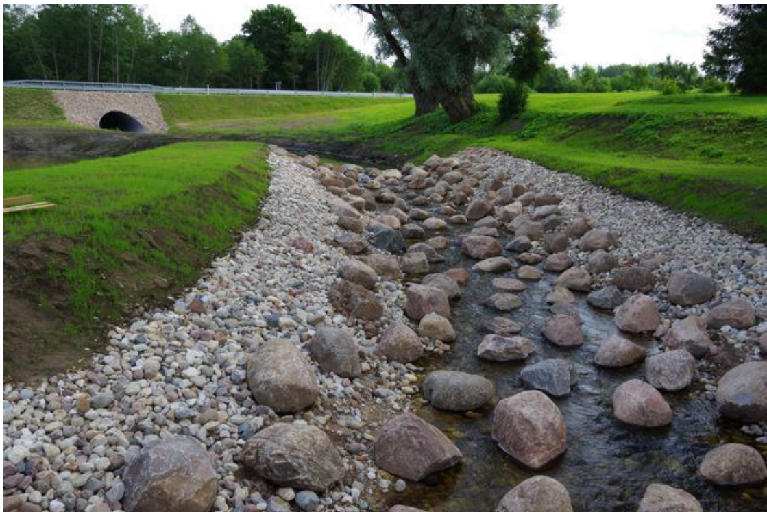
Foto 4. Vaade pääsu ülemisele osale jalakäijate sillalt ülesvoolu.
