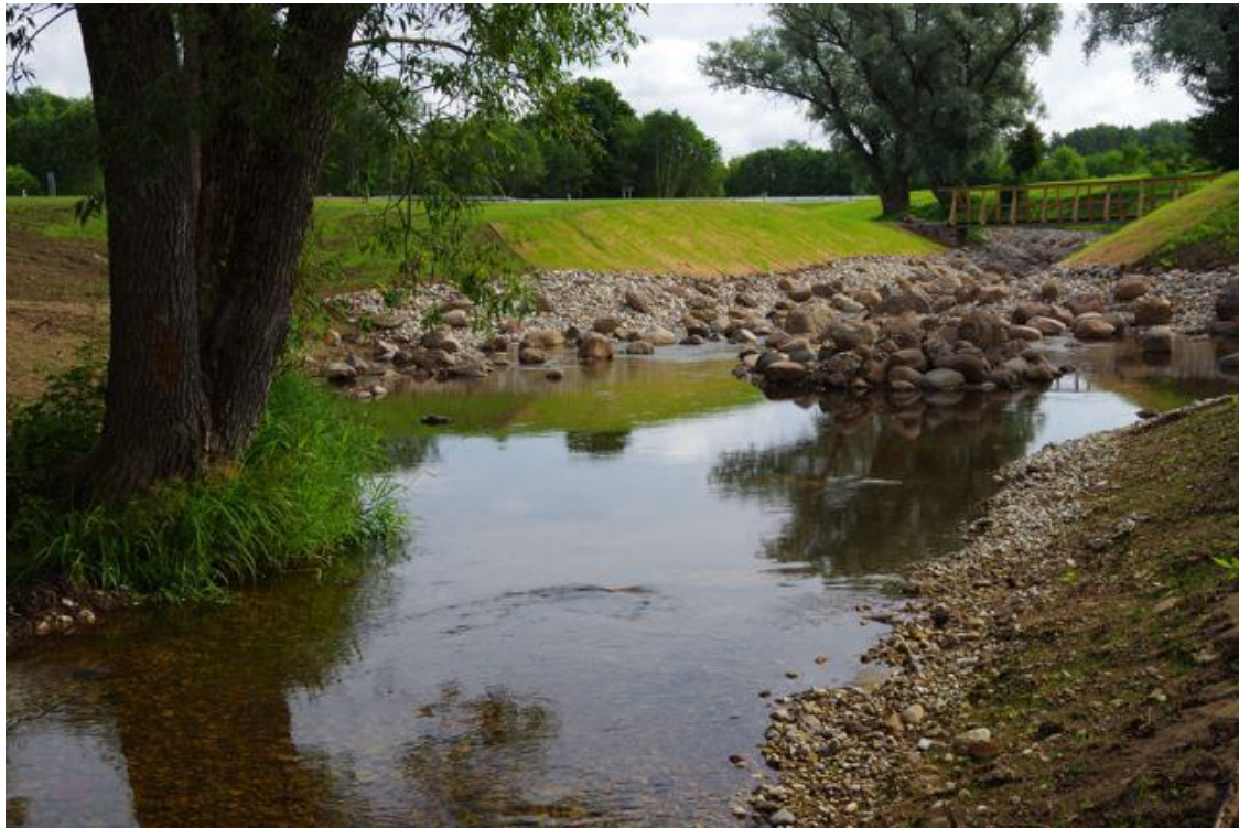
Foto 1. Vaade kalapääsu sissepääsule (väljavoolule) kudeala juurest. Keskel sängilaiend kivisaarega
