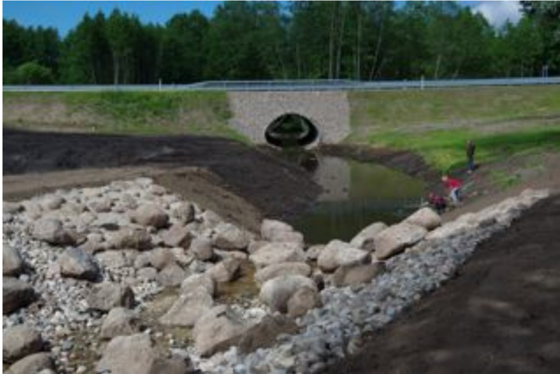
Foto 5. Ehitustööde aegne (1.07.15) vaade pääsu väljapääsule (sissevool). Kivide vahel pääsu põhjal vesi vaevvalt niriseb.
