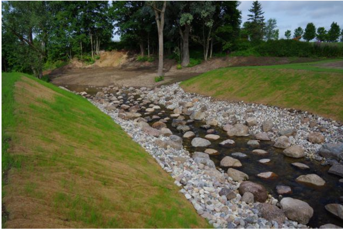
Foto 3. Allavoolu vaade kalapääsu alumisele osale tehiskärestikku keskelt ületava jalakäijate silla juurest.
