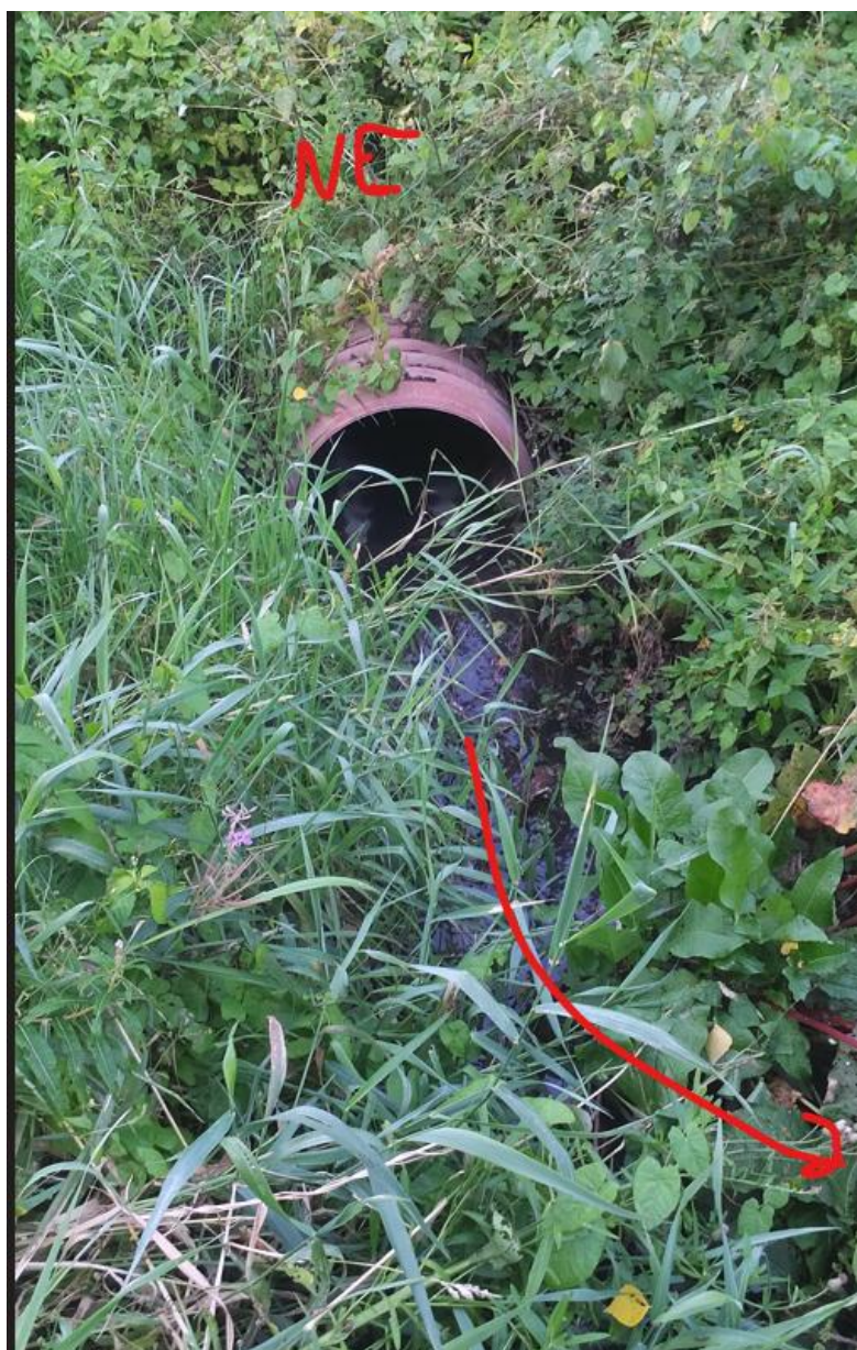
2. Kraavi kirdekaldal suur toru, millest voolas vett välja. Peaks olema Jõgeva linna Pae sademevee väljalask:
