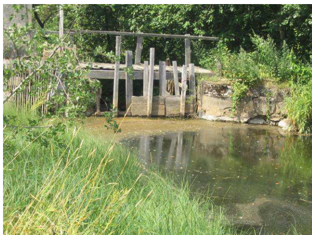
Joonis 12. Pärlijõe Raudsepa paisu vasakkalda regulaator ( vasakul ) ning paremkalda regulaator ( paremal ).
