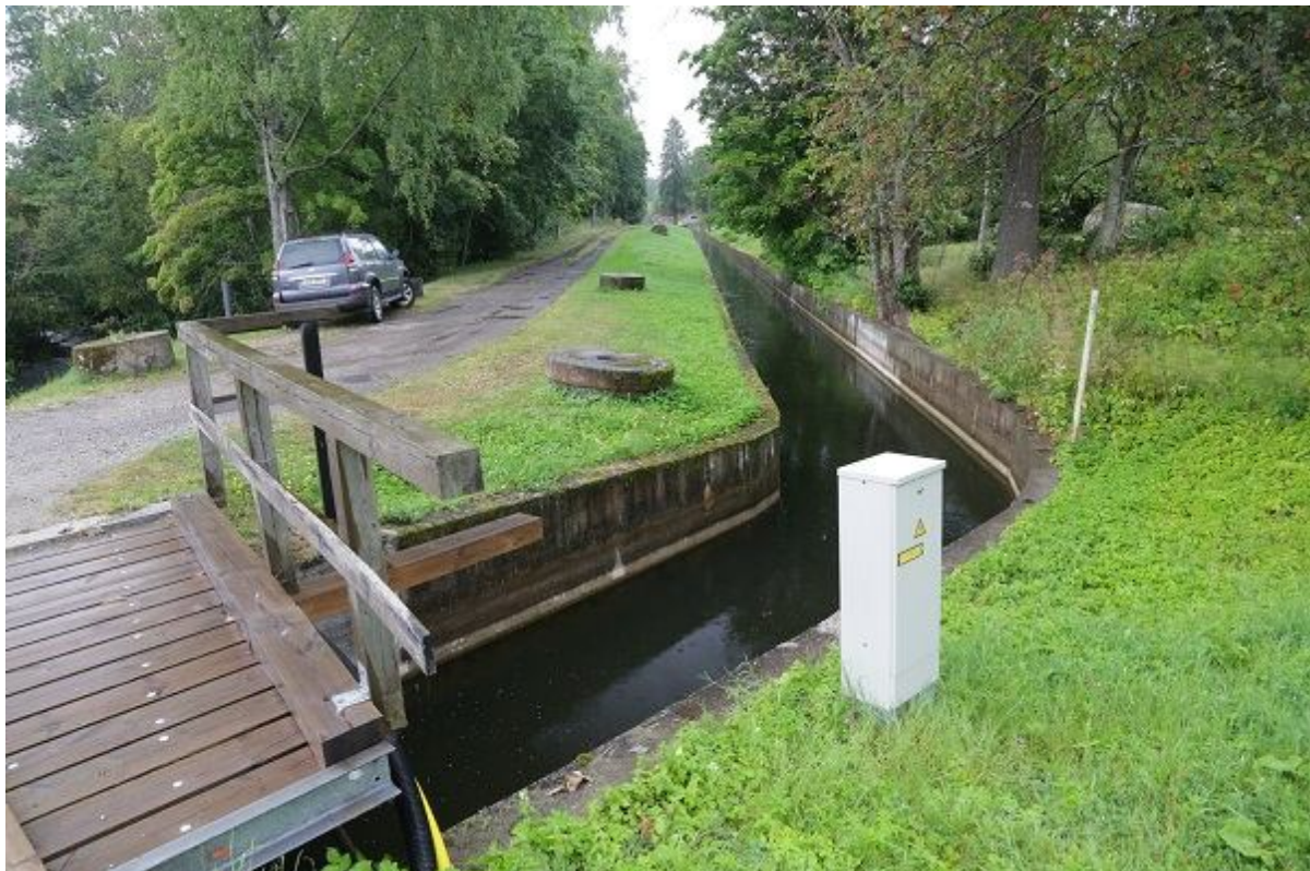
Foto 1.2.9.10. HEJ juurdevoolukanal. 2015. a suvel ja sügisel HEJ ei töötanud. 24.11.2015, mil lõpetati sügisene seire kalapääsul, valmistus omanik HEJ käivitama (26.08.2015, R. Järvekülg).
