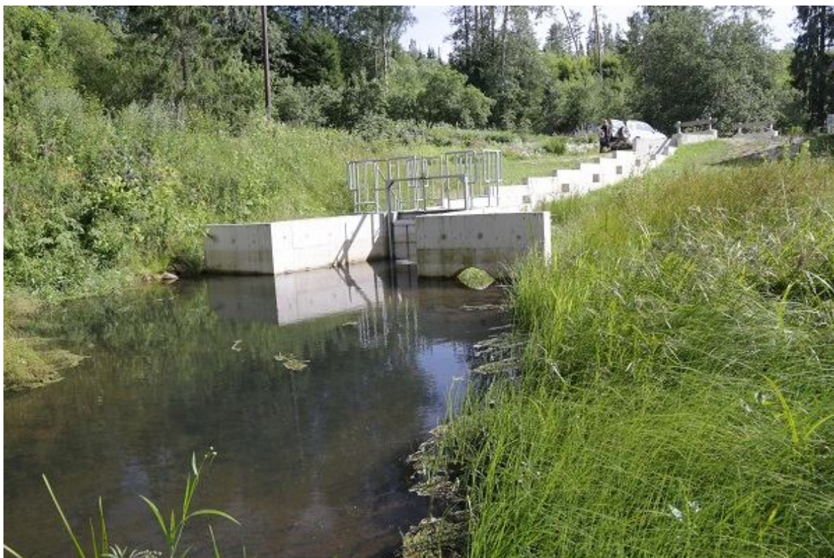
Foto 1.3.3.4. Roti kalapääsu väljavool ja alumine osa. Veetäide kalapääsu väljavoolul on piisav. Kaladel, kes kalapääsu alla jõuavad, on kalapääsu sisenemine lihtne (21.07.2015, R. Järvekülg).
