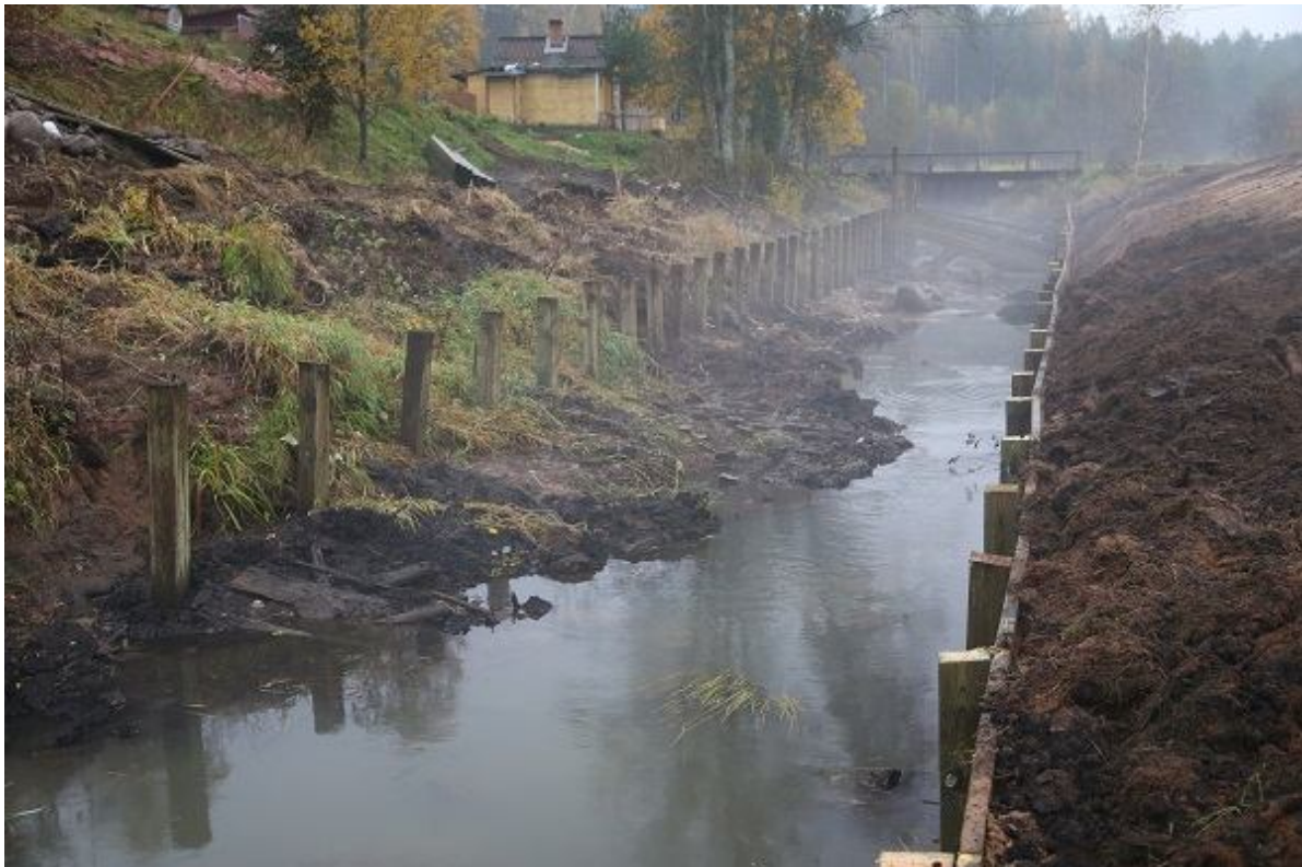
Foto 1.2.15.12. Kindlustamata kaldad vajuvad sisse. Kaldakindlustuse postid rammiti vähemalt 3 m sügavusele maasse (10.10.2014, R. Järvekülg).
