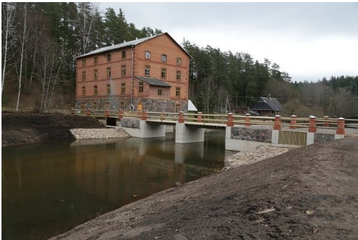
Foto 1.2.6.3. Vaade Kiidjärve veskile ja veskisillale ülavee poolt (30.11.2015, R. Järvekülg).
