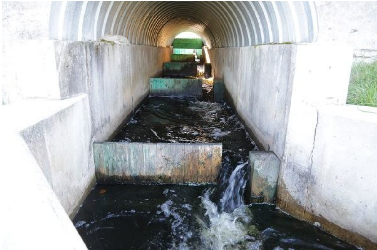
Foto 1.2.8.2. Koseveski kalapääsu ülemine, pilupääsu osa (13.08.2015, R. Järvekülg).
