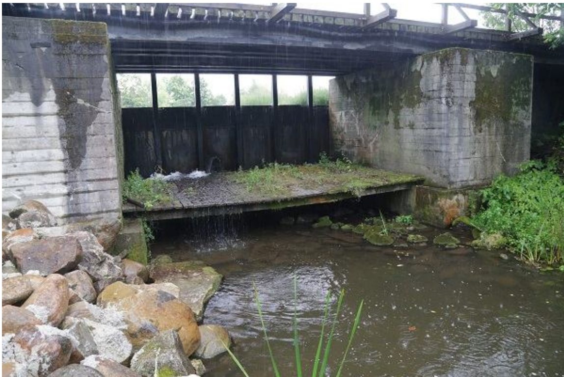
Foto 1.2.10.8. Liigveelasu kaudu on kalade laskumistingimused ebasoodsad. Otse liigveelasu all on veetäiteta betoonranta, millele järgneb allavoolu väikse kaldega laudis. Laudis võiks ju alata kohe liigveelasu alt ja olla suurema kaldega. Nii väheneks kalade vigastuste oht (26.08.2015, R. Järvekülg).
