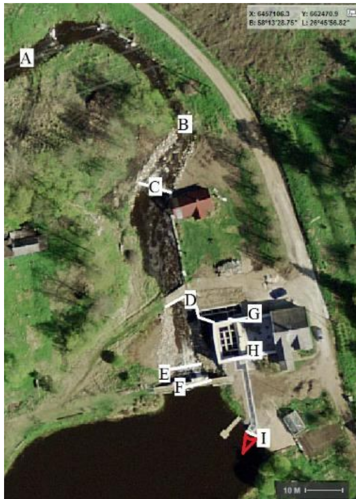
Joonis 2.2.12-1. Porijõel Sasi kalapääsu piirkonnas teostatud elektripüükide lõikude algused ja lõpud (tähistatud tähtedega A, B, C, D, E, F, G, H ja I) ning mõrra asetus kalapääsu sissevoolul (punane kolmnurk, suue tähistatud kaarjoonega).
