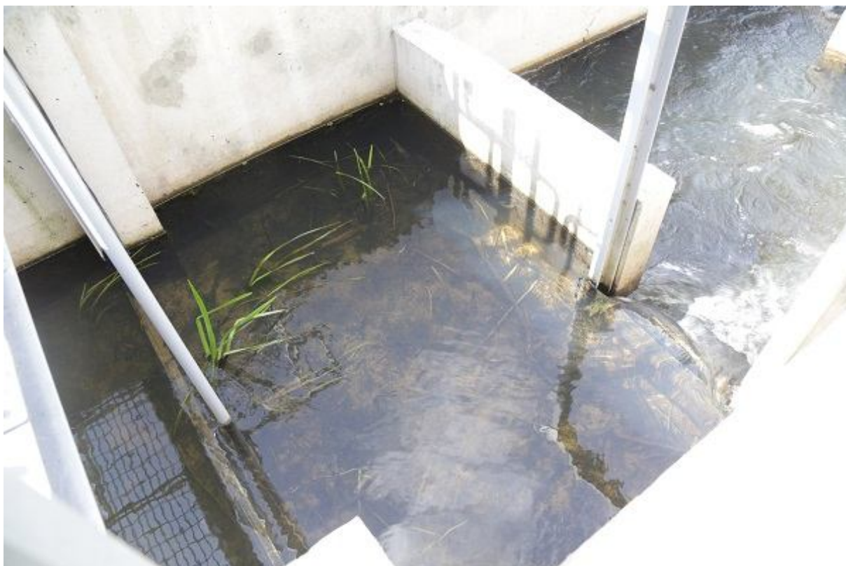
Foto 1.3.3.8. Lisaks ujuvprahile kalapääsul on probleemiks kalapääsu sissevoolu ummistumine setetega. Vaatluspäeval 21.07.2015 oli settekihi paksus sissevooluregulaatori kambris kuni 0,3 m (R. Järvekülg).
