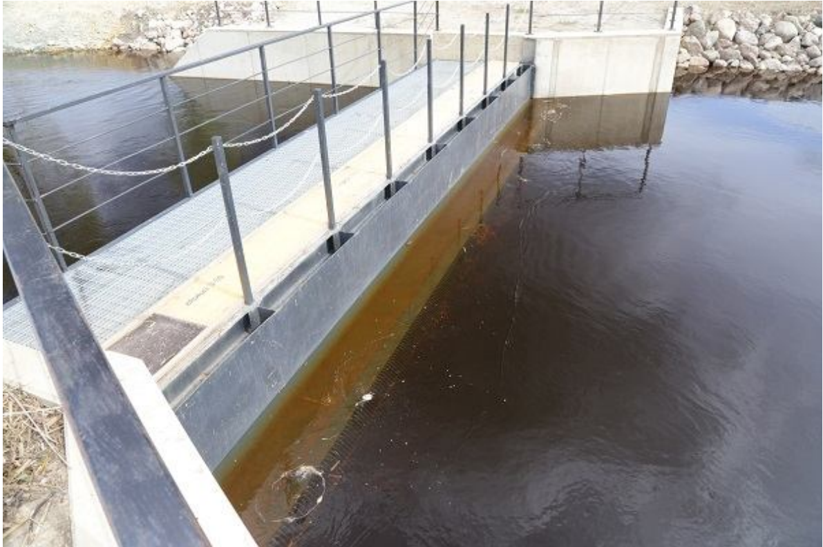
Foto 1.2.13.7. HEJ juurdevoolukanali sissepääs on suletud võrega (14.05.2015, R. Järvekülg).
