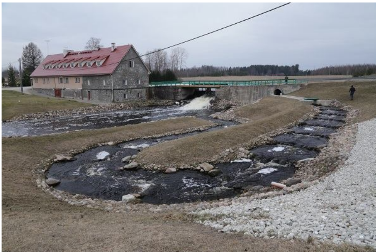
Foto 1.2.8.1. Koseveski kalapääs kevadel 20.03.2015, tiikide kaskaadi osa (R. Järvekülg).
