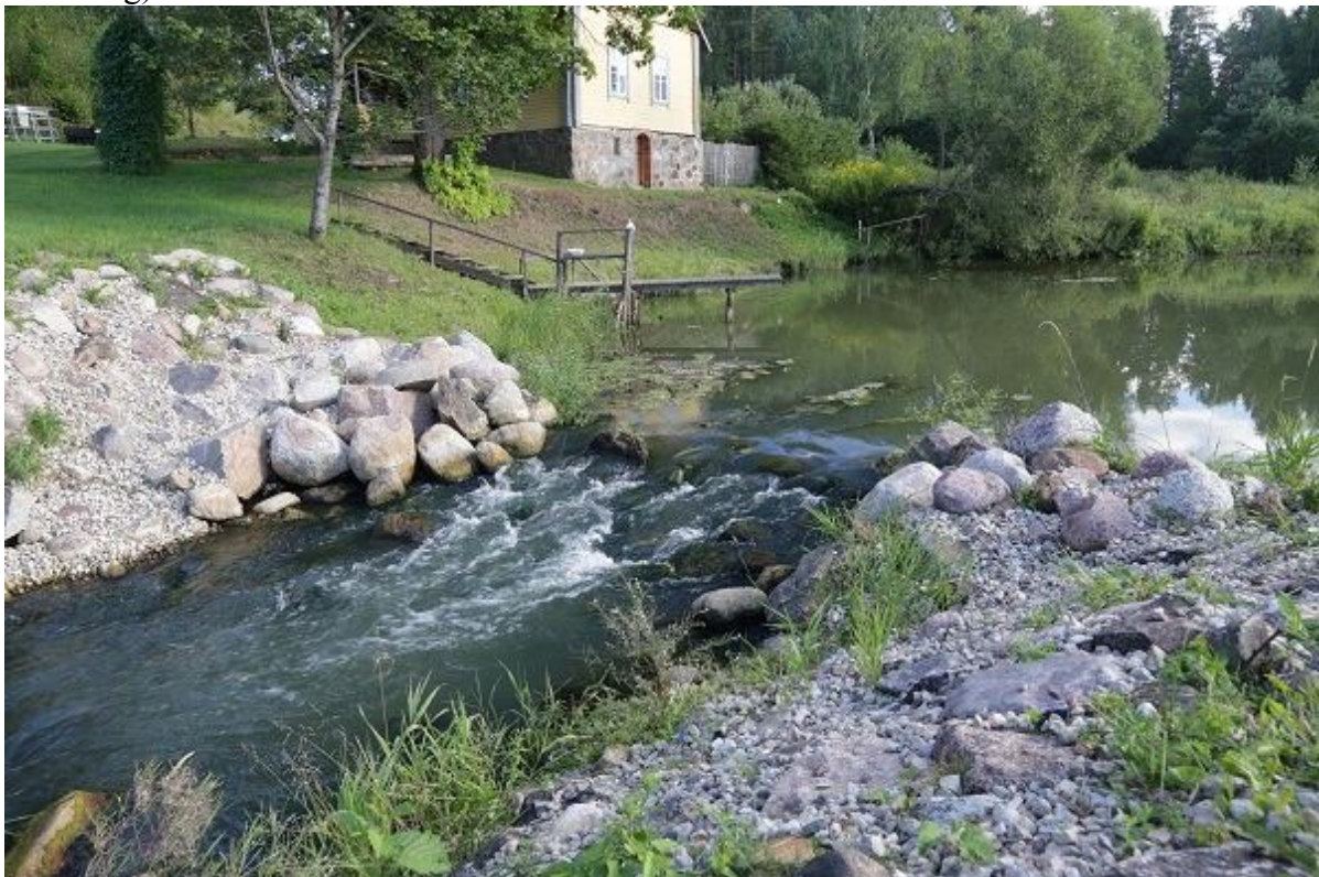
Foto 1.2.15.8. Nagu sageli juhtub, kipub kalapääsu sissevoolul lang liiga suureks ja vool käreteks minema. Vaatluspäeval mõõdeti kalapääsu vooluhulgaks 0,82 m 3 /s (14.08.2015, R. Järvekülg).
