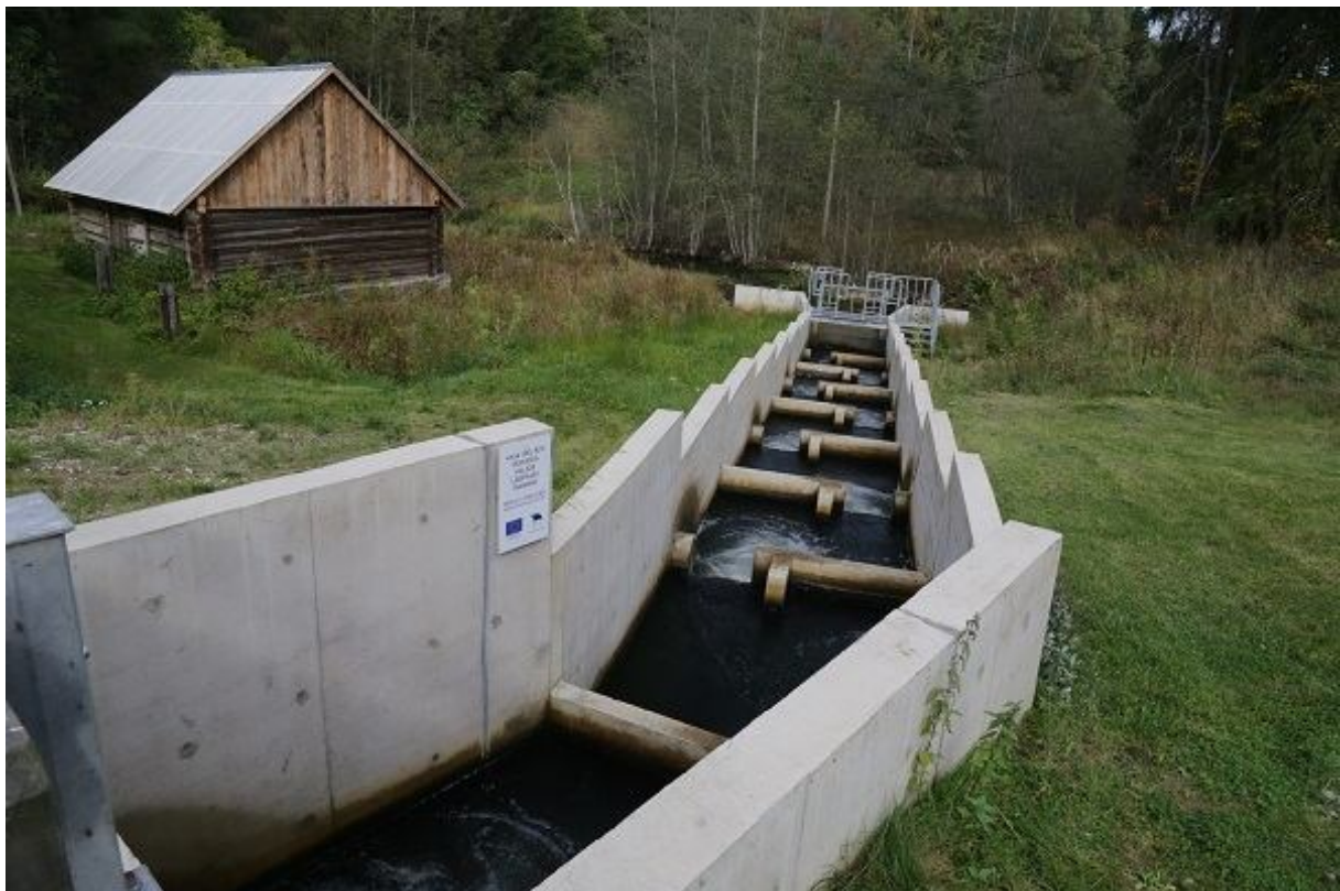
Foto 1.2.3.1. Roti kalapääs, vaade sissevoolu juurest allavoolu suunas(24.09.2015, R. Järvekülg).
