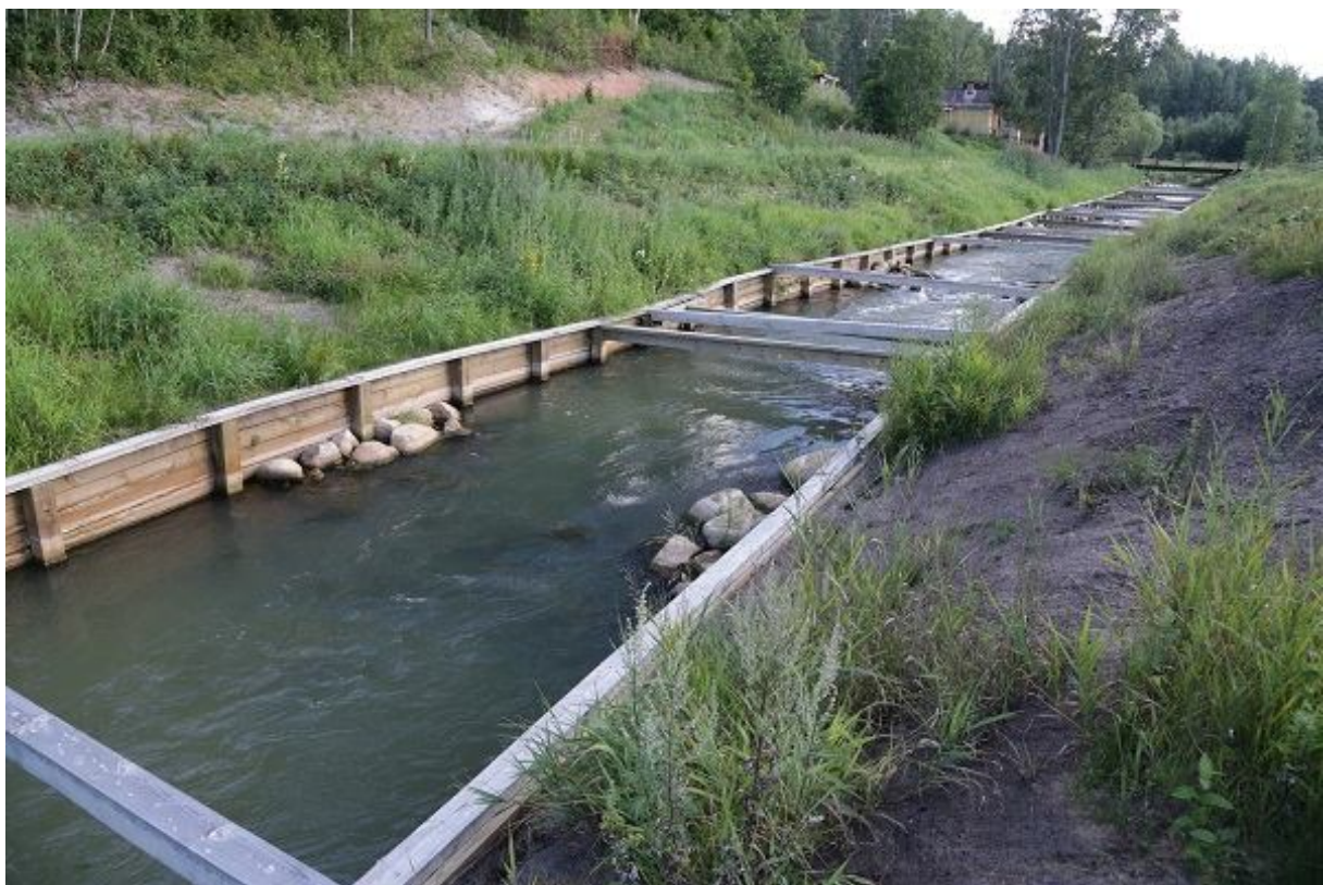
Foto 1.2.15.1. Tsüdsina kalapääsu alumine osa, vaade ülesvoolu. Kalapääsu kesk- ja alaosas on kaldad kindlustatud laudisega. See peab aitama vähendada erosiooniõhtu (14.08.2015, R. Järvekülg).
