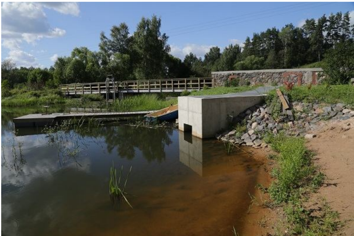
Foto 1.2.12.7. Kalapääsu sissevooluotsak paisjärves, selle taga paadisild ja sild liigveelaskmega (03.08.2015, R. Järvekülg).
