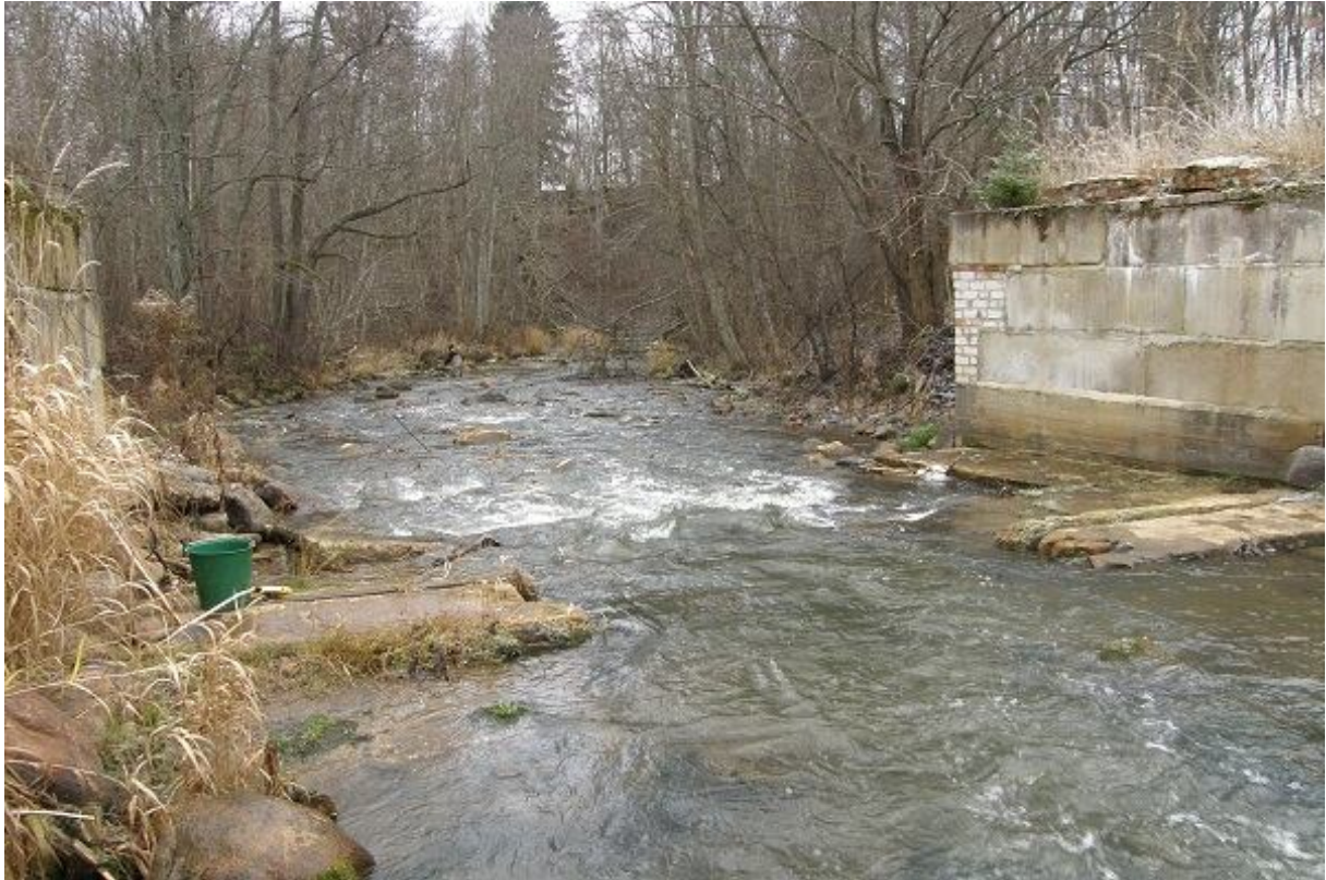
Foto 1.2.16.4. Ainsaks mõnevõrra probleemseks kohaks on kärestiku ülaosas olev sillakoht. Kuna omanik pidas silla sambaid kaitset väärivateks, siis ei saanud neid kalapääsu rajamisel lammutada. Et sambad püsiksid, selleks pidi säilima vähemalt osaliselt ka silla sammaste vaheline betoontala, millesse tehti ca 2 m laiune ava. Betoontala all on suurema languga kiirevooluline koht. Allavoolu jääv kärestik on suure languga. Langu vähendamiseks peaks kogu kärestikku pikalt tõstma, mis oleks aga väga materjalimahukas.
