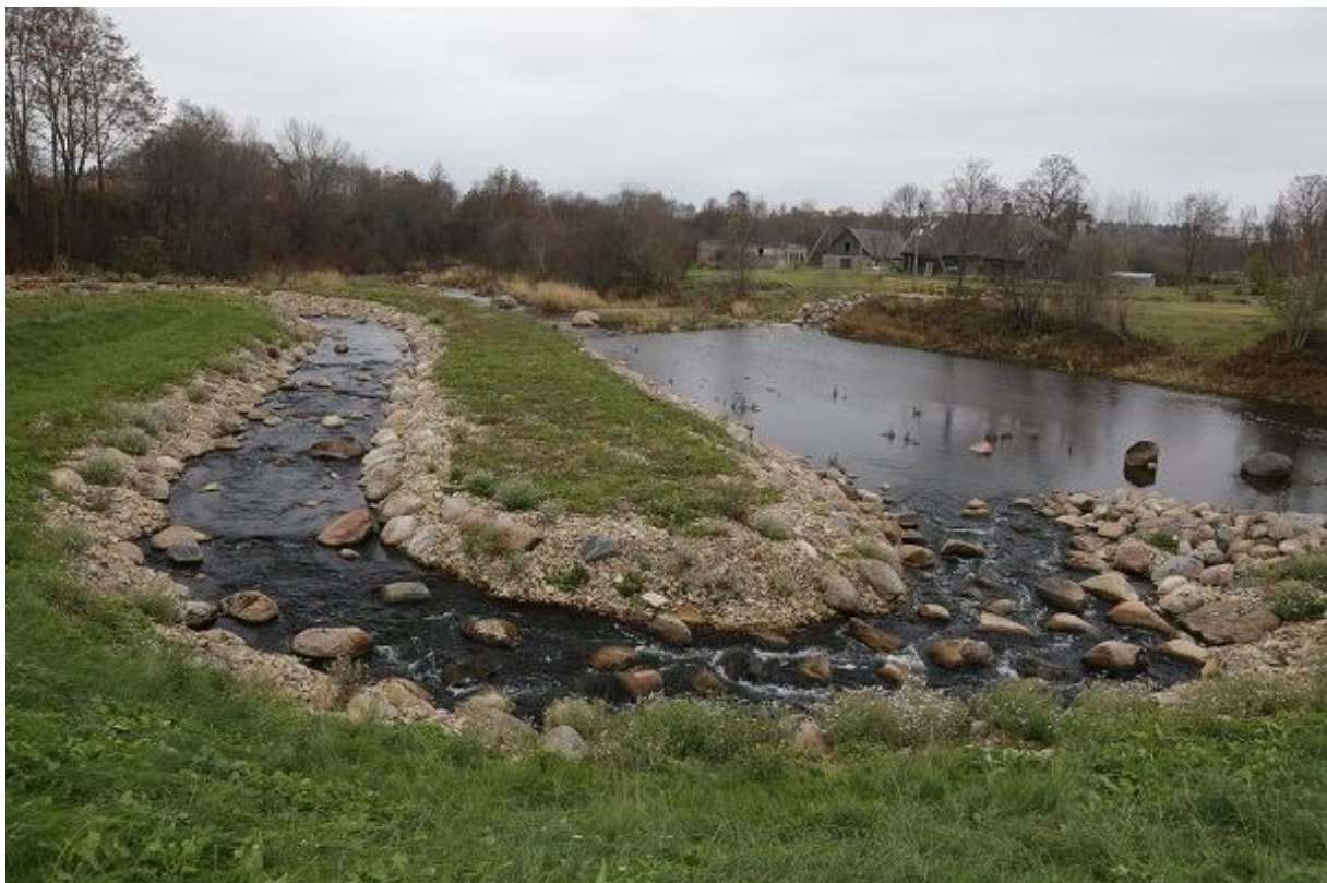
Foto 1.2.13.2. Sillaoru kalapääs on hajuskärestiku tüüpi möödaviikpääs. Vaade kalapääsu alaveepoolsele osale (22.10.2015, R. Järvekülg).
