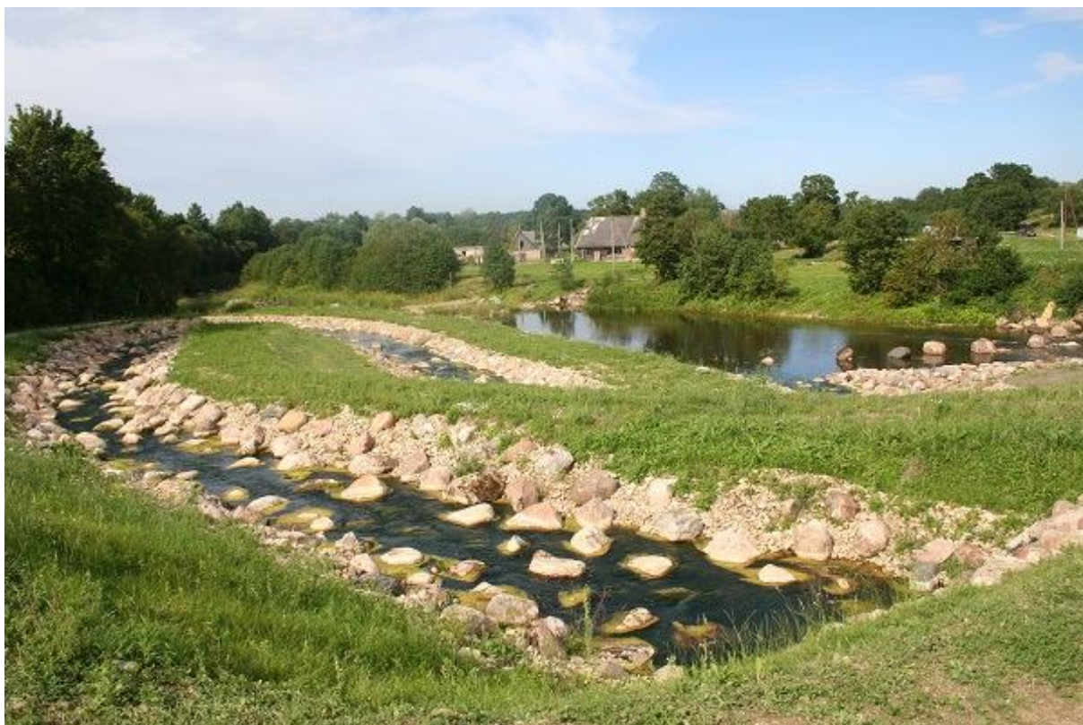
Foto 1.2.13.3. Sillaoru kalapääsu keskosa madalvee tingimustes (29.07.2015, R. Järvekülg).
