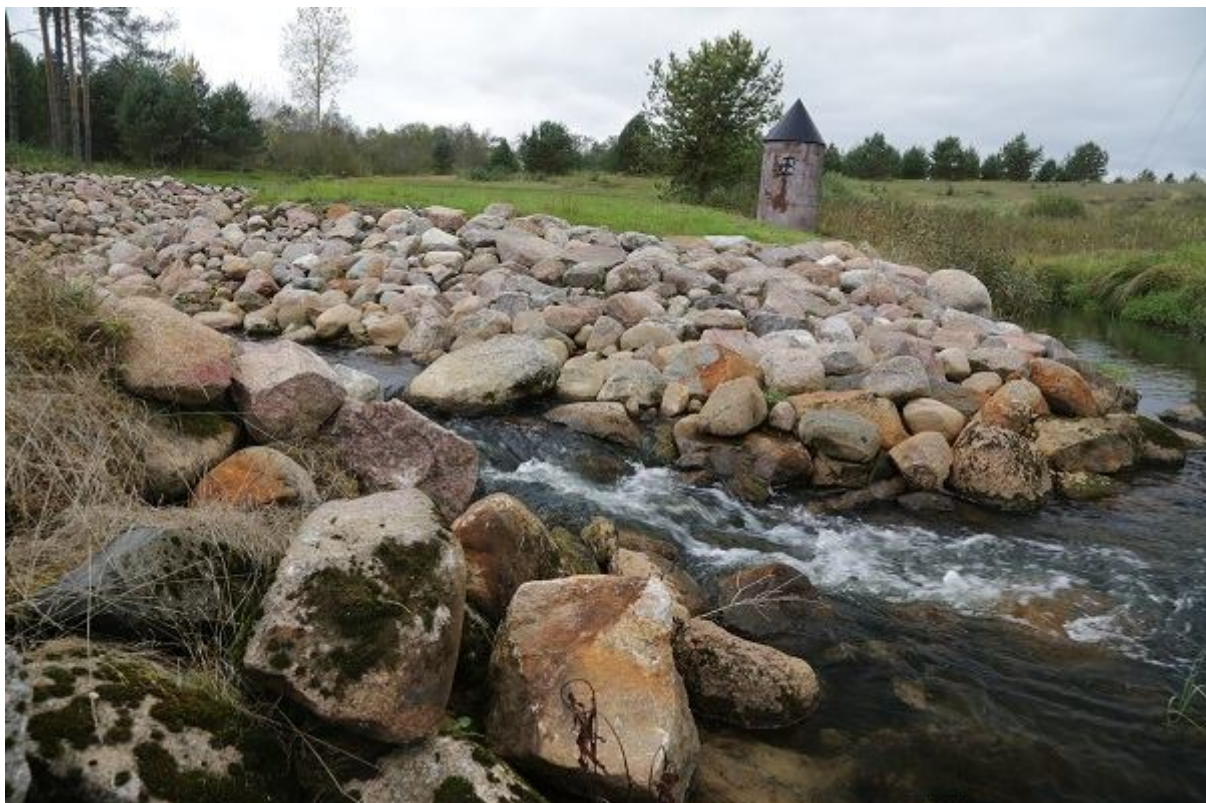
Foto 1.2.11.4. Kõige probleemsemaks kohaks kaladele on kalapääsul väljavool, kus madalvee ajal tekib järsu langusega kiirvool. Veerohkel ajal alavee tase tõuseb ning veeaste väljavoolul väheneb (01.10.2015, R. Järvekülg).
