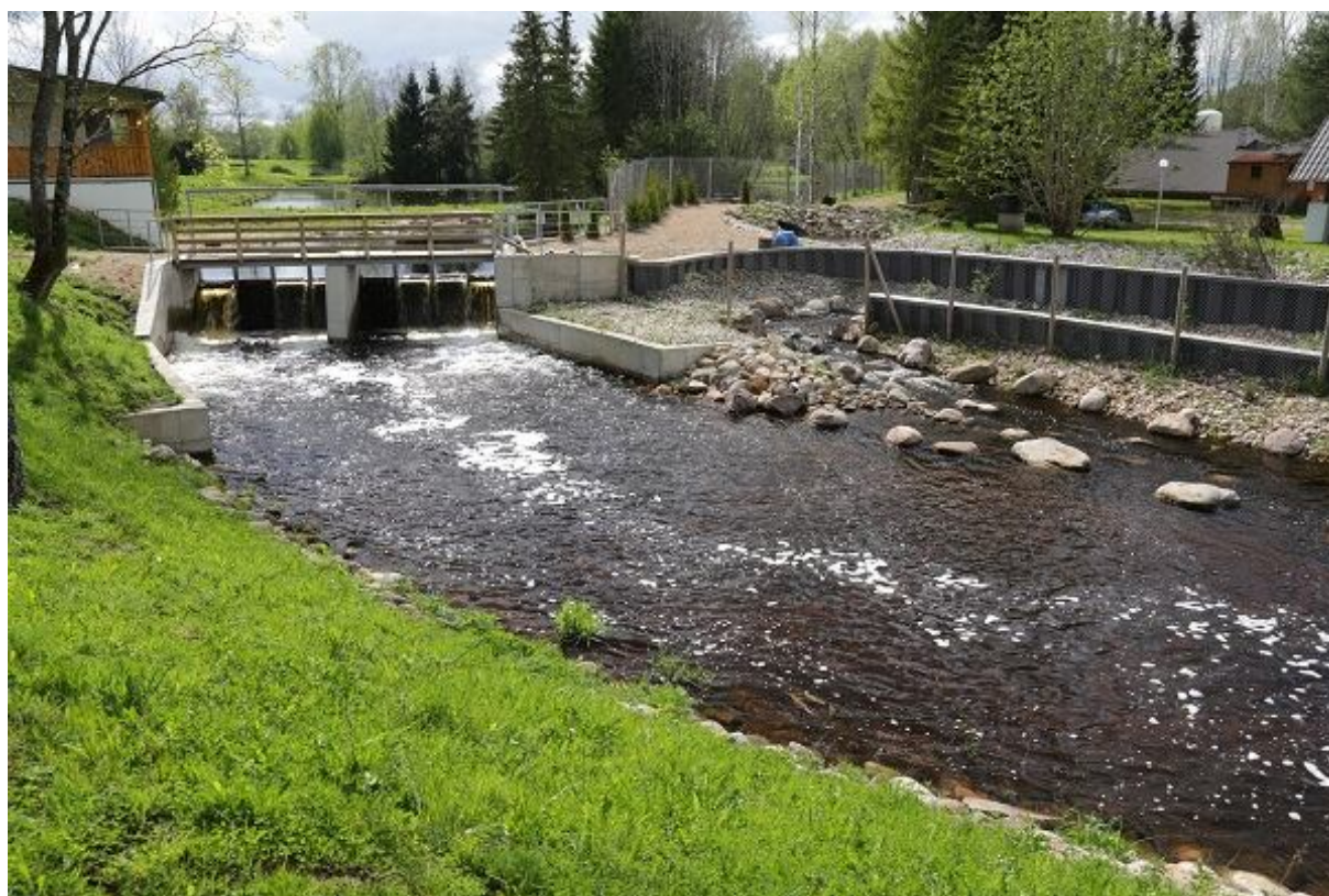
Foto 1.2.2.2. Karilatsi paisu alune jõeosa veerohkel ajal. Kalapääsu leidmine on kaladele suhteliselt lihtne, kalapääs on kaladele normaalselt läbitav. Fotol paremal kalapääsu väljavool, vasakul liigveelask (08.05.2014, R. Järvekülg).
