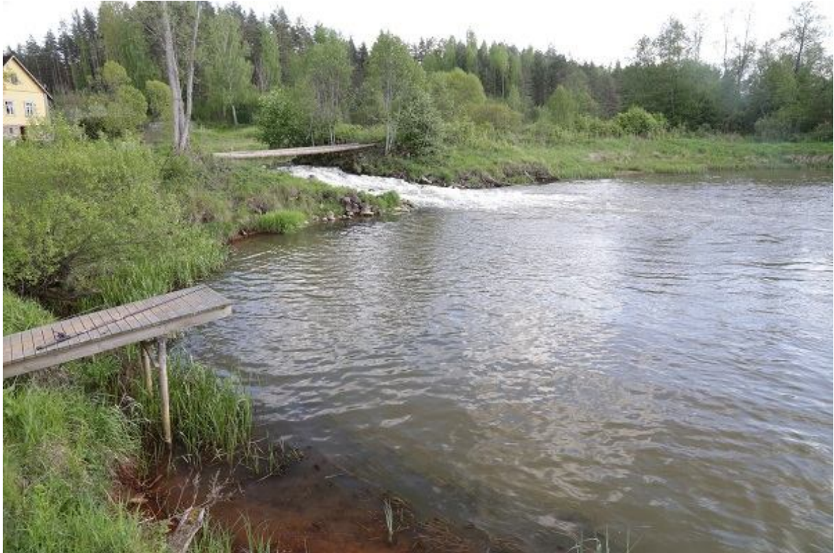
Foto 1.2.15.3. Liigveelask on kaladele enamiku ajast vastuvoolu ületamatu. Laskuva rände tingimused liigveelasu kaudu on head (22.05.2015, R. Järvekülg).
