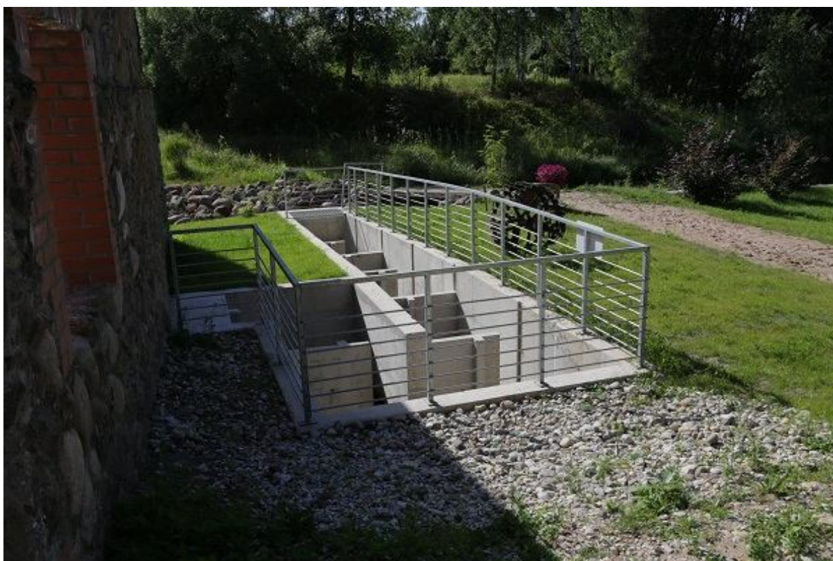
Foto 1.2.12.1. Sasi kalapääsu alumine osa, lõik vanast veskihoonest kuni jõeni (03.08.2015, R. Järvekülg).
