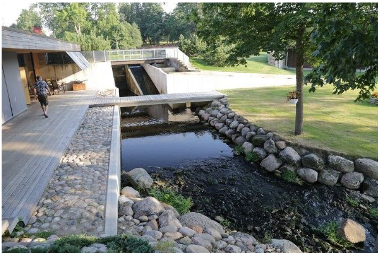
Foto 1.2.9.1. Loo pais ja kamberkalapääsule alavee poolt. Kalapääsu väljavool asub jõe vasaku kalda ääres (fotol paremal veepinna kohal). Alavee poolt vaadates vasakul pool on kaheosaline liigveelask (25.08.2015, R. Järvekülg).
