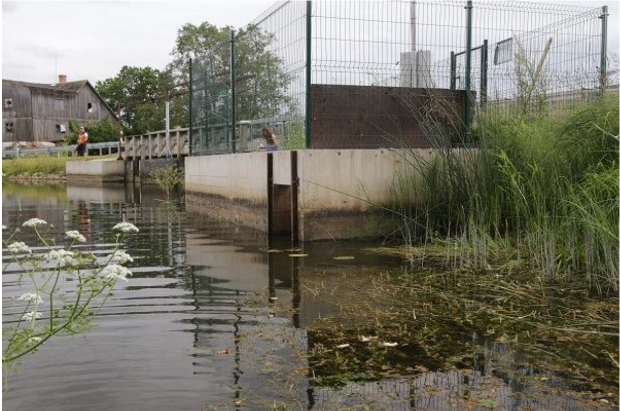
Foto 1.2.14.11. Kalapääsu sissevool paisjärve poolt vaadates. Tagaplaanil liigveelask. Nagu rantidest näha, on veetase paisjärves hiljuti oluliselt kõrgem olnud (23.07.2015, R. Järvekülg).
