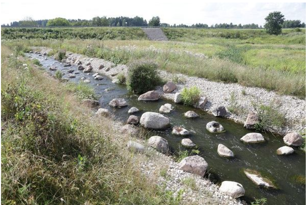
Foto 1.2.1.a.5. Leevi Külajärve kalapääsu keskosa, ca 100 m väljavoolust ülesvoolu (11.08.2015, R. Järvekülg).
