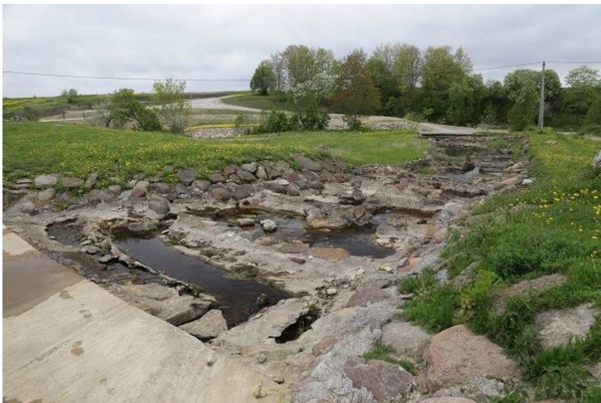
Foto 1.2.13.18. Sillaoru vana kalapääs, mis toimima ei hakanudki (14.05.2015, R. Järvekülg).
