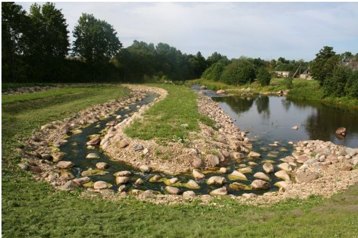
Foto 1.2.13.1. Sillaoru kalapääsu alumine osa madalvee tingimustes (29.07.2015, R. Järvekülg).
