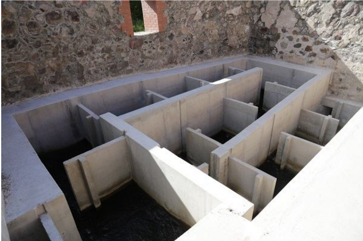
Foto 1.2.12.2. Sasi kalapääsu keskosa asub vana veskihoone müüride vahel (03.08.2015, R. Järvekülg).
