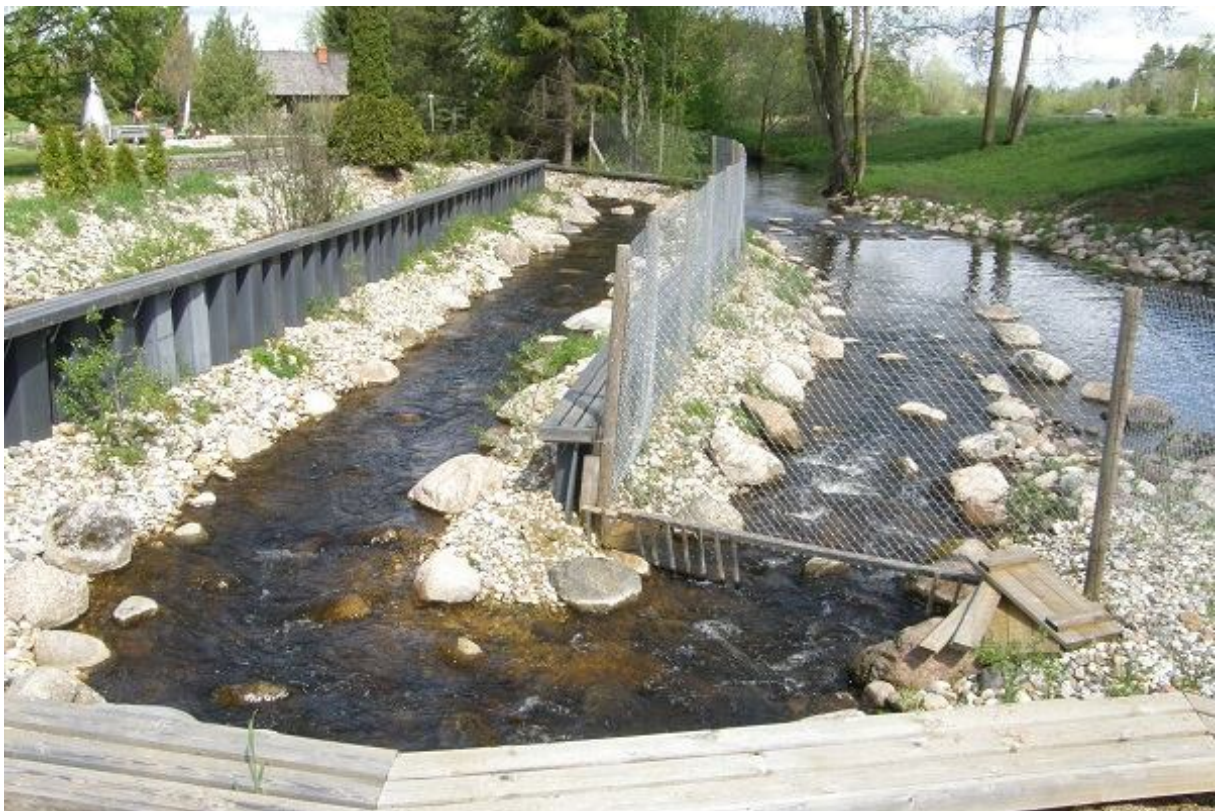
Foto 1.2.2.6. Karilatsi kalapääsu alumine osa 13.05.2015. Kalapääsu vooluhulk on lähedane projektijärgsele (R. Pihu).
