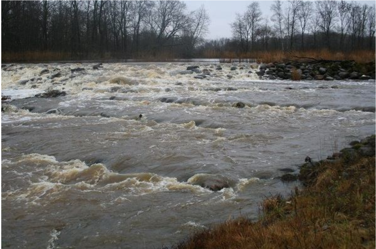
Foto 1.2.17.8. Laastre kalapääs mõõduka suurvee tingimustes (vh ca 17 m 3 /s) (03.12.2015, A. Sinimets).
