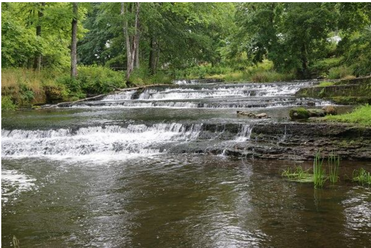
Foto 1.2.10.5. Joaveski joastiku suurimad astmed madalvee oludes. 26.08.2015 oli Loobu jõe vooluhulk Joaveski lävendis ca 0,53 m 3 /s, elektrijaam ei töötanud. Sellise vooluhulgaga kalad joastikku ületada ei suuda (R. Järvekülg).
