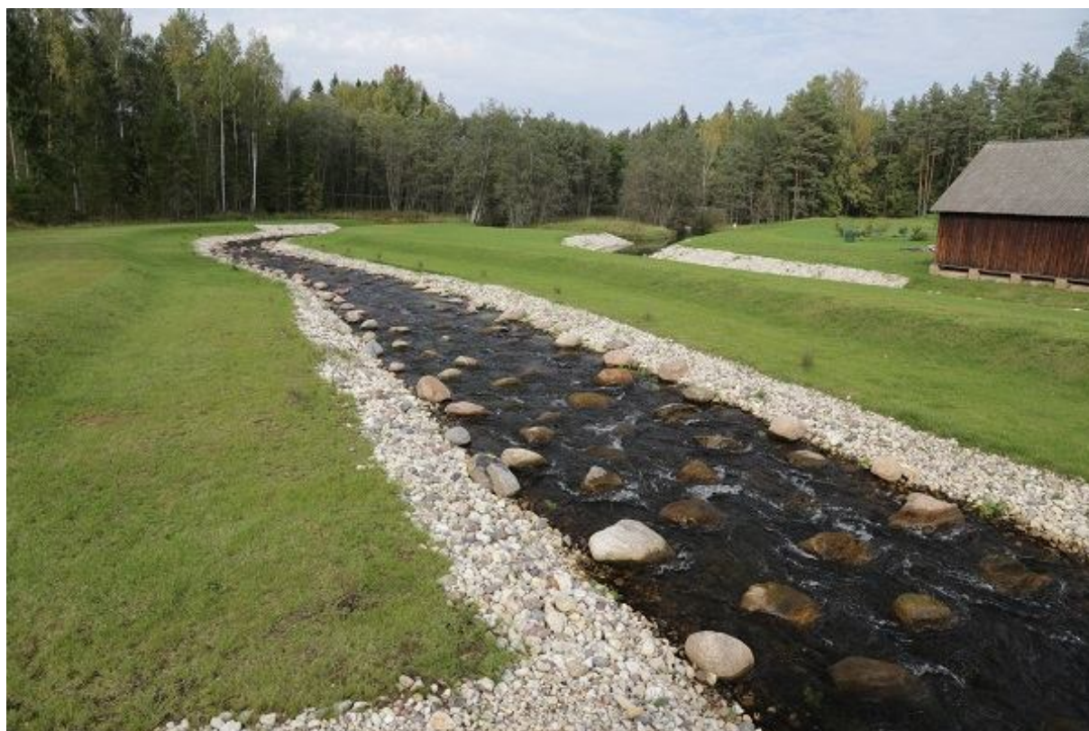
Foto 1.2.4.1. Aarna kalapääs on hajuskärestiku tüüpi. Vaade paisult allavoolu. Tagaplaanil paremal on näha liigveelasu äravoolukanal. Kalapääsuks kujundatud jõesäng on kahe-astmeline – rohtunud kaldanõlvadel on näha suurvee aegne voolusäng (24.09.2014, R. Järvekülg).
