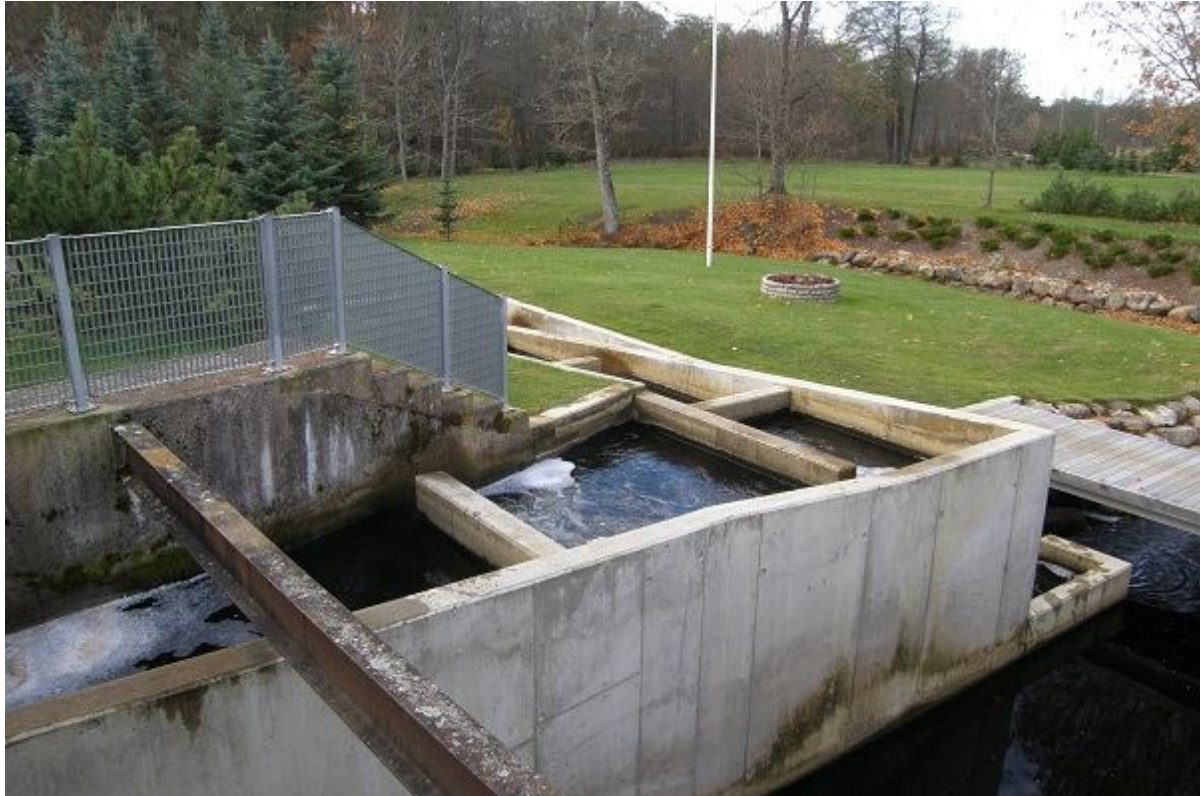
Foto 1.2.9.9. Loo kalapääsu ülaosa 30.10.2015. Kui vett jões rohkem oli, siis täitusid kalapääsu kambrid uuesti veega, aga ainult tänu sellele, et omanik oli kalapääsu ise ümber ehitanud. Projekteeritud kujul poleks kalapääsu kambrid 2015. a suvel ja sügisel kordagi veega täitunud (R. Pihu).
