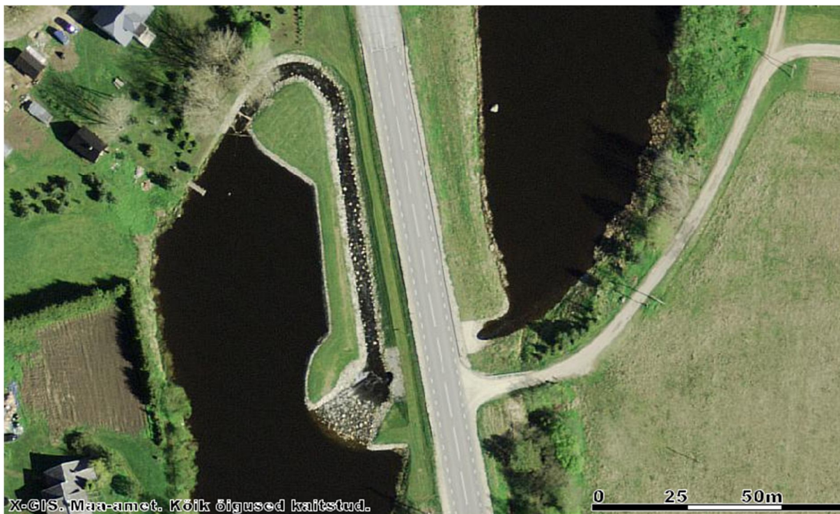
Joonis 1.2.1.b.3. Kalapääsu sissevool asub Veskijärve põhjatipus. Kalapääsu väljavool paikneb vahetult liigveelasu juures, seetõttu on tõusval rändel olevatel kaladel kalapääsu leidmine lihtne ka suurte äravooluhulkade korral. Kalapääs on hajuskärestiku tüüpi möödaviik-pääs.
