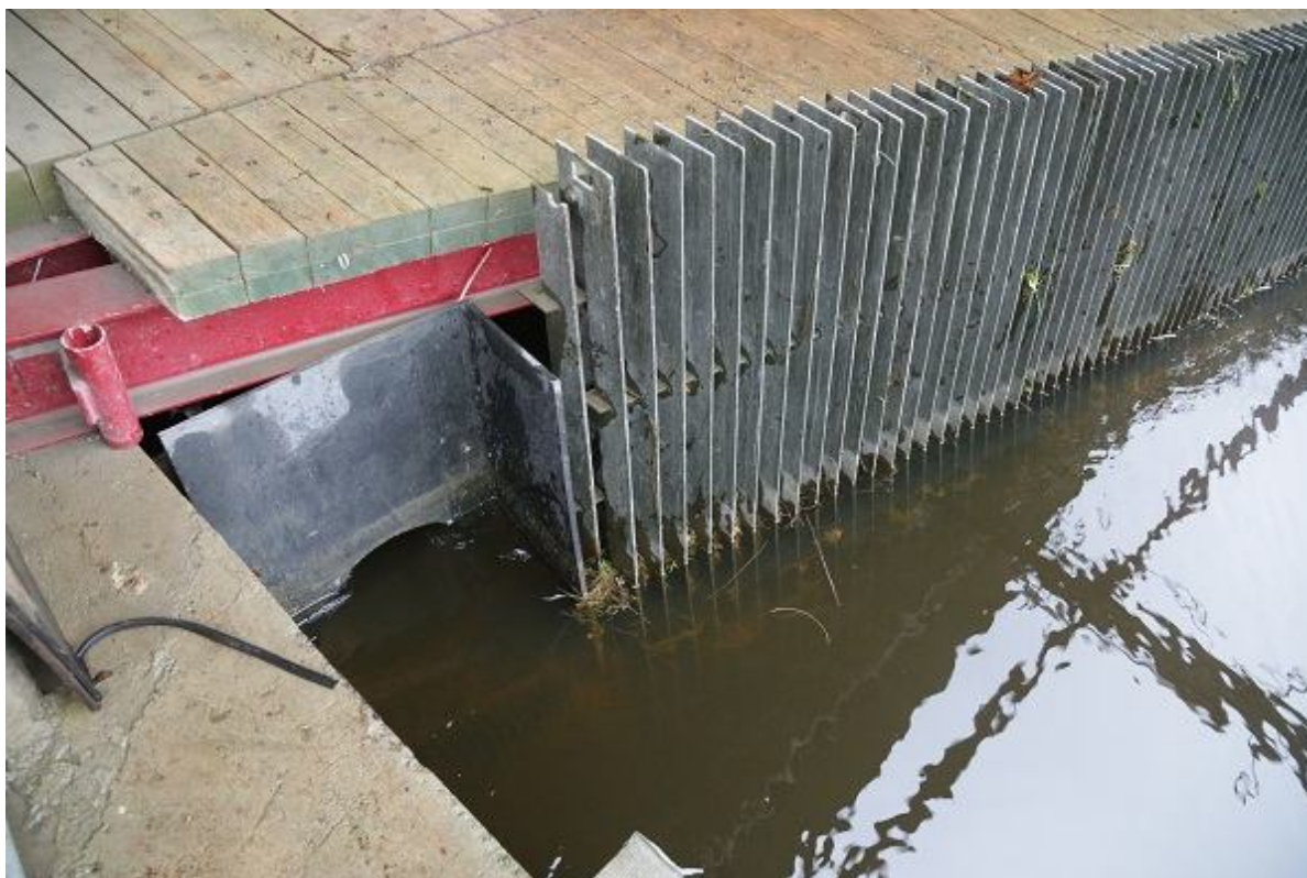
Foto 1.2.7.7. HEJ turbiinide sissevooluvõre vasakus servas on toru kalade laskuva rände võimaldamiseks. Toru läbimõõt on 0,47 m. Ülavee NPT tingimustes on toru sissevoolu ülaseriv veepinnaga tasa (17.11.2015, R. Järvekülg).
