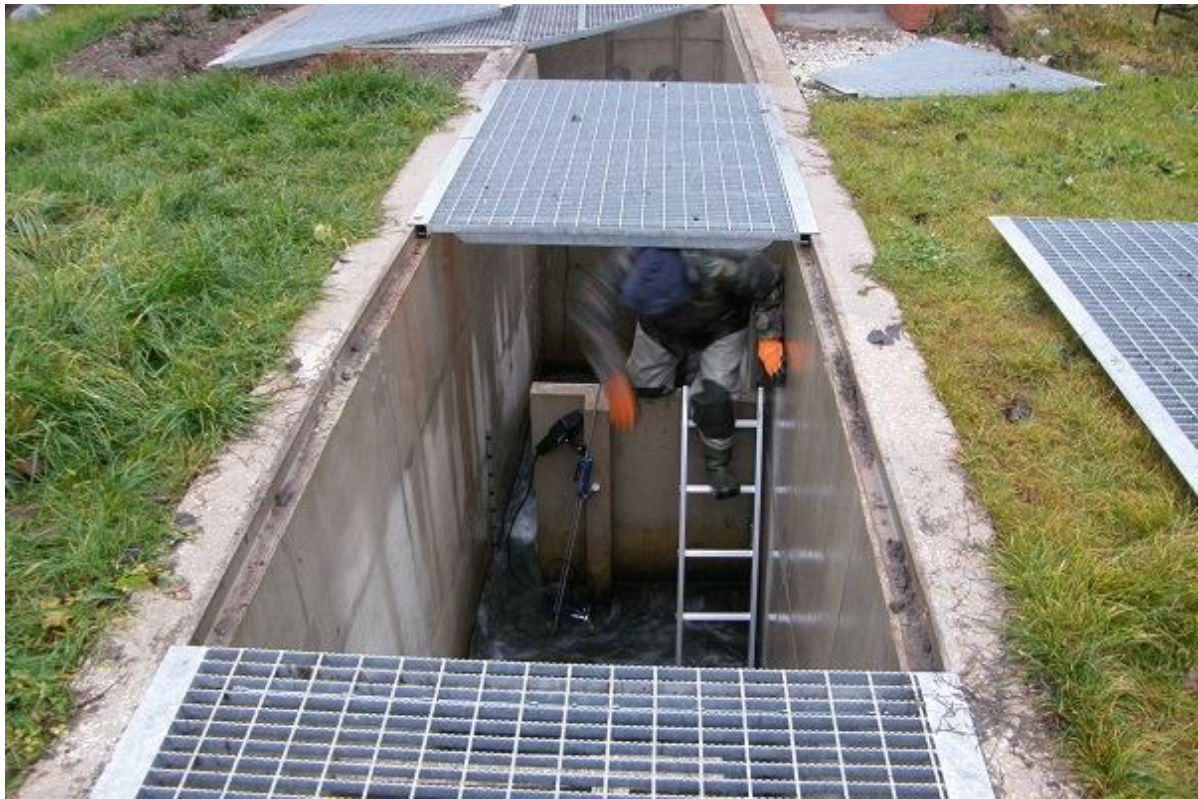
Foto 1.2.12.8. Nii hüdrauliliste mõõtmiste kui katsepüükide läbiviimine kamberkalapääsudes on alati ebamugav ja keeruline protsess. Läbi kaladele mõeldud pinna- ja põhjaavade liikuma ei mahu, vaja on kasutada redelit (17.11.2015, R. Pihu).
