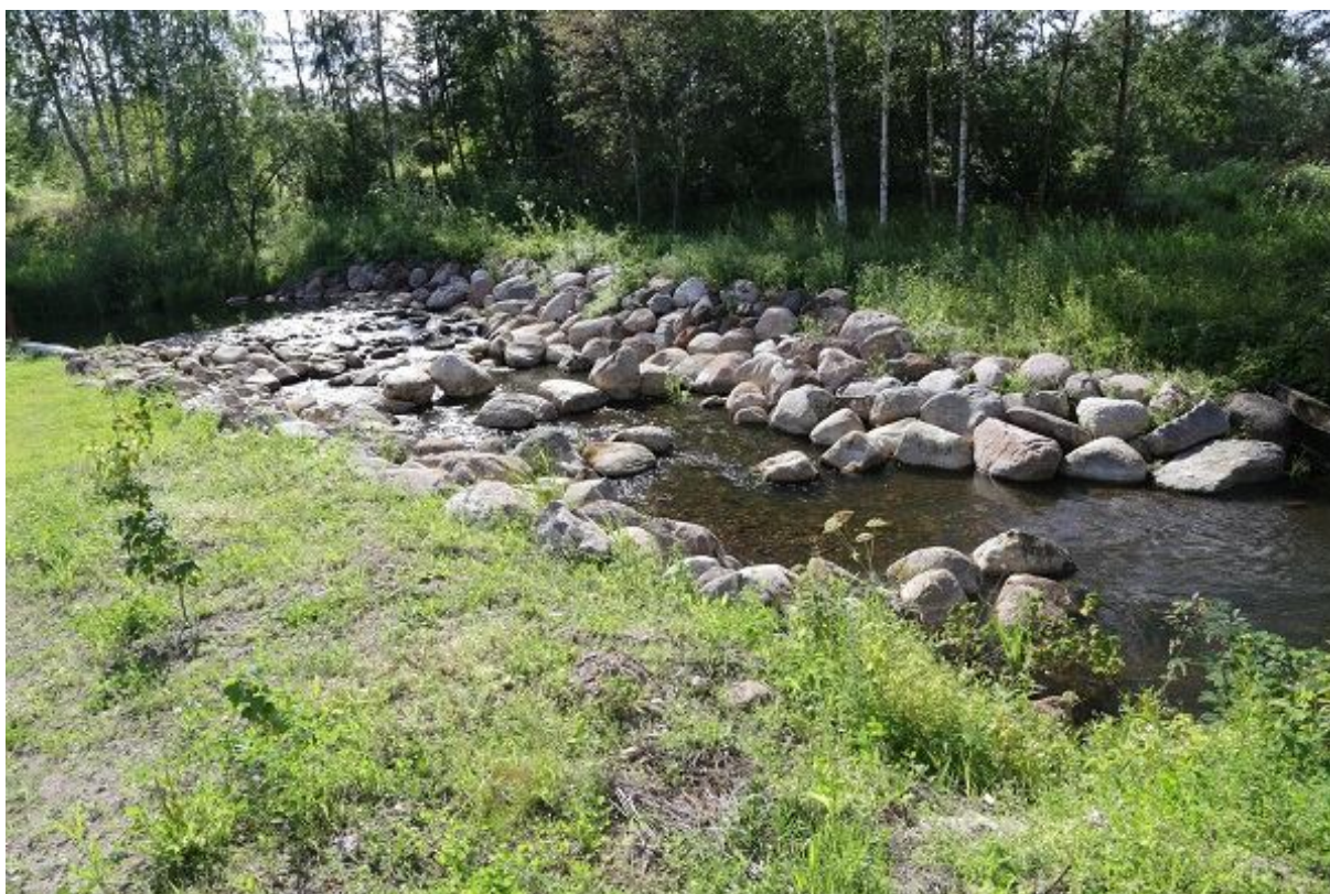
Foto 1.2.12.3. Ca 50 m Sasi paisust allavoolu on jõele rajatud tehiskärestik, millega tõstetakse veetäidet paisu alusel jõelõigul. Tehiskärestiku ülemine osa on liiga suure languga ning kaladele seetõttu raskesti läbitav. Kärestik tuleks ehitada laugemaks (03.08.2015, R. Järvekülg).
