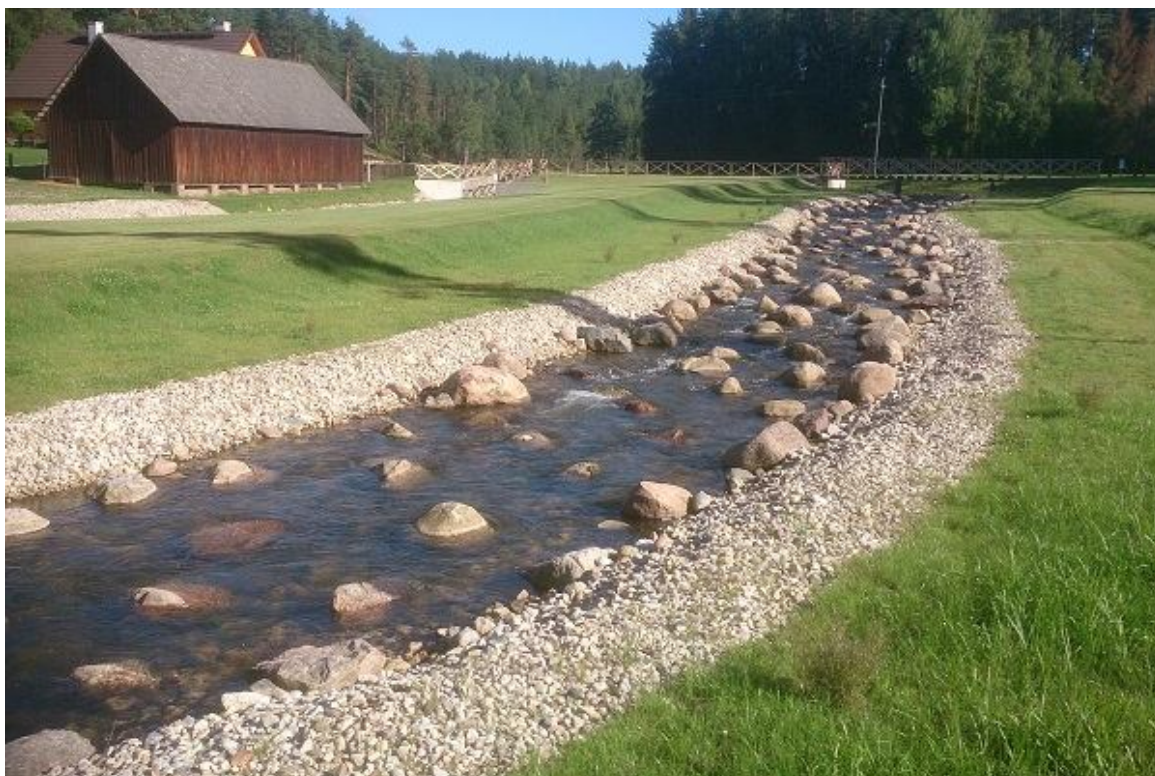
Foto 1.1.1. Hajuskärestiku tüüpi kalapääs (Ahja jõgi Aarnas, 17.08.2015, R. Järvekülg).
