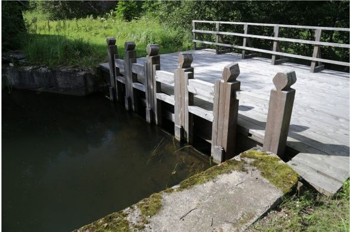
Foto 1.3.3.12. Roti liigveelask ülavee poolt vaadates. Probleemiks on see, et paisu juures elab suviti ainult üks vananimene. Aga kes hakkab paisul suurvee läbilaskmiseks varjadega opereerima? Eriti kui kevadel on liigveelasu varjad paksu jää all kinni. Praegu ei näi olukord jätkusuutlik (21.07.2015, R. Järvekülg).
