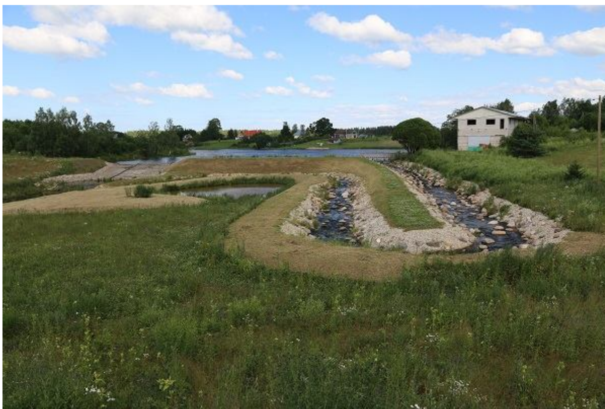
Foto 1.2.1.a.1. Vaade Kälajärve kalapääsule Põlva-Reola mnt-lt. Tagaplaanil vasakul on näha liigveelask (10.07.2014, R. Järvekülg).
