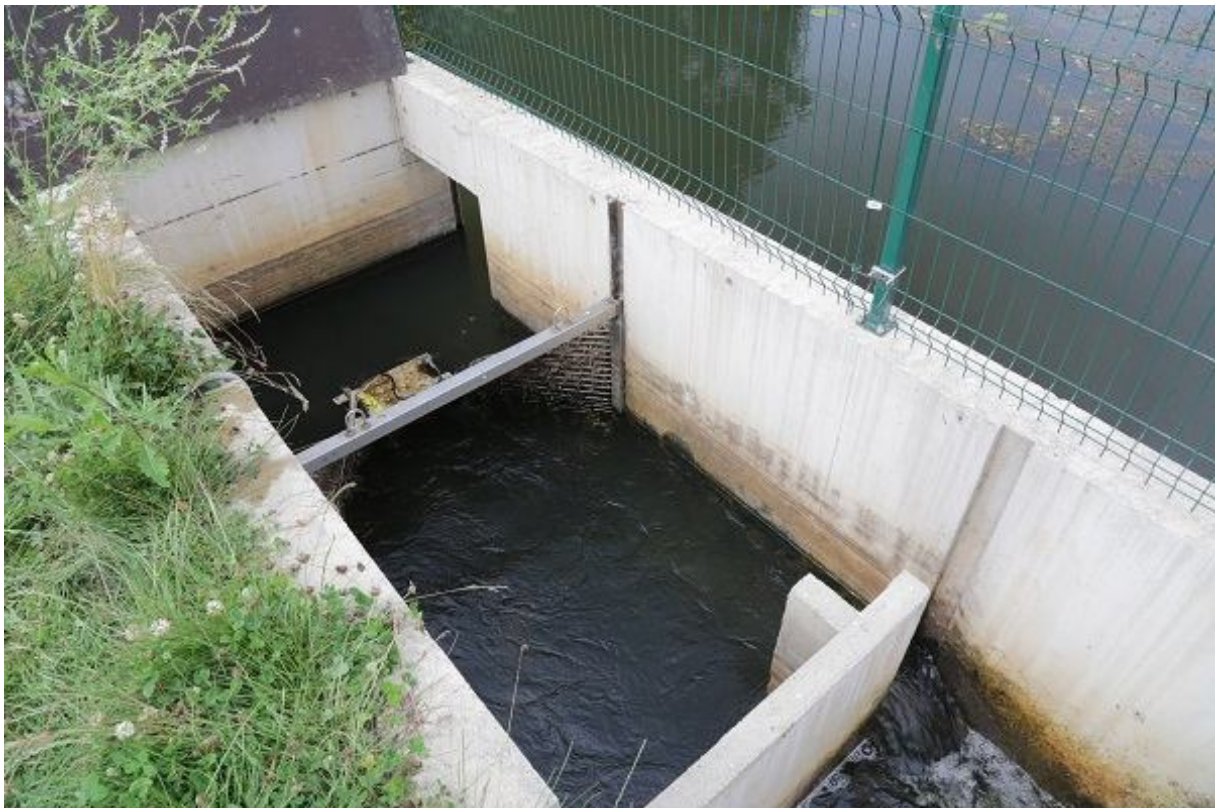
Foto 1.2.14.10. Kalapääsu sissevoolul on kalaloendur. 2015. a kevadseire perioodil see ei töötanud. Kalapääsu omaniku kinnitusel polnud seade töökorras (23.07.2015, R. Järvekülg).
