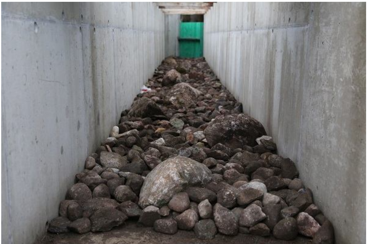
Foto 1.2.8.9. 0-languga kanal enne vee sisselaskmist (09.10.2013, R. Järvekülg).
