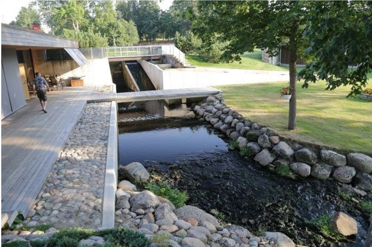
Foto 1.2.9.1. Vaade Loo kamberkalapääsule alavee poolt. Kalapääsu väljavool asub jõe vasaku kalda ääres (fotol paremal veepinna kohal). Alavee poolt vaadates vasakul pool on kaheosaline liigveelask.
