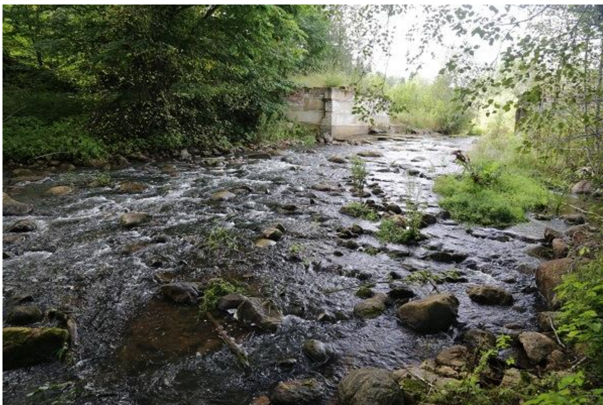
Foto 1.2.16.1. Oro paisuvare on kujundatud kärestikuks. Endise paisu asukohas on säilinud silla sambad ja nende vaheline betoonlænd (10.09.2015, R. Järvekül).
