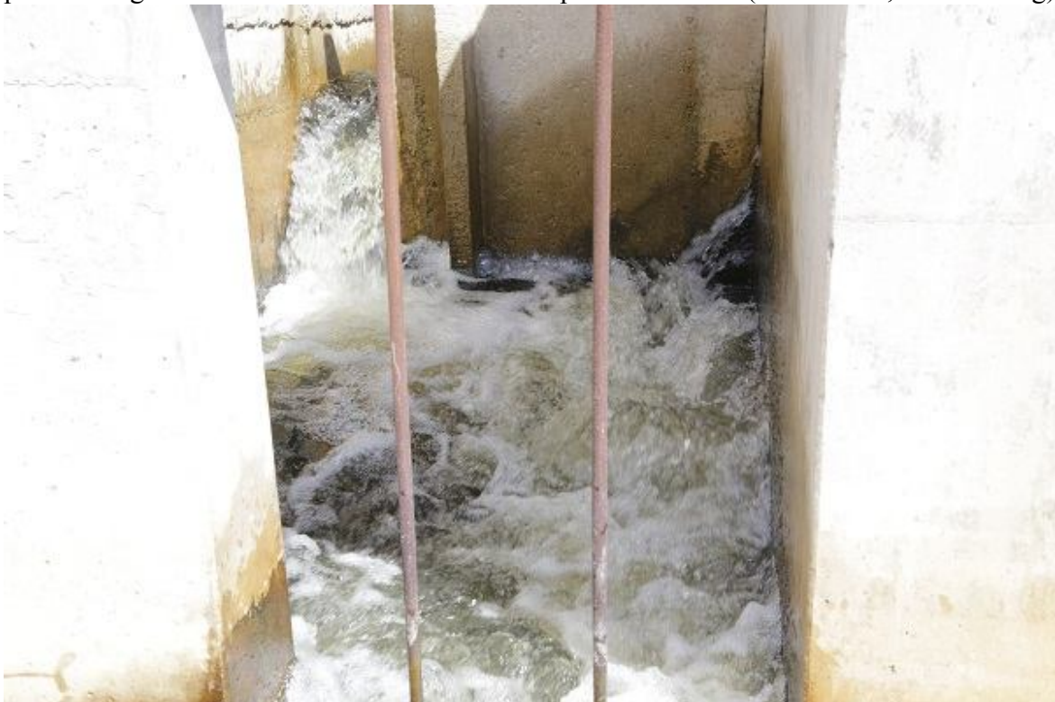
Foto 1.2.14.6. Kalapääsu alumine kamber. Tegemist on tormilise kiirvoolu kohaga. Liigmadala alavee taseme tõttu puudub viimase kambri väljavoolul vee vastutäide. Veetasemete vahe eelviimase ja viimase kambri vahel oli eri mõõtmisaegadel 0,40...0,53 m (projekti järgi peaks olema 0,11 m)! Sellised kohad on enamikule kaladele isegi motivatsiooni olemasolul puht füüsiliselt läbimatu (22.05.2015, R. Järvekülg).
