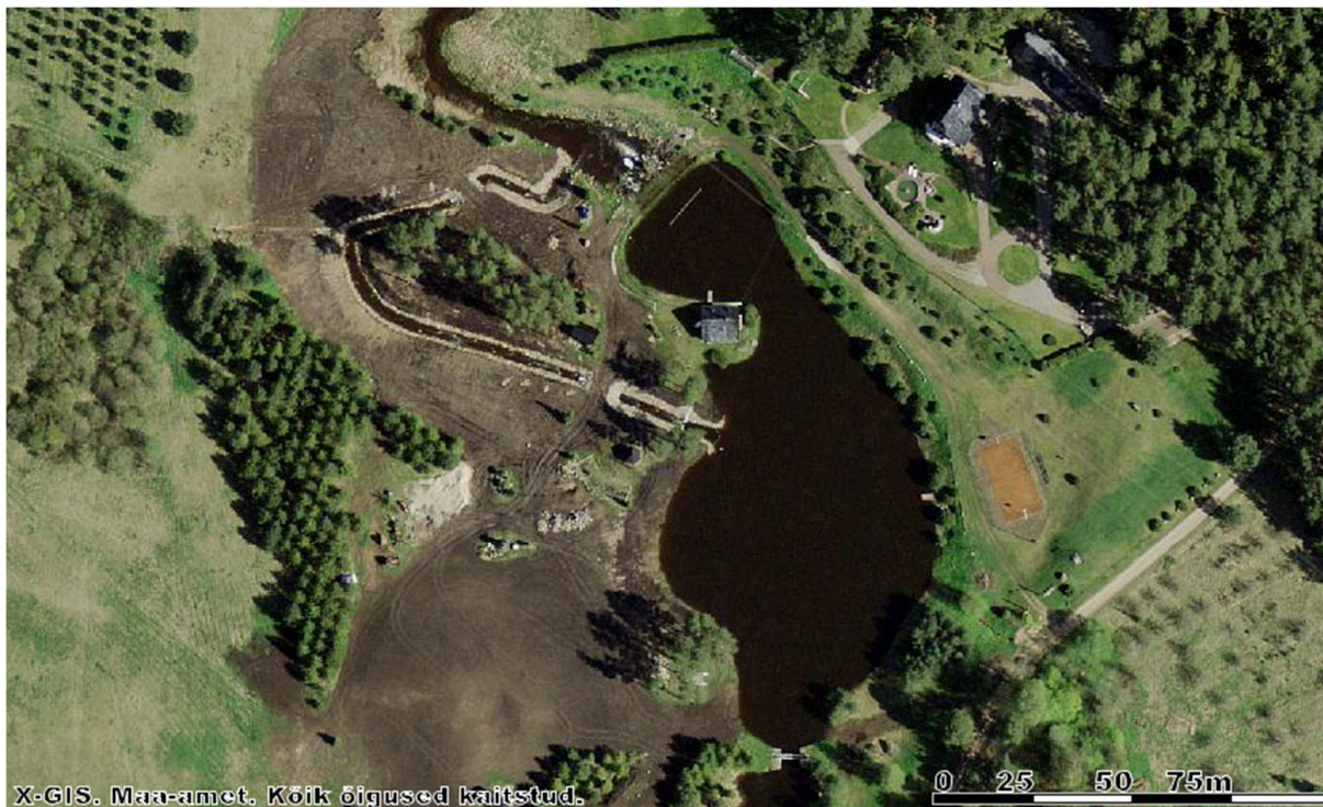
Joonis 1.2.11.3. Ploomi kalapääs asub jõe vasakul kaldal ning on hajuskärestiku tüüpi möödaviikpääs. Kalapääsul on kaks ihtüodukti, kust kalapääsust üle pääseb.
