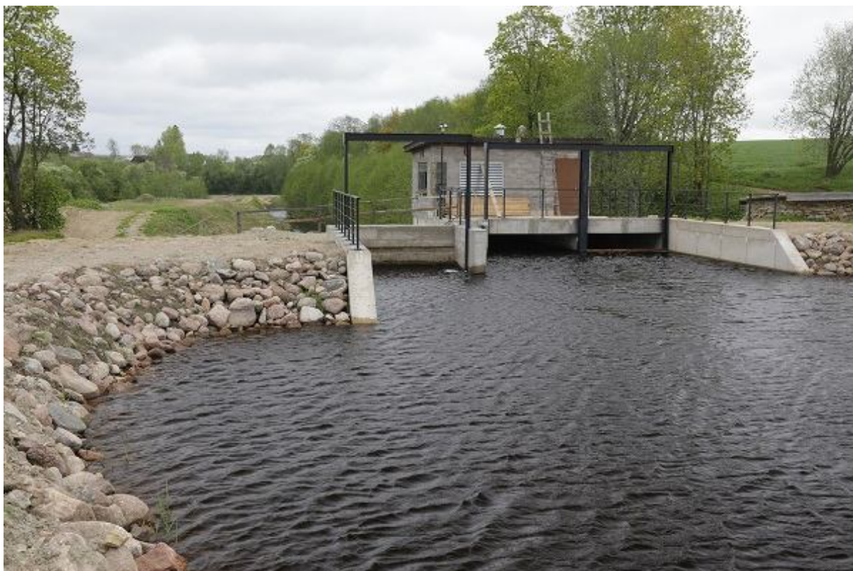
Foto 1.2.13.5. Sillaoru HEJ asub jõe paremale kaldale rajatud 500 m pikkuse derivatsioonikanali ülemisel kolmandikul. Jaamas on kaks turbiini, mis võimaldavad kasutada vooluhulki vahemikus 0,5 \dots 8 \text{ m}^3/\text{s} (23.05.2015, R. Järvekülg).
