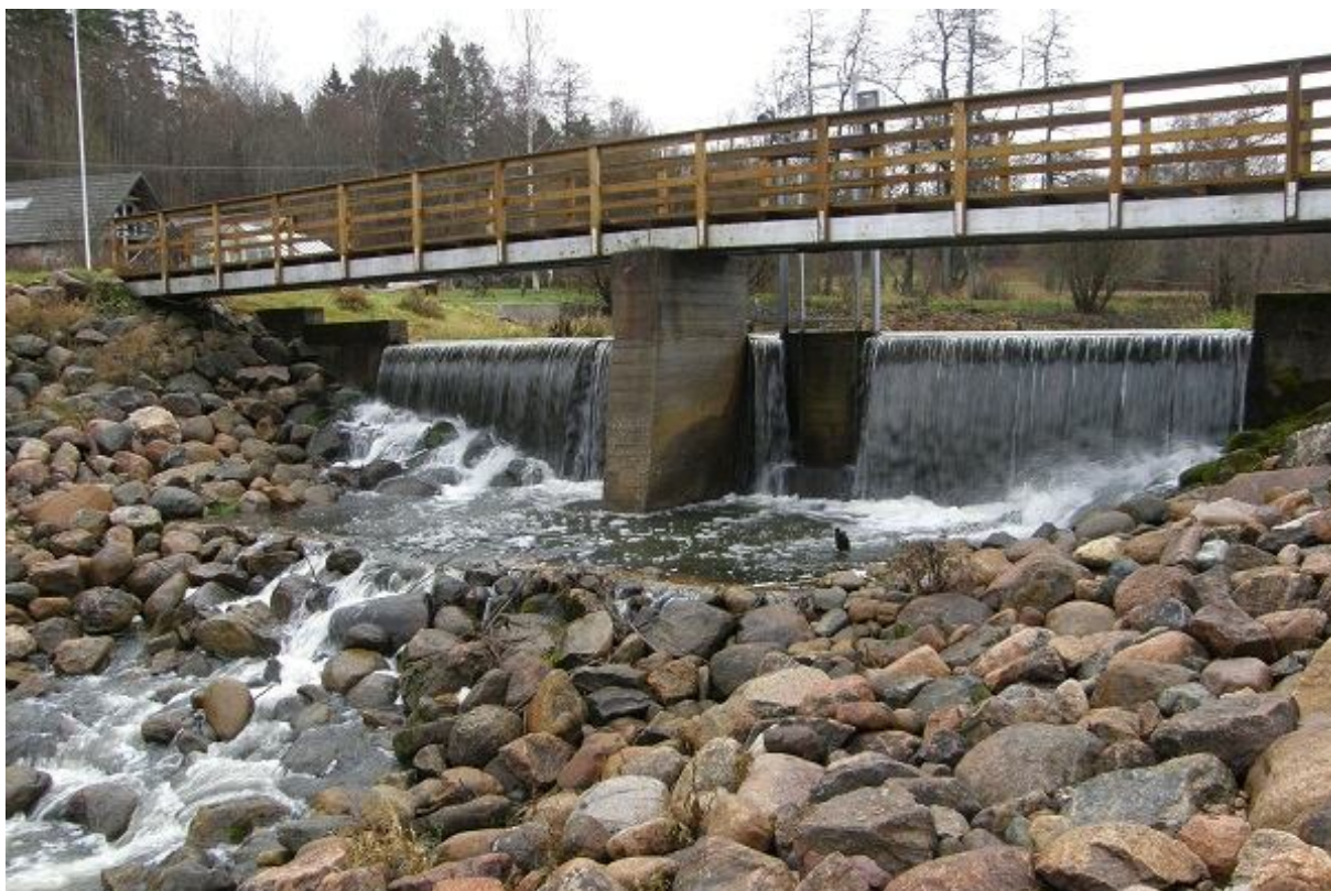
Foto 1.2.12.12. Kalade laskuv ränne on Sasi paisu juures võimalik ka liigveelaskme kaudu. Veerohkemal ajal on see kaladele ohutu, sest liigveelaskme all on piisava veetäitega bassein ja ka basseini väljavoolus on üle kivide veetäide olemas. Veevaesemal ajal võib osa kalu jääda liigveelasu alusel kivipuiste langul kivide vahele kinni jääda (20.11.2015, R. Pihu).
