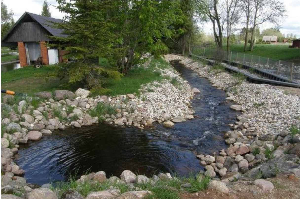
Foto 1.2.2.7. Karilatsi kalapääsu ülaosa 13.05.2015. Kalapääsu vooluhulk on lähedane projektijärgsele, vee liigvähendamist ei toimu (R. Pihu).
