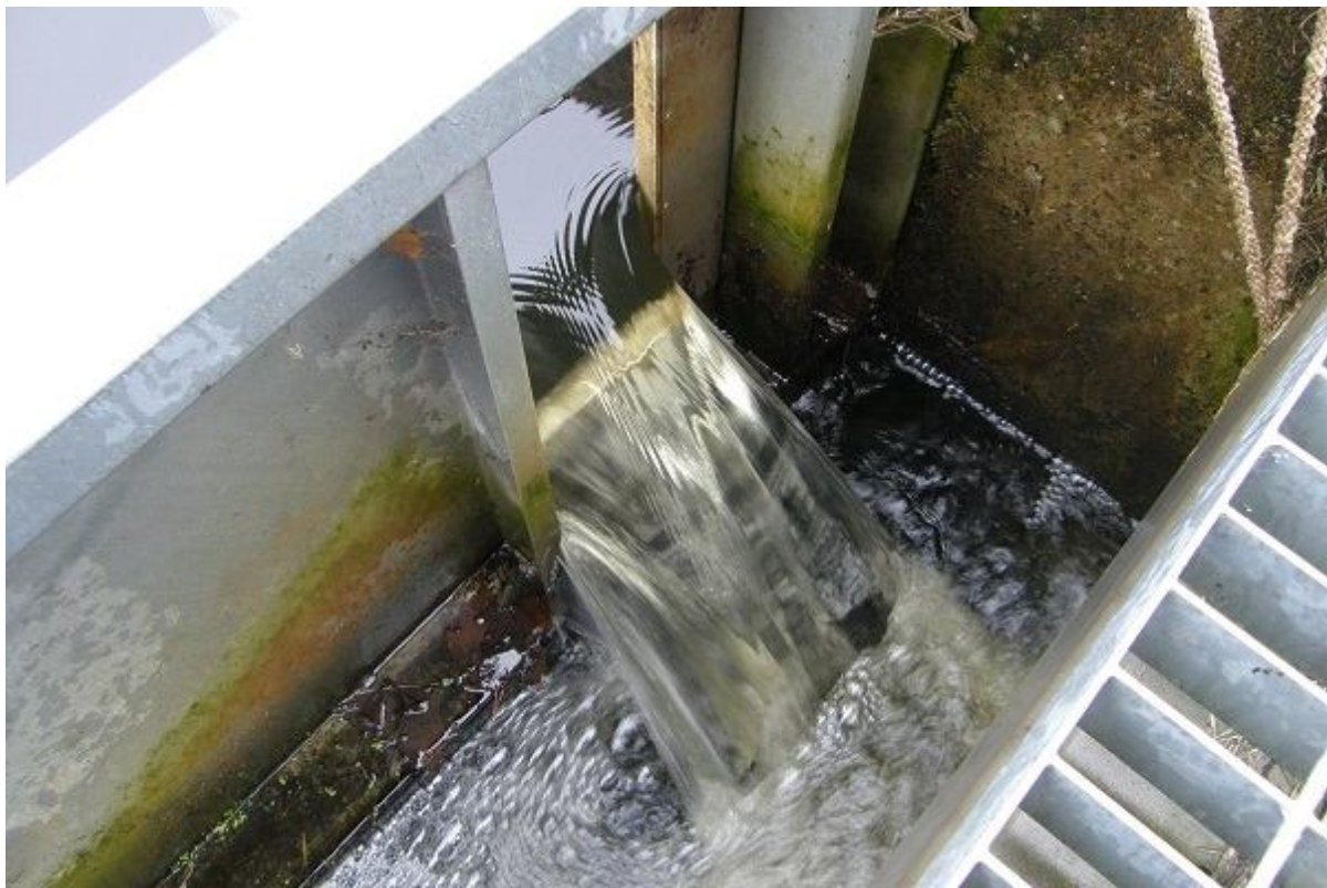
Foto 1.2.9.10. Kalapääsu sissevoolule jäi aga kaladele raskesti ületatav veeaste kogu seireajaks. 18.11.2015 oli veeaste sissevoolul 0,37 m (R. Pihu).
