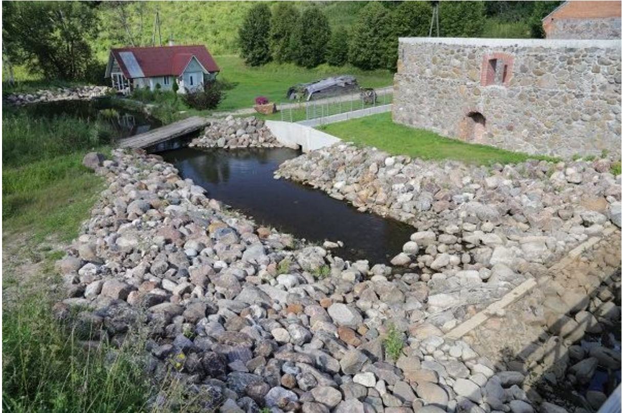
Foto 1.2.12.4. Vaade Sasi paisult allavoolu. Jõe paremal kaldal liigveelasust ca 15 m allavoolu asub kalapääsu väljavool (03.08.2015, R. Järvekülg).
