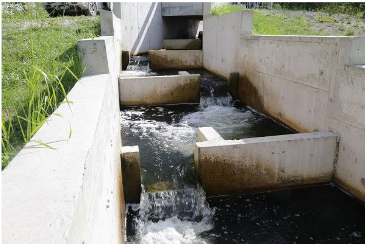
Foto 1.3.3.6. Roti kalapääsu ülaosa, vahetult allpool ihtüodukti. Vahed kambrite veetasemete vahel pole ühtlased, mõnede kambrite puhul on veetasemete vahed liiga suured. Nii 21.07.2015 kui ka 29.11.2015 varieerus veetasemete vahe kambrite vahel vahemikus 0,13-0,29 m. Probleemiks on läbivooluavade ummistumine prahiga (21.07.2015, R. Järvekülg).
