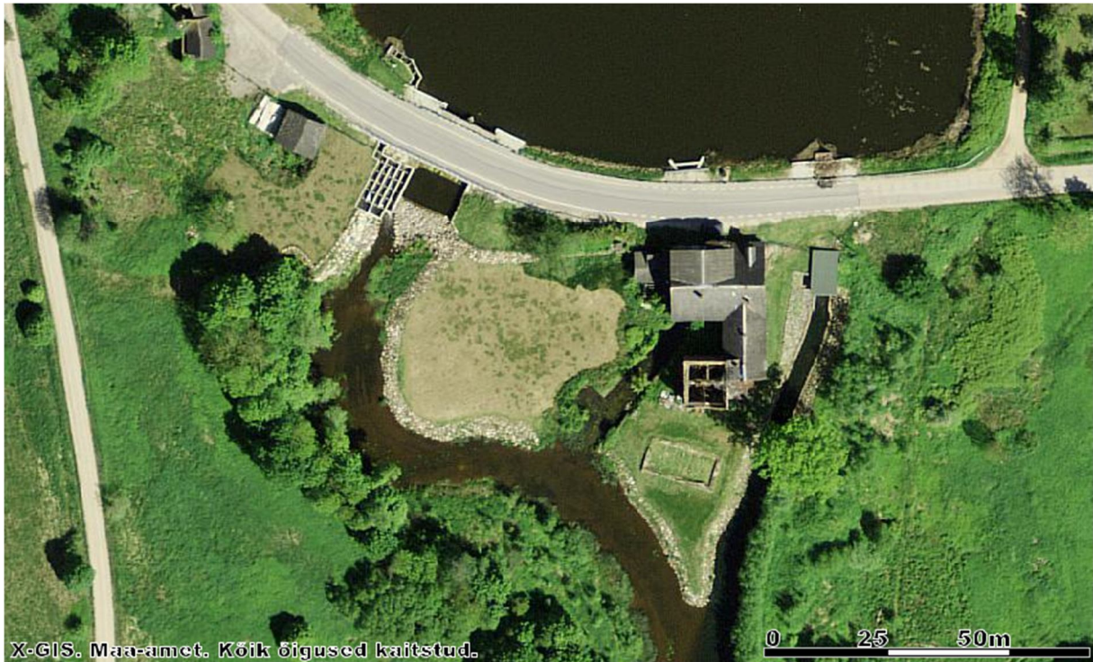
Joonis 1.2.14.3. Sangaste kamberkalapääs asub paisu parempoolses otsas liigveelasust paremal. HEJ asub seevastu paisu vasakpoolses servas. Keskmise veehaare on vana vesiveski derivatsioonikanal, aga sealtkaudu vee läbivoolu ei toimu.
