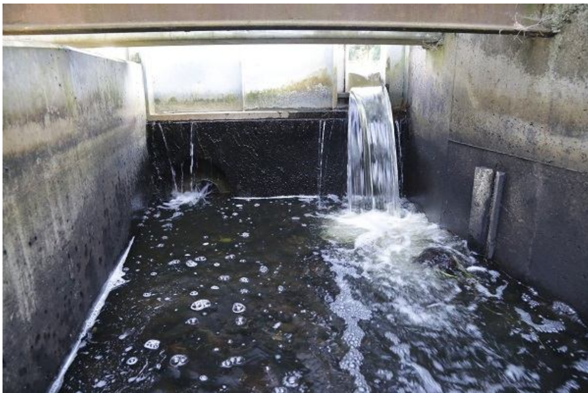
Foto 1.2.9.8. Kalapääsu sissevool paisjärvest. Vaatluspäeval oli põhjaava täielikult suletud. Pinnaava oli plekktahvliga ahendatud, veeaste paisjärve ja ülaveepoolse kambri vahel oli 0,81 m (25.08.2015, R. Järvekülg).
