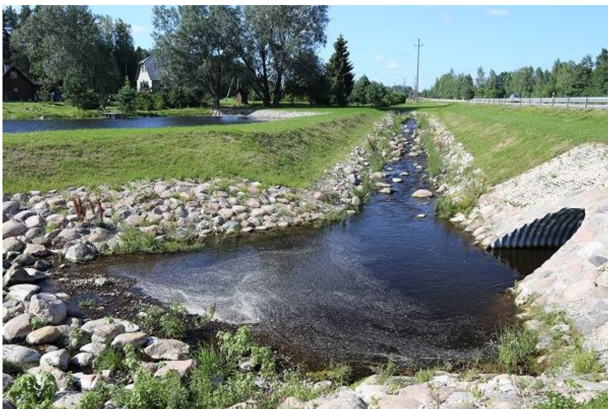
Foto 1.2.1.b.1. Vaade Leevi Veskijärve kalapääsule alavee poolt liigveelasu alt. Paijärv jääb fotol vasakule, paremale jääb Põlva-Reola mnt (10.07.2014, R. Järvekülg).
