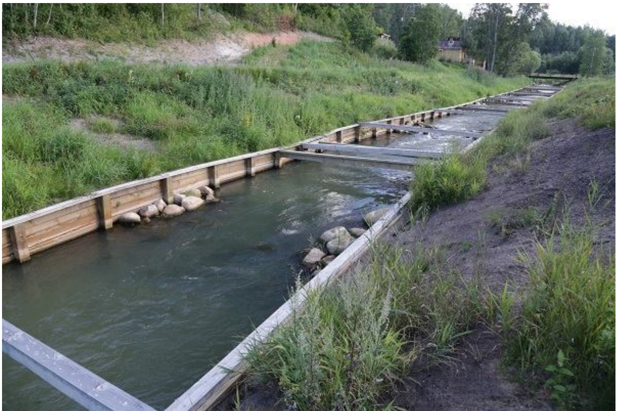
Foto 1.2.15.6. Tsüdsina kalapääsu keskosa. Füüsiliselt peaks kalapääsu läbimine kaladele igati jõukohane olema. Kiviülevoolud on rajatud vaiadest ja geovõrgust põhjakindlustusele (vt fotod 1.2.16.11 kuni 1.2.16.14) (14.08.2015, R. Järvekül).
