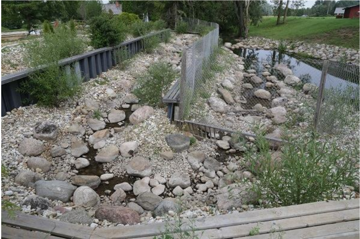
Foto 1.2.2.5. Karilatsi kalapääsu alumine osa madalvee ajal. Vooluhulk kalapääsus on < 1 \text{ l/s} (12.08.2015, R. Järvekülg).
