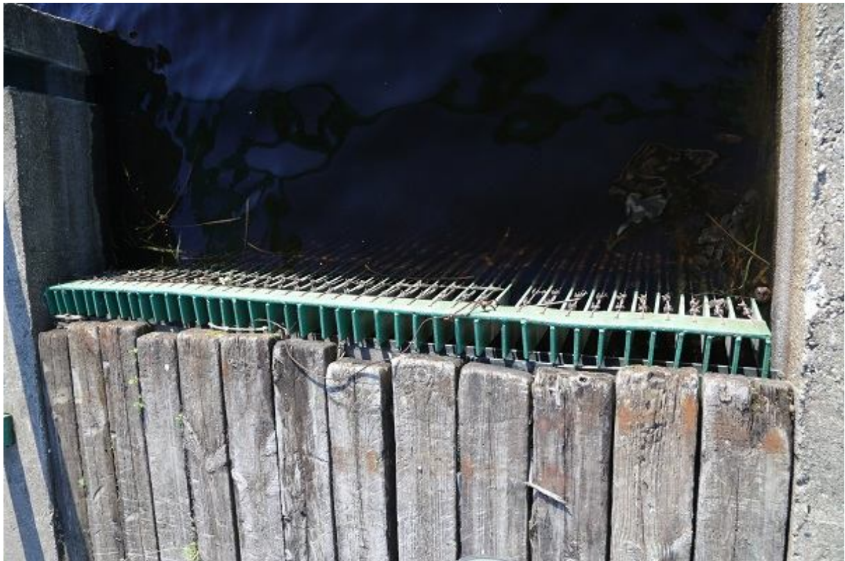
Foto 1.2.8.14. Võre HEJ sissevoolušahti ees. Metallrest vahedega 30...40 mm on trossidega tihedamaks muudetud. Vahed trosside ja metalllehtede vahel olid ebaühtlased vahemikus 15...25 mm. Üks trossidest oli katki, suurim vahe oli võre ja betoonšahti seina vahel – 55 mm. Seega võisid võrest läbi minna isegi 40...50 cm pikkused kalad (13.08.2015, R. Järvekülg).
