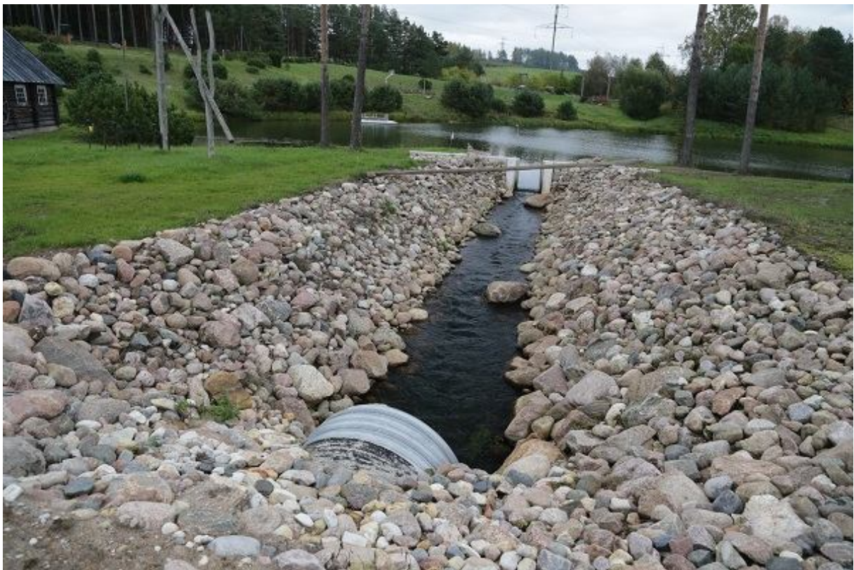
Foto 1.2.11.7. Kalapääsu ülemine osa, ülemisest ihtüoduktist paisjärve poole (01.10.2015, R. Järvekülg).
