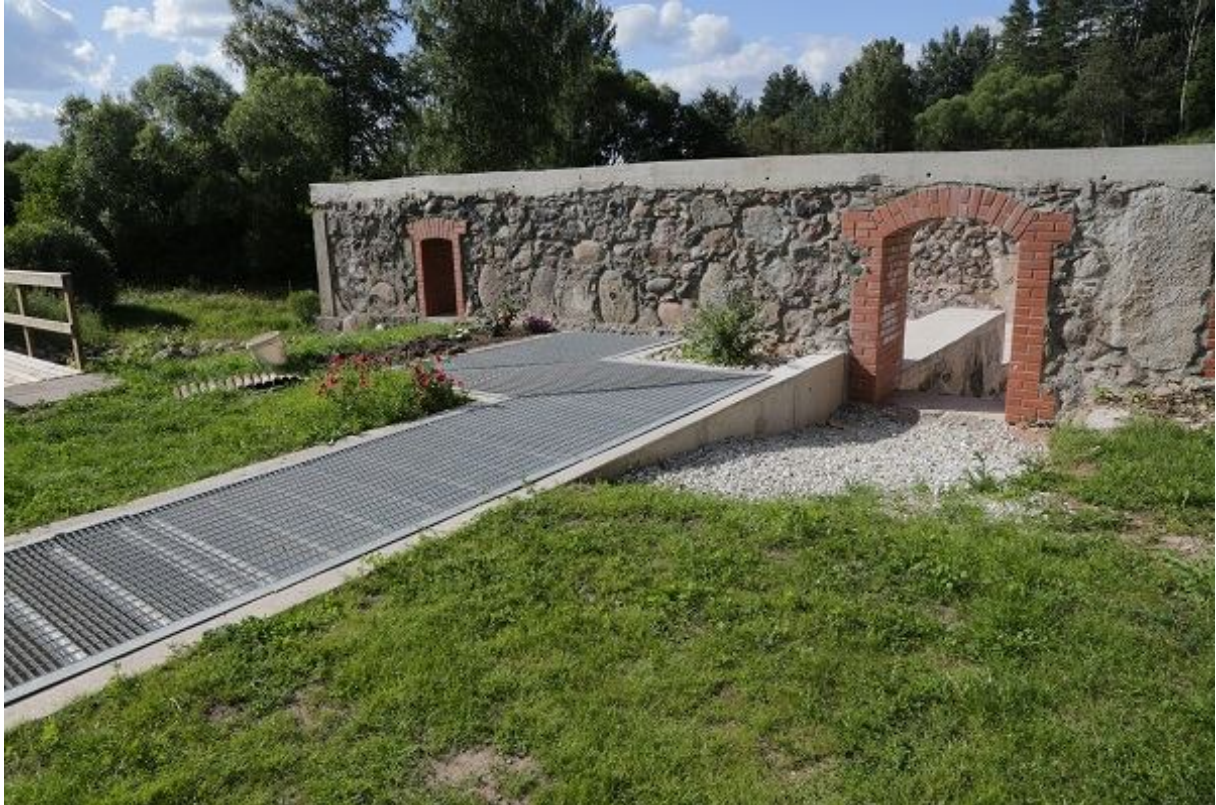
Foto 1.2.12.6. Sasi kamberkalapääsu ülemine osa veskihoone ja paisjärve vahel (03.08.2015, R. Järvekülg).
