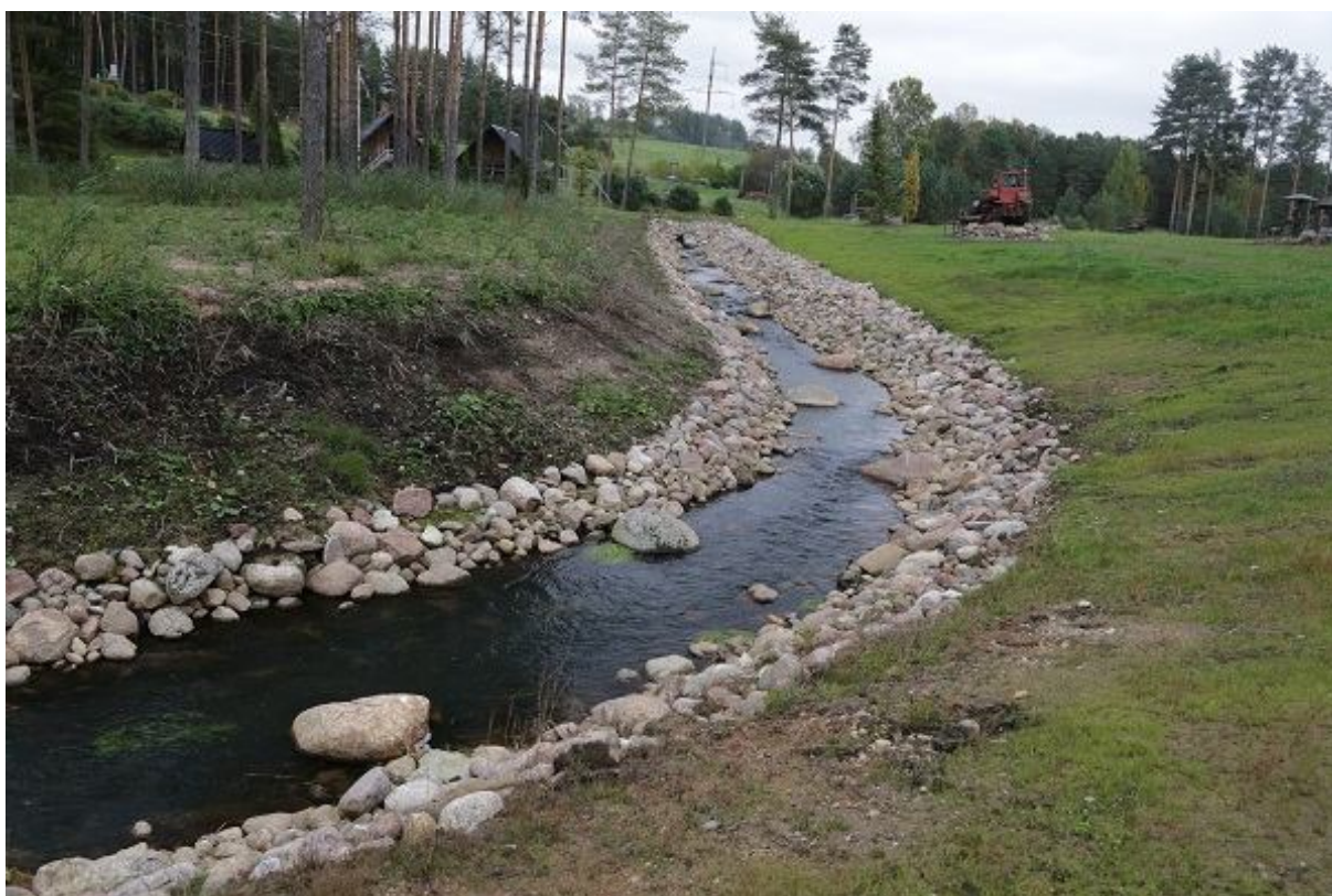
Foto 1.2.11.1. Ploomi kalapääs on väikese languga hajuskärestiku tüüpi möödaviik-pääs. Vaade kalapääsu keskosale ülesvoolu suunas (01.10.2015, R. Järvekülg).
