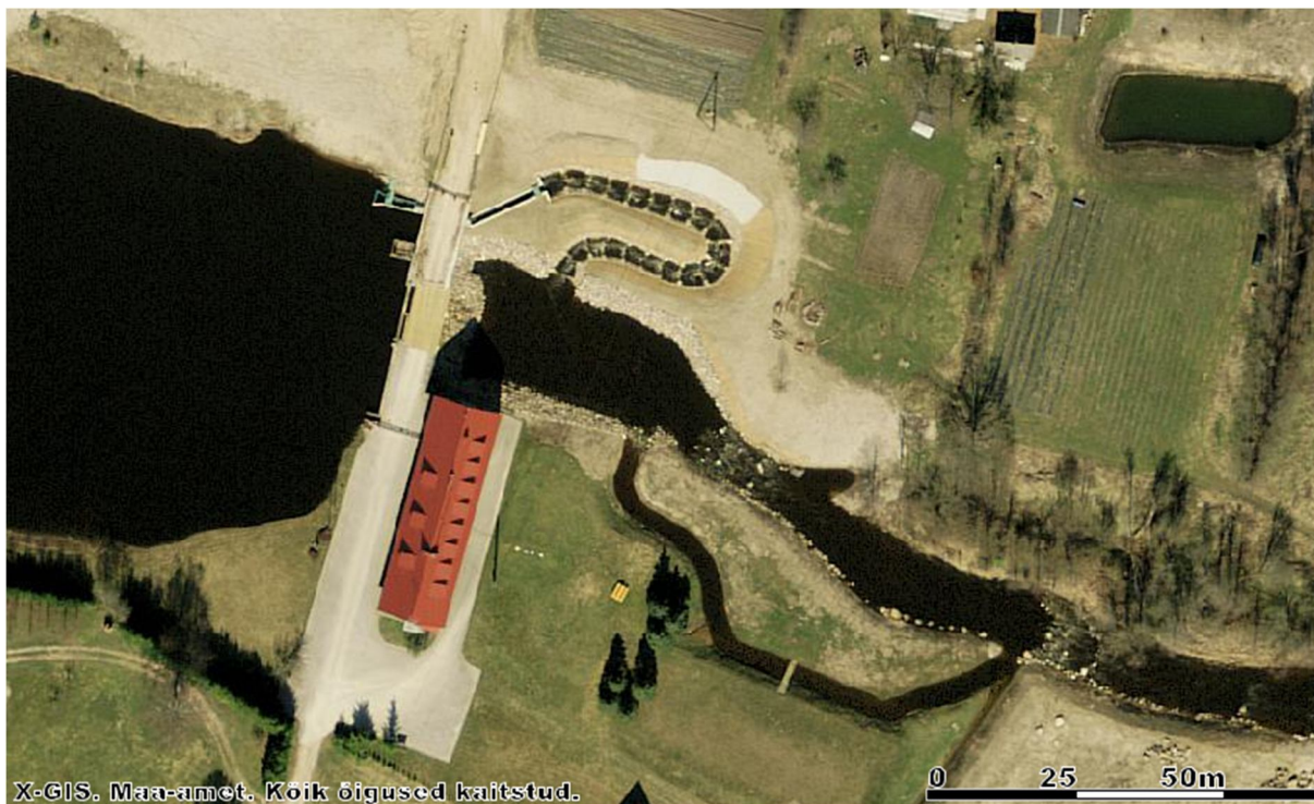
Joonis 1.2.8.3. Kalapääs asub jõe vasakul kaldal ja on oma tüübilt tiikide kaskaadi ja pilupääsu kombinatsioon. Kalapääsu alavee poolne pikem osa on loodusilmeliste tiikide kaskaad, ülavee poolne osa koosneb 0-languga betoonkanalist (vahetult tee tammist allavoolu jääv osa) ja pilupääsu kambritest (tee tammi all ja sellest ülesvoolu jääv osa).
