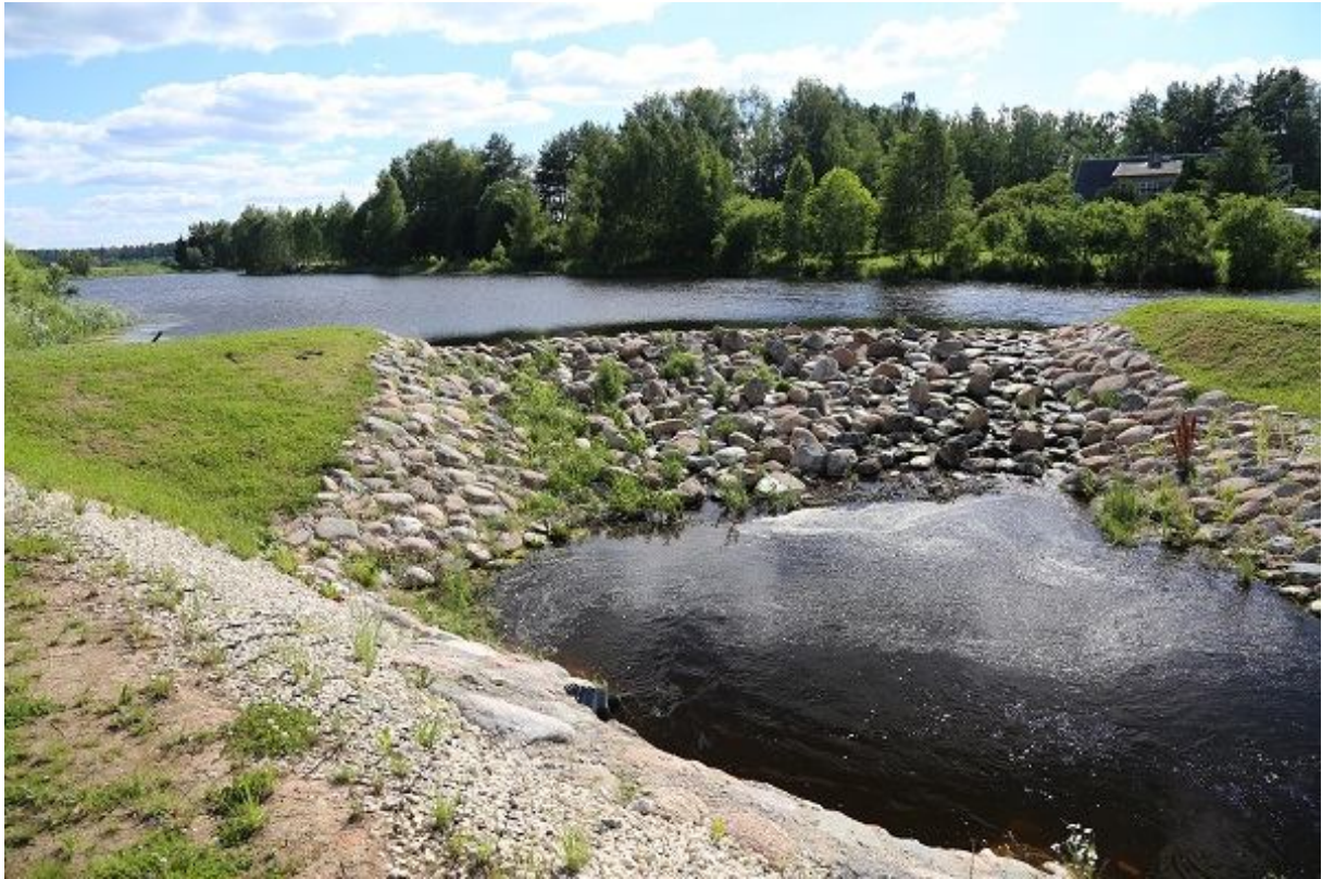
Foto 1.2.1.b.6. Leevi Vesikjärve liigveelask. Laskumine kaladele on suurvee ajal ohutu, madalvee ajal on veekiht ülevoolul õhuke ning kalad tavaliselt väldivad liigveelasule sattumist (10.07.2014, R. Järvekülg).
