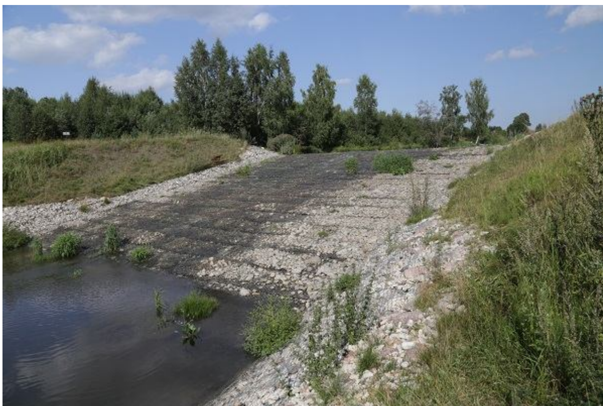
Foto 1.2.1.a.11. Leevi Külajärve liigveelask. Kalade laskumine liigveelasu kaudu on veerohkel ajal ohutu, veevaesel ajal võivad kalad kivide vahele takerdudes hukkuda, kuid enamasti kalad väga õhukeses veekihis üle liigveelasu laskumist väldivad (11.08.2015, R. Järvekülg).
