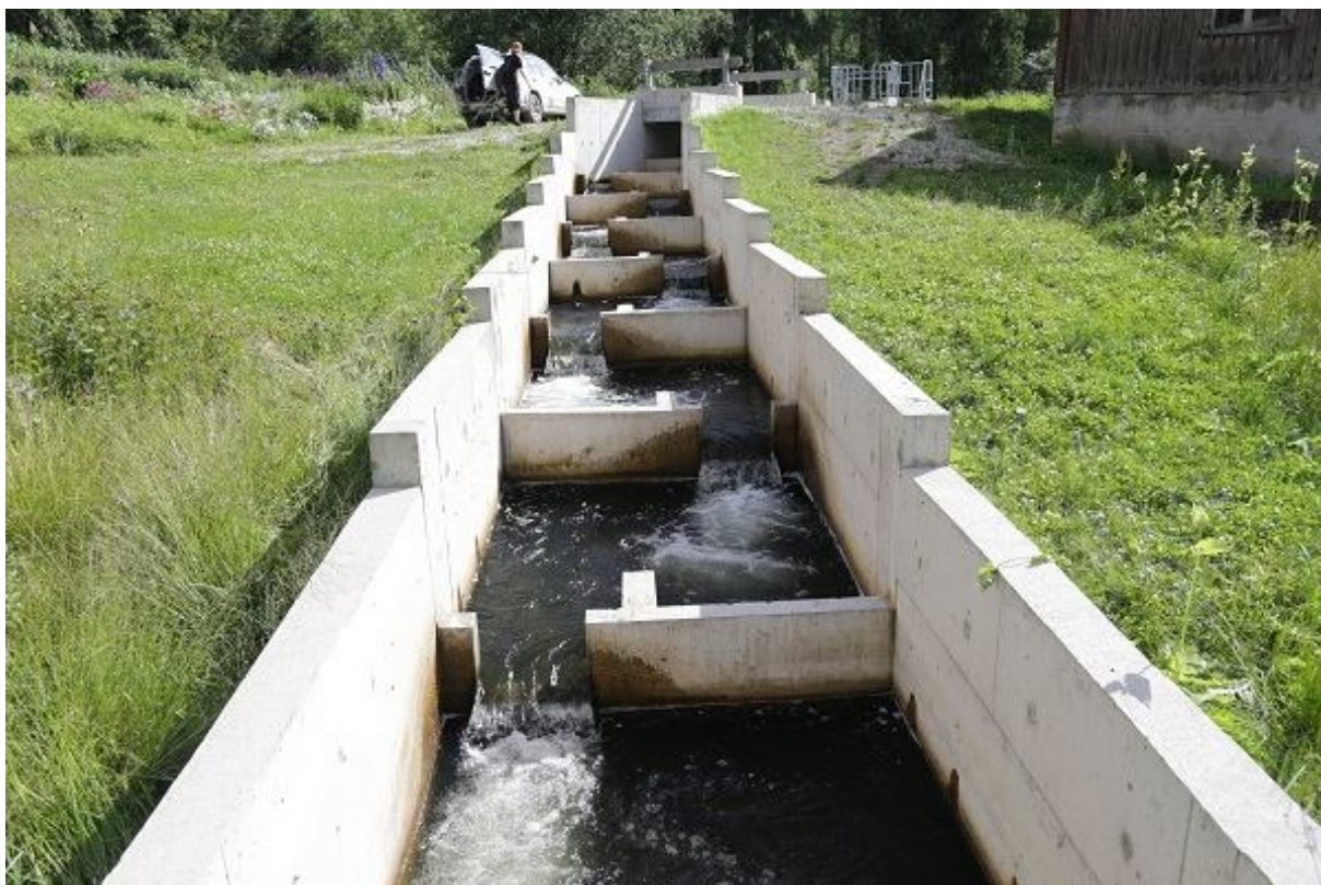
Foto 1.3.3.5. Roti kalapääsu keskosa. Kamberkalapääsu üheks miinuseks on see, et põhjaavad puuduvad (21.07.2015, R. Järvekülg).
