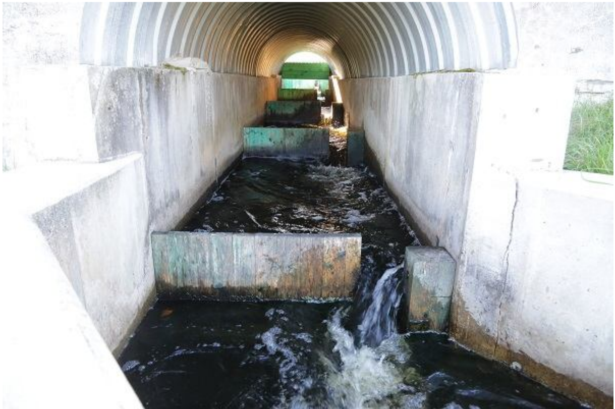
Foto 1.2.8.10. Pilupääsu osa ihtüodukti truubis (13.08.2015, R. Järvekülg).
