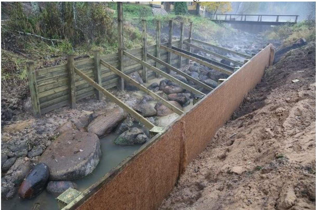
Foto 1.2.15.14. Kalapääsu ülemises osas hakkas kalapääsu põhi kandma ning sinna oli võimalik kujundada kivine põhi ja kaldad (10.10.2014, R. Järvekülg).
