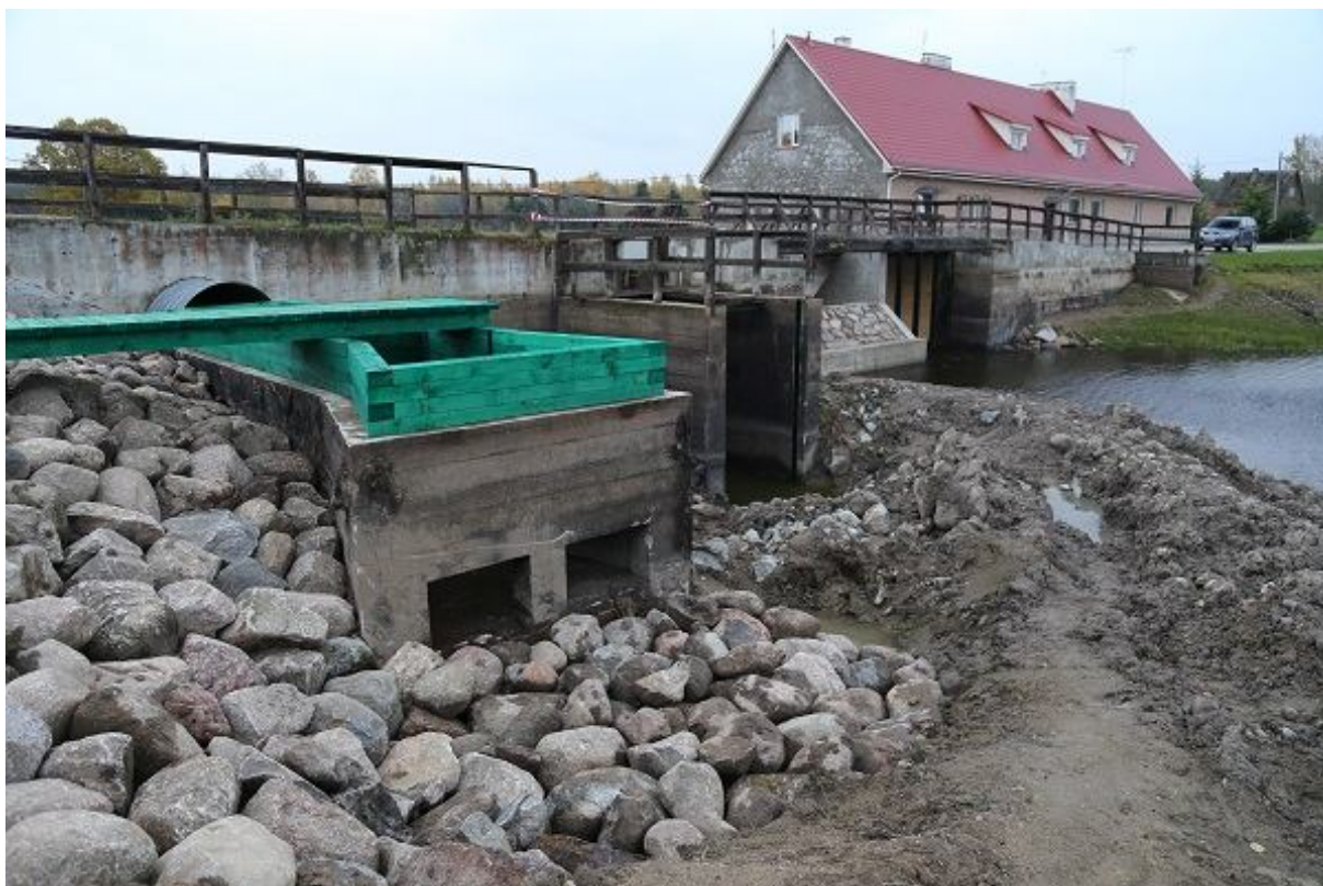
Foto 1.2.8.13. Koseveski pais ülavee poolt vaadates kalapääsu ehituse ja paisu rekonstrueerimise ajal (paisjärv alla lastud) (09.10.2013, R. Järvekülg).
