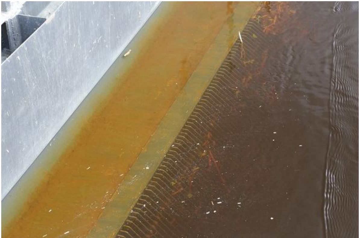
Foto 1.2.13.8. Tegemist on ühe kõige korralikuma seni nähtud võrega Eesti hüdroelektrijaamade juures. Kõik võre avad on horisontaalselt täpselt 25 mm. Nagu näitasid kalade laskuva rände uuringud 2015. a kevadel, lähevad meriforelli ja lõhe 2-aastased laskujad siiski võrest küllalt hõlpsalt läbi. Varam laialt levinud arvamus, et kalad küll mahuvad võrest läbi, aga võre toimib visuaalse barjäärina, ei leidnud uuringutes kinnitust (14.05. 2015, R. Järvekülg).
