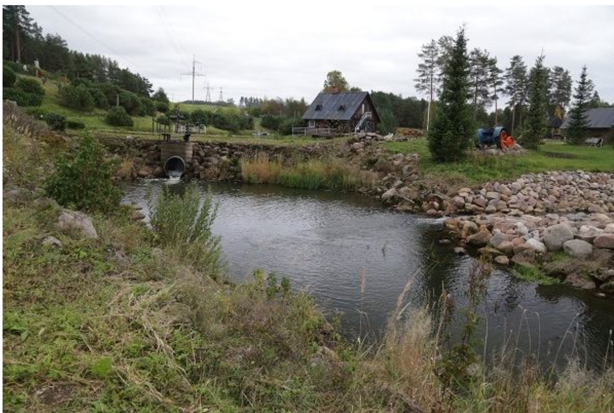
Foto 1.2.11.2. Vaade Ploomi paisule alavee poolt. Vasakul kaldal (fotol paremal) on näha kalapääsu väljavoolu suubumiskoht jõkke (01.10.2015, R. Järvekülg).
