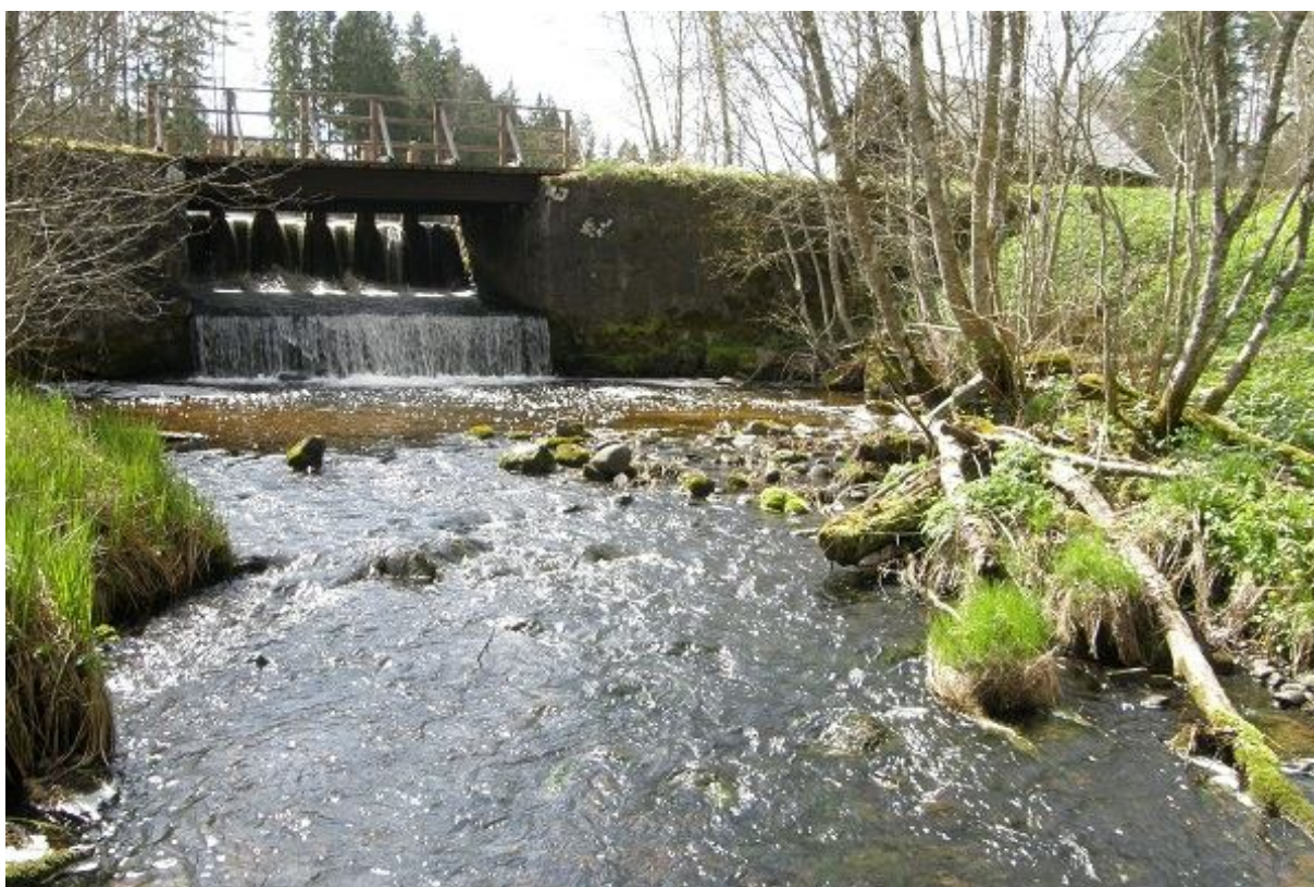
Foto 1.3.3.11. Roti paisu liigveelask. Kalade laskumistingimused pole kiita. Üle liigveelasu laskuvad kalad kukuvad algul ca 1,6 m kõrguselt kaldega betoonpõrnadale. Alumine 0,9 m toimub juba vette (30.04.2015, R. Pihu).
