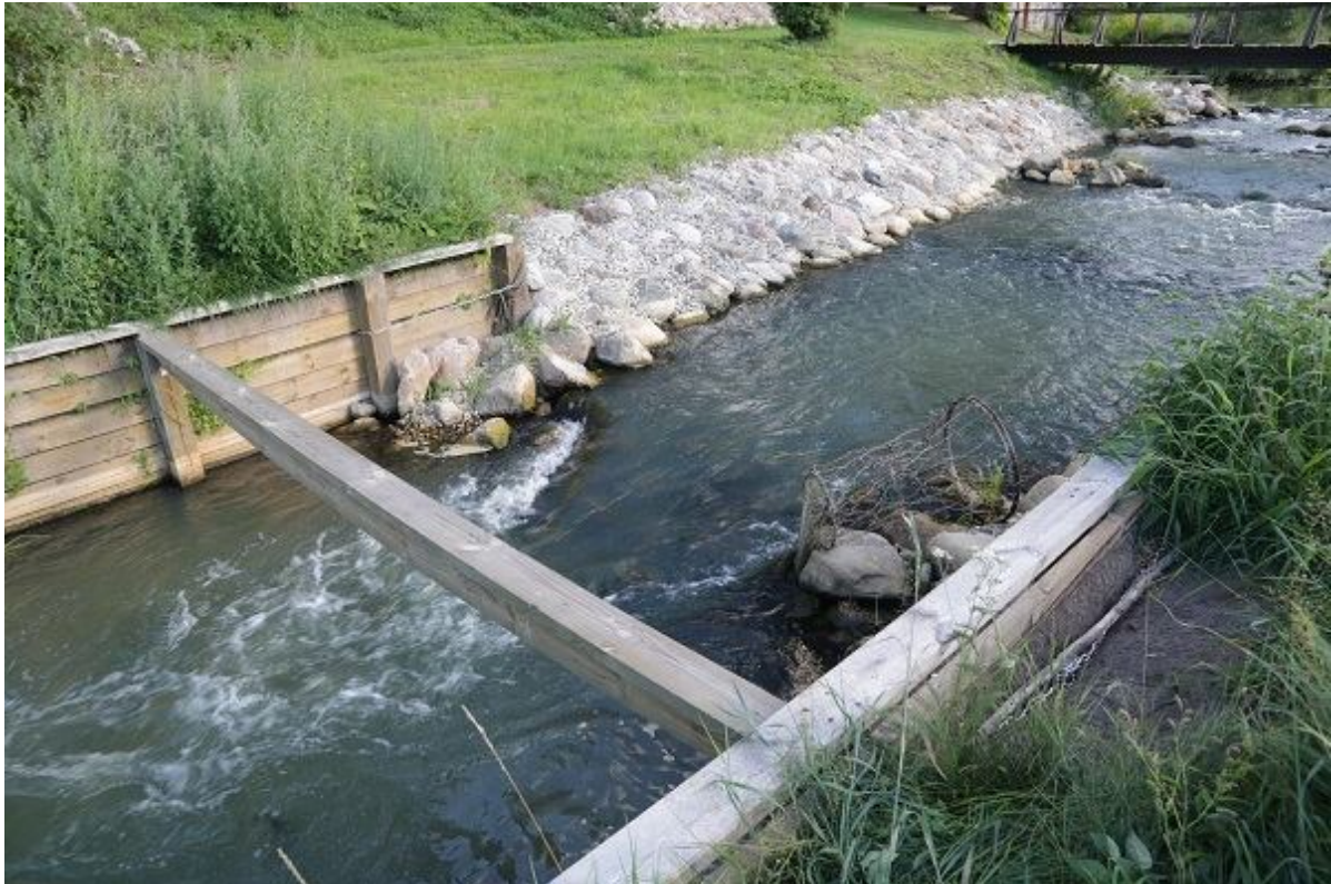
Foto 1.2.15.7. Tsüdsina kalapääsu ülaosa, ülemineku koht laudadega kindlustatud kallastega pehmepõhjaliselt kalapääsu osalt kõvapõhjalisele kivitallakindlustusega osale (14.08.2015, R. Järvekülg).
