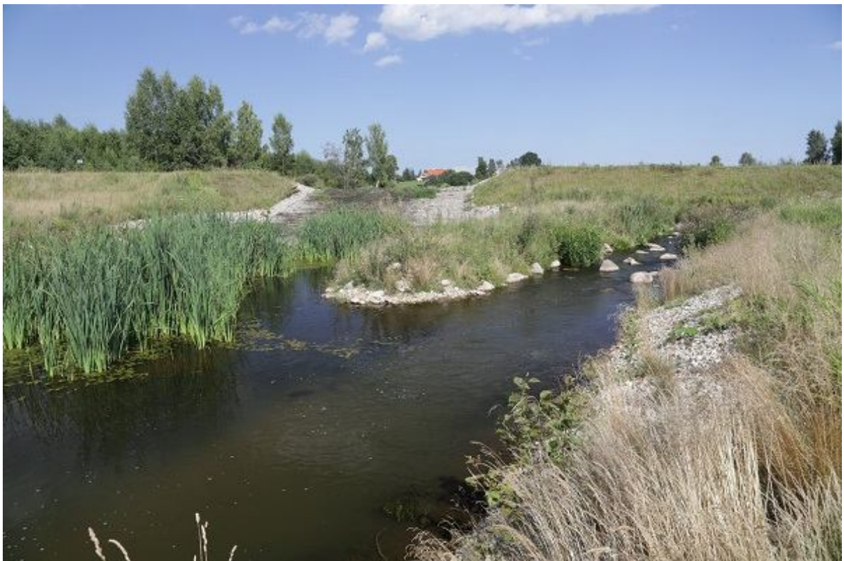
Foto 1.2.1.a.3. Kalapääsu väljavool suvisel madalvee perioodil. Veetaimestiku areng näitab, et enamiku aastast on peavoolu kohaks kalapääs (11.08.2015, R. Järvekülg).
