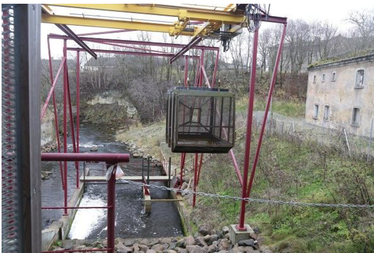
Foto 1.2.7.1. Kalalift tõuseb ülavee poole. Käimas on lifti töö testimine (17.11.2015, R. Järvekülg).
