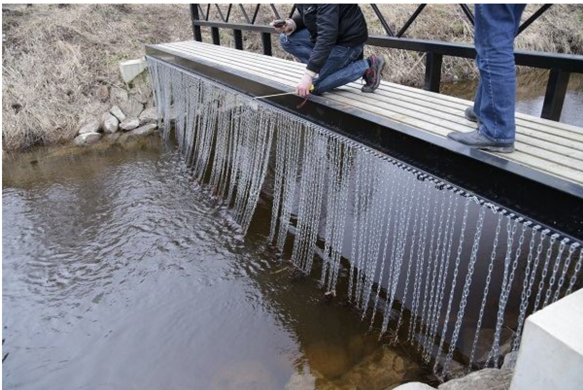
Foto 1.2.10.3. HEJ väljavoolukanali suudme-eel on kettidest kardin – vertikaalsete ülalt kinnitatud kettide jada sammuga 40 mm. Kalu see tõenäoliselt oluliselt ei tõkesta, sest juba väga väikeste HEJ vooluhulkade juures tekivad veevoolu tõttu kettide vahele >0,2 m laiused vahed (20.03.2015, R. Järvekülg).
