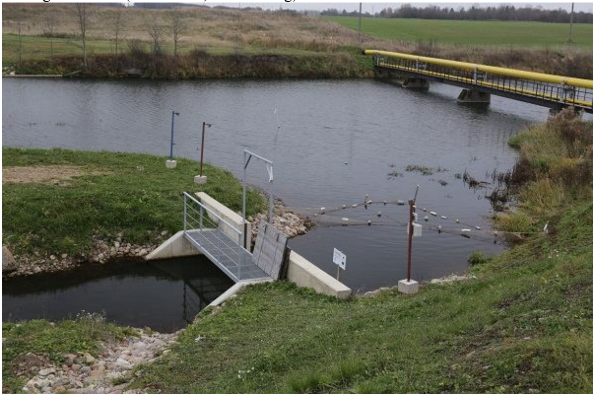
Foto 1.2.13.16. Sügisel uuriti Sillaoru kalapääsu juures kalade tõusvat rännet. Mõrraga suleti kalapääsu sissevool. Kuna mõrd esimestel öödel kohe lõhuti, siis telliti mõrrale seireperioodiks ööpäevaringne turvafirma valve (kaamerapostid kallastel) (22.10.2015, R. Järvekülg).
