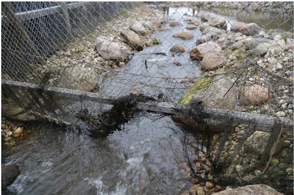
Foto 1.2.2.12. Karilatsi kalapääsu väljavool kalade sügisrände perioodil. Kalapääsu väljavool on suletud võrkudega, ajutiselt on võrk osaliselt üles tõstetud (29.11.2015, A. Sinimets).
