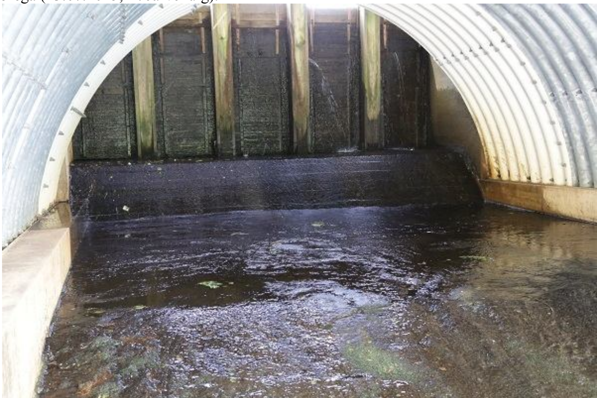
Foto 1.2.14.14. Kalade laskuv ränne on võimalik ka liigveelasu kaudu, loomulikult eeldusel, et liigveelasu kaudu vett üldse lastakse. Laskumine liigveelasu pole kaladele ohutu. Laskuvad kalad kukuvad >2 m kõrguselt rõhtsale veetaiteta betoonpinnale, mis alles tagapool omandab kalde allavoolu suunas. Väikeste ülevoolude korral võivad kalad kinni jääda ka liigveelasu alusel kivipuistelangul (vt fotod 1.12.14.4 ja 1.2.14.5) (23.07.2015, R. Järvekülg).
