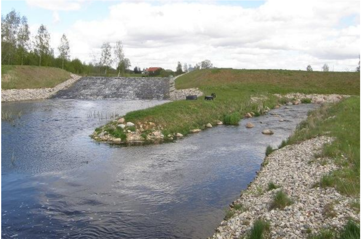
Foto 1.2.1.a.2. Leevi Külajärve kalapääsu väljavool kevadseire perioodil. Nii vaatluse kui läbiviidud kalastiku-uuringute põhjal saab järeldada, et kalapääsu väljavool on tõusval rändel olevate kalade jaoks suhteliselt lihtsalt leitav (13.05.2015, R. Järvekülg).
