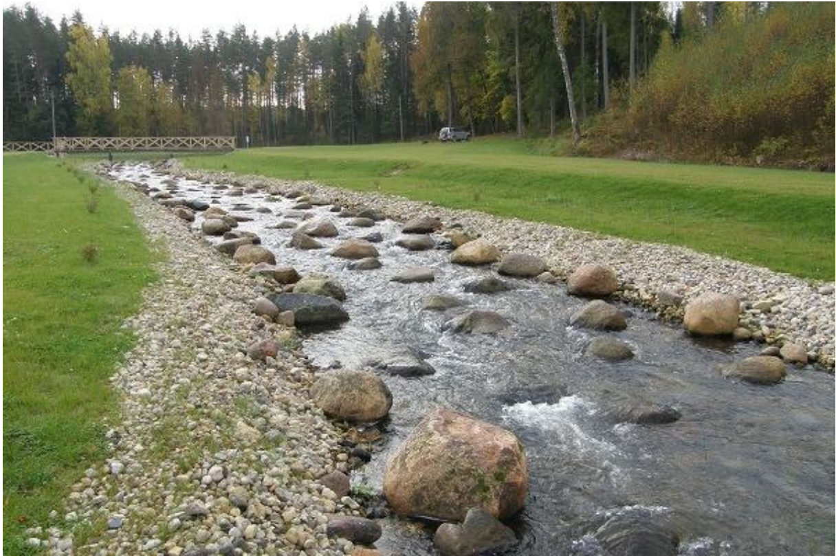
Foto 1.2.4.4. Aarna kalapääsu keskosa. Kärestik on kaladele hästi läbitav (05.10.2015, R. Pihu).
