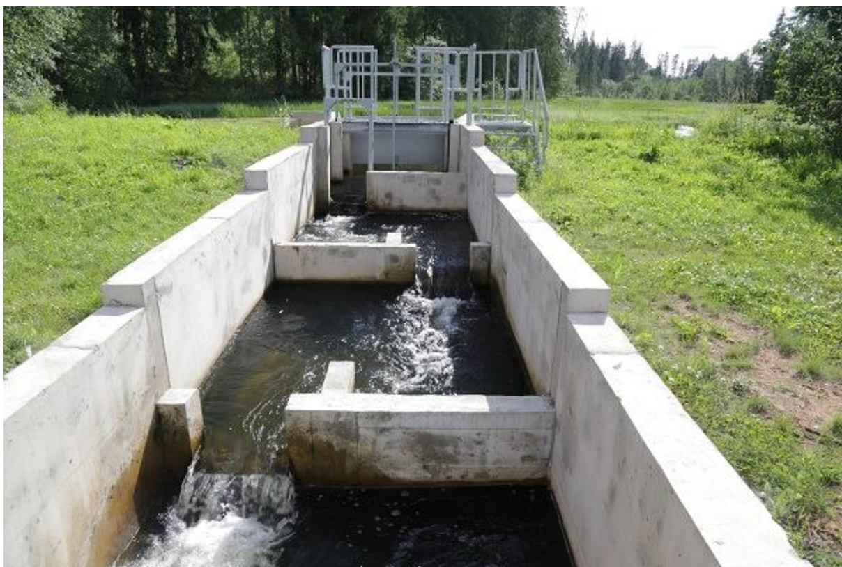
Foto 1.3.3.7. Roti kalapääsu sissevool (21.07.2015, R. Järvekülg).
