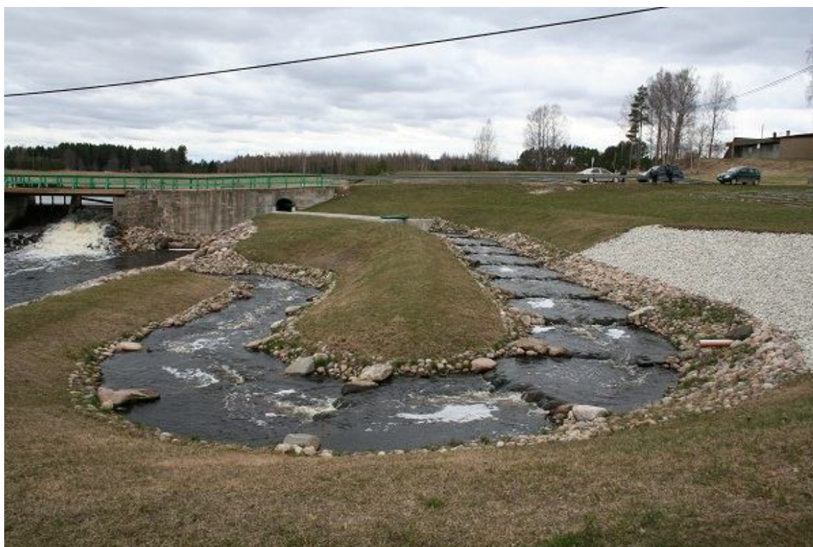
Foto 1.1.2. Tiikide kaskaadi tüüpi kalapääs (Kääpa jõgi, Koseveski kalapääsu alumine osa, 20.03.2015, R. Järvekülg).
