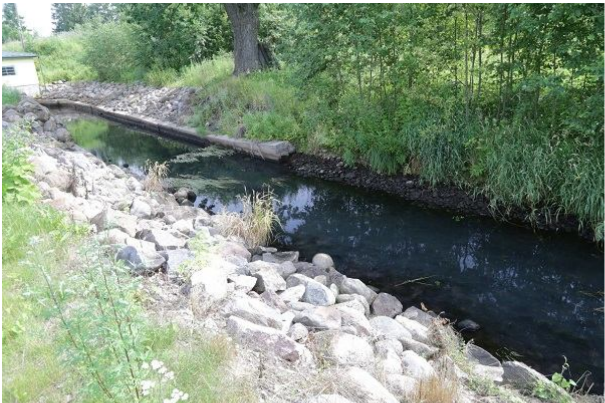
Foto 1.2.14.12. Samasugused ca 0,3 m kõrgused niisked randid olid vaatluspäeval (23.07.2015) ka HEJ äravoolukanali servades, mis näitab, et madalvee perioodil töötab Sangaste HEJ tsükliliselt vett kogudes ja jõe äravoolu reguleerides (R. Järvekülg).
