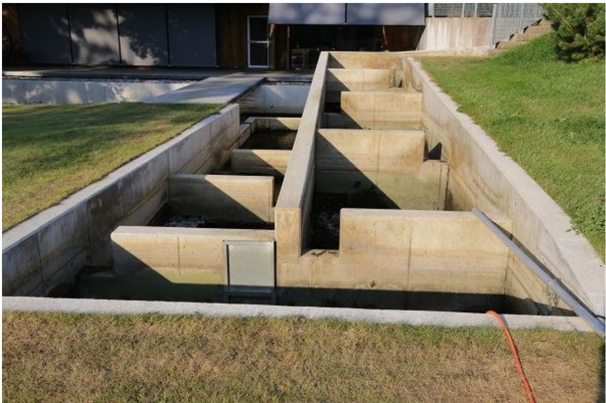
Foto 1.2.9.6. Loo kalapääsu keskosa madalvee tingimustes 25.08.2015. Pinnaavadest vett ei voolanud, veetäide kambrites varieerus vahemikus 0,15...0,4 m (R. Järvekülg).
