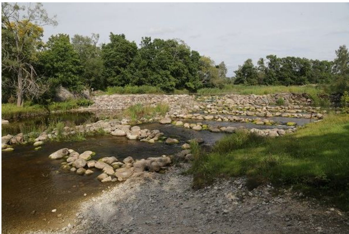
Foto 1.2.17.1. Vaade kalapääsule alavee poolelt jõe vasakult kaldalt. Kalapääsu alumine ja keskosa on kaladele väga hästi läbitavad (27.08.2015, R. Järvekülg).
