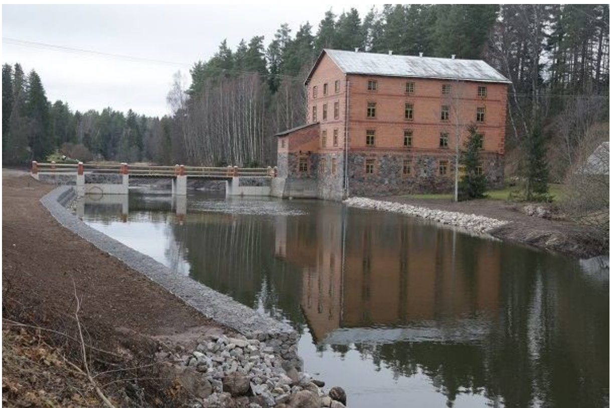
Foto 1.2.6.1. Ahja jõgi Kiidjärve veski juures pärast paisu likvideerimist, silla renoveerimist ja jõe kaldaalade korrastamist. 6 km allavoolu asuva Saesaare paisu paisutus ulatub üsna täpselt vana Kiidjärve veskihooneni (30.11.2015, R. Järvekülg).
