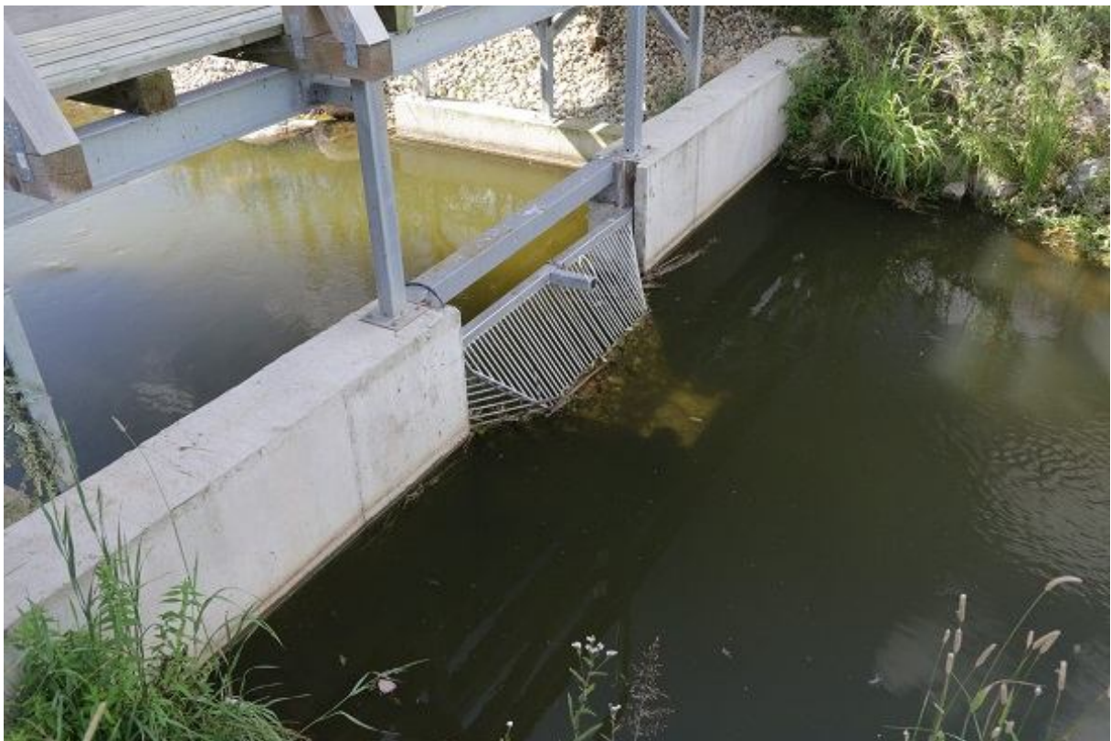
Foto 1.2.1.a.7. Leevi Külajärve kalapääsu sissevooluregulaator, avas on näha kalaloendur (11.08.2015, R. Järvekülg).
