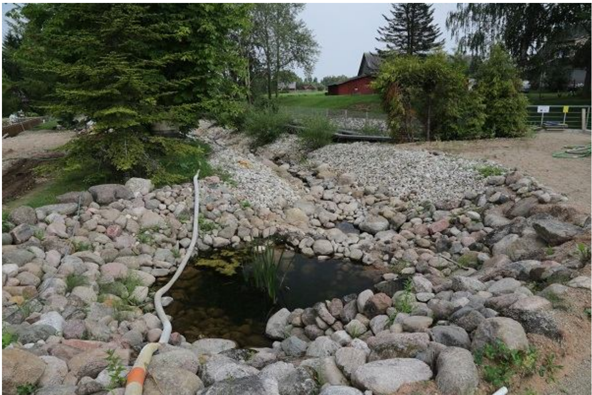
Foto 1.2.2.8. Karilatsi kalapääsu ülaosa madalvee ajal vee liigvähendamise tingimustes (12.08.2015, R. Järvekülg).
