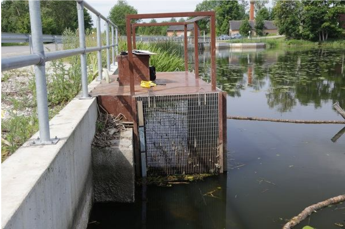
Foto 1.2.14.13. HEJ sissevooluotsaks paisjärves. Sissevoolul on võre avadega 18 x 46 mm. Kalade ohutuse seisukohalt on tegemist ühe parima Eesti elektrijaamade juures kasutatava võrega (23.07.2015, R. Järvekülg).
