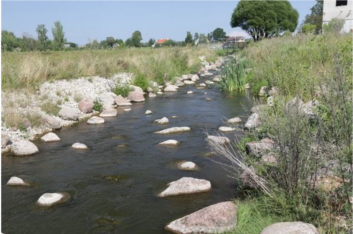
Foto 1.2.1.a.6. Leevi Külajärve kalapääsu ülaveepoolne osa, ca 180 m väljavoolust ülesvoolu. Esiplaanil on väiksema languga ning laiem puhkebassein (11.08.2015, R. Järvekülg).
