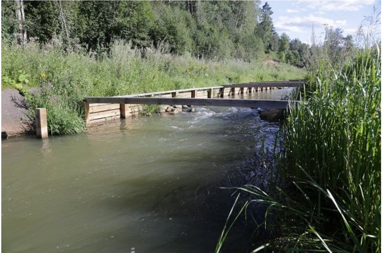
Foto 1.2.15.5. Tsüdsina kalapääsu väljavool suvise keskmise veetaseme tingimustes (14.08.2015, R. Järvekül).
