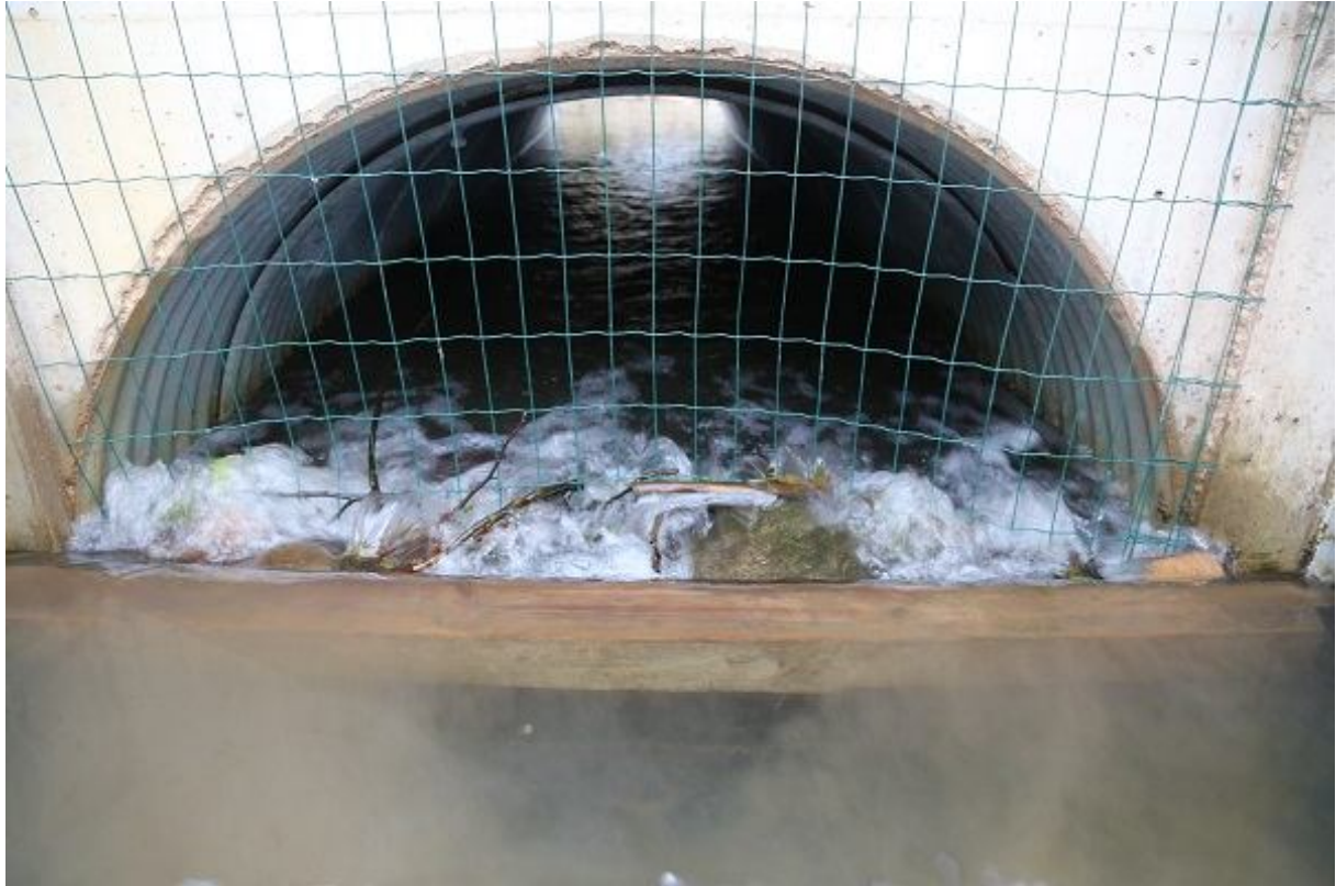
Foto 1.2.2.11. Karilatsi kalapääsu sissevool kalade sügisrände perioodil. Kalapääsu sissevoolu ees on varjad ja lisaks on varjadest kõrgemal ees metallvõrk. Kalade läbipääs on välistatud (29.11.2015, A. Sinimets).
