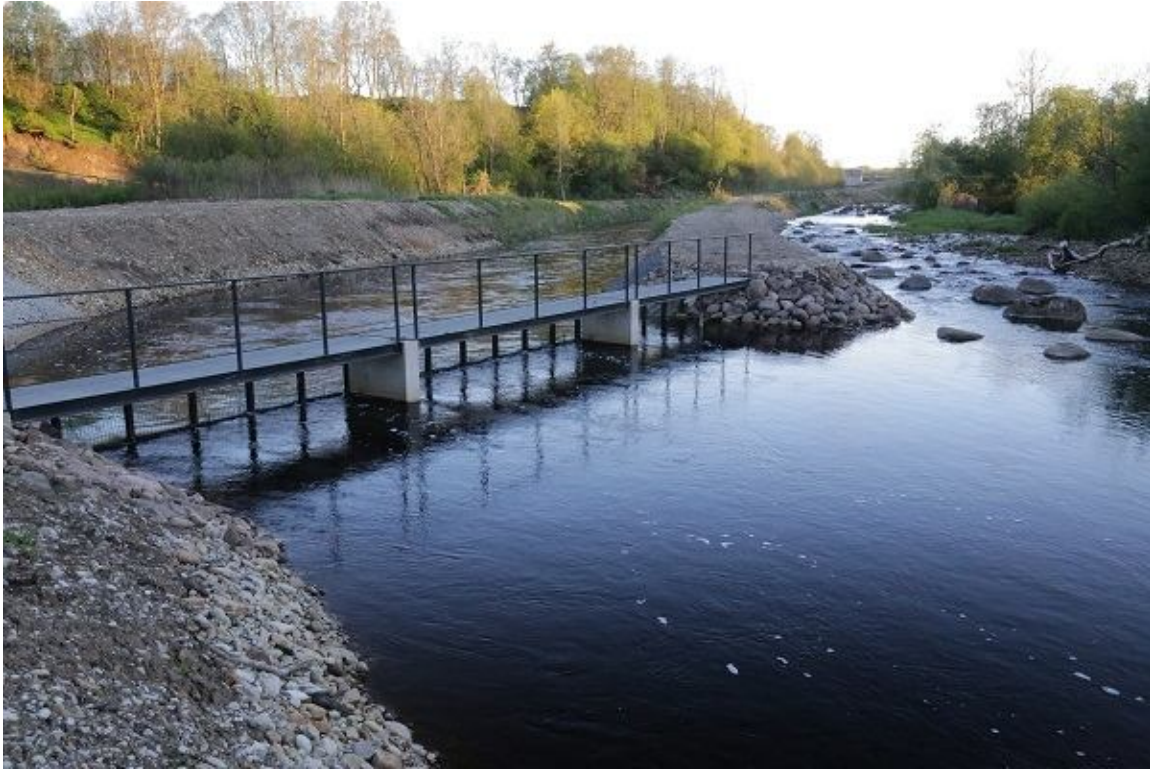
Foto 1.2.13.9. Sillaoru HEJ äravoolukanali suudmes on kalatõkke võre avadega 45 x 95 mm. Võre toimib suuremate tõusval rändel olevate lõhelaste puhul efektiivselt. Jõesilmu ja väiksemaid kalu see aga ei takista. Tõsi, jõesilmu rännet on üldise ükskõik millise võrega väga raske takistada (14.05.2015, R. Järvekülg).
