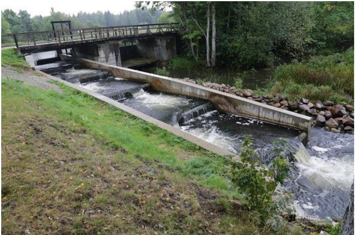
Foto 1.2.10.1. Joaveski kalapääs. 26.08.2015 oli kalapääsu vooluhulk ca 0,42 m 3 /s, veetasemete vahe basseinides oli 0,40...0,47 m (R. Järvekülg).
