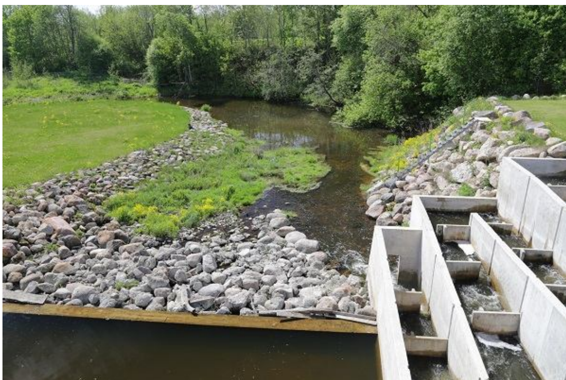
Foto 1.2.14.4. Sangaste paisu ja kalapääsu alune jõeosa 22.05.2015, ajal, mil võiks oodata kalade aktiivset rännet. HEJ põhjustab vee liigvähendamist. Jõesängis on vaid kalapääsu läbiv vesi ca 130 l/s, lisaks pressib 20...30 l/s läbi liigveelasu varjade vahelt. Rändel olevad kalad ei pruugi aru saada, miks nad peaksid veerohkel ajal minema edasi kuhugi, kus vett õieti polegi (R. Järvekülg).
