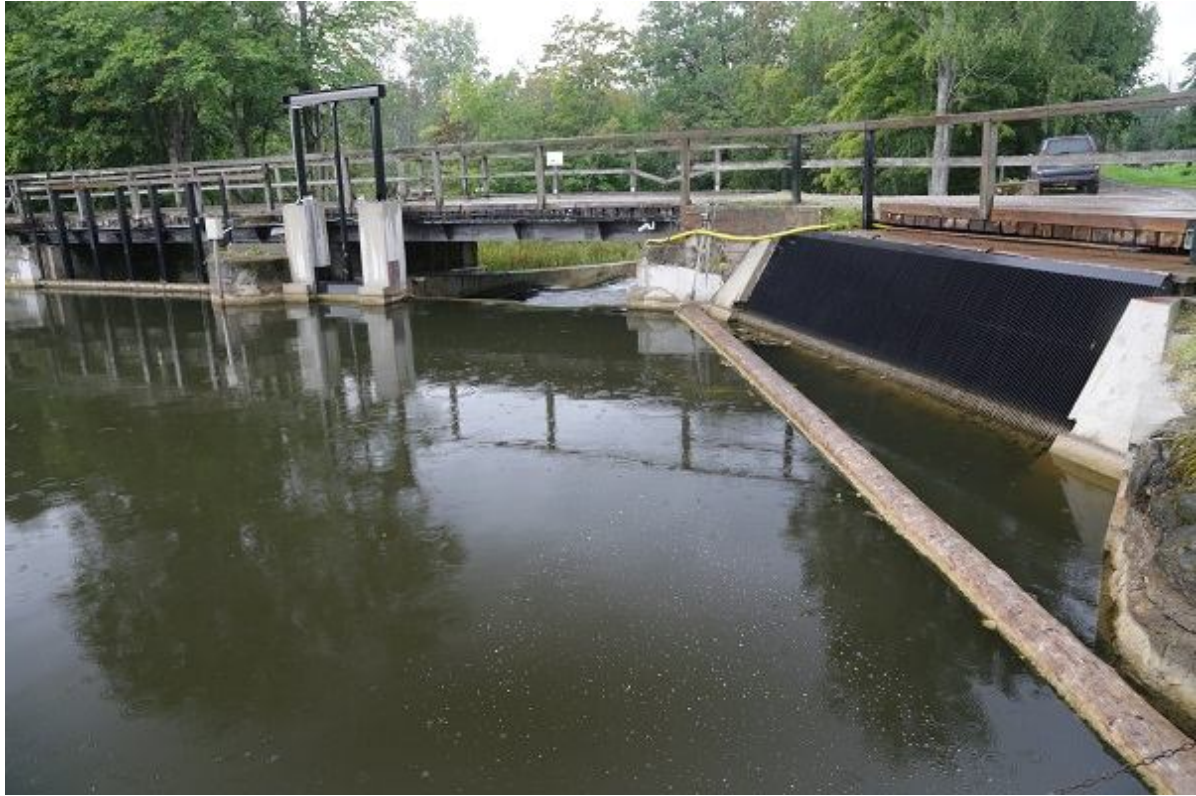
Foto 1.2.10.9. HEJ juurdevoolukanali sissevoolul on 4 mm lattraudadest võre, mis on kohati läbipaindunud. Avade vahed võrel 23...29, keskmiselt 25 mm. Võre juhib suuremad kalad hästi kalapääsu sissevoolu suunas, kuni 30 cm pikkused kalad võivad võrest läbi minna (26.08.2015, R. Järvekülg).
