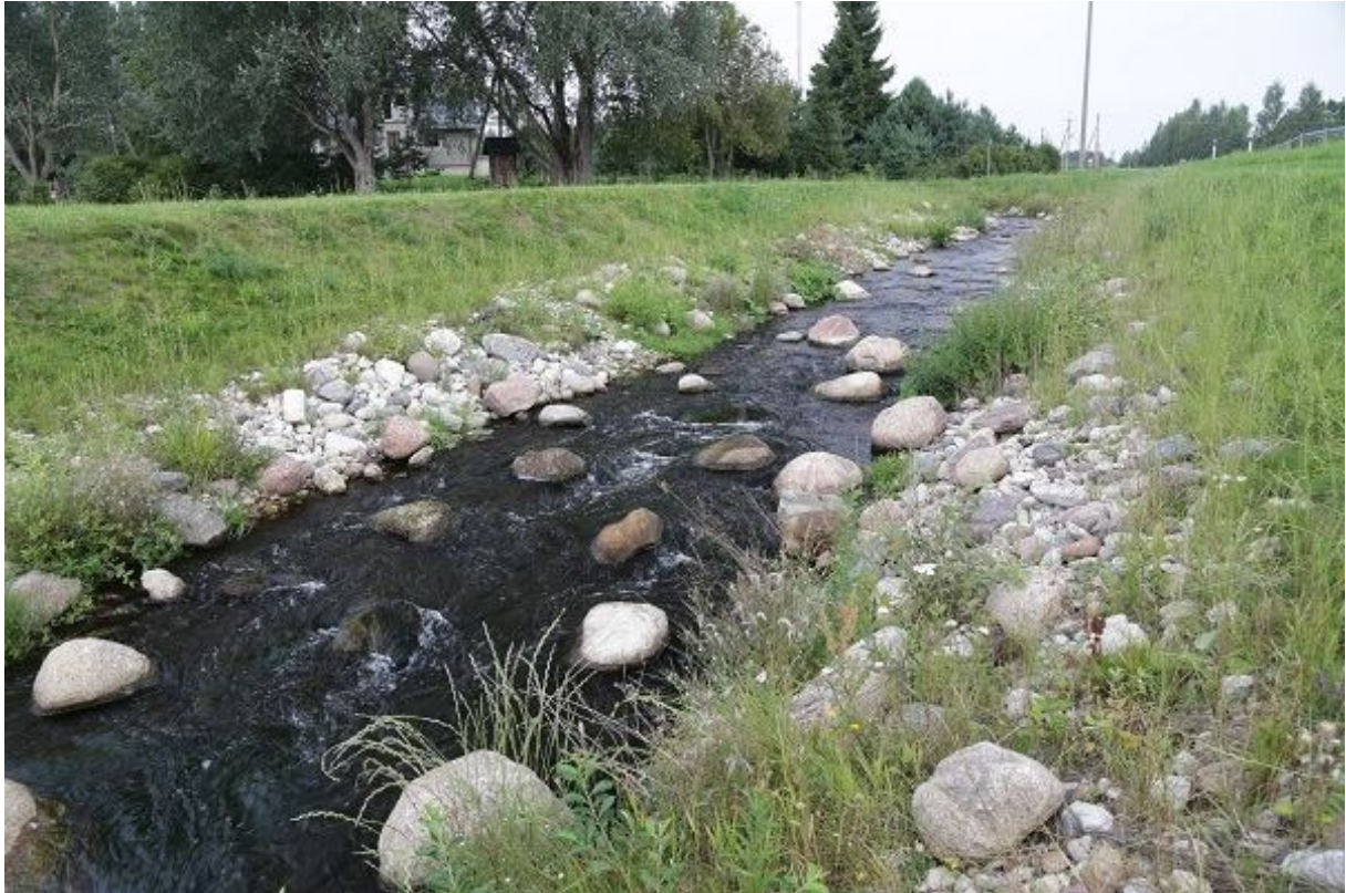
Foto 1.2.1.b.2. Veskijärve kalapääsu alaveepoolne osa (10.07.2014, R. Järvekülg).
