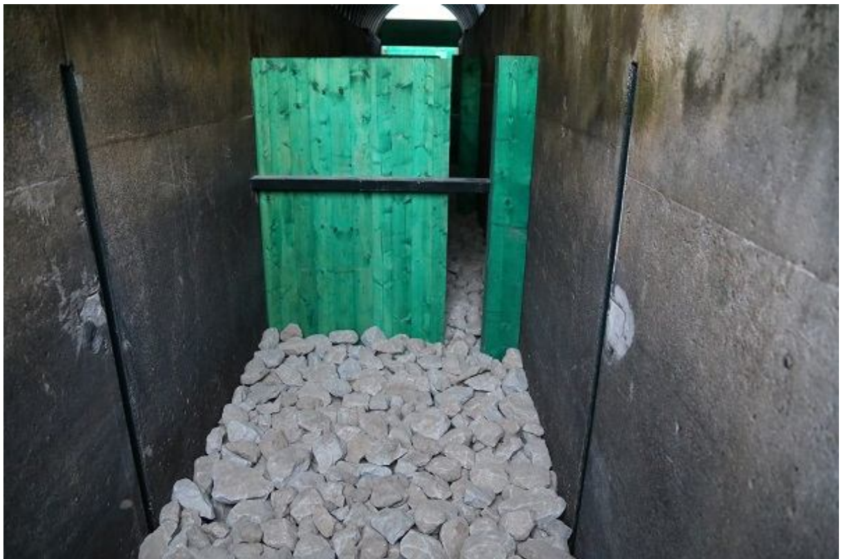
Foto 1.2.8.11. Pilupääs enne vee sisselaskmist. Vahetult enne kalapääsu valmimist lisati pilupääsu kambritesse veel üksikuid suuremaid kive (09.10.2013, R. Järvekülg).
