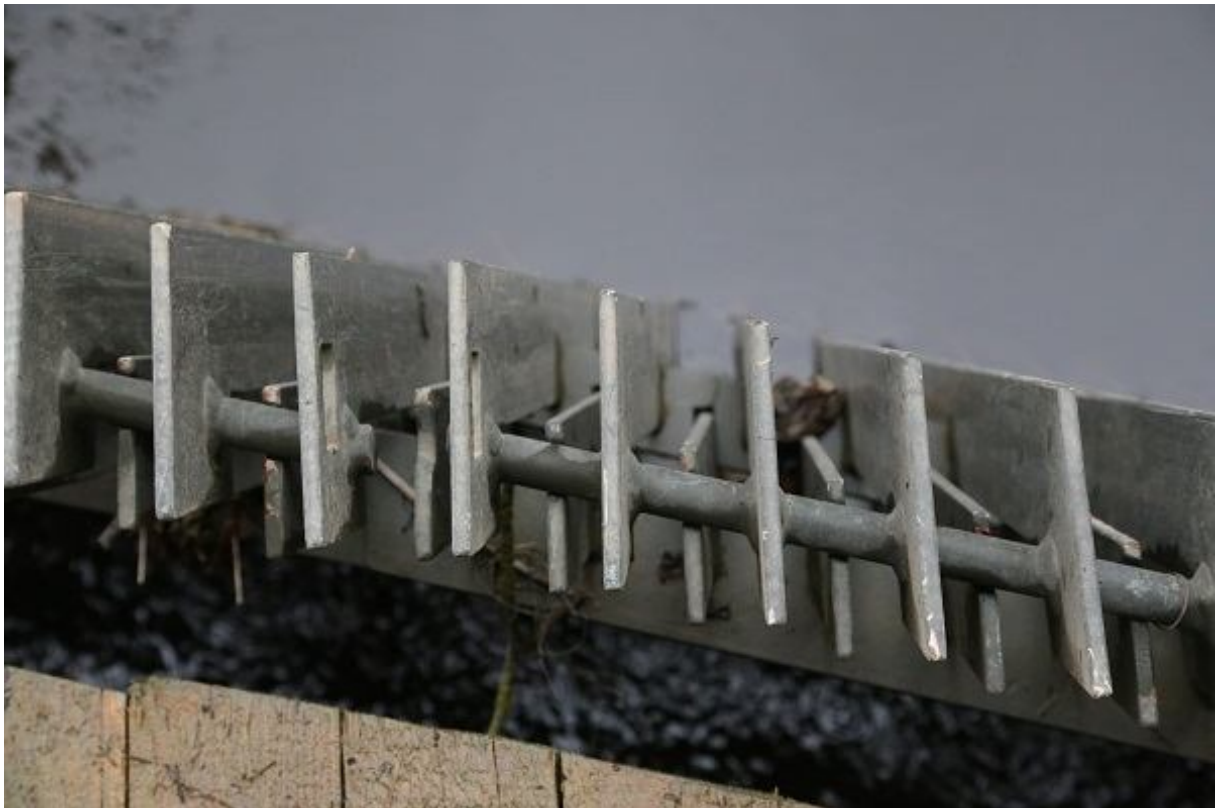
Foto 1.2.7.6. HEJ turbiinide sissevoolu ees olev võre on horisontaalsete avadega 26 mm. Võre konstruktsioon on jäik, vahed ühtlased (17.11.2015, R. Järvekülg).
