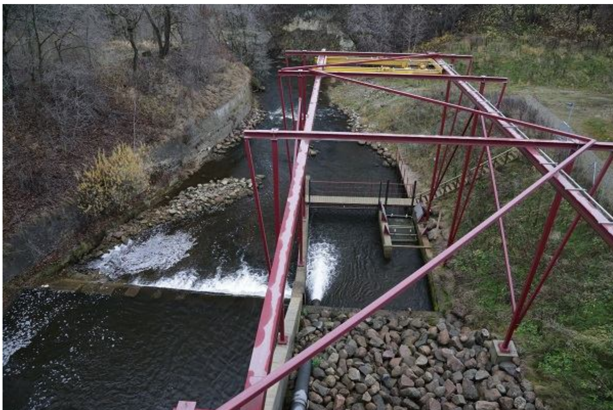
Foto 1.2.7.3. Kalalift konstruktsioonid ülal paisult vaadates. Lift on uputatud olekus (17.11.2015, R. Järvekülg).
