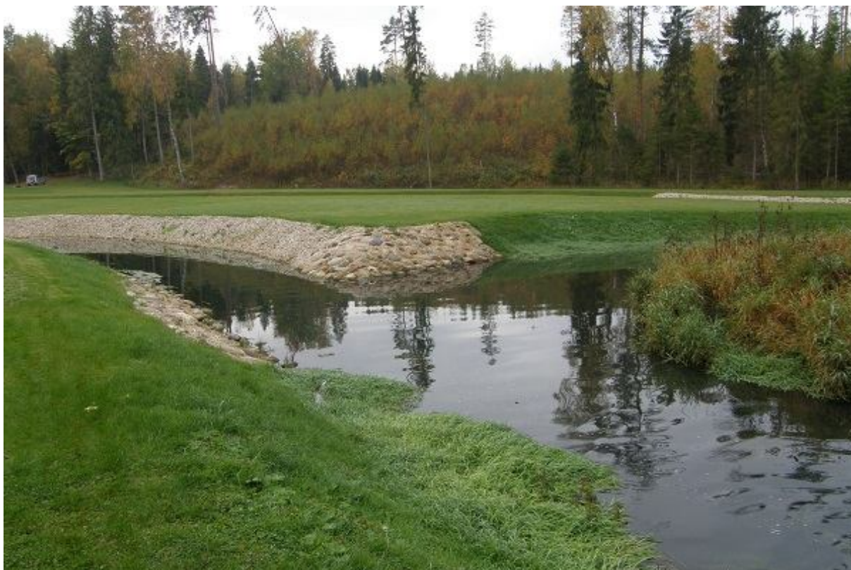
Foto 1.2.4.2. Tõusval rändel olevate kalade jaoks on ainus mõtlemise koht liigveelasu kanali (fotol vasakul) suubumiskoht jõkke. Kuna peajõesäng (fotol paremal) on enamiku ajast oluliselt veerikkam, siis valib enamik kalu eeldatavasti selle (05.10.2015, R. Pihu).
