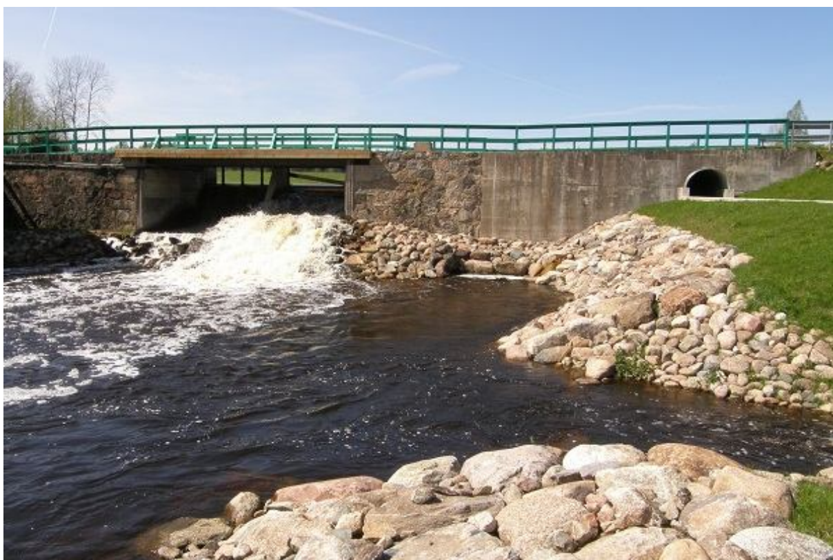
Foto 1.2.8.3. Koseveski paisu alune – paremale jääb kalapääsu väljavool, paremale üles ihtüodukti ava, keskel HEJ turbiini väljavoolu šaht, vasakul liigveelask. Suurveega on liigveelask kaladele laskumiseks ohutu ... (12.05.2015, R. Pihu).
