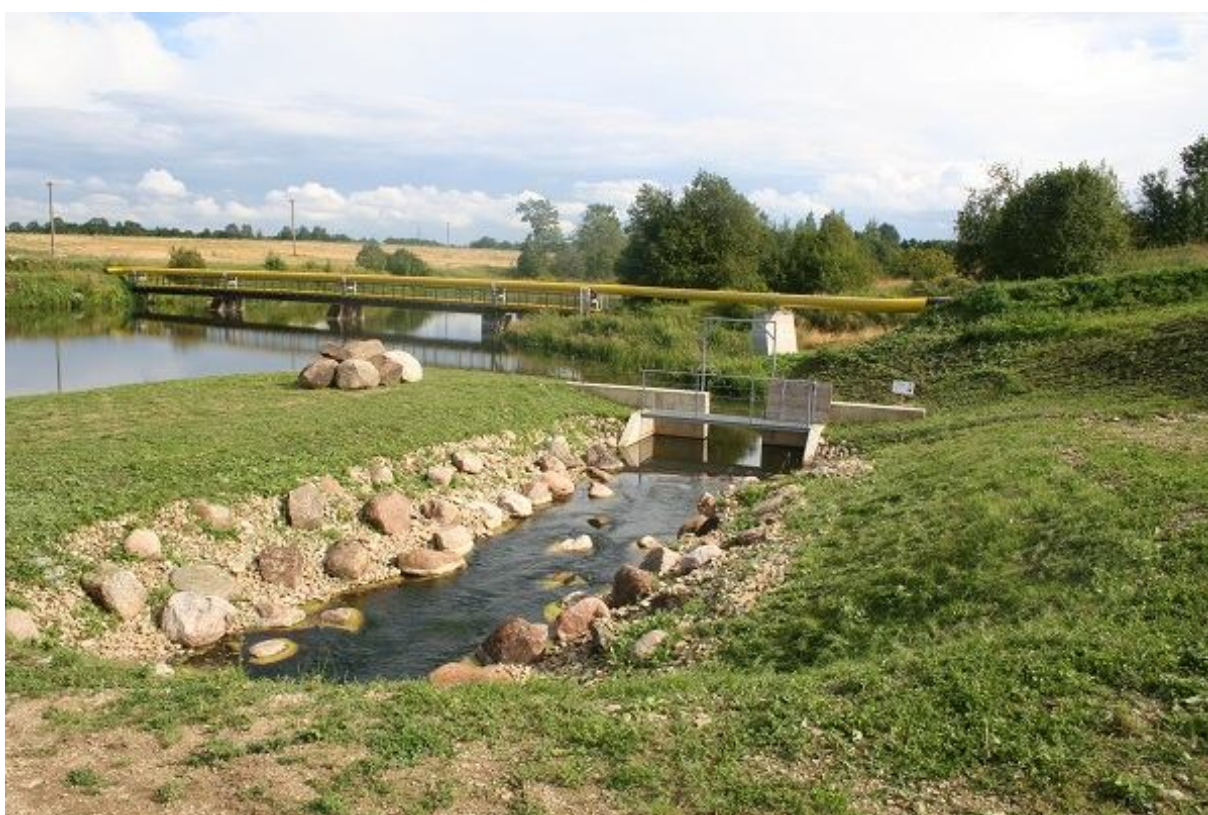
Foto 1.2.13.4. Sillaoru kalapääsu ülemine osa ihtüoduktist paisjärveni. Kalapääsu sissevoolul on betoonotsak, mida on vajadusel võimalik varjadega sulgeda või paigaldada sinna kalaloendur. Kollane toru jõe kohal on gaasitrass (29.07.2015, R. Järvekülg)
