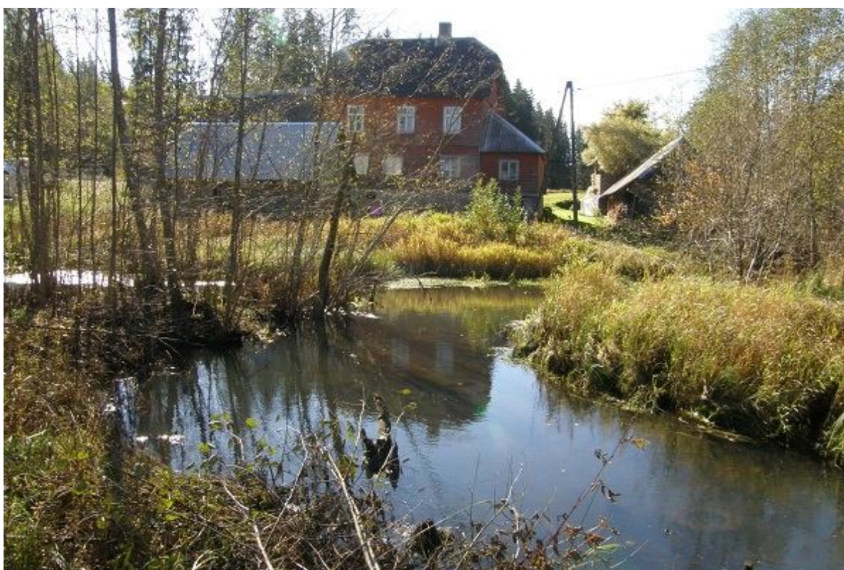
Foto 1.2.3.3. Probleemseks kohaks kalade tõusval rändel on koht, kus kalapääsu väljavooluharu ja liigveelasu alt tulev jõesäng kokku saavad. Fotol vasakul kalapääsu väljavoolu-haru, paremale käänab jõesäng. Kui jõesängi vooluhulk on oluliselt suurem kui kalapääsu vooluhulk, tõuseb enamik kalu jõeharu pidi liigveelasu alla (30.09.2015, R. Pihu).
