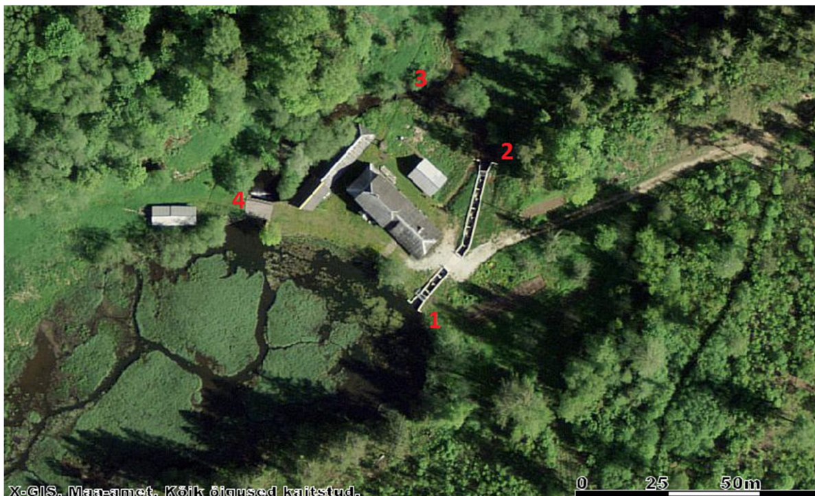
X-GIS. Maa-amet. Kõik õigused kaitstud. Joonis 1.2.3.3. Roti kalapääs on oma tüübilt kamberkalapääs. Kalapääsu sissevool asub paisjärve kirdenurgas. Paisjärv on setteid täis kandunud ning taimestikku ohtralt täiskasvanud. 1- kalapääsu sissevool, 2- kalapääsu väljavool, 3- kalapääsu väljavooluharu suubumiskoht jõkke, 4- liigveelask.
