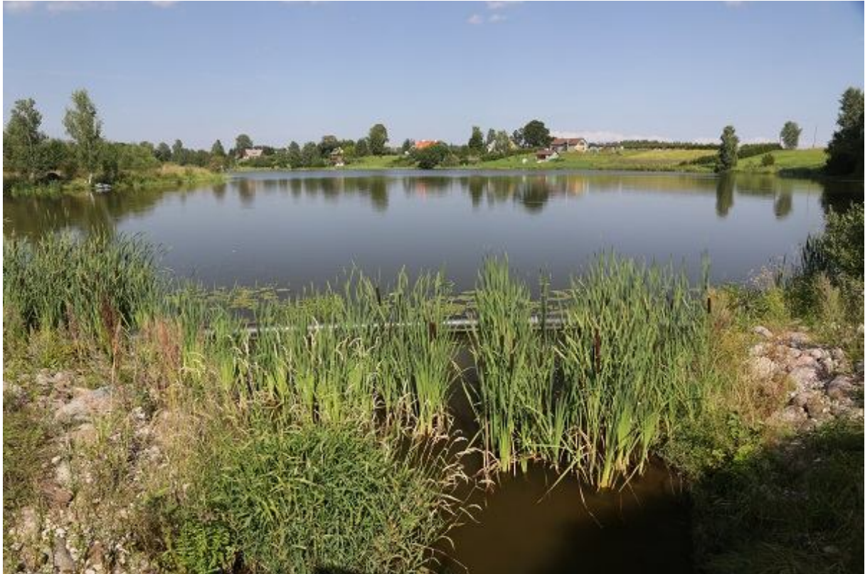
Foto 1.2.1.a.8. Leevi Külajärve kalapääsu sissevool asub regulaatorist veel ca 10 m ülesvoolu. Sissevooluavasse kogeneb setteid ja ava hakkab taimestikku täis kasvama. Tagaplaanil Külajärv (11.08.2015, R. Järvekülg).
