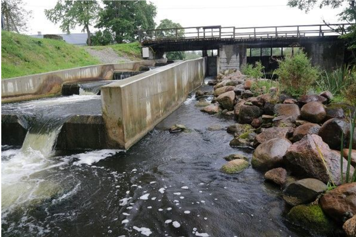
Foto 1.2.10.7. Kõige raskemini ületatav koht kalade jaoks on kalapääsu sisenemine. Veeaste alavee ja kalapääsu väljavoolu vahel oli vaatluspäeval 26.08.2015 0,62 m. Veerohkemal ajal veeaste väheneb. Kalapääsust paremal asub peibutusvoolu kanal, kuhu on võimalik täielikult avatud varjade korral juhtida vooluhulk kuni 5 m 3 /s (R. Järvekülg).
