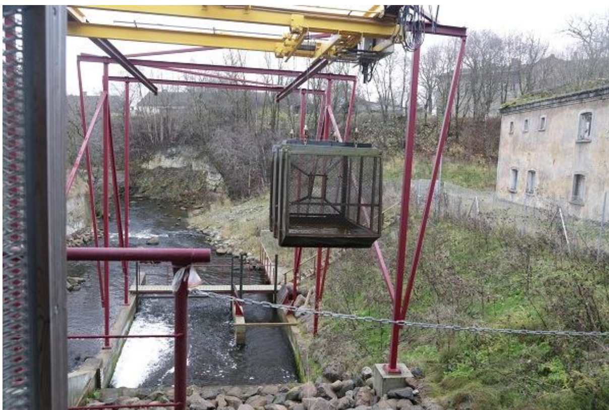
Foto 1.2.7.4. Kalalift tõuseb ülavee poole. Käimas on lifti töö testimine (17.11.2015, R. Järvekülg).
