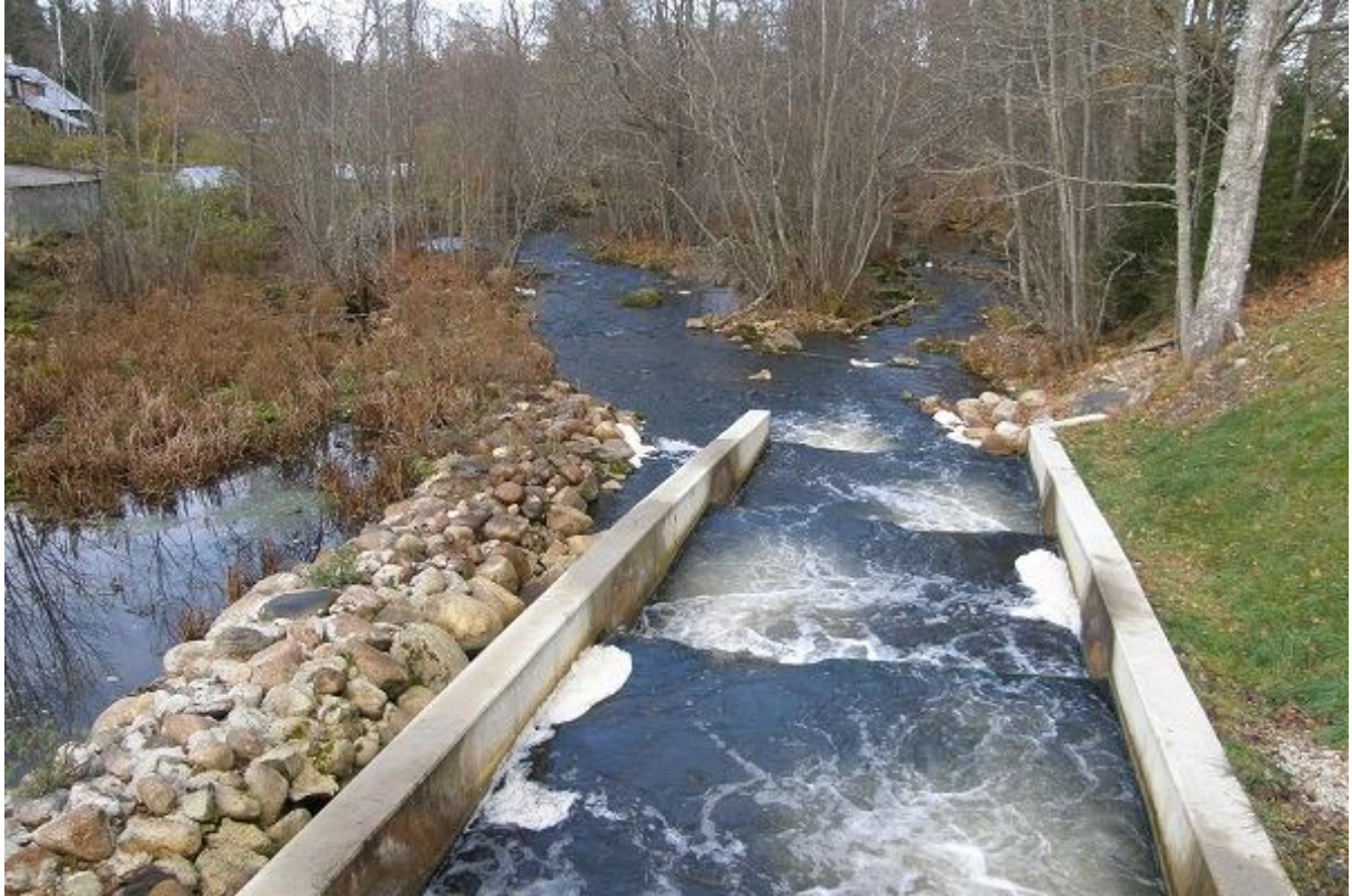
Foto 1.2.10.6. Joastiku läbinud kalad leiavad kalapääsu väljavoolu suhteliselt hõlpsasti, sest peavool paisu juures on koondatud kalapääsu väljavoolu piirkonda (30.10.2015, R. Pihu).
