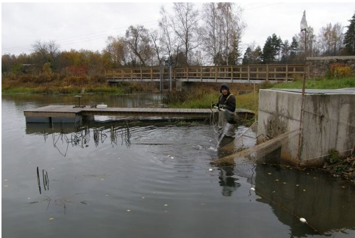
Foto 1.2.12.10. Seireperioodidel 22.04.-03.06. ja 25.09.-25.11.2015 oli kalapääsu sissevool suletud mõrraga, et registreerida kalapääsu läbinud kalad (27.10.2015, R. Pihu).
