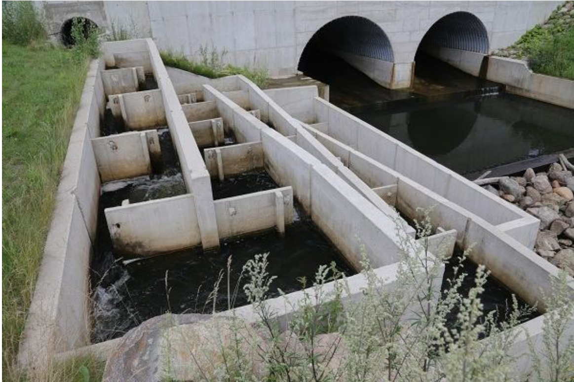
Foto 1.1.3. Kamberkalapääs Väikesel Emajõel Sangastes (23.07.2015, R. Järvekülg).
