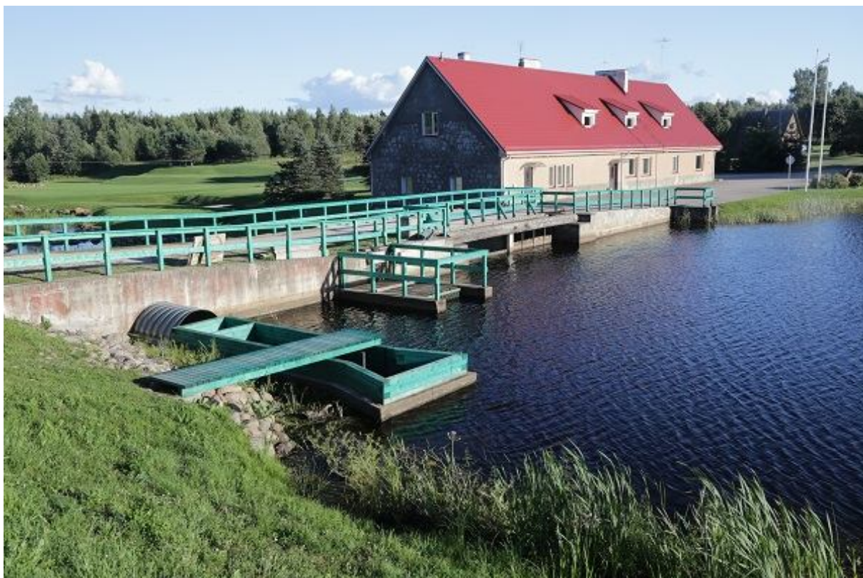
Foto 1.2.8.12. Koseveski pais ülavee poolt vaadates. Vasakul kalapääsu sissevooluotsak, keskel HEJ turbiinide sissevoolušaht, paremale silla alla jääb kaheosaline liigveelask (13.08.2015, R. Järvekülg).
