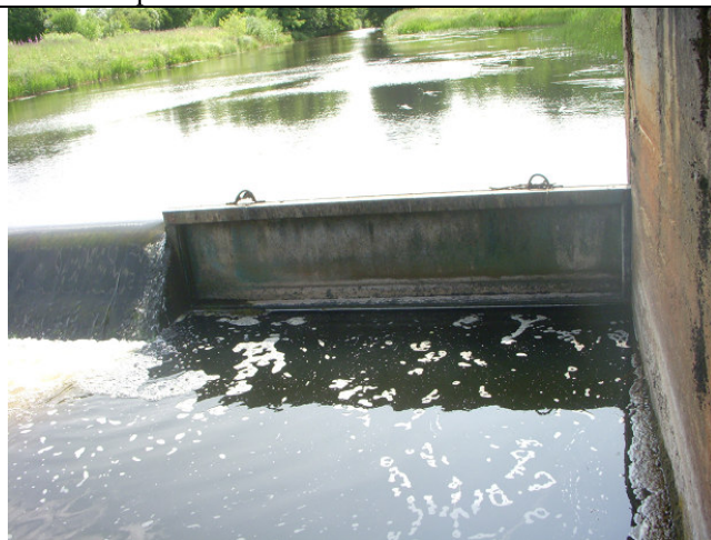
Pilt 6 Sae betoonpaisu põhjalasu ava terasest kilpväri
