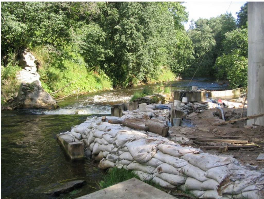
Foto 2. Estonian Cell AS veehaarde paisu ehitustööd on pooleli (11.08.2005).
