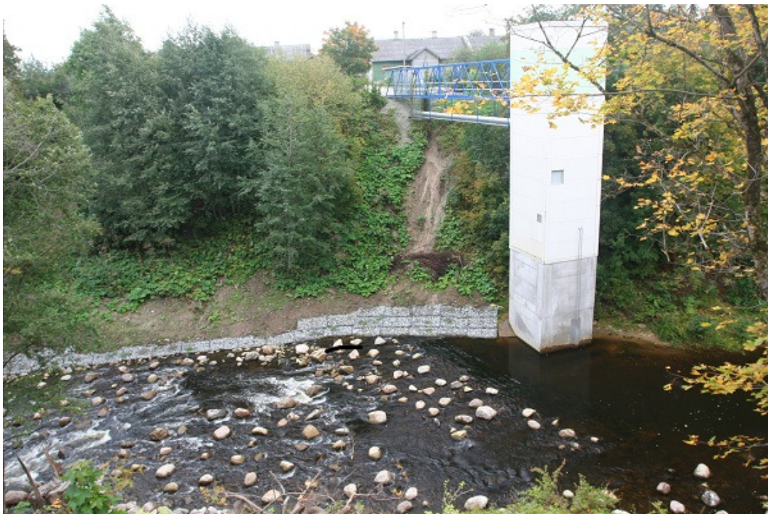
Foto 4. Vaade Estonian Cell AS veehaardele ülalt kanjoni vasakult servalt. Pais on asendatud tehiskärestikuga (22.09.2011).
