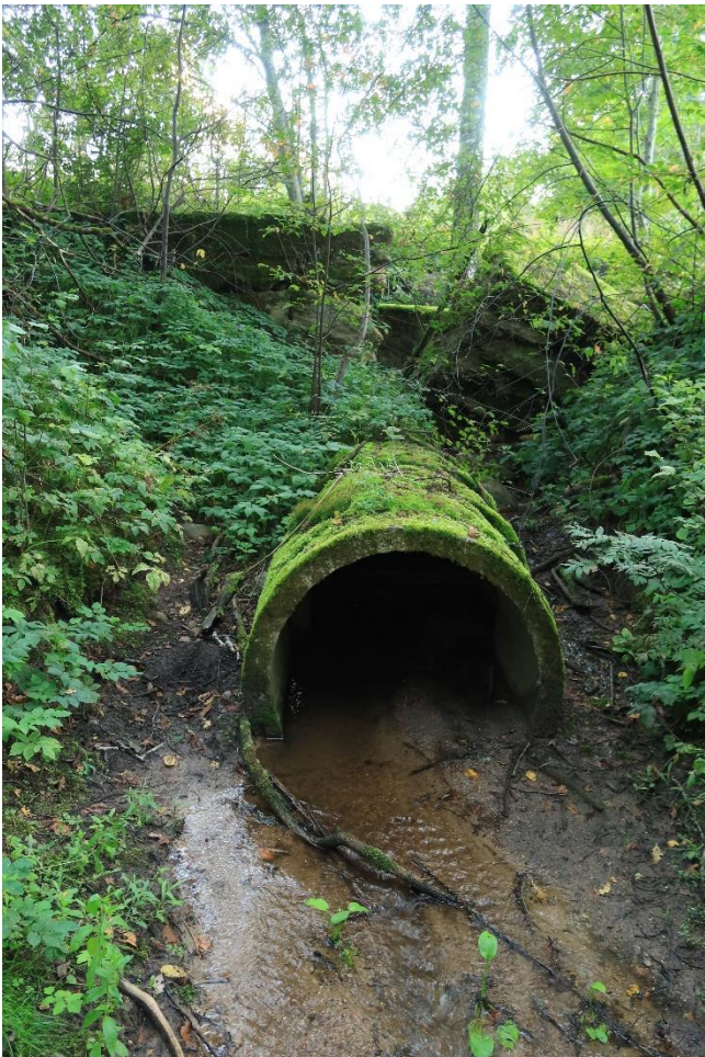
2. Truubist ida pool on massiivne betoonkonstruktsiooni vare. Selles on puitvarjade paigutamise kohad ja pikk meetrise läbimõõduga betoonrõngastest toru. Vesi voolas välja nii torust kui ka konstruktsiooni vahelt:
