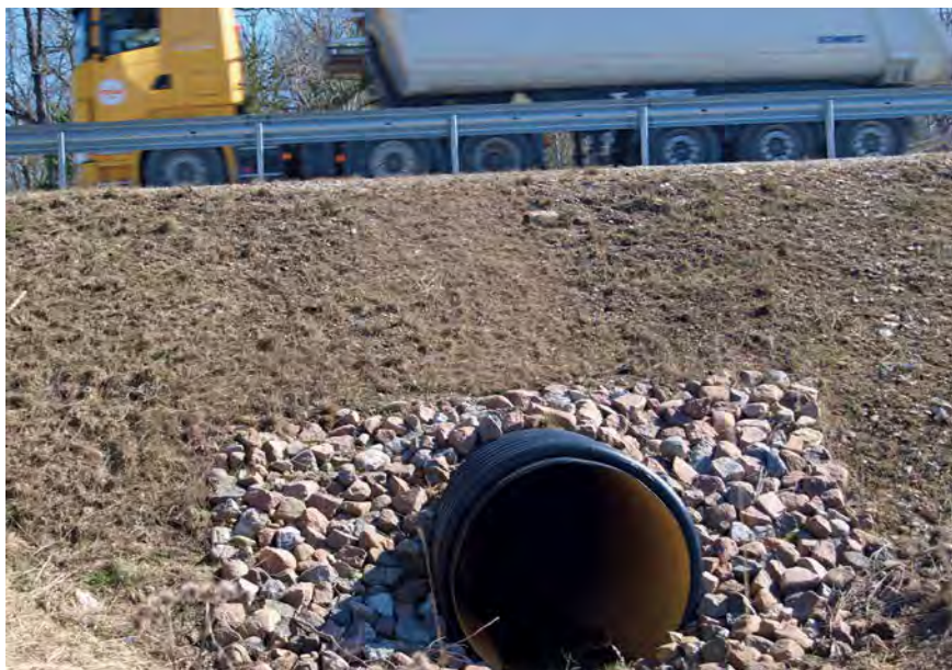
♦ 6. Paar aastat tagasi renoveeritud Kohtla-Järve – Mäetaguse tee alla on pandud suur truubitoru. Vett ei ole siin voolanud juba paarkümmend aastat
