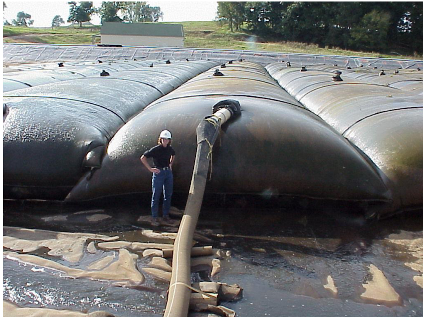
Foto 1 Geotubide täitmine ladestusplatsil
