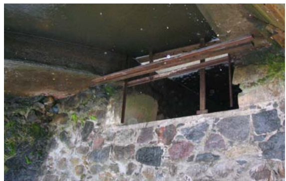
Joonis 3. Rekonstrueeritud paisu kaldasammas ja pealevoolukanal ( vasakul ) ning äravoolukanali algus ( paremal ).
