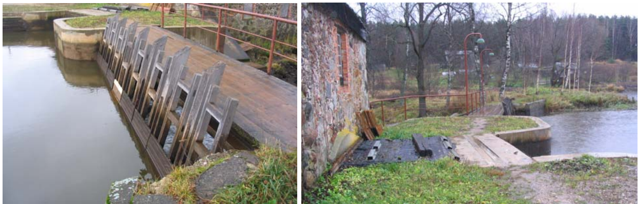
Joonis 6. Regulaator on varustatud uute varjadega ( vasakul ) ning vasakkalda pais-regulaator on tervikuna rekonstrueeritud ( paremal ).
