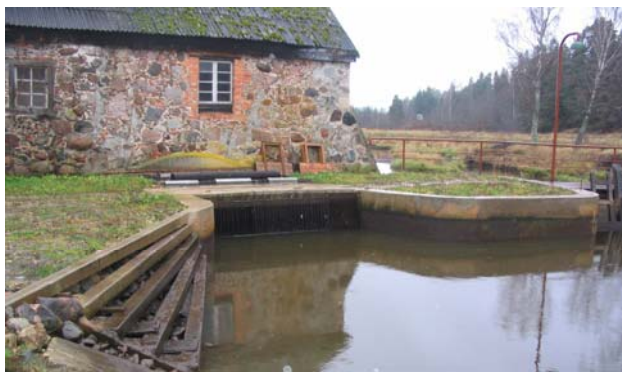
Joonis 3. Rekonstrueeritud paisu kaldasammas ja pealevoolukanal ( vasakul ) ning äravoolukanali algus ( paremal ).
