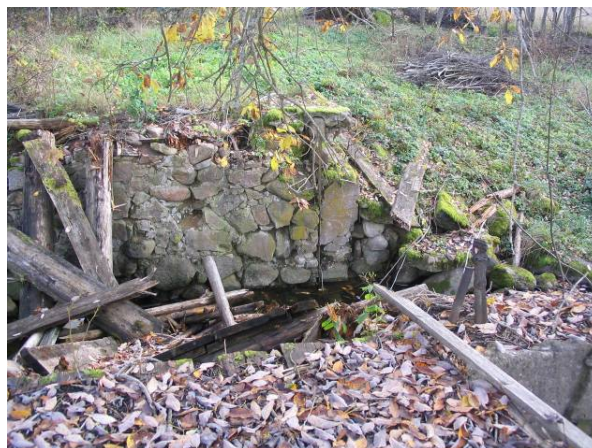
Joonis 6. Vaade Paju veski põhjaküljele ( vasakul ) ning lagunevale paisusambale, mis on ühtlasi sillasambaks ( paremal ).
