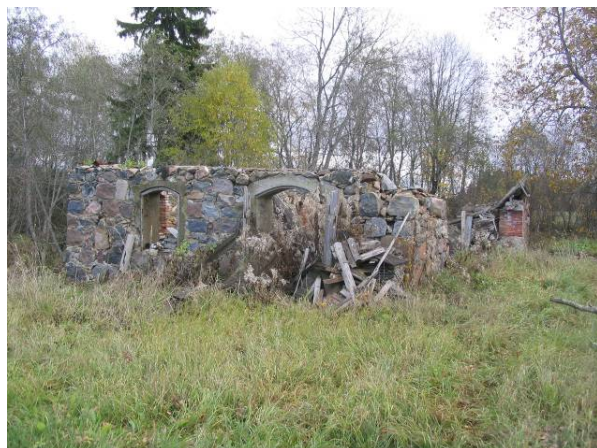
Joonis 6. Vaade Paju veski põhjaküljele ( vasakul ) ning lagunevale paisusambale, mis on ühtlasi sillasambaks ( paremal ).
