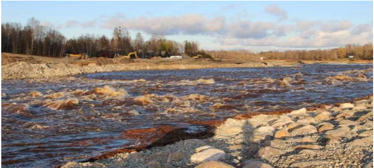
Foto 5. Jõgi on juhitud valminud kärestikule vasaku kalda pool oktoobris 2019 (kogu jõe vooluhulk)
