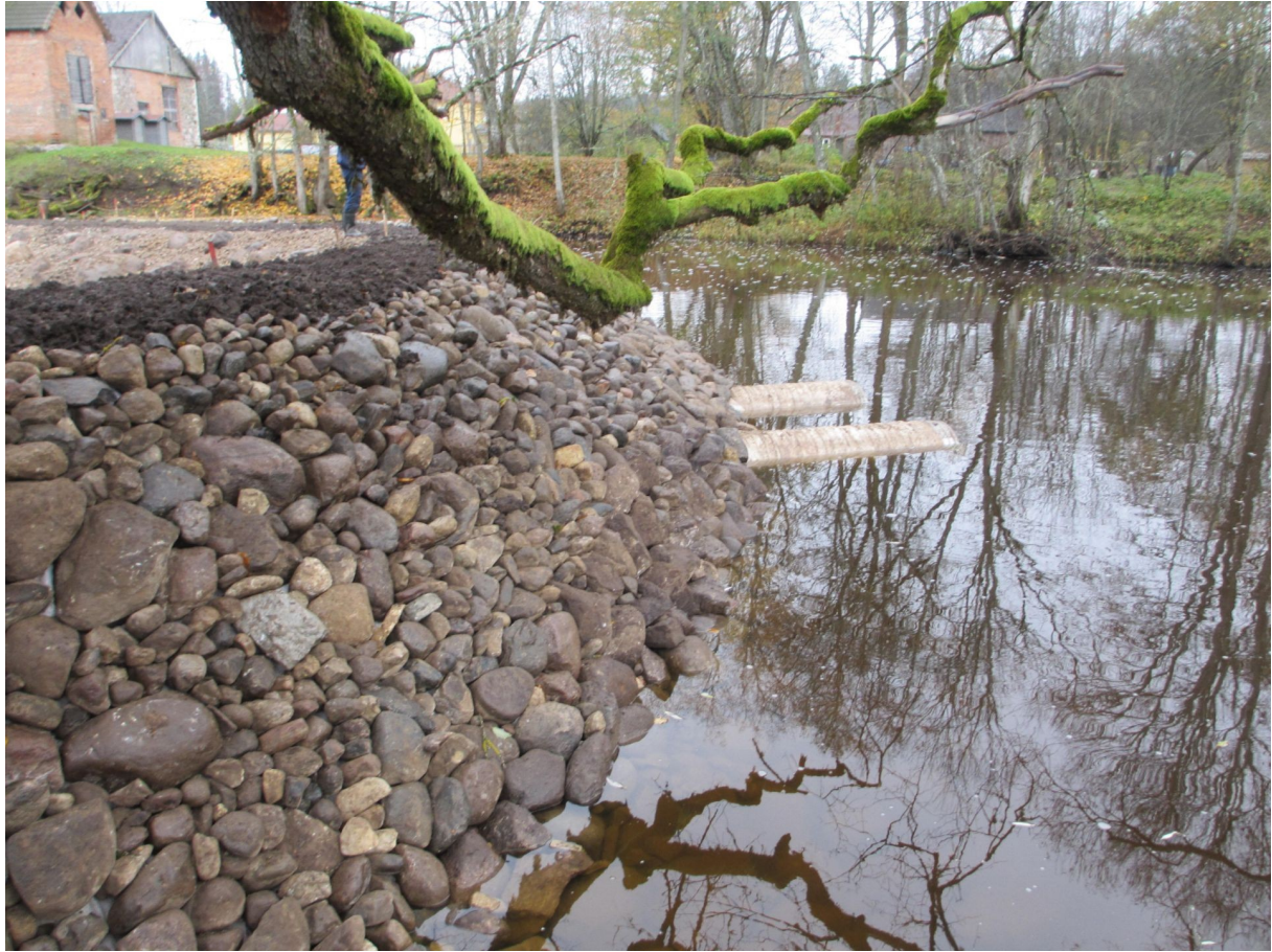
Kalapääsu alumine osa (äravoolutorud).
