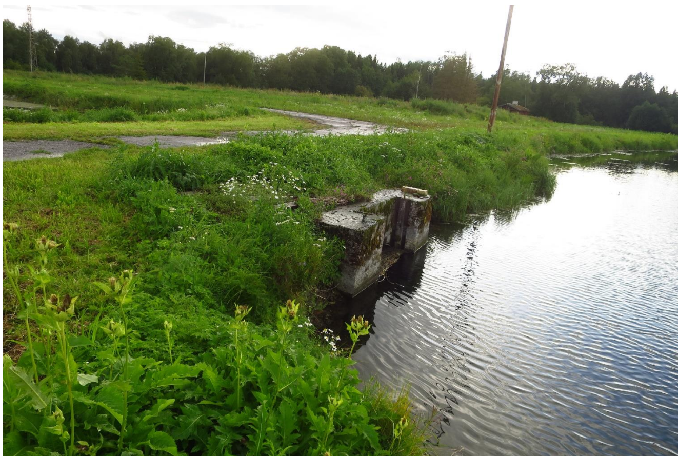
2. Nelinurkne betoonpais, millel polnud vaatluse ajal varjasid ees ning veetase oli sama, nagu lõuna pool oleval kalatiigil. Seega reguleeris Vanaveski järve veetaset vaatluse ajal Kalatiiki üleval hoidev pais (nr. 5).
