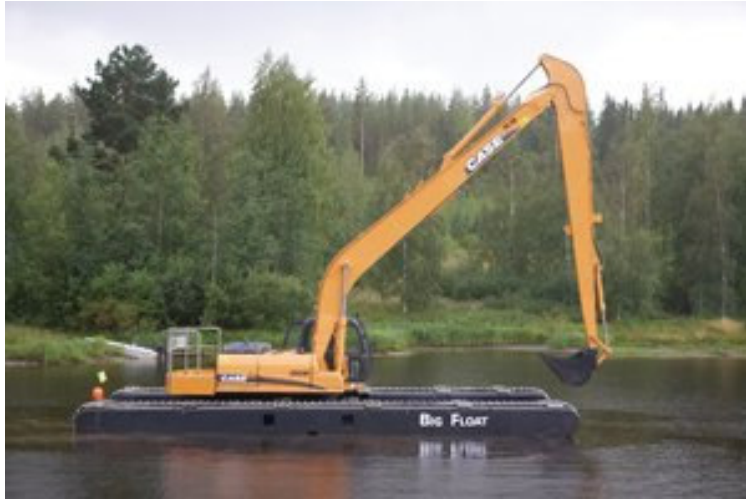
Joonis 5.6. Big float ujuvekskavaator (allikas: www.forconstructionpros.com , 2009)
