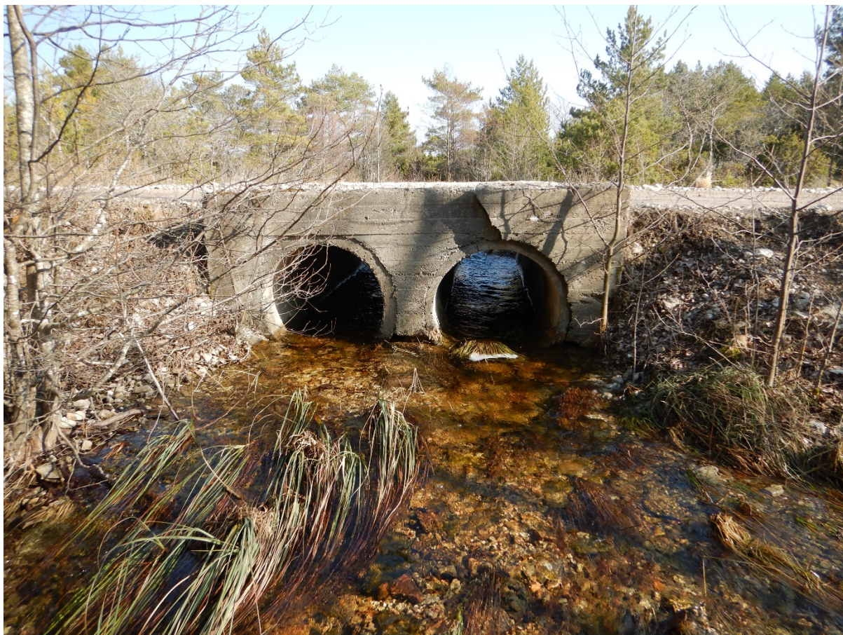
Foto 3. Kalmu-Kuralase-Neeme tee truup Tüüdu jõel (22.03.2022) on hakanud lagunema. Uue truubi paigaldamisel peaks veenduma, et see oleks kindlasti kogu vee elustikule nii üles kui ka allavoolu liikumisel ületatav. Siinkohal on hoiatavaks näiteks Oju jõel (4.3.2.1) Virita külas paiknev teetruup (Imre Taal).
