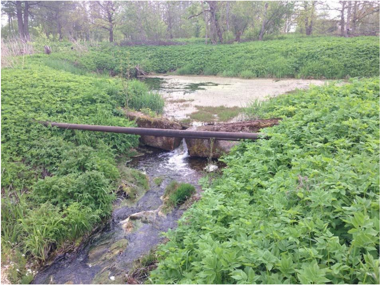
Foto 6.2. Vohnja pais kõrvalharul. Paisjärv asub pinnasvalli taga. Läbi valli on juhitud toru, mis suubub pildil oleva tiigi keskele, millest omakorda saab alguse kõrvalharu. Ilmselt on tegemist mingit tüüpi põhjaveelasu äravoolu süsteemiga (M. Kesler, pildistatud 22.05.15).
