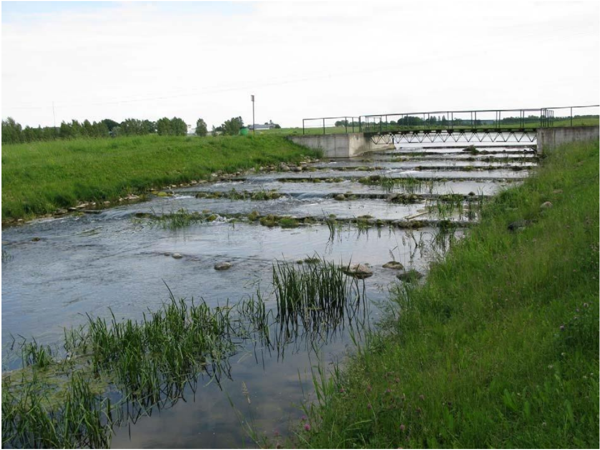
Foto 1.14. Kadrina paisjärve väljavool on kalapääsuks kujundatud, mistõttu kalade liikumine siin takistatud pole (M. Kesler).
