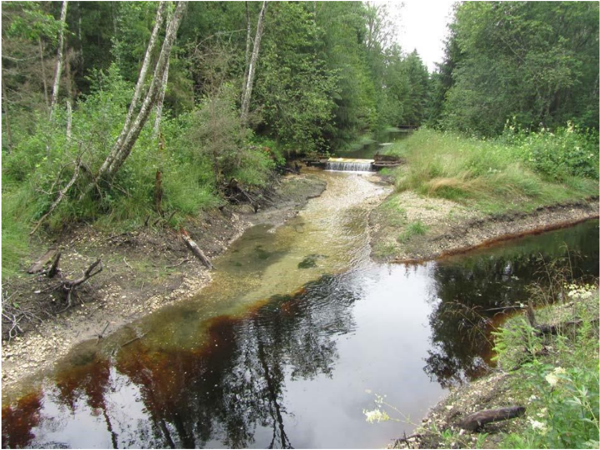
Foto 9.5. Allikalise kraavi suubumine Pakitu peakraavi. Suubumise kohast ülesvoolu on peakraav tumedaveeline ning arvatavasti jääb põuastel perioodidel väga veevaeseks. Allikalisel kraavil on 30 m kaugusel suudmest 0,4 m kõrgune pais. Paisu ees leidub forellile ja silmule sobilikku koelmuala (R. Svirgsden).
