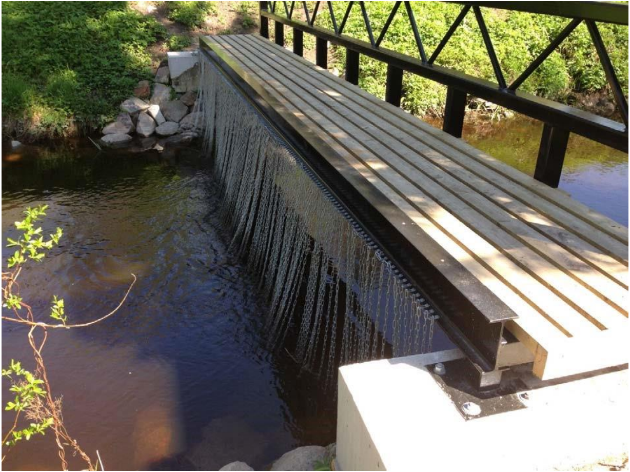
Foto 1.6. Joaveski HEJ väljavoolu lõppu on kalade tõkestamiseks paigaldatud rippuvate kettide rivi. Kalu selline lahendus kindlasti ei takista (M. Kesler).
