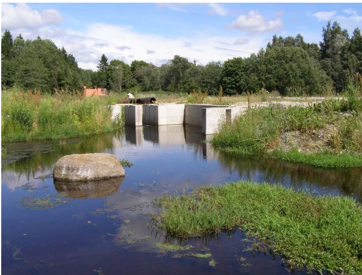
Foto 6.12. Rajatava kalakasvatuse kõrvale on oja ehitatud regulaatori betoonkehand. Siia on tekitatud paisutamise võimalus, mida koelmuualade inventeerimise hetkel ei kasutatud. Regulaatorist paremale jääb kalakasvatuse veevõtu suue (I. Taal).
