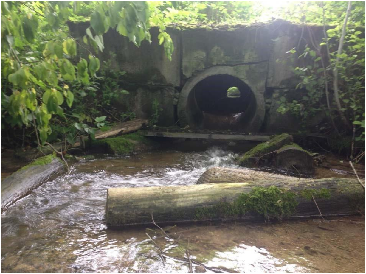
Fotod 5.4. Astmega Tipu suurkivi tee truup on lagunened ja takistab kuival perioodil kalade liikumist (M.Kesler).
