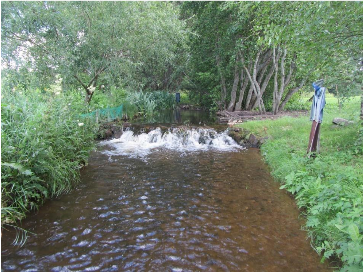
Foto 8.5. Jõekääru talu juures paiknev kivilaotis on kaladele rändetakistuseks ning seda eriti veevaesel perioodil (R. Svirgsden).
