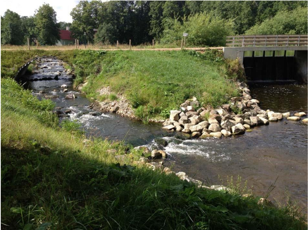
Foto 1.8. Esiplaanil on Loobu paisu kõrvale rajatud kalapääsu suubumine Loobu jõkke. Looduslähedane kalapääs meenutab looduslikku kärestikulist jõge ning sellised kalapääsud toimivad kõige paremini (M. Kesler).
