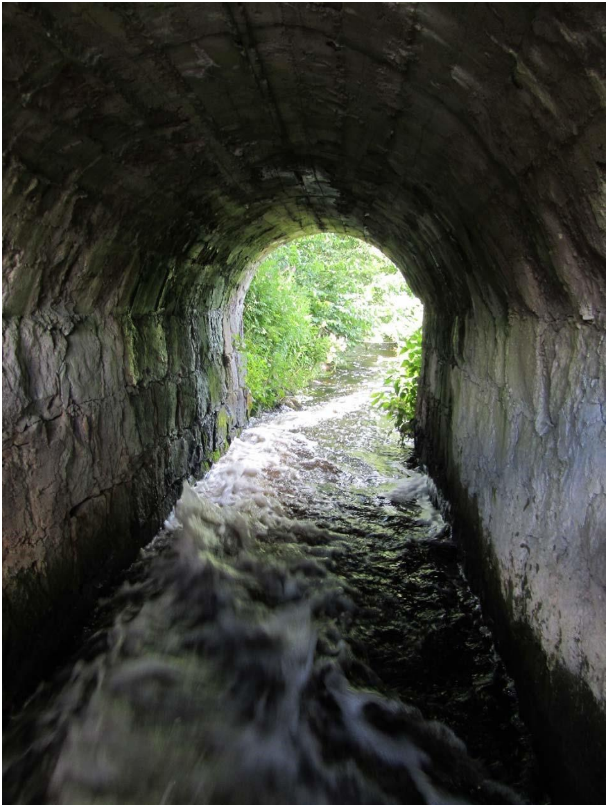
Foto 6.6. Peaharu paisust allavoolu voolab oja kümnekond meetrit tunnelis, kus väga kiire veevoolu tõttu kalad püsivalt elada ei saa (R. Svirgsden).
