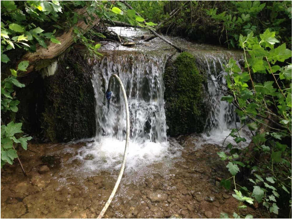
Foto 5.5. Tipu suurkivist ülesvoolu on ojale rajatud 0,8 m kõrgune kaladele ületamatu pais. Paisu lammutamisega suureneks Niilise oja forelli taastootmispotentsiaal (M. Kesler).
