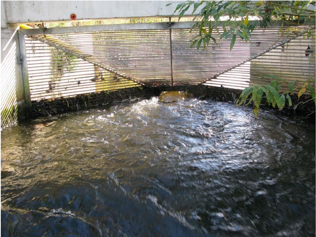
Foto 1.10. Esiplaanil on ummistunud kalaloenduri võre (ilma kalaloendurita), mis takistab vee voolamist kalapääsu (võre paisutab vett ca. 10 cm). (M. Kesler).
