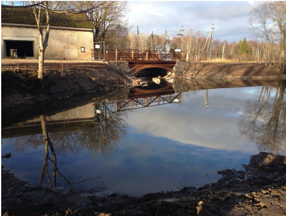
Foto 6. Hulja - Neeruti tee sillast ülesvoolu süvendati jõge ning eemaldati jõkke langenud puid. Negatiivsete mõjude vähendamiseks oleks seda tööd pidanud suvel tegema (15.11.2015).
