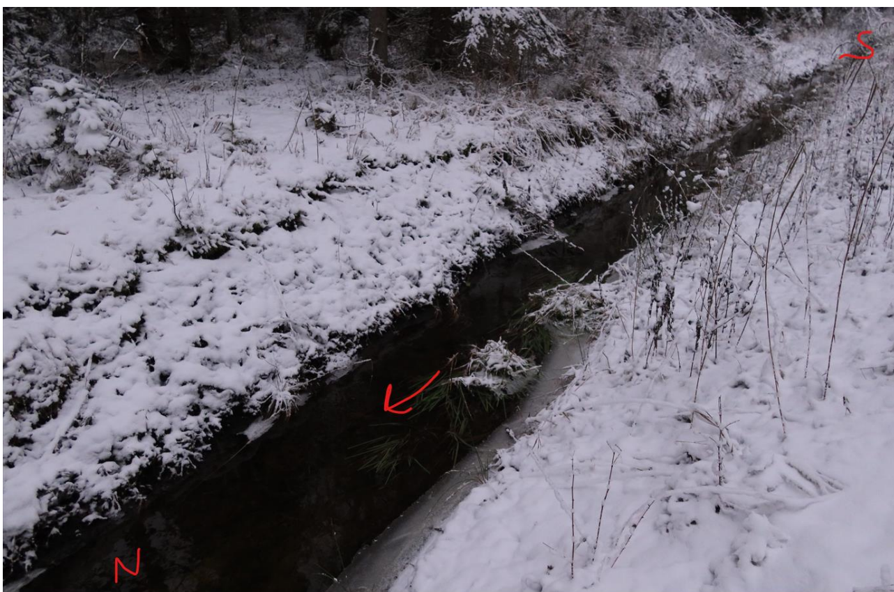
9. Läänest tulevas kraavis nirises vesi läbi truubi ( ETAKis puudu ) lõuna-põhjasuunalisse kraavi. Idast tuli kõige rohkem vett. Seal oli kraavis liiv põhjas. Lõuna pool oli veel kohati jääkirme peal:
