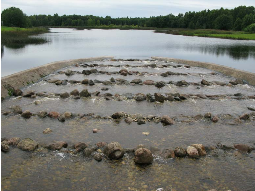
Foto 2. Vaade Vaskjala kalapääsu ülemisele osale, kivivallide juures on saavutatud ühtlane veetasemete langemine (M. Kesler 02.09.2015).
