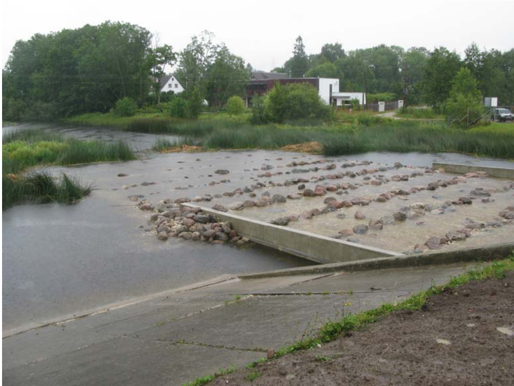
Foto 4. Vaade Vaskjala kalapääsu alumisele osale. Tavapärasest kõrgema veetaseme tõttu on alumised ajutiselt astangud vee all (M. Kesler 28.08.2015).
