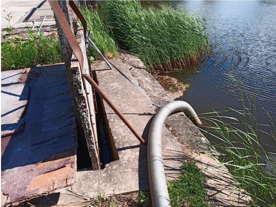
Foto Pikru 4. Pikru hej sissevoolukanal on pealt kaetud (13.06.2022).
