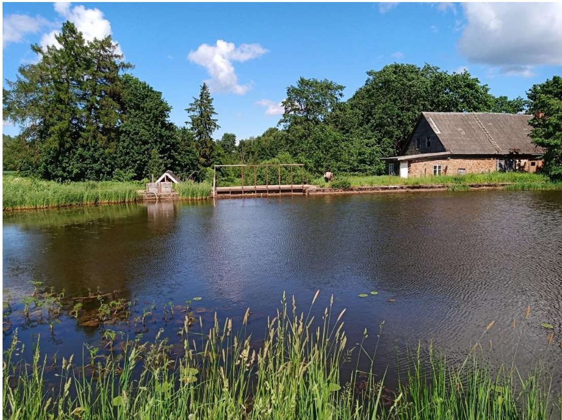
Foto Pikru 1. Vaade Pikru paisule, veskihoonele (suur paremal) ja hüdroelektrijaamale (väike vasakul) paisjärve poolt (13.06.2022).
