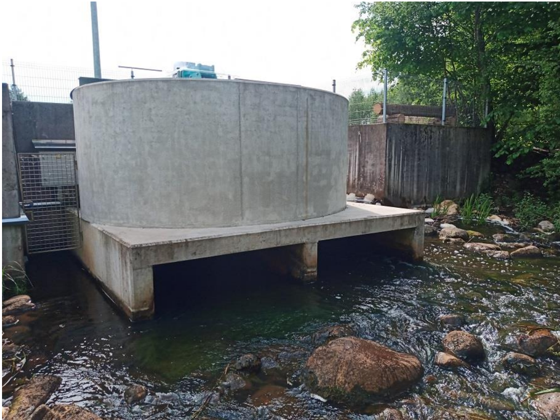
Foto Elva (Räbi) 4. Elva (Räbi) paisu turbiini väljavoolukanalid (10.06.2022).
