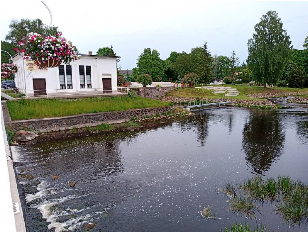
Foto Põltsamaa 4. Hej äravoolukanali ja kalapääsu suudmed paiknevad lähestikku. See teeb kalapääsu väljavoolu kaladele lihtsalt leitavaks 14.06.2022).
