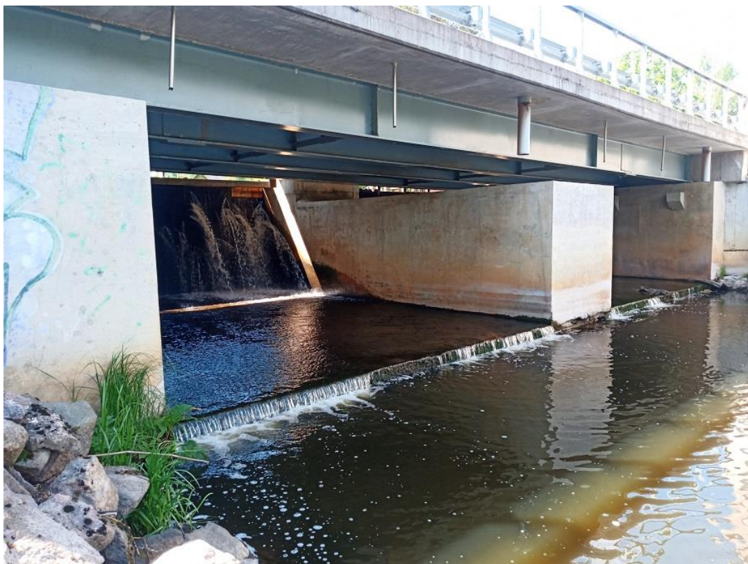
Foto Leevaku-3. Leevaku paisu liigveelask on kaheosaline. Kalade laskuv ränne üle liigveelasu on ohtlik, kuna liigvaalasu alusel betoonplaadil puudub väljaspool suurvee aega piisav veetäide (09.06.2022).
