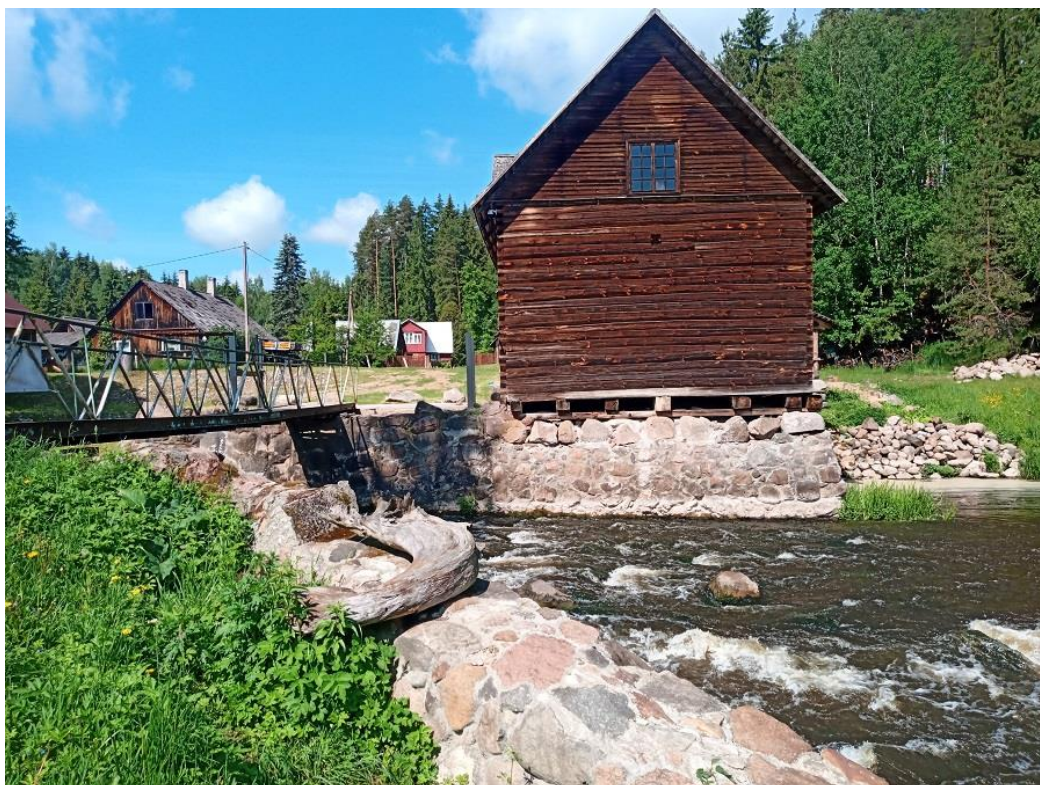
Foto Viira-1. Viira hej kruviturbiin on paigutatud vanasse veskihoonesse. Jõesäng on kujundatud kärestikuliseks kalapääsuks (09.06.2022).
