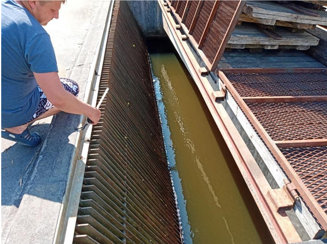
Foto Rápina 2. Paberivabriku hej turbiini sissevoolul olev võre. Selle konstruktsioon on ebasobiv, seetõttu on suhteliselt uus võre juba deformeerinud. Avad 20...35 mm (09.06.2022).
