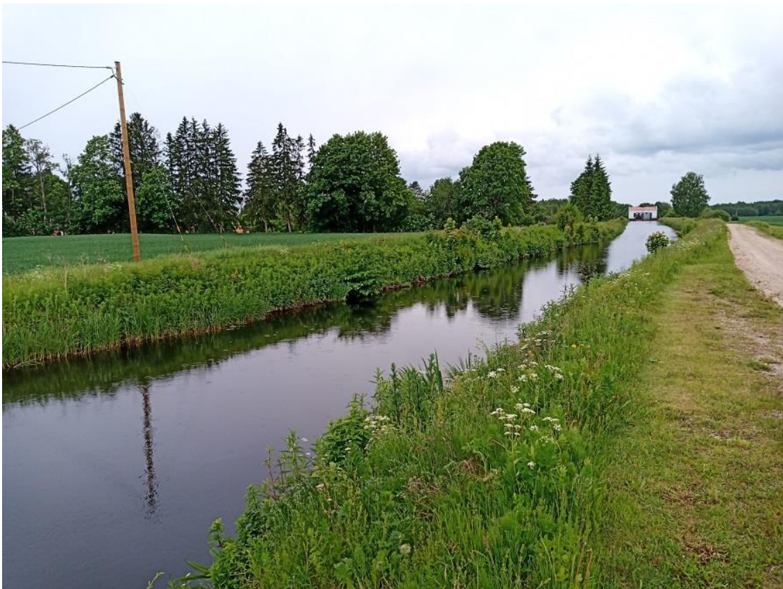
Foto Kamari 2. Kamari hej juurdevoolukanal, tagaplaanil hej hoone (14.06.2022).
