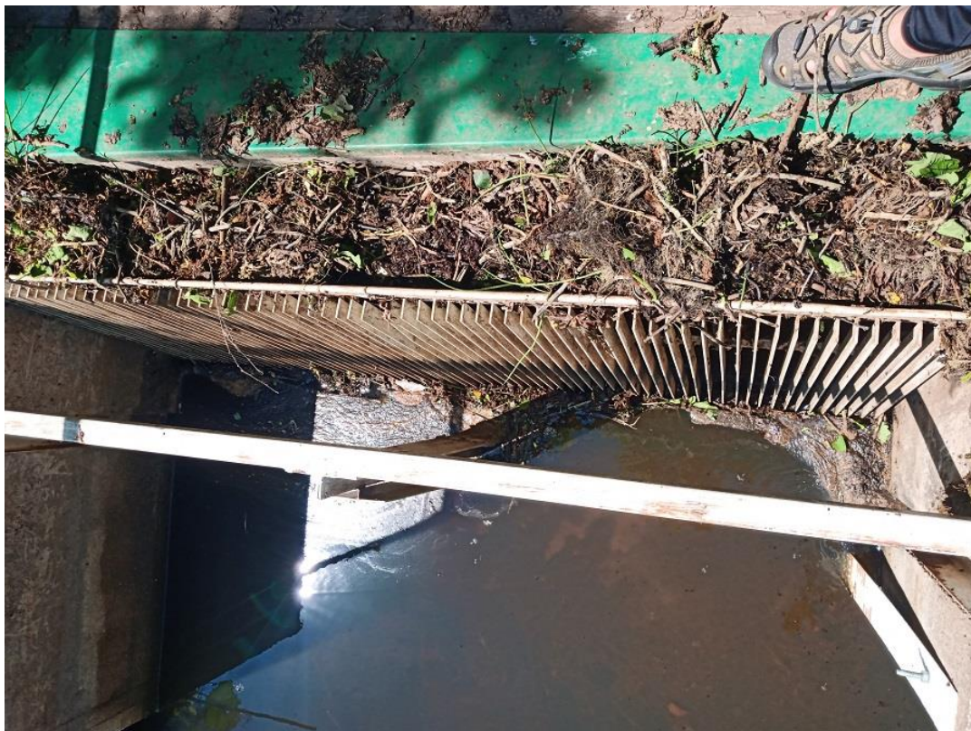
Foto Peri 4. Hej sissevoolukanali ees olev võre on avadega 22...26 mm. Hädaga käib kah. (09.06.2022).
