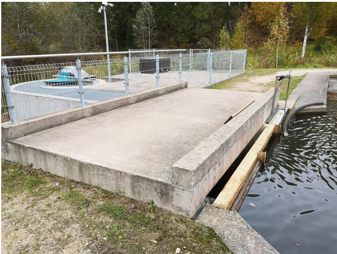
Foto Elva (Räbi) 2. Elva (Räbi) paisu vasak liigveelask (esiplaanil) koos turbiinikanaliga (tagaplaanil)(05.10.2021).
