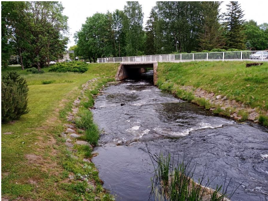
Foto Põltsamaa 5. Kalapääs on kaladele hästi läbitav. Fotel kalapääsu ülemine tiikide kaskaadi osa 14.06.2022).
