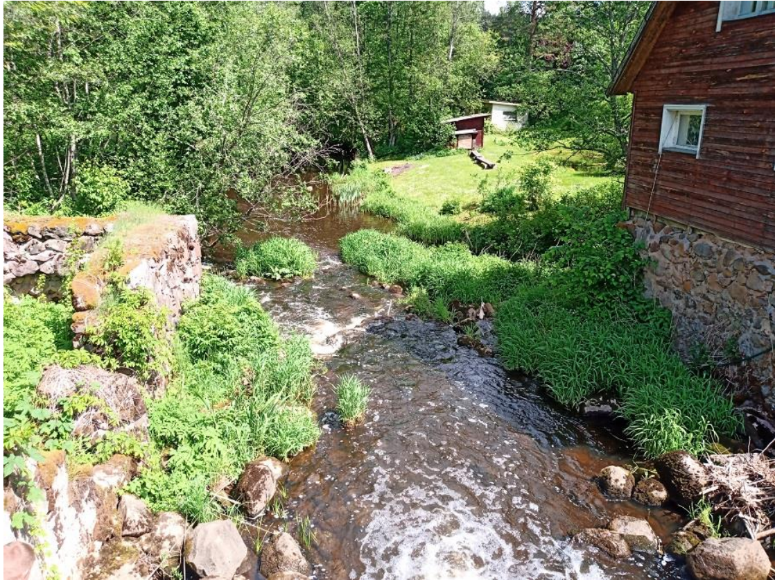
Foto Raudsilla 4. Vaade paisult allavoolu. Paremalt kaldalt suubub jõkke hej äravoolukanal (09.06.2022).
