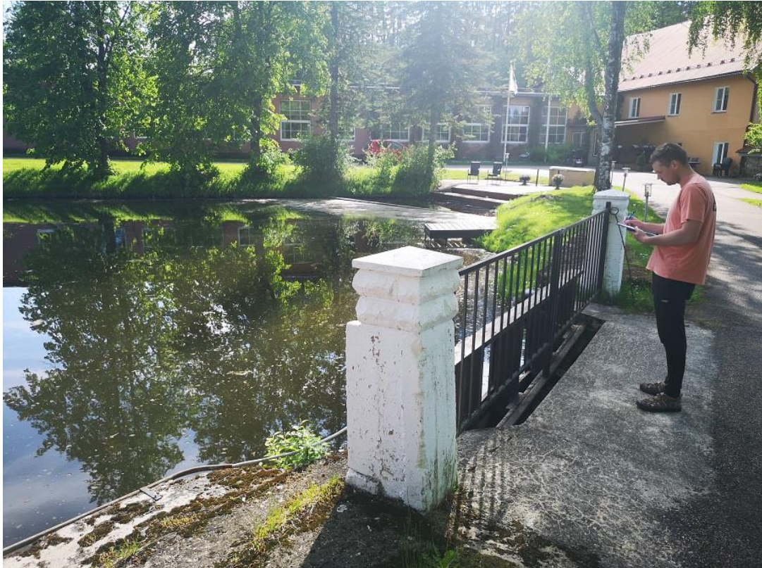
Foto Ala-Rõuge 3. Esiplaanil paisu liigveelask, tagaplaanil hej hoone ja hej sissevool (kaetud puitterrassiga) (07.06.2022).
