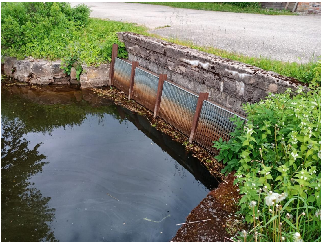
Foto Hellenurme 4. Turbiinide sissevoolukanali ees olev võre avadega 32 mm (10.06.2022).
