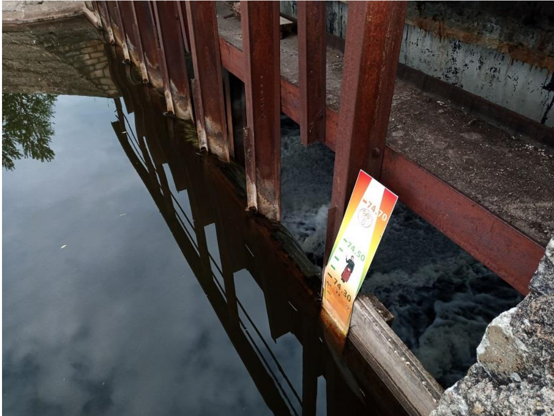
Foto Hellenurme 3. Hellenurme paisu liigveelask ja sellel olev paisjärve veetaseme mõõdulatt (10.06.2022).
