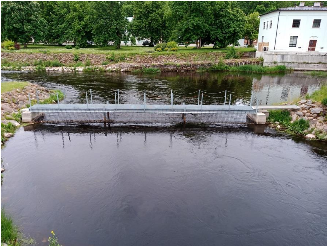
Foto Põltsamaa 7. Hej äravoolukanali suudmes on võre avadega 40 mm, mis takistab suuremate kalade sattumist äravoolukanalisse (14.06.2022).
