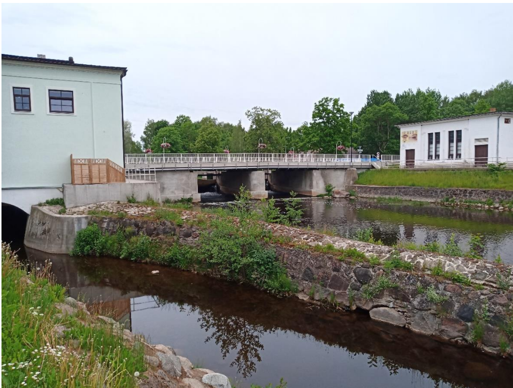
Foto Põltsamaa 3. Põltsamaa pais ja hej alavee poolt jõe paremalt kaldalt vaadates. Jõe paremal kaldal on tavaoludes varjadega suletud lisaliigveelask, mida avatakse ainult suurvee korral (14.06.2022).
