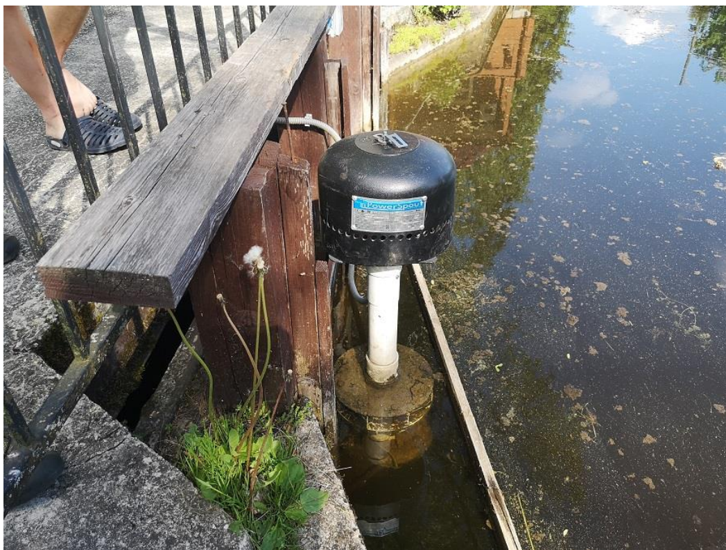
Foto Ala-Rõuge 1. Paisu liigveelasu juures olev mikro-turbiin võimsusega 120 W ning veetarbega kuni 53 l/s (07.06.2022).
