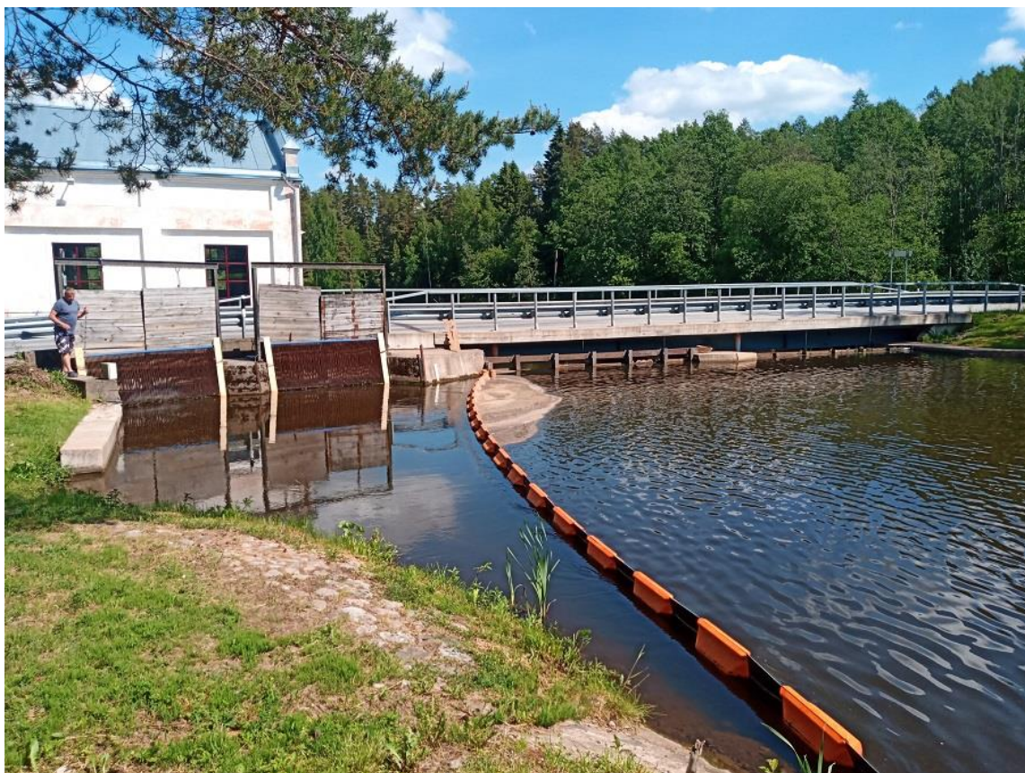
Foto Leevaku-1. Pais on rajatud koos mnt sillaga, turbiinide sissevoolud asuvad jõe vasaku kalda ääres (09.06.2022).
