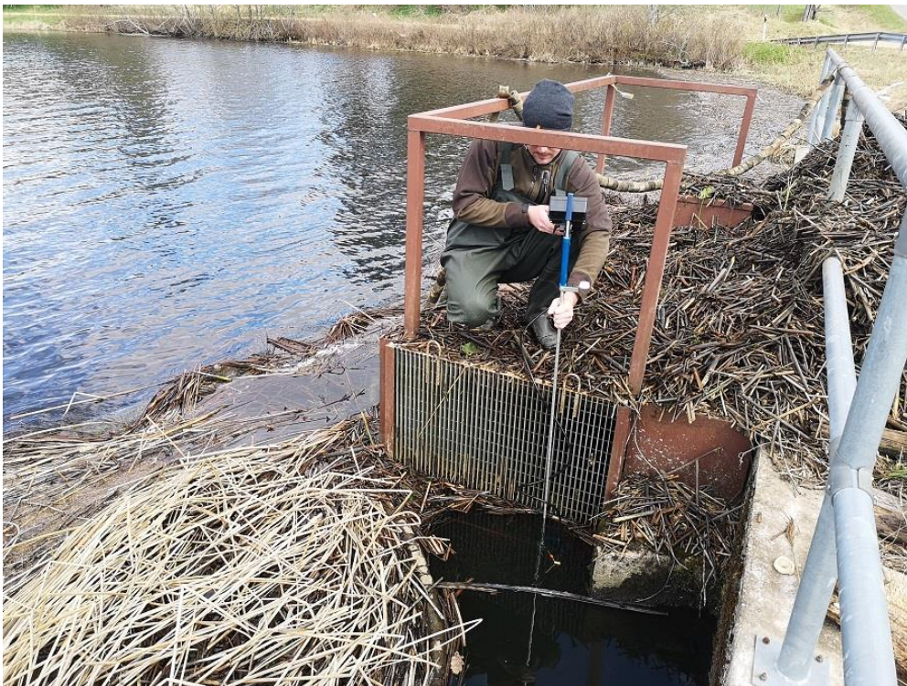
Foto Sangaste 8. Hej sissevoolul olevad võred on piisavalt väikeste avadega (18 x 46 mm), et takistada >15 cm pikkuste kalade sattumist turbiinidesse, kuid kitsad avad ka ummistuvad kiirelt ja nõuavad tihti puhastamist (28.04.2022).
