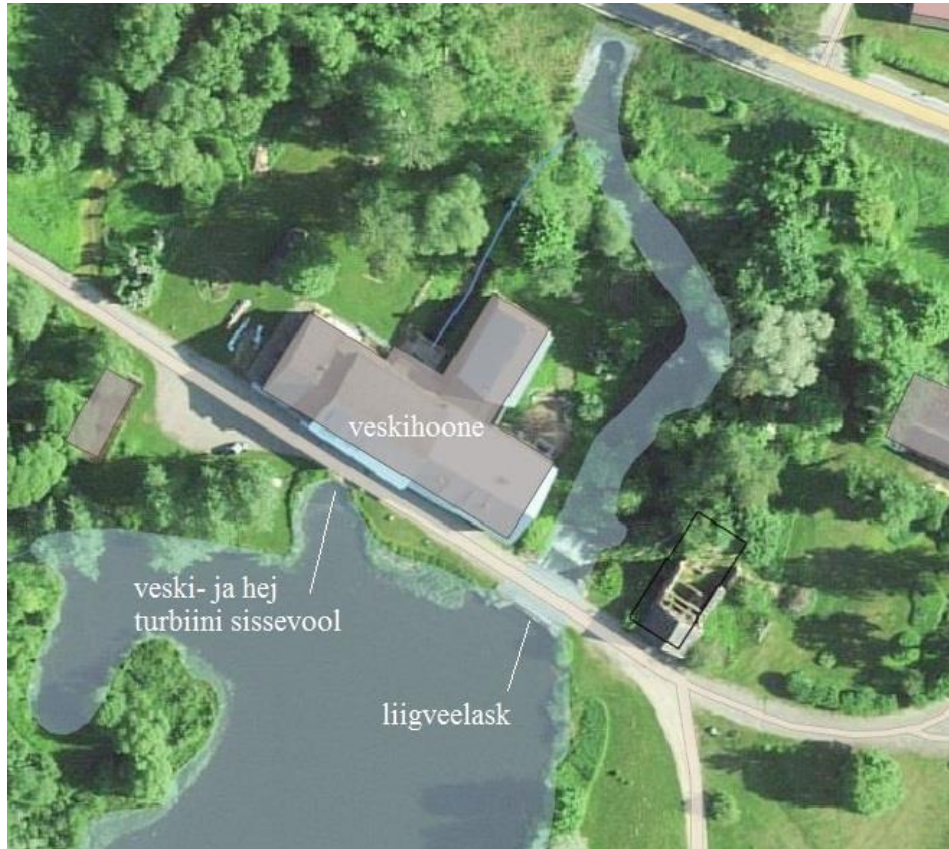
Ortofoto Elva-2. Hellenurme pais ja veski Elva jõel.
