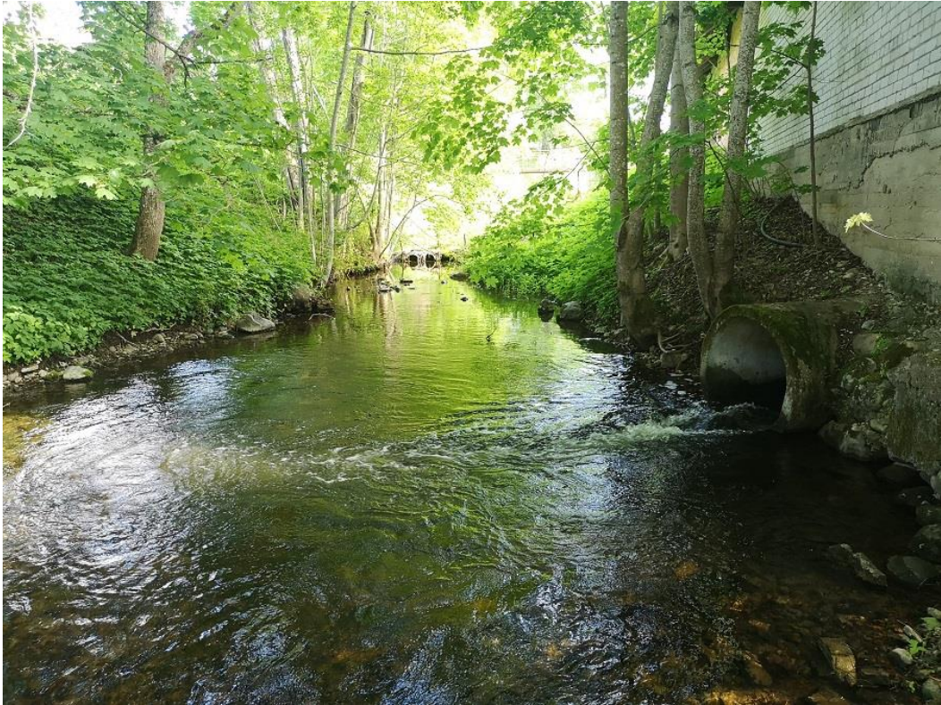
Foto Ala-Rõuge 6. Põhiturbiini äravoolukanal kulgeb pikalt maa all ja suubub jõkke ca 70 m paisust allavoolu (07.06.2022).
