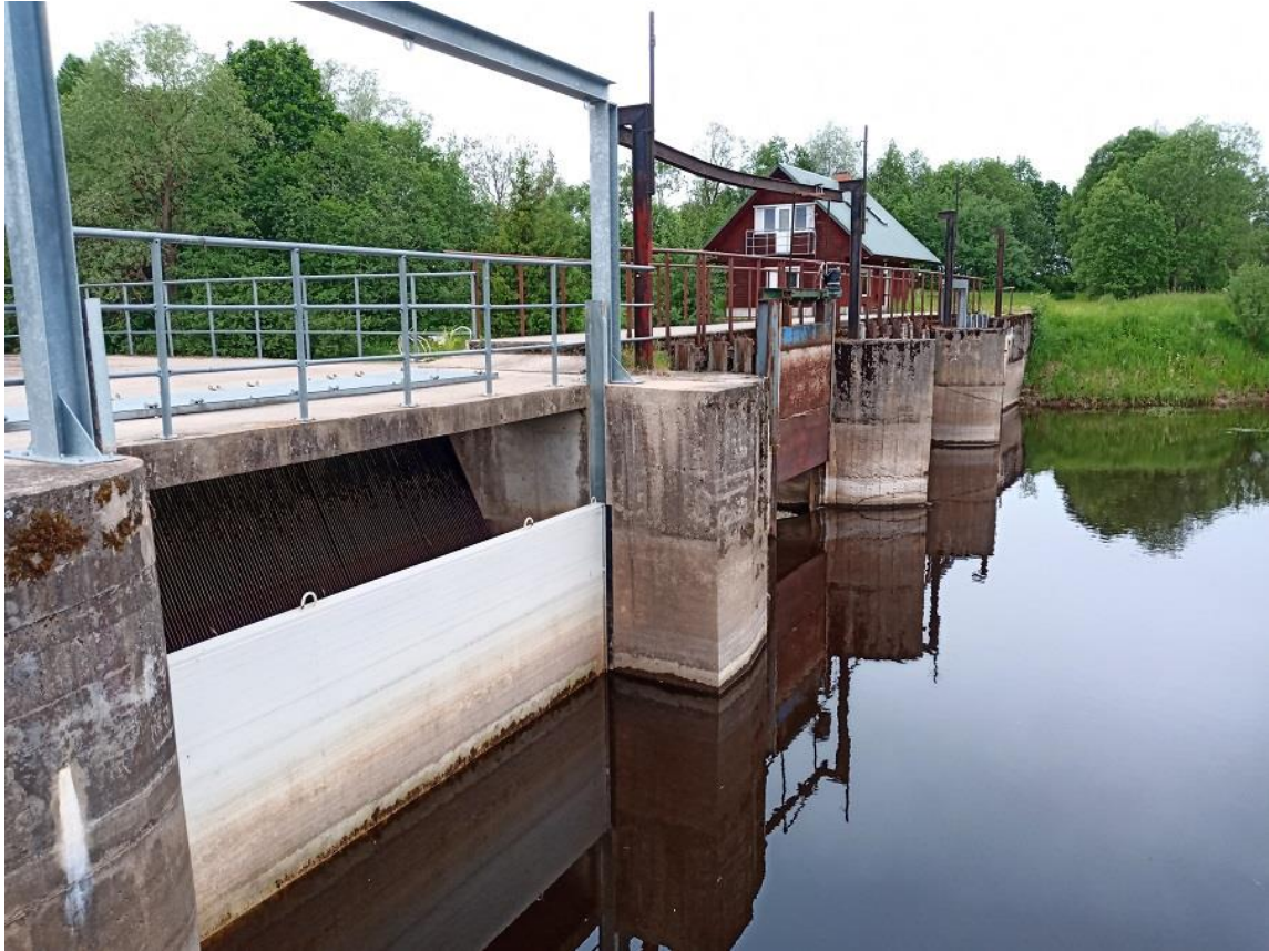
Foto Painküla 3. Painküla paisu liigveelask osaliselt tõstetud varjadega (14.06.2022).
