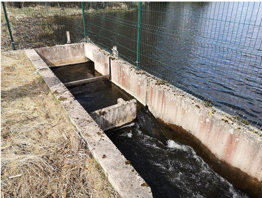
Foto Sangaste 6. Sangaste Vastsemõise kalapääsu sissevool. Sissevoolul olev kalaloendur pole praktiliselt töötanud ja seniste seirete käigus sellest kasu pole olnud. EL abiga hangitud kalaloendurid anti paisuomanikele, kel puudub huvi ja oskused neid kasutada ja korras hoida. Kalade seire läbiviijatel kalaloendureid pole (28.04.2022).
