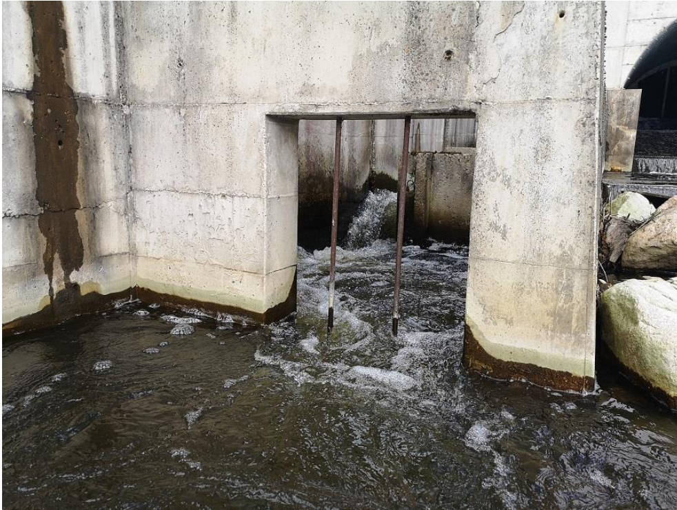
Foto Sangaste 7. Kalapääsu väljavool on kamberkalapääsu üks kriitilisemaid kohti. Paisu aluste ümberehitustöödega on püütud jõe veetaset kalapääsu väljavoolu juures tõsta, viimati 2021. aastal. Väga hästi pole see ikkagi õnnestunud. Veetasemete vahe eelviimase ja viimase kambri vahel on projekteeritud 12 cm asemel 20...30 cm (28.04.2022).
