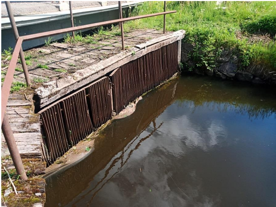
Foto Leevi-4. Parempoolse turbiini sissevoolu ees olev võre on deformeerunud, võre avad varieeruvad 20...60 mm (09.06.2022).
