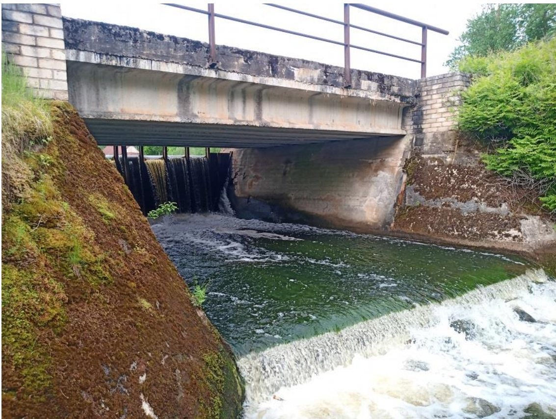
Foto Hellenurme 2. Hellenurme paisu liigveelask (10.06.2022).
