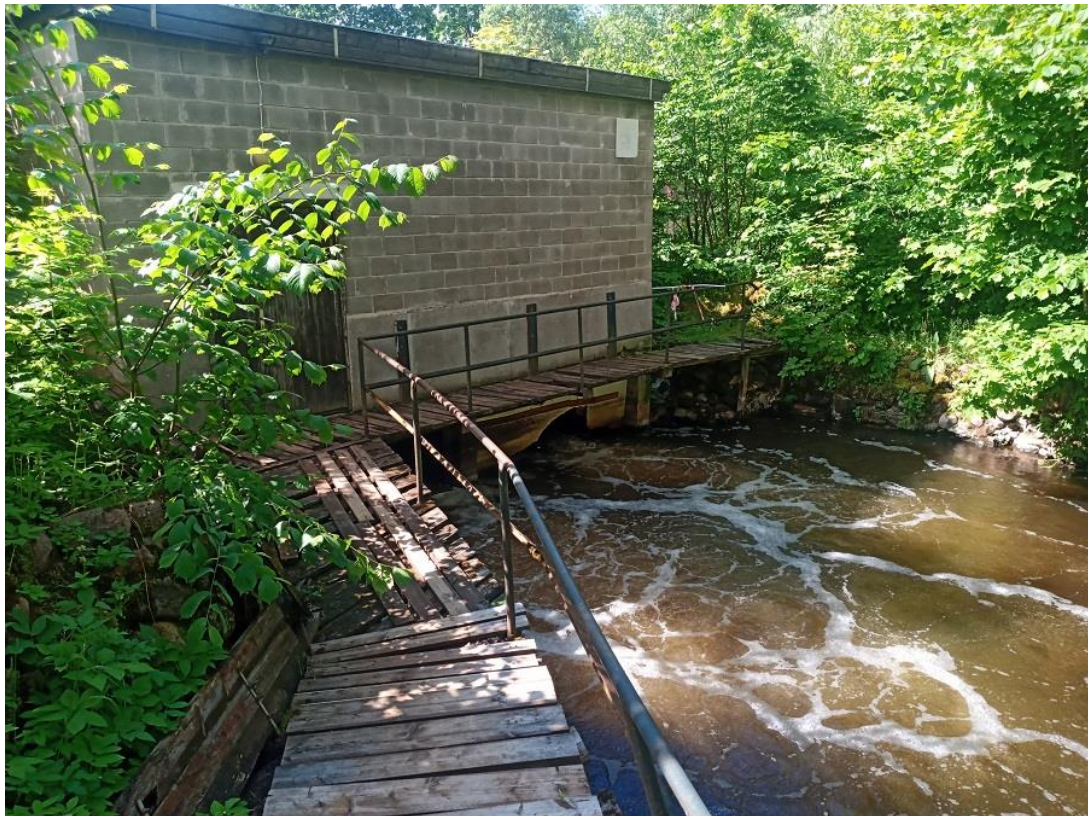
Foto Leevi-5. Leevi hej turbiinihoone ja turbiinide väljavoolukanali algus (09.06.2022).
