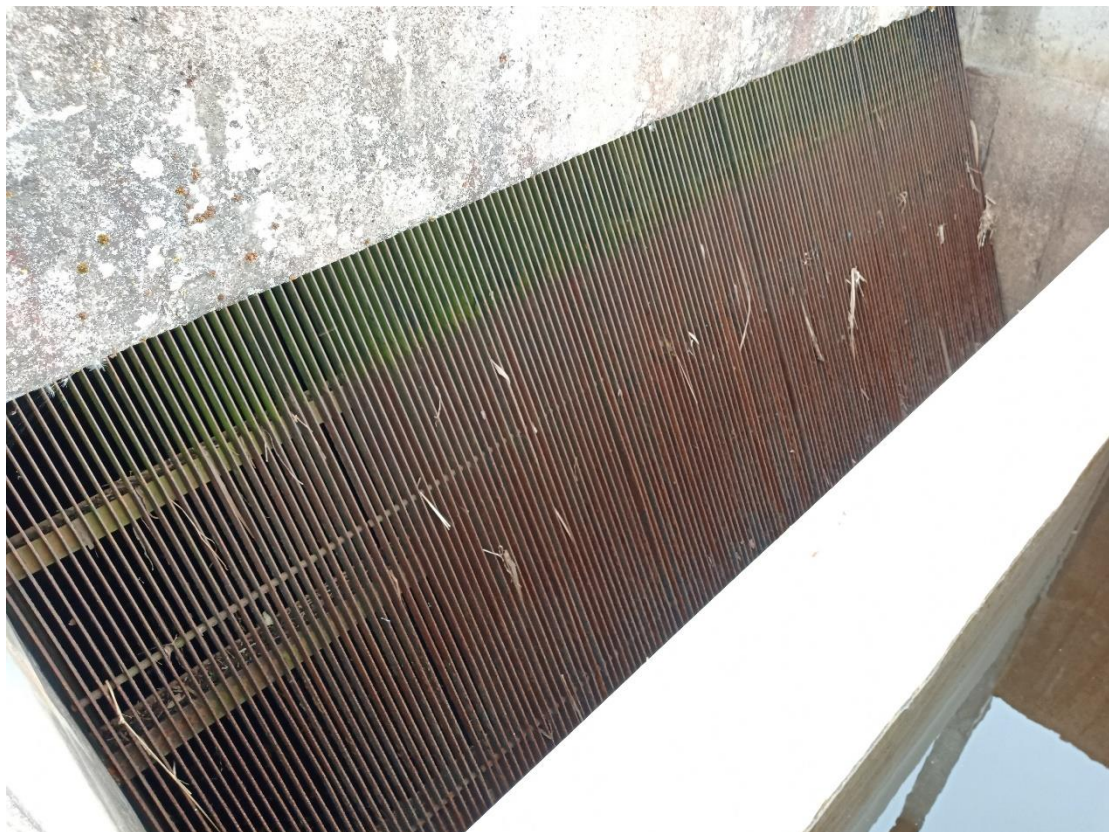
Foto Painküla 6. Võre Painküla hej sissevoolukanali ees on korralik (14.06.2022).
