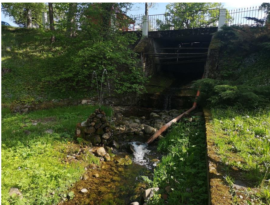
Foto Ala-Rõuge 2. Paisu liigveelask alavee poolt vaadates. Oranži toru kaudu tuleb vesi paisu peal olevast mikro-turbiinist (07.06.2022).
