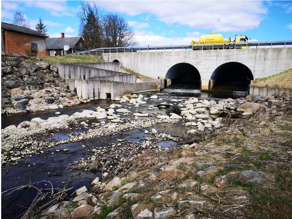
Foto Sangaste 5. Sangaste Vastsemõise paisu liigveelask ja kalapääs alavee poolt vaadates (28.04.2022).
