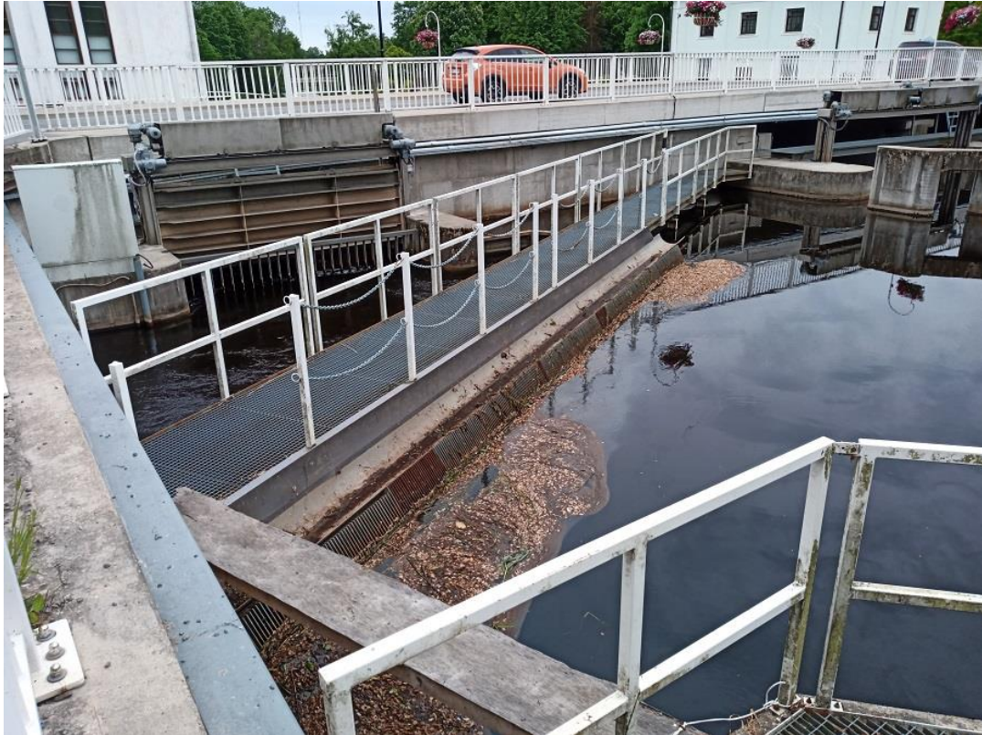
Foto Põltsamaa 6. Hej sissevoolu ees on korraliku konstruktsiooniga võre avadega 20 mm (14.06.2022).
