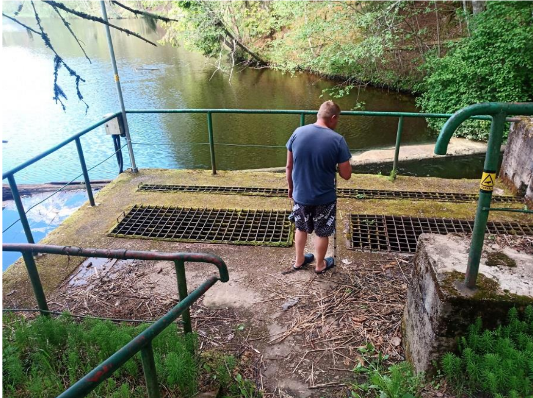
Foto Saesaare 5. Saesaare hej turbiinide sissevool (10.06.2022).
