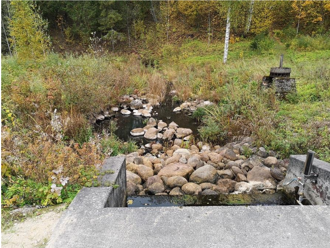
Foto Elva (Räbi) 5. Elva (Räbi) paisu parempoolne liigveelask. Sellesse oleks loogiline kujundada kalapääs (10.06.2022).
