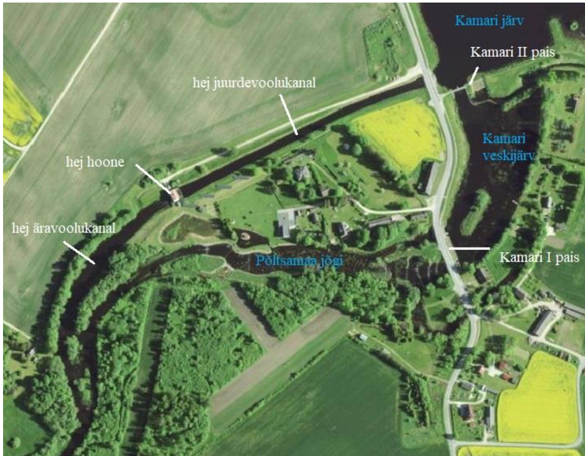
Ortofoto Põltsamaa 1. Kamari I ja II paisud ning hej Põltsamaa jõel.
