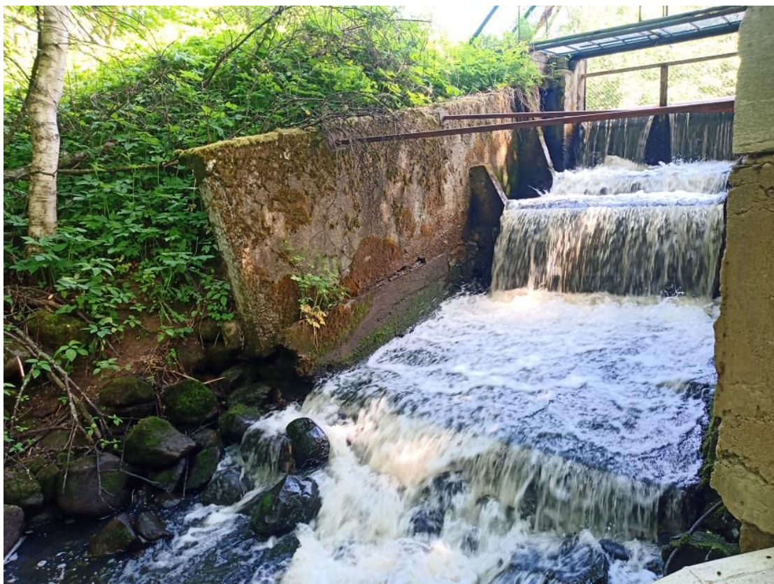
Foto Peri 2. Liigveelase alavee poolt vaadates (09.06.2022).
