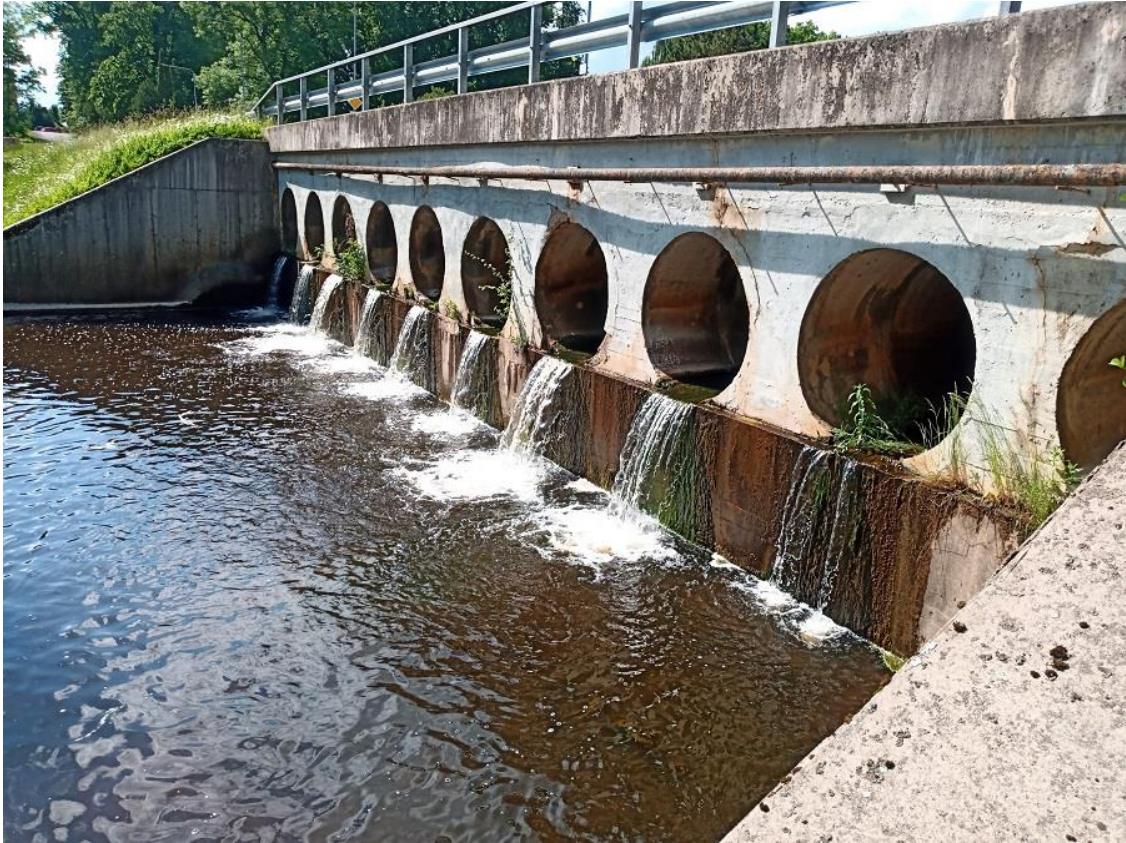
Foto Rápina 4. Rápina paisu keskel asuv liigveelask, vaade alavee poolt (09.06.2022).
