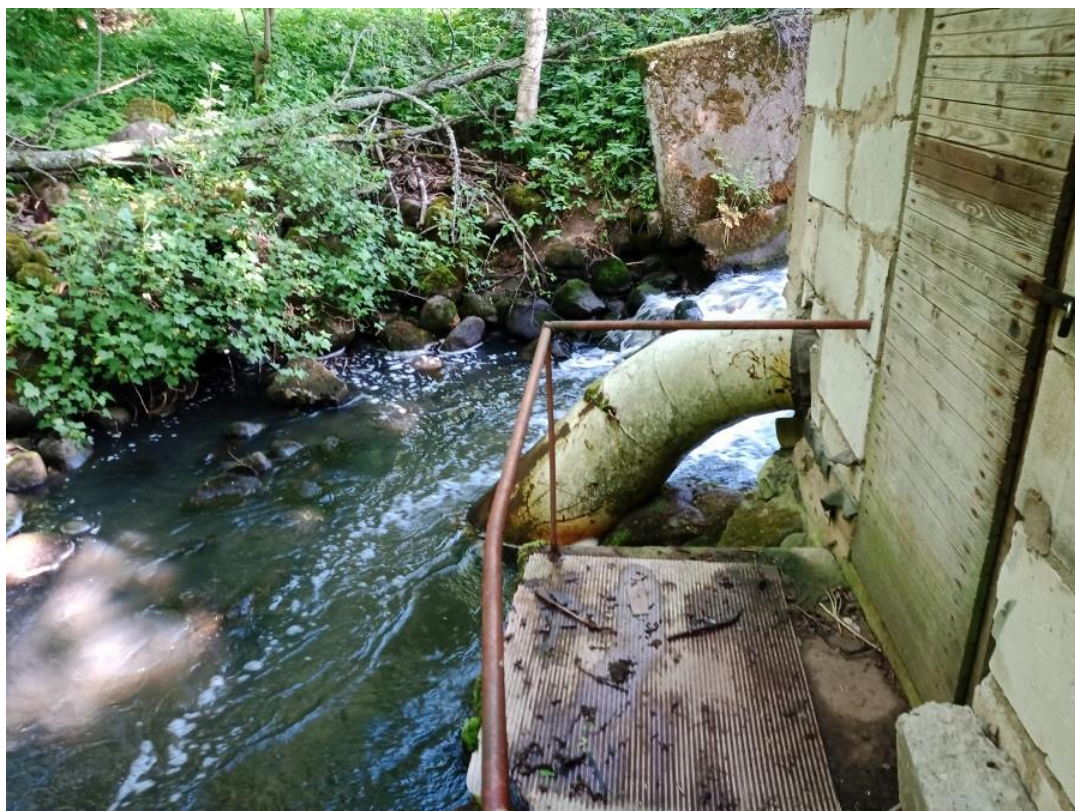
Foto Peri 5. Hej väljavoolutoru on uputatud (09.06.2022).
