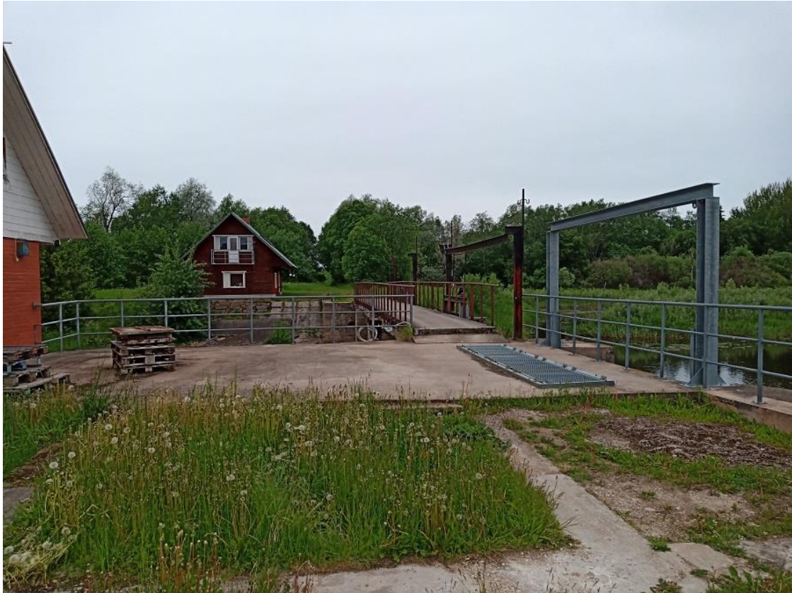
Foto Painküla 5. Painküla pais, esiplaanil hej sissevoolukanal, mis on pealt kaetud betoonplaadiga (14.06.2022).
