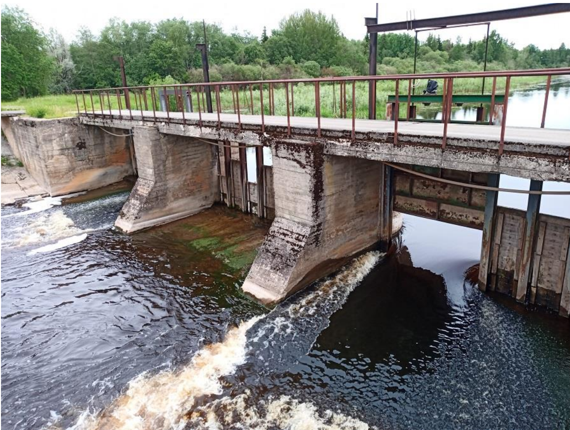
Foto Painküla 4. Painküla paisu liigveelask, vaade alavee poolt (14.06.2022).
