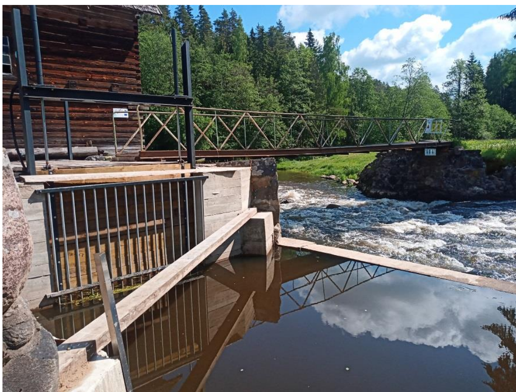
Foto Viira-2. Kruviturbiini sissevoolukanalis on prahivõre avadega 150 mm. Kalade vigastumise oht kruviturbiini sattudes on väike. Tagaplaanil kärestikuline kalapääs (09.06.2022).
