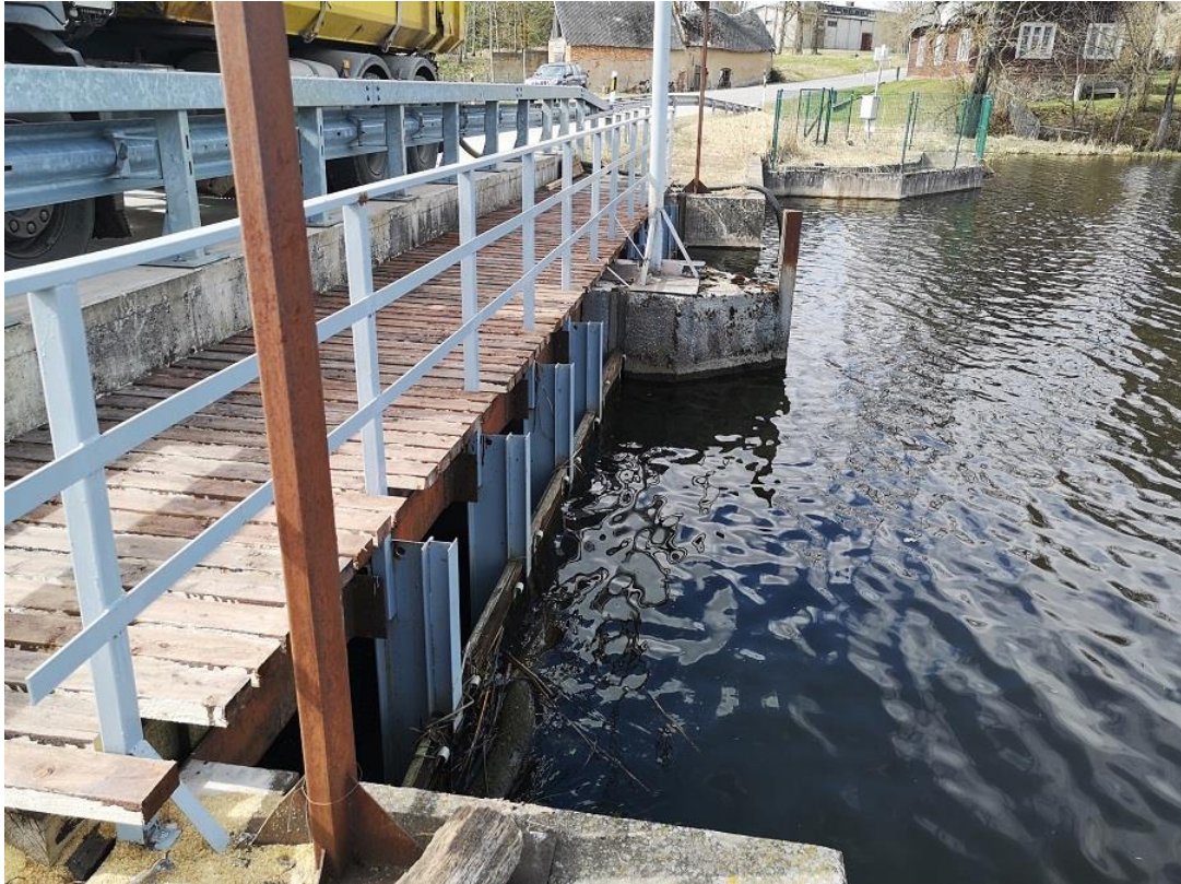
Foto Sangaste 3. Sangaste Vastsemõise paisu liigveelask ülavee poolt vaadates. Tagaplaanil kalapääsu sissevool (28.04.2022).
