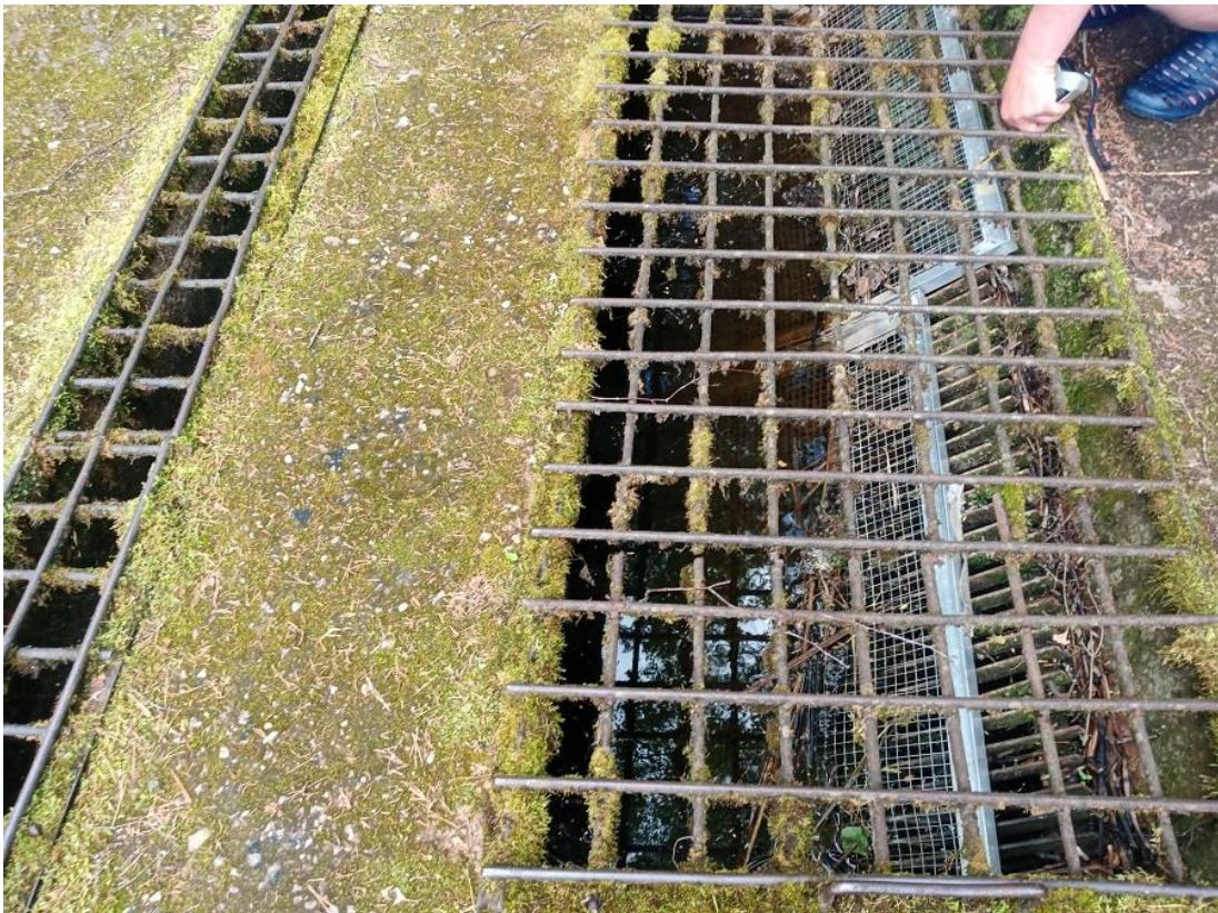
Foto Saesaare 6. Hej sissevoolul on vana võre peale paigaldatud uus võre, kuid seegi pole piisava tihedusega. Mõõtmisel saadi võre avadeks 32 mm (10.06.2022).
