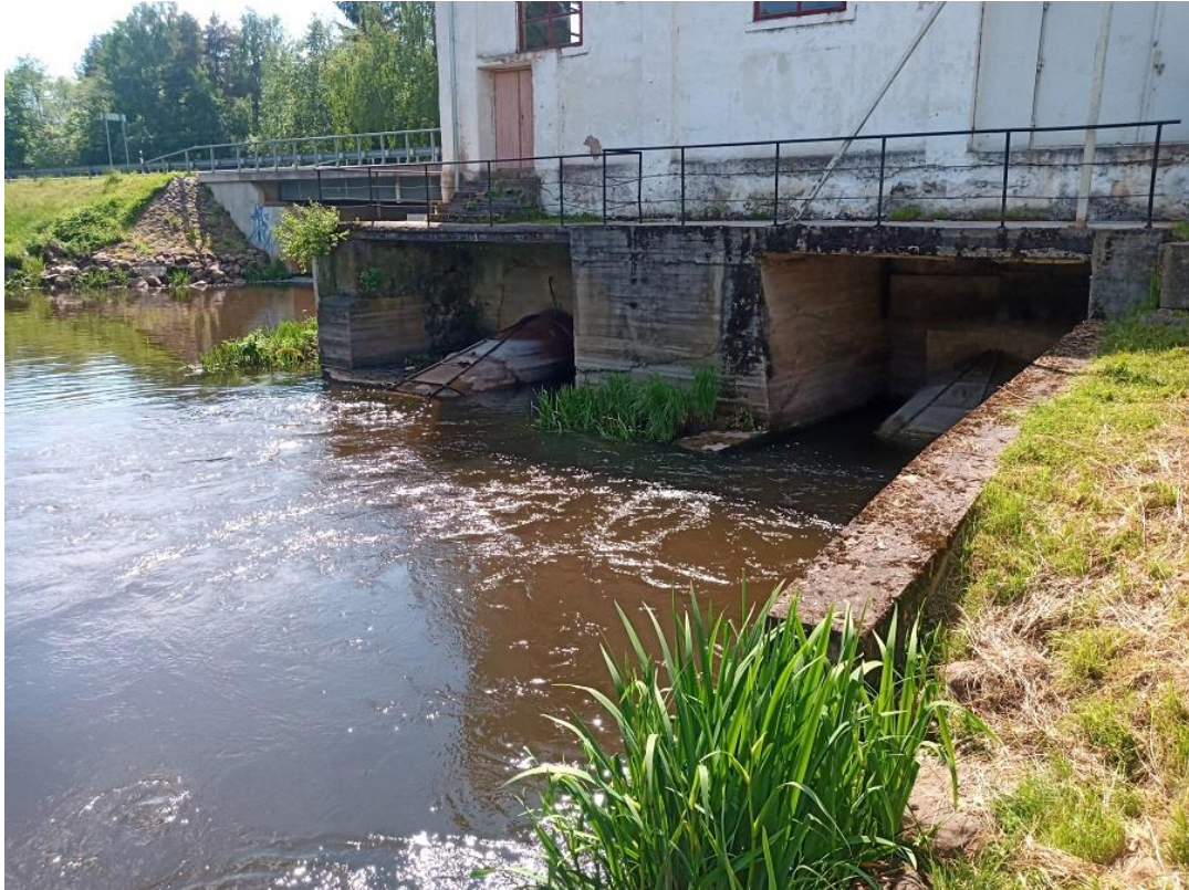
Foto Leevaku-2. Hüdrolektrijaama turbiinide väljavoolud (09.06.2022).
