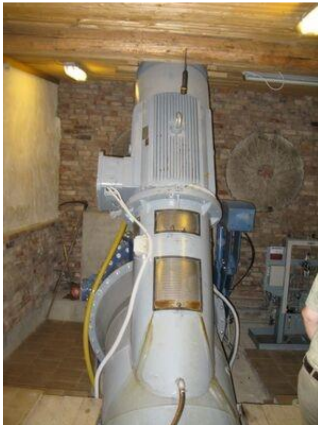
Foto Sangaste 2. Sangaste hej-s kasutatav kaplanturbiin (foto WeskiWiki).
