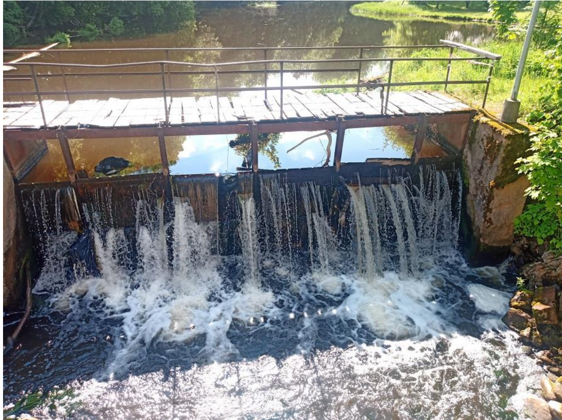
Foto Leevi-2. Leevi paisu vasakpoolne liigveelask (09.06.2022).
