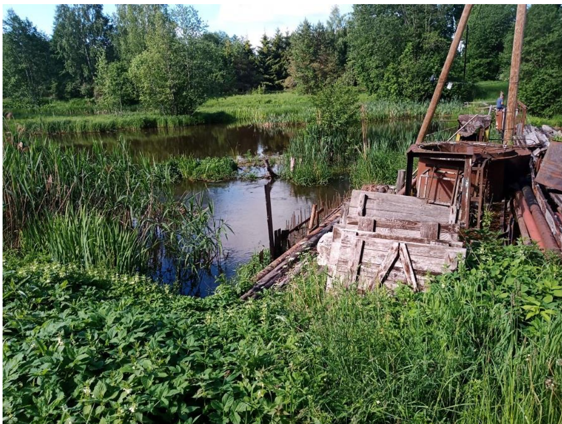
Foto Paidra-2. Paidra hej turbiinikanali sissevool (09.06.2022).
