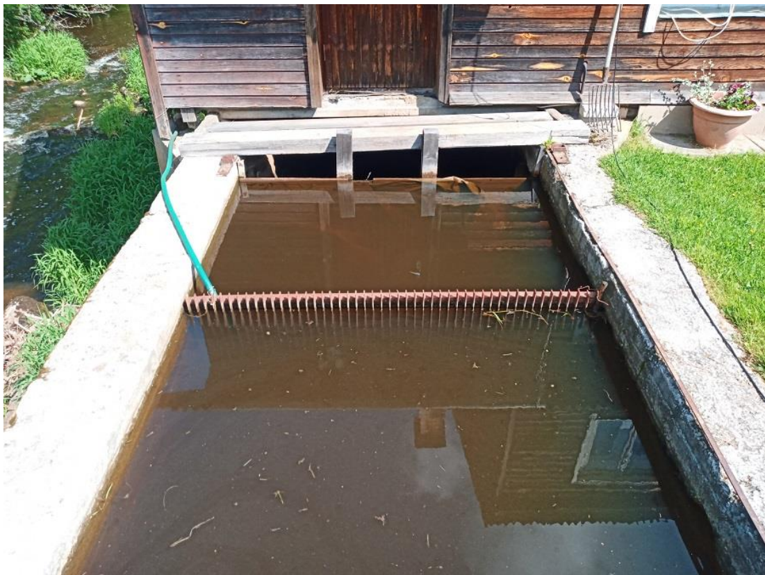
Foto Raudsilla 3. Hej sissevoolukanal, lehtterasest võre avad (35...38 mm) ei vasta seadusest tulenevatele nõuetele (09.06.2022).
