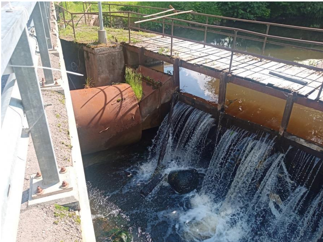
Foto Leevi-3. Leevi paisu parempoolne liigveelask koos ühe turbiini sissevoolutoruga (09.06.2022).
