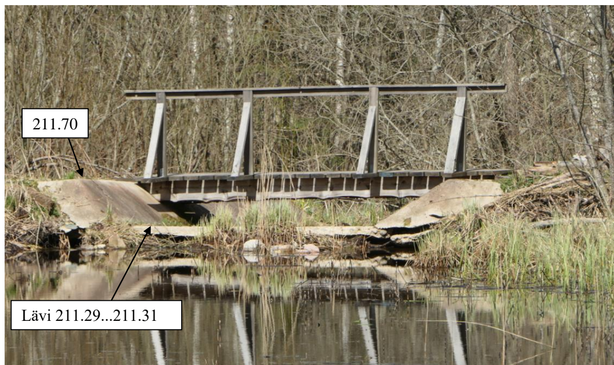
Foto 1. Vaade ülevoolule ülavee poolelt (30.04.2020). Vee tase on 20 cm ülevoolulävest madalamal (8.05.2020).
