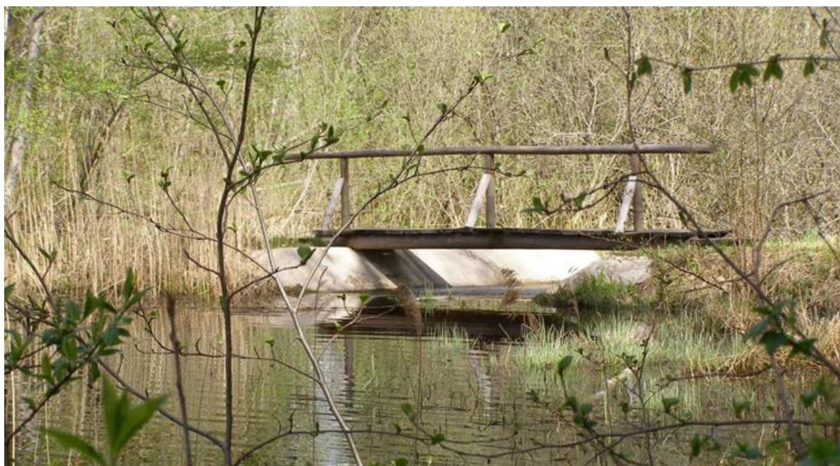
Foto 4. Vaade ülevoolule ülavee poolelt (8.05.2012). Vee tase on 10 cm ülevoolulävest kõrgemal (Foto Urmas Nugin 2012).
