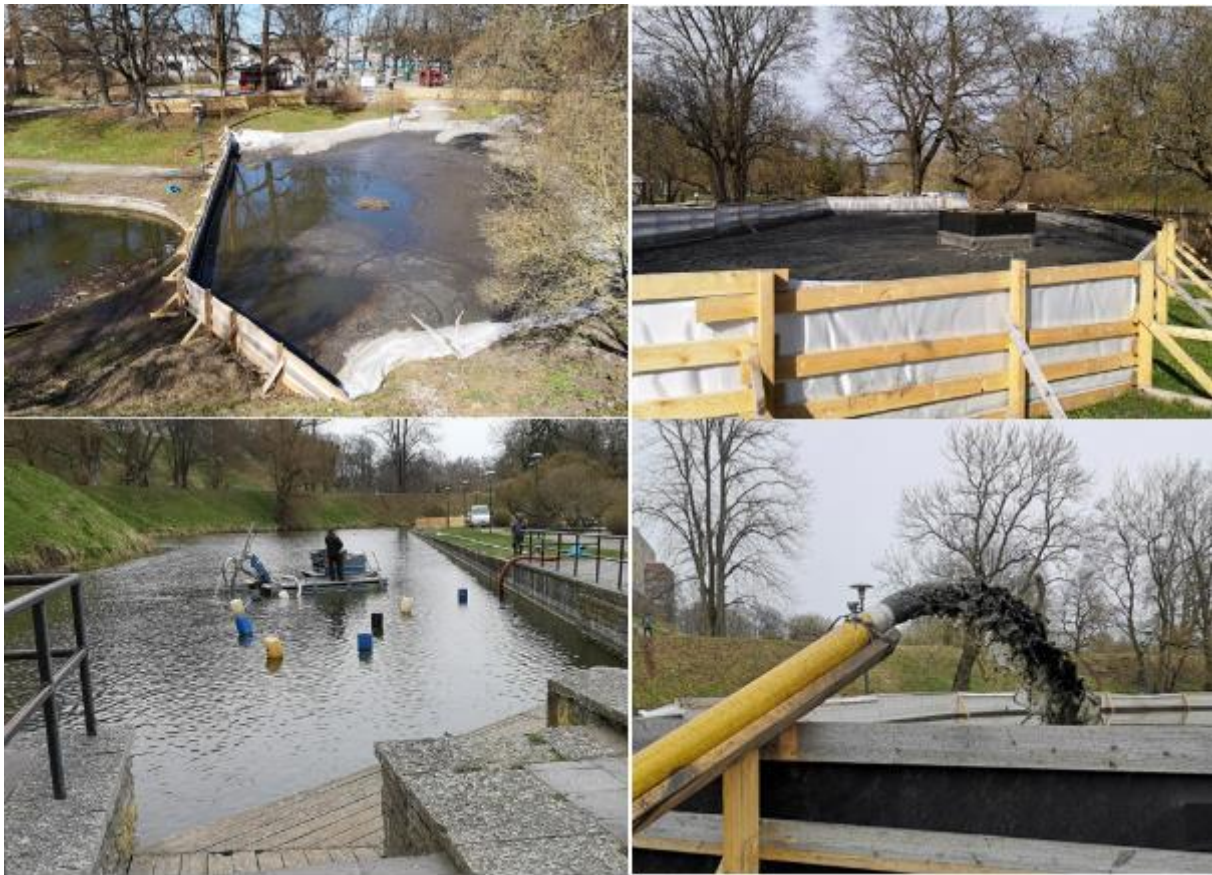
Foto 6. Snelli tiigi puhastamine ujuvsüvendajaga. Materjal pumbatakse välja kaladele rajatud settebasseini, tahendatakse (vesi juhitakse tagasi tiiki) ja veetakse minema (K.Tuul foto 2021)
