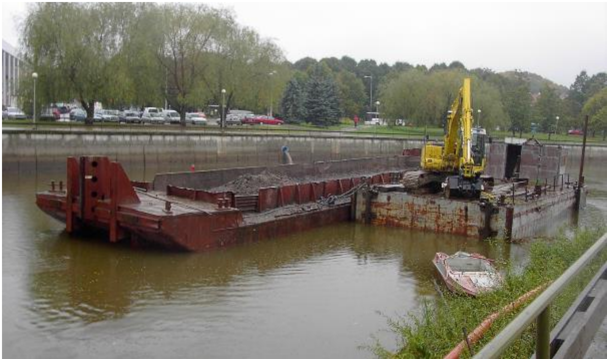
Foto 8. Emajõe süvendamine Atlantise kai rajamisel. Pinnas kaevatakse välja praamil seisva roomikekskavaatoriga, laaditakse praamile ja veetakse minema. Kaevetööde ja piirkonda ei ole heljumi leviku tõkestamiseks piiratud (U. Nugin foto 2005).
