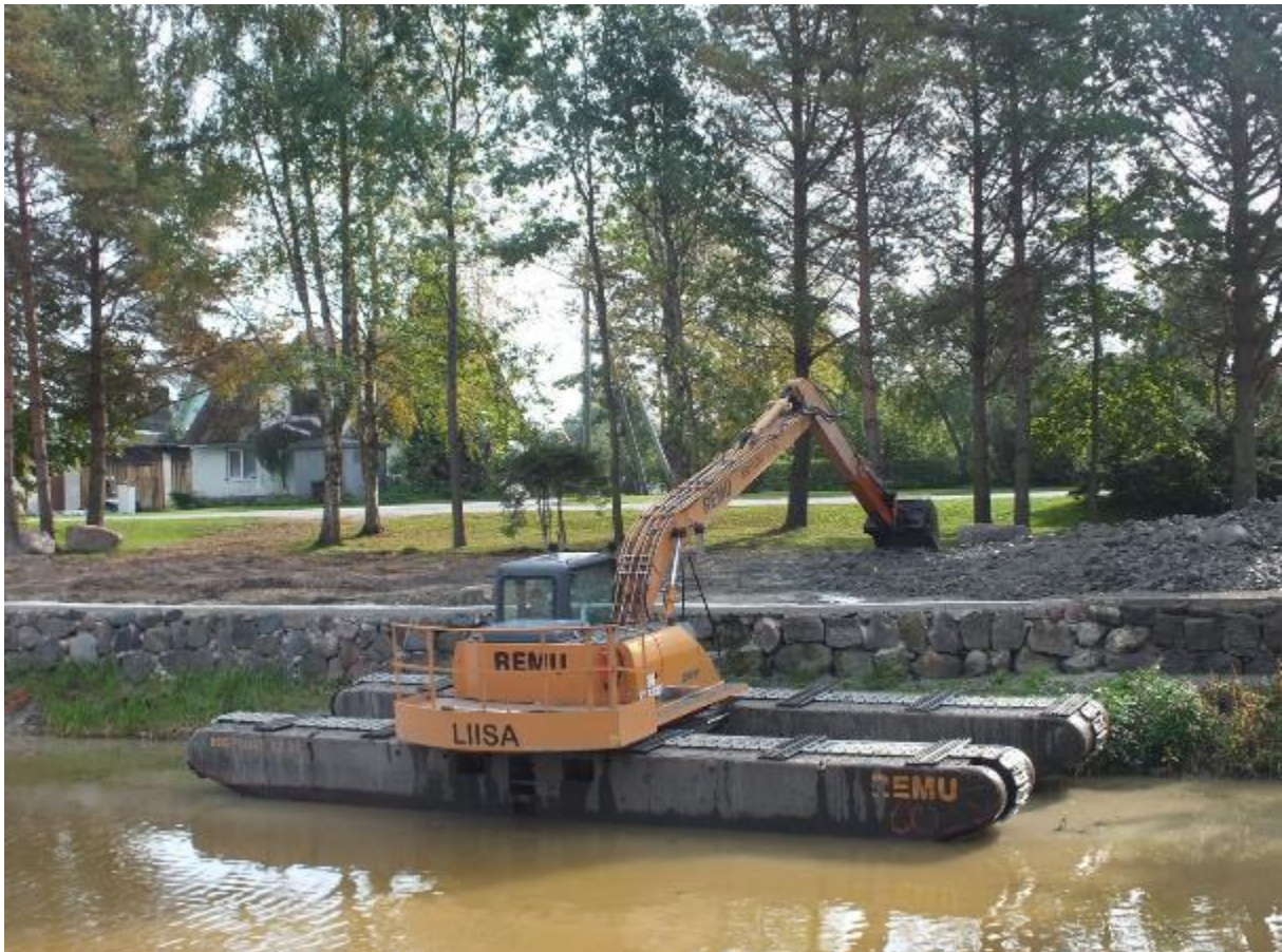
Foto 3. Mustvee jõe süvendamine paadisadama piirkonnas. Pinnas kaevatakse välja ujusüvendajaga, paigutatakse kaldale ja veetakse peale tahenemist minema. Kaevetööde piirkonda ei ole heljumi leviku tõkestamiseks piiratud. (M.Viirma foto 2014).
