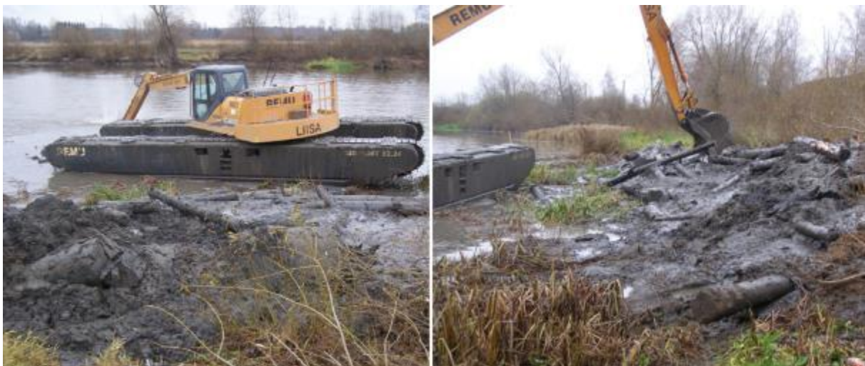
Foto 7. Emajõe süvendamine Sõbra tn ujuvkai rajamisel. Materjal (pinnas ja palgid) kaevatakse välja ujuvsüvendajaga, paigaldatakse kaldale ja veetakse peale tahenemist minema. Kaevetööde ja materjali ladustamise piirkonda ei ole heljumi leviku tõkestamiseks piiratud (U. Nugin foto 2013).
