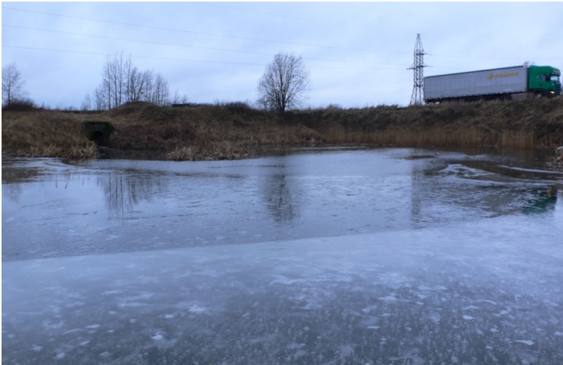
Foto 5. Maardu tööstusrajooni sademe ja heitvee ühisvoolse kanalisatsiooni väljalask alumises tiigis (väljalasu kood TL047).
