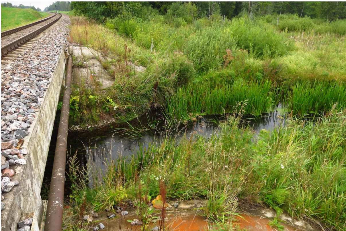
Joonis 19. Tapa-Tartu raudtee all olev killustikukuhjatis takistab Nõmme jõe voolu ning reguleerib ka Kaanjärve veetaset (Foto: Marko Vainu).
