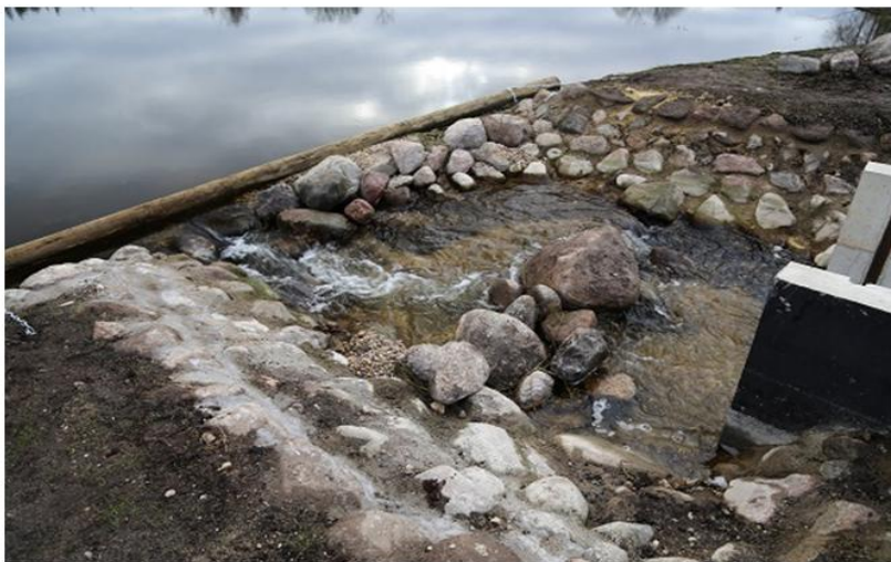
Foto 11. Ajutise lahendusena tõstis ehitaja kalapääsu sissevoolul sāngi põhjakõrgust ning rajas sinna kaks väikest veeastet. See võimaldas muuta kalapääsu kaladele põhimõtteliselt läbitavaks ka väga väikese vooluhulga korral ning paisjärve NPT säilitades (R. Järvekül, 31.01.2014).
