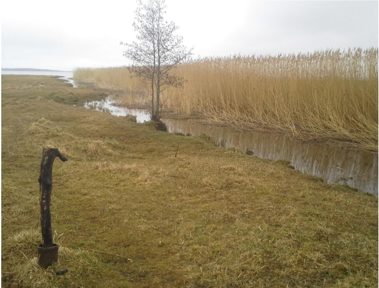
Joonis 3.16. Veiste poolt osaliselt avatuks söödud, kuid osaliselt roostunud Jausa oja peavoolukanal ja avatud suue (Foto 9.04.2019).
