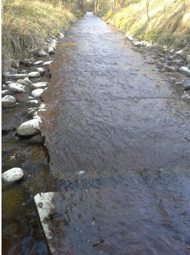
Joonis 3.89. Tõrvanõmme peakraavi säng on maantesillast allavoolu betoonplaatidega vooderdatud (Foto 23.04.2019).
