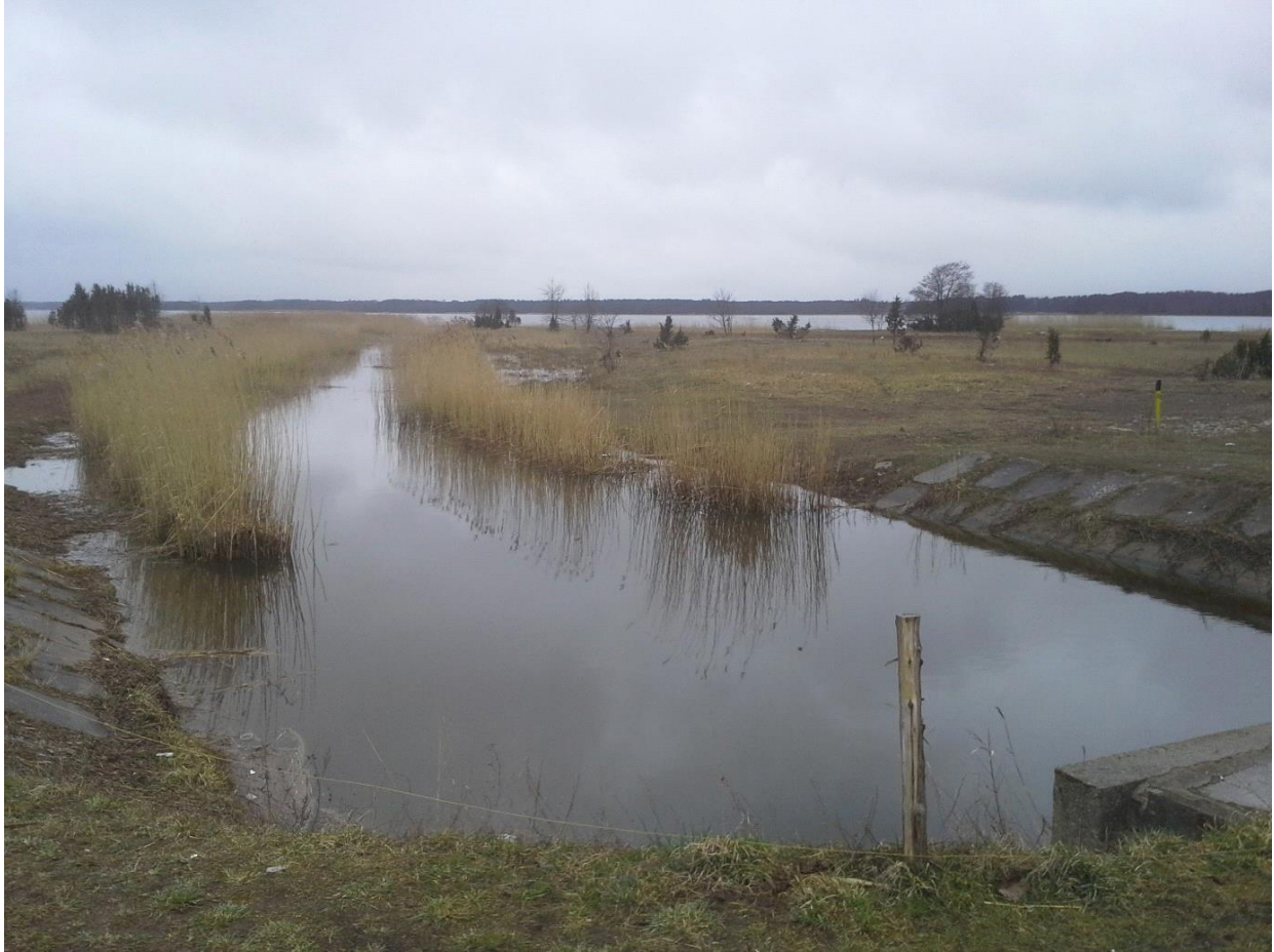
Joonis 1.1.8. Puulaiu kanal oli foto tegemise ajal keskelt pisut roostunud, kuid siiski kaladele läbitav (Foto 9.04.2019).
