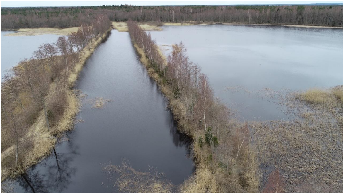
Joonis 3.1. Armioja veerikkam, läänepoolsem suue Kõõnaaku on pinnasevallidega piiratud ning juhitud sisuliselt otse Kõõnaaku Kirikulahest eraldava vallini (Foto 10.04.2019).
