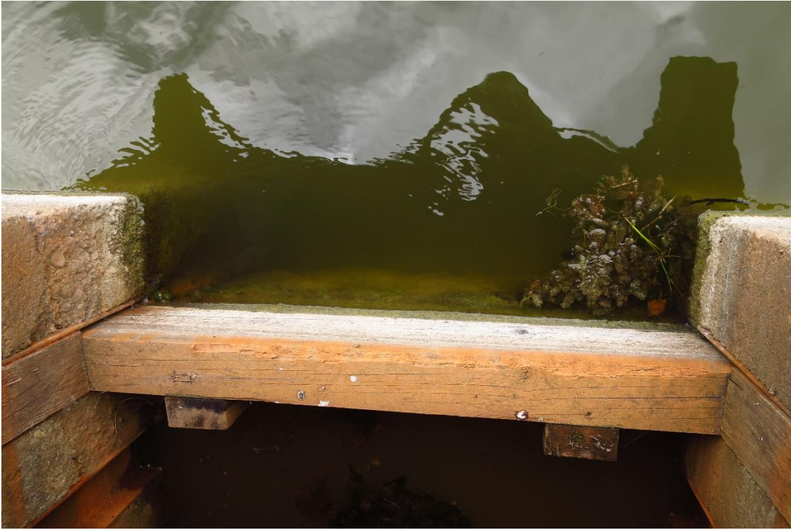
2. Järve sissevoolu truubikoht. Vee all oli näha oranži toru, kuid voolu polnud, sest paisutuse mõju ulatus ka truubist lääne poole, kus taimestiku vahel oli seisvat vett:
