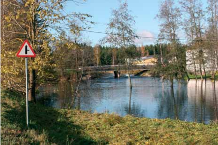
Avinurme alevi Paadenurme silla juures asusid kunagi Ansipi vesiveskid. Foto: Anne-Ly Feršel.
