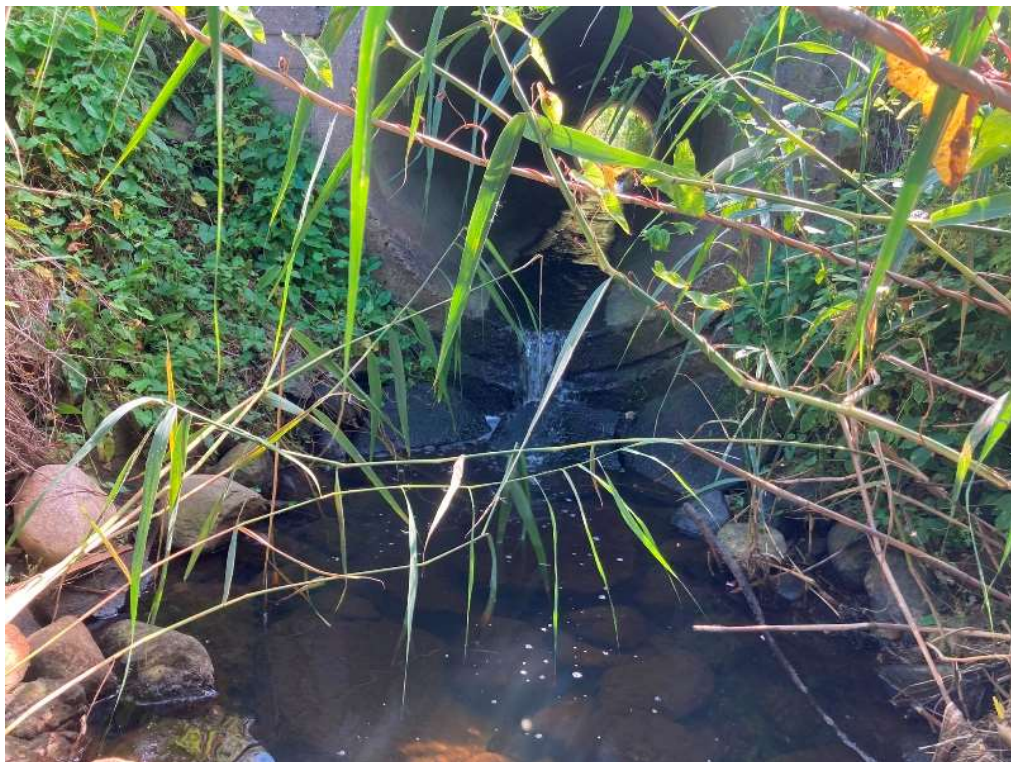
Foto 2. Uusküla tee aluse truubi väljavool on madalveeperioodil kaladele rändetõkkeks (P. Pall, 8.08.2024).
