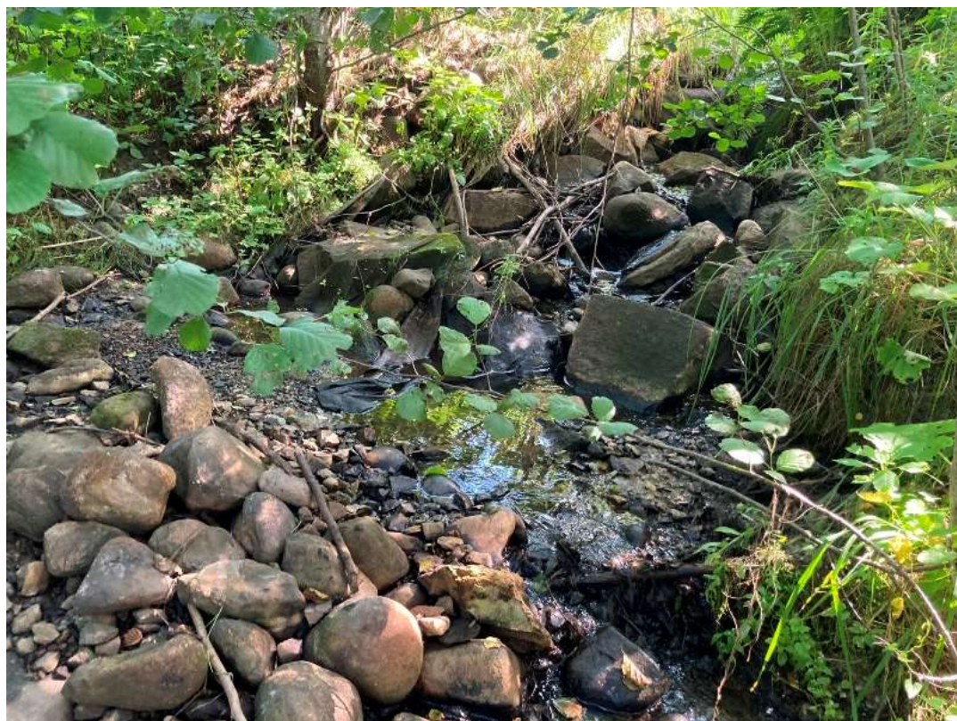
Foto 4. Veevaene tehiskärestik Võerdla ojal ca 20 m allpool Klaukse tee truupi on kaladele ületamatu rändetõke (P. Pall, 8.08.2024).
