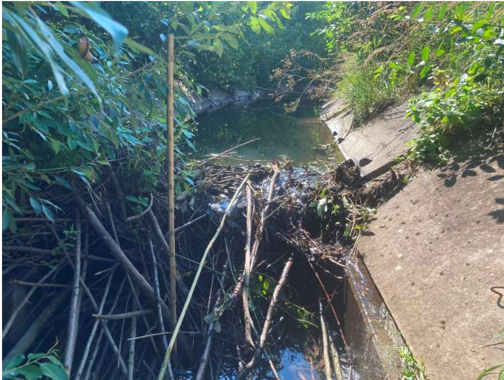
Foto 1. Kopravais (kõrgusega 0,6 m) Võerdla peakraavi alamjooksul betoonkallastega sängis ca 240 m suudmest (P. Pall, 8.08.2024).
