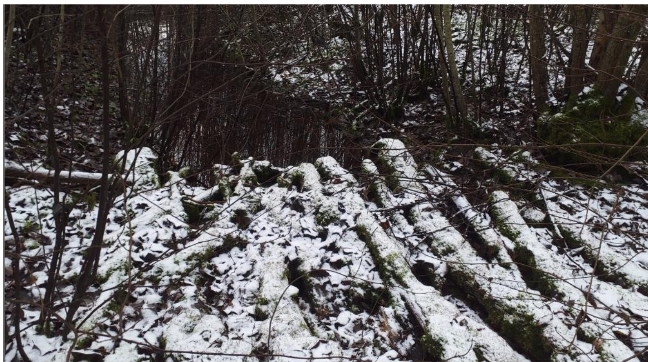
216. Üle kraavi on kuue meetri laiune palkidest ületuskoht. Palgid on osaliselt kraavi sisse vajunud. Nii üles- kui allavoolu vesi kraavis seisis:
