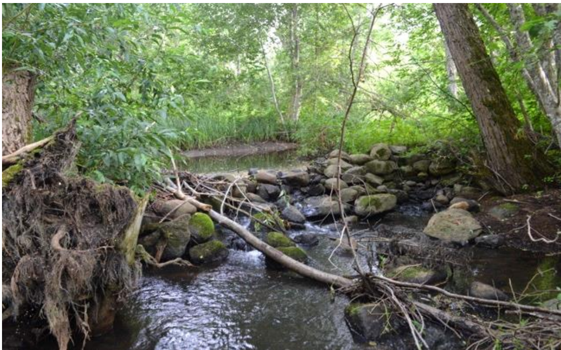
Foto 3.3.4. Ketneri talu lähedal (4,64 km suudmest) olev kivivall. Paisutuse kõrgus oli 0,5 m ning mõju ülesvoolu 70 m. Tegemist on raskesti ületatava rändetõkkega, välitööde ajal immitses vesi läbi kivide, kuid suurvee ajal on pais kaladele tõenäoliselt ületatav.
