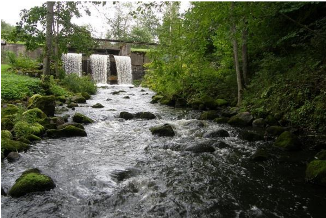
Foto 2.1.20. Märdi paisjärve pais (h 4,8 m) kaugusega 81,52 km suudmest. Efektiivselt toimiva kalapääsu rajamine on siin praktiliselt võimatu (R. Pihu, 05.09.2017).
