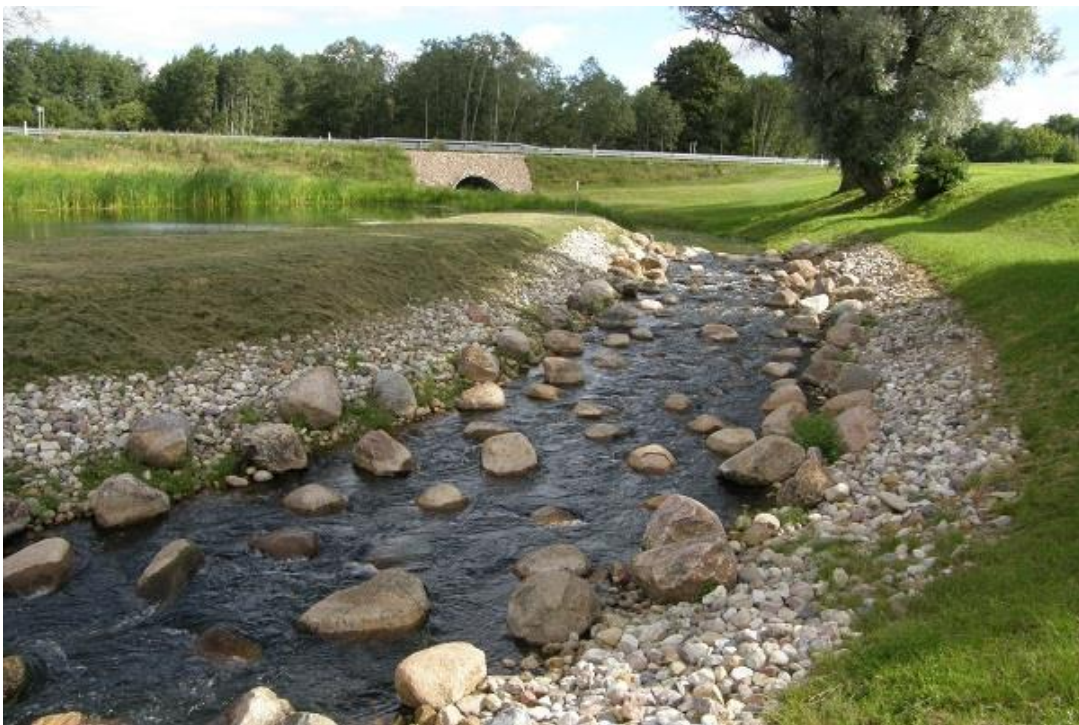
Foto 2.2.10. Endine Sarapuu pais allpool Võru–Viljandi maanteed on likvideeritud ja kujundatud karestikuks, mis sobib elu- ja sigimispaigaks jõeforellile (R. Pihu, 15.08.2016).
