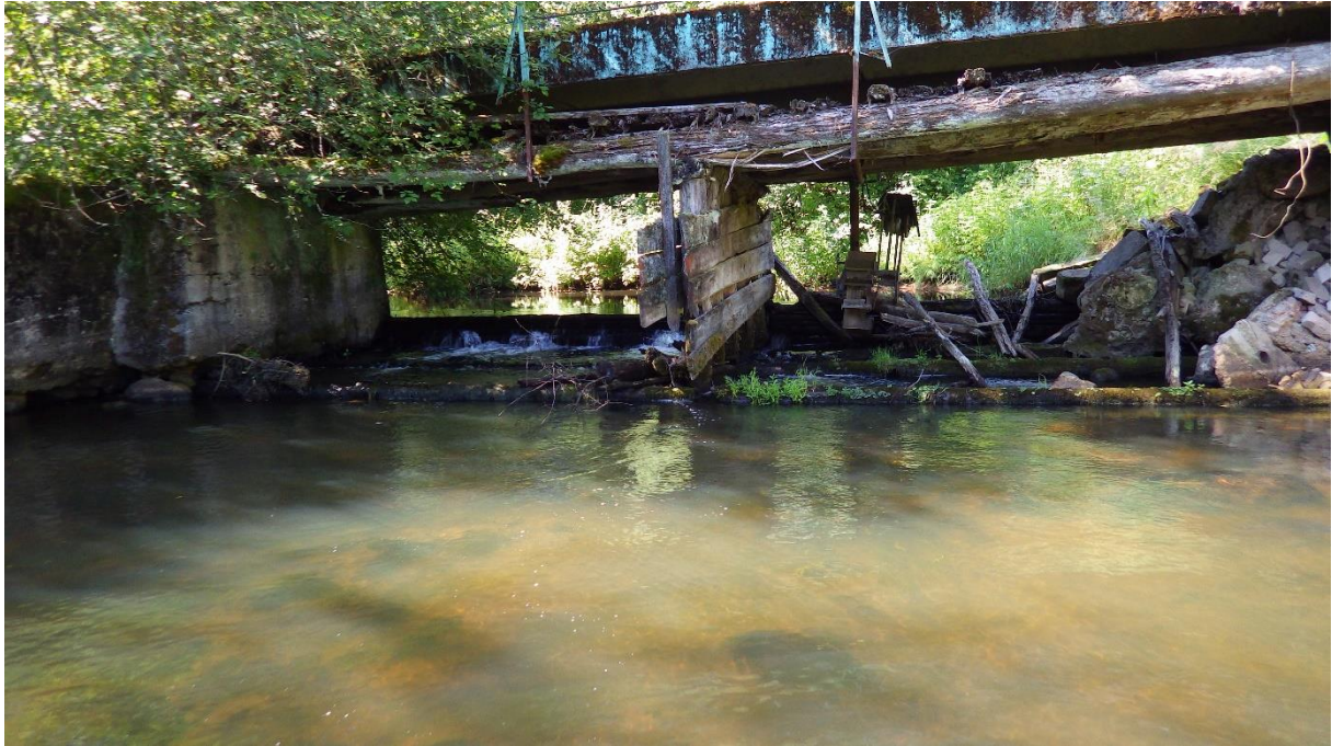
Foto 3.1.5. Rundsoveski paisu vare. Lagunenud pais tuleks likvideerida, kuna madalvee ajal on see kaladele rändetakistuseks. Paisu kohas olevaid suuri kive saaks kasutada jõe füüsilise kvaliteedi parandamiseks.
