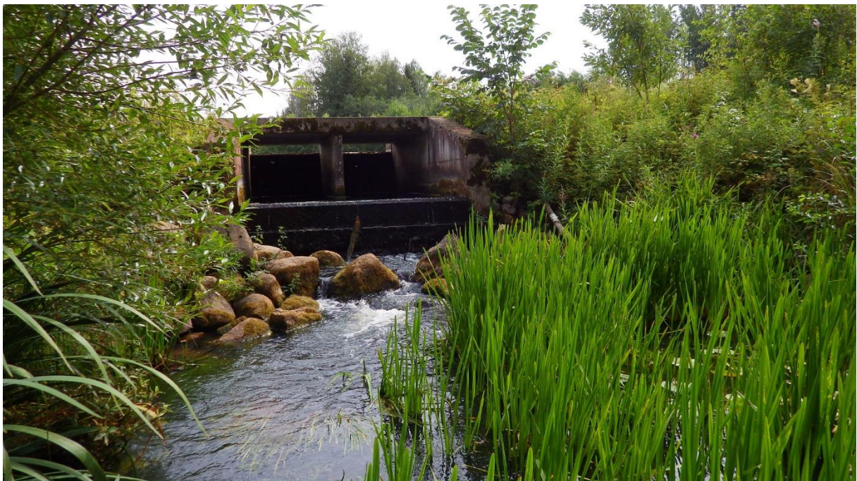
Foto 3.1.2. Elva küla all asuv Elva paisjärv. Pildil on parempoolne väljavool, mis sarnaselt vasakpoolsele on kaladele ületamatu. Veetasemete vahe on 2 meetrit.
