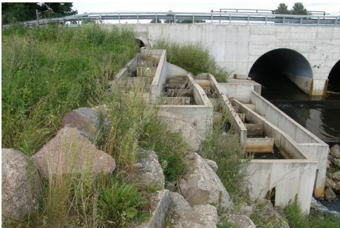
Foto 2.1.9. Sangaste paisu (65,86 km suudmest) juurde rajati 2013. a betoonist kamberkalapääs, mis aga normaalselt ei funktsioneer. Vaade kalapääsule alavee poolt (R. Pihu, 11.08.2017).
