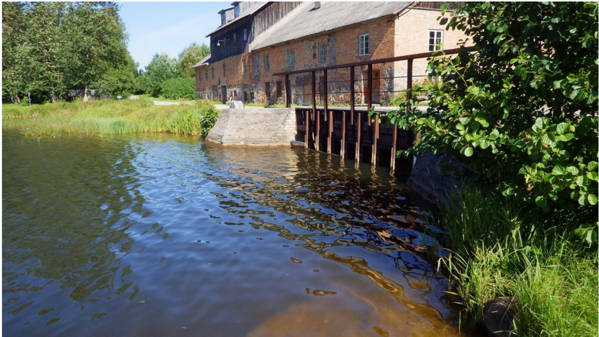
Foto 3.1.1. Hellenurme paisjärv. Paisu mõju ulatub ülesvoolu 1,7 km ning rajatis on kaladele läbimatu.
