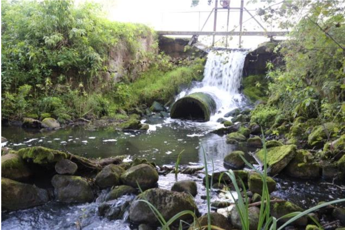
Foto 3.7.1. Voika paisjärve pais (1,19 km suudmest). Kaladele ületamatu rändetõkke kõrgus on 2,5 m.
