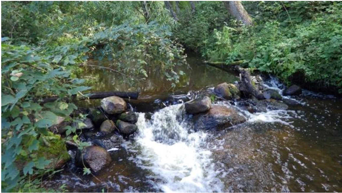
Foto 3.8.1. Maakividest paisutus 1,41 km suudmest. 0,4 m kõrgune rajatis on enamiku hüdroloogiliste tingimuste puhul forellile ületatav takistus.
