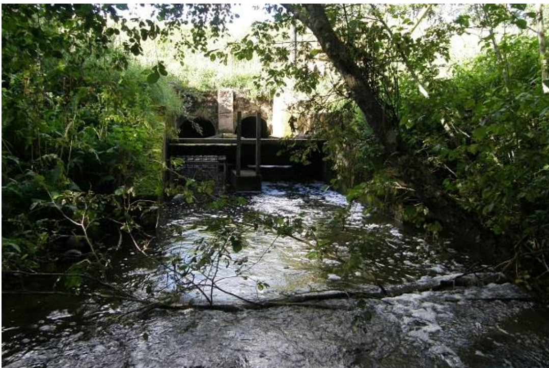
Foto 2.2.14. Suudmest 12,42 km kaugusel asub jõel Restu-Madissõ pais kõrgusega 5,1 m (R. Pihu, 15.08.2016).
