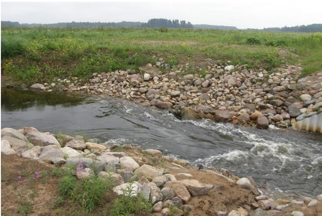
Foto 2.3.4. Lauküla–Tagula maanteest ca 10 m ülesvoolu asub tehislik kiviastang, mis välitööde ajal paisutas jõge ca 0,3 m, põhjustades ühtlasi vahetult selle all vee suure languse ja voolukiiruse \geq 1,5 m/s (R. Pihu, 02.09.2016).
