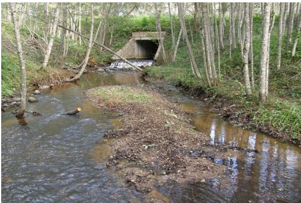
Foto 2.4.11. Antsla–Lüllemäe mnt-st (13,95 km suudmest) vahetult allavoolu jääb ca 50 m pikkune ritraalne jõelõik, mis sobib forellile kudealaks. Silla all asub pais (h 0,7 m), millele lisandub sillaaluse betoonist kaldpinna põhjustatud täiendav paisutus. Rajatise summaarne paisutus oli 1,25 m. Enamik forelli kudealadest jääb paisust ülesvoolu (R. Pihu, 15.09.2016).
