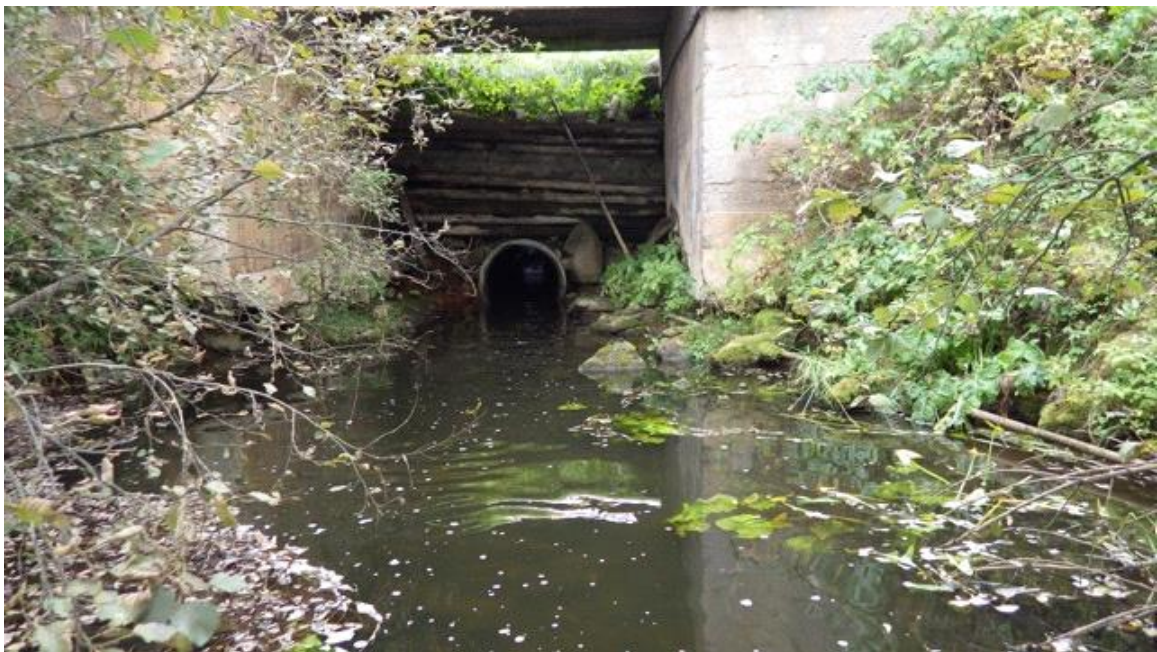
Foto 3.7.2. Viinamärdi paisjärve väljavool. Paisutuse kõrgus on 2 m ning tegemist on kaladele ületamatu rändetõkkega.
