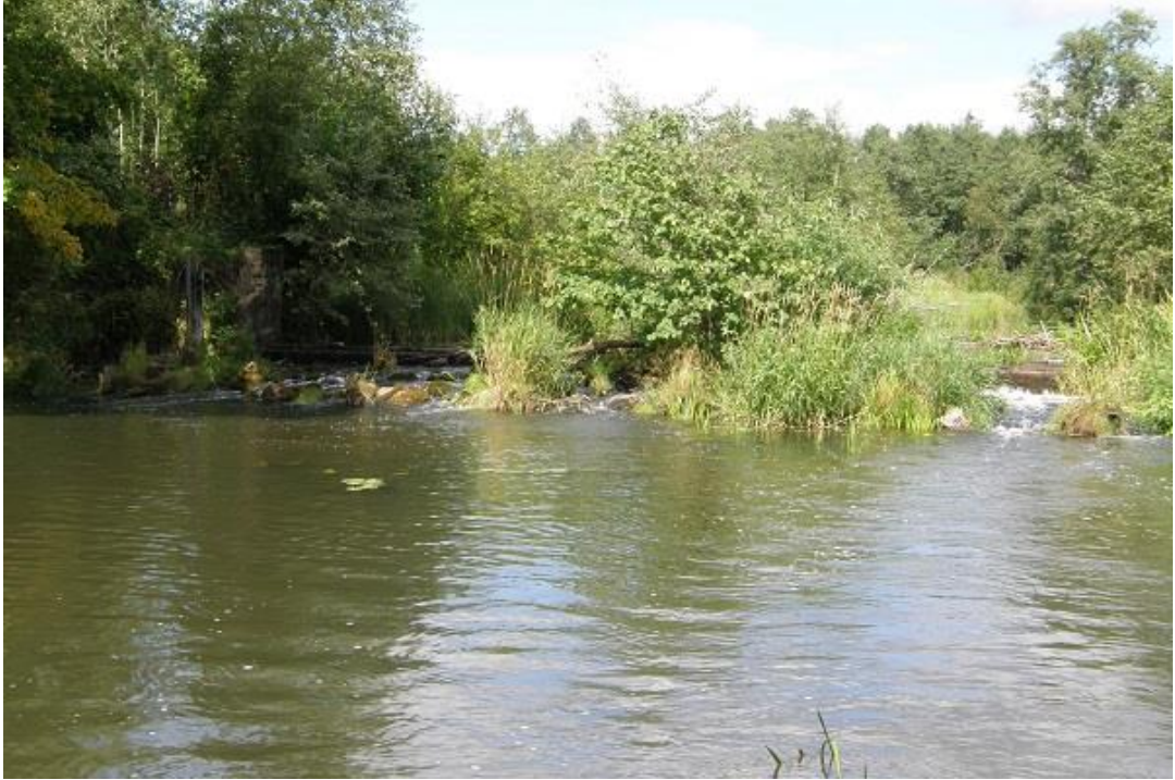
Foto 2.1.7. Sangaste villaveski paisuvare (65,10 km suudmest) põhjustab jõel 0,6 m kõrguse ja ca 0,2 km ülesvoolu ulatuva paisutuse (R. Pihu, 11.08.2017).
