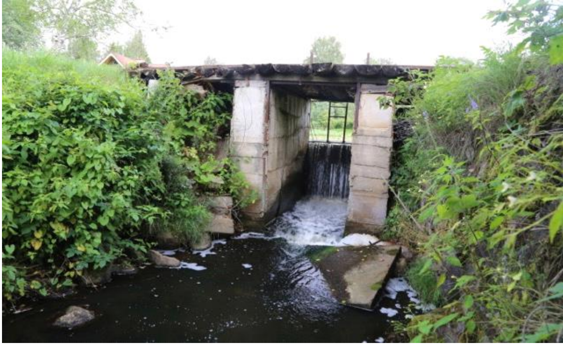
Foto 3.3.3. Üleoja (Laguja) paisjärve pais (7,45 km suudmest). Paisutus 1,5 m ning mõju ulatub ülesvoolu 650 m. Antud paisust ülesvoolu jääval ojaosal jõeforelli noorjärkudele elupaiku ega kudealaid praktiliselt ei esinenud.
