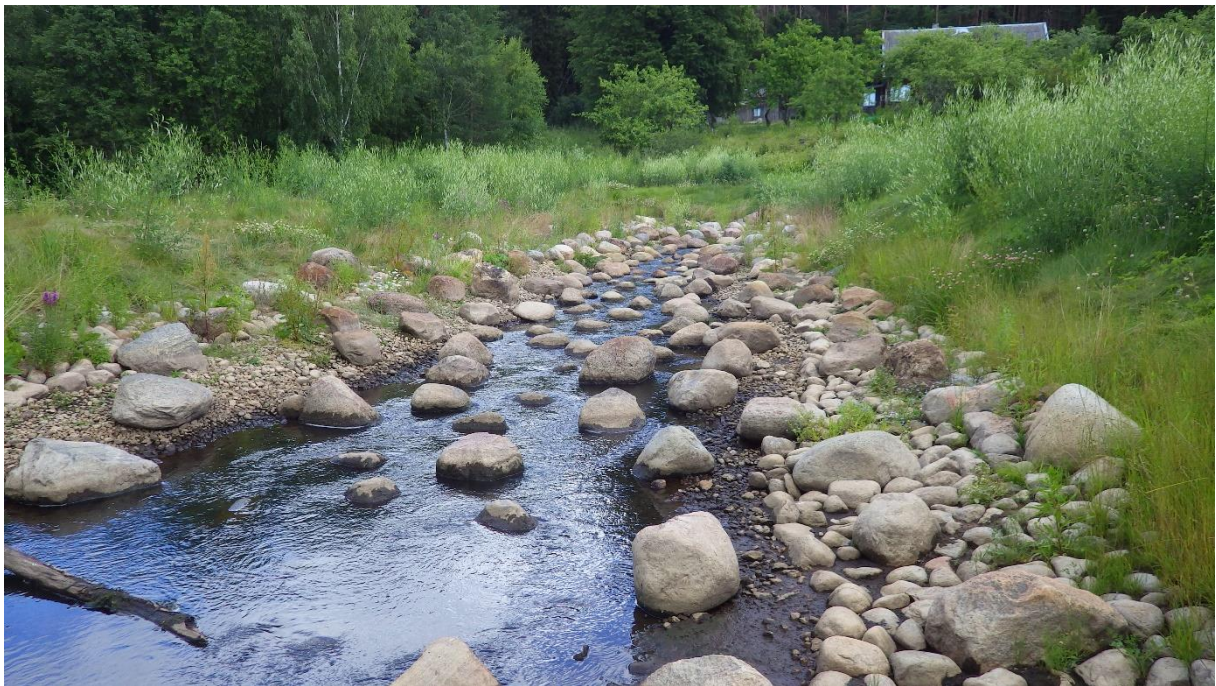
Foto 3.1.8. Looduslähedane kalapääs Tõravere paisul. Kesmiselt 3 m laiune kivine säng pakub elupaiku forelli noorjärkudele, kuid kudekohti kalapääsul napib.
