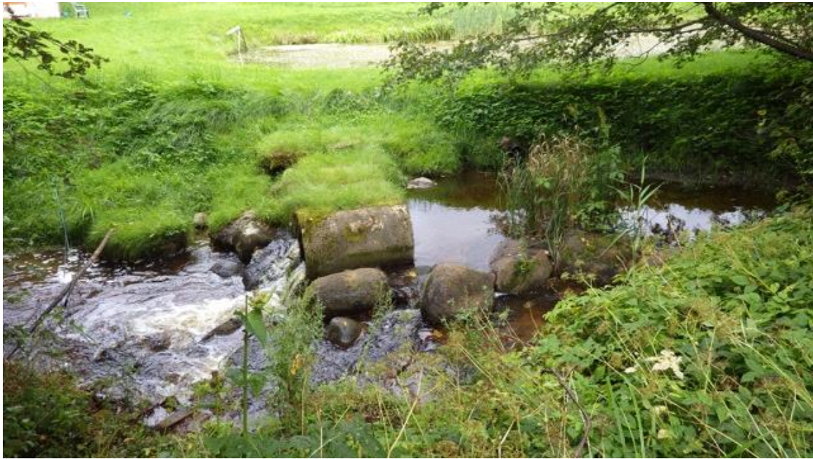
Foto 3.5.1. Illi ojal asuv väheoluline rändetõke (2,86 km suudmest). Maakividest ja torudest koosnev rajatis olulist takistust ülesvoolu rändel ei kujuta (möödavool vasakult). Samuti ei esine ülesvoolu olulisi kudealasisid.
