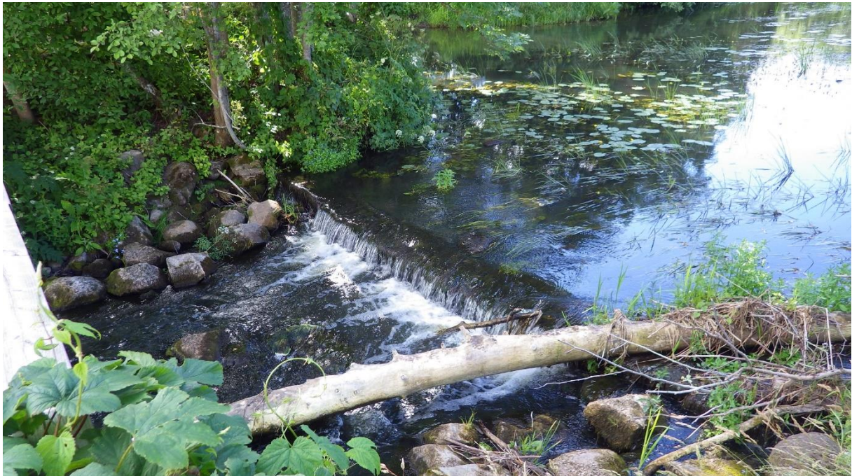
Foto 3.1.4. Mosina vesiveski kohal olev betoonist astang. Tegemist on väheolulise rändetõkkega.
