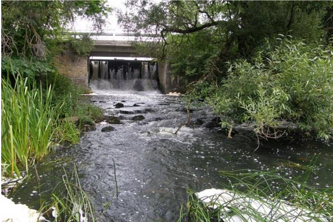
Foto 2.1.13. Restu pais kaugusega 73,65 km suudmest on Väikese Emajõe forelliasurkonna jaoks kõige probleemsem tõkestusrajatis. Paisu kõrgus on 4,2 m. Normaalselt toimiva kalapääsu rajamine pole maakasutusest tulenevalt tõenäoliselt reaalne (R. Pihu, 01.09.2017).
