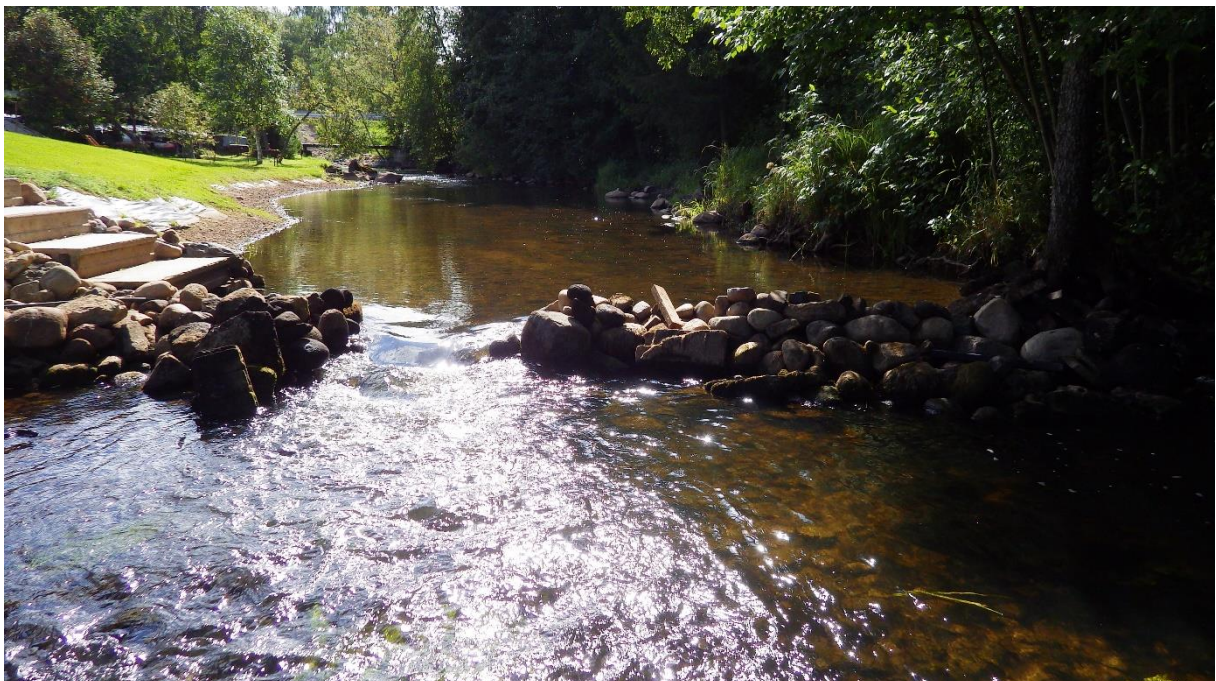
Foto 3.1.6. Foto 1-6. Hellenurme külas, 47,52 km suudmest, asuv kivipuistepais. Kuna paisu keskelt oli läbivool, loeti see väheoluliseks rändetõkkeks. Taolisi kalade rännet tõkestavaid paisutusrajatisi ei tohiks siiski jõgedel olla.
