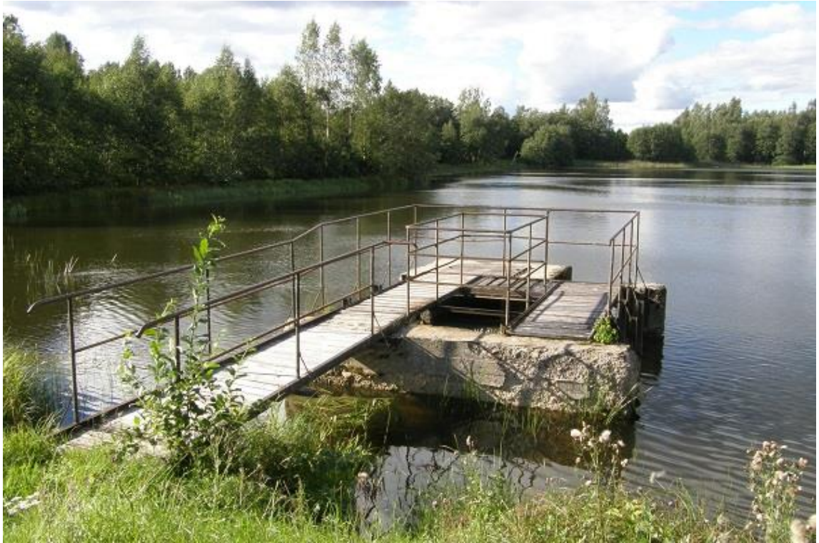
Foto 2.2.15. Restu–Madissõ pais on konstruktsioonilt betoonist šahtveelase. Paisjärve pindala on 61,5 ha. Paisjärve kasutatakse kalakasvandusena ja see lastakse igal sügisel alla (R. Pihu, 15.08.2016).
