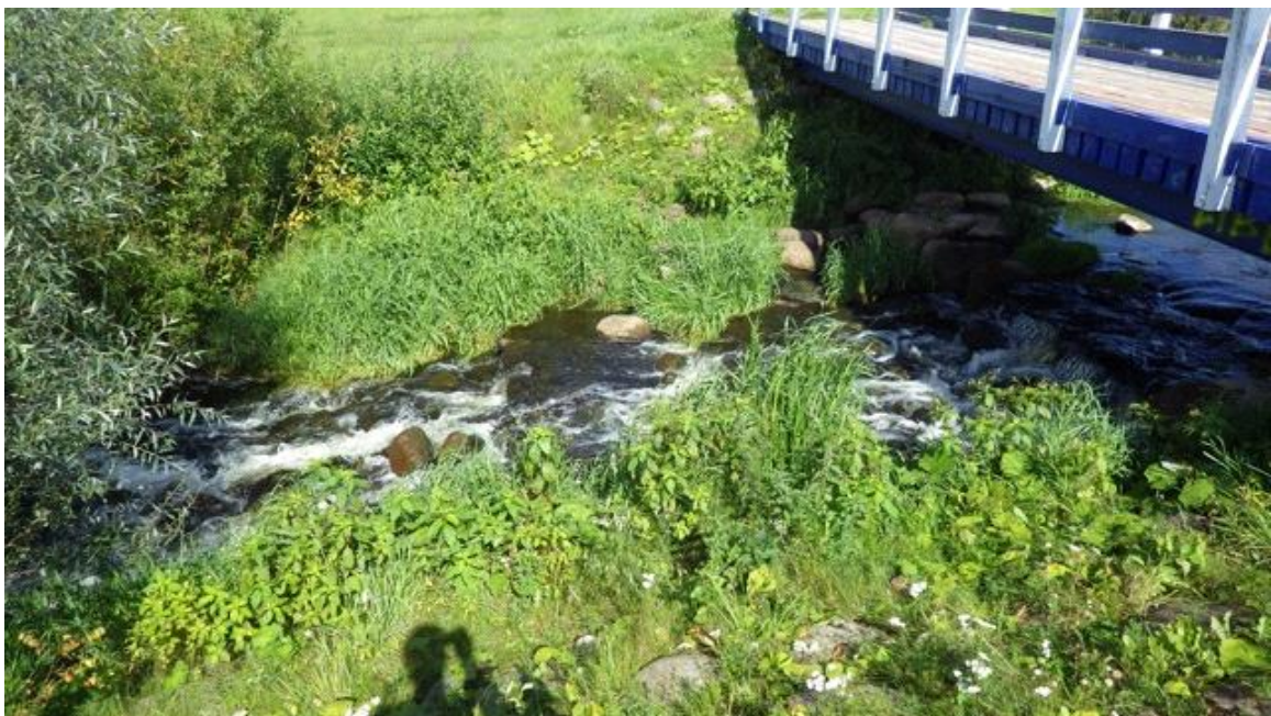
Foto 3.8.2. Nõo Veski järve väljavool (4,71 km suudmest) on kujundatud looduslähedaseks kärestikuks, mis on kaladele läbitav.
