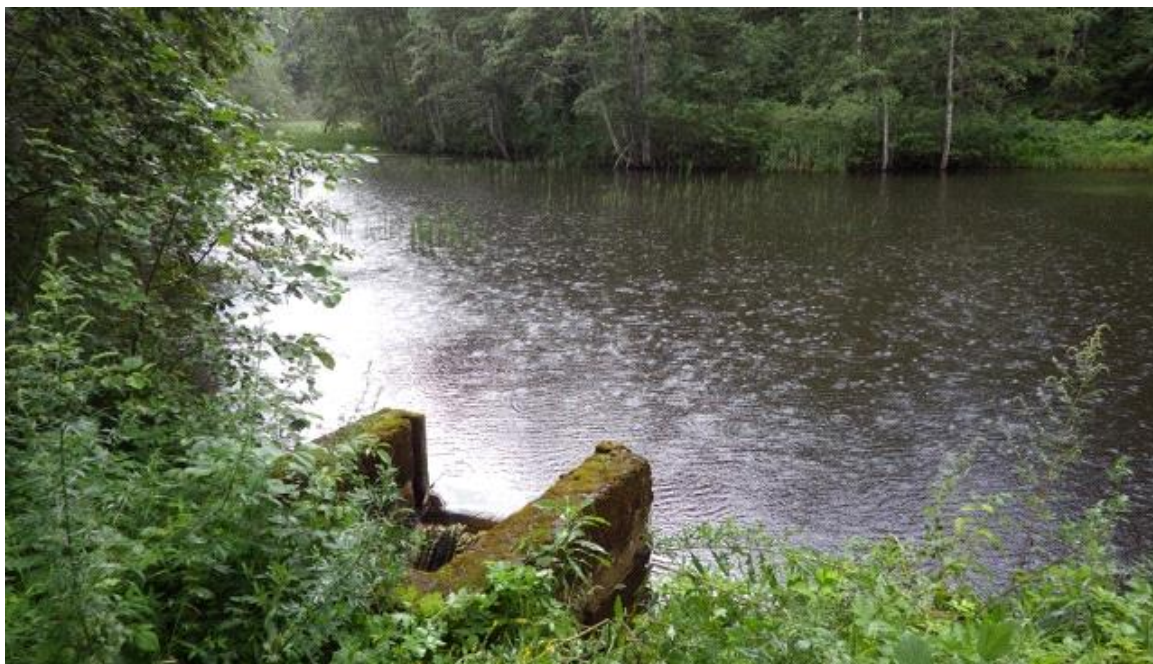
Foto 3.4.1. Ilusa oja alamjooksul (250 m suudmest) asub paisjärv, paisutuse mõju ulatub pikalt ülesvoolu ligikaudu 2 km. Paisu kõrgus on 1,4 m ning rajatis on kaladele ületamatuks rändetõkkeks.
