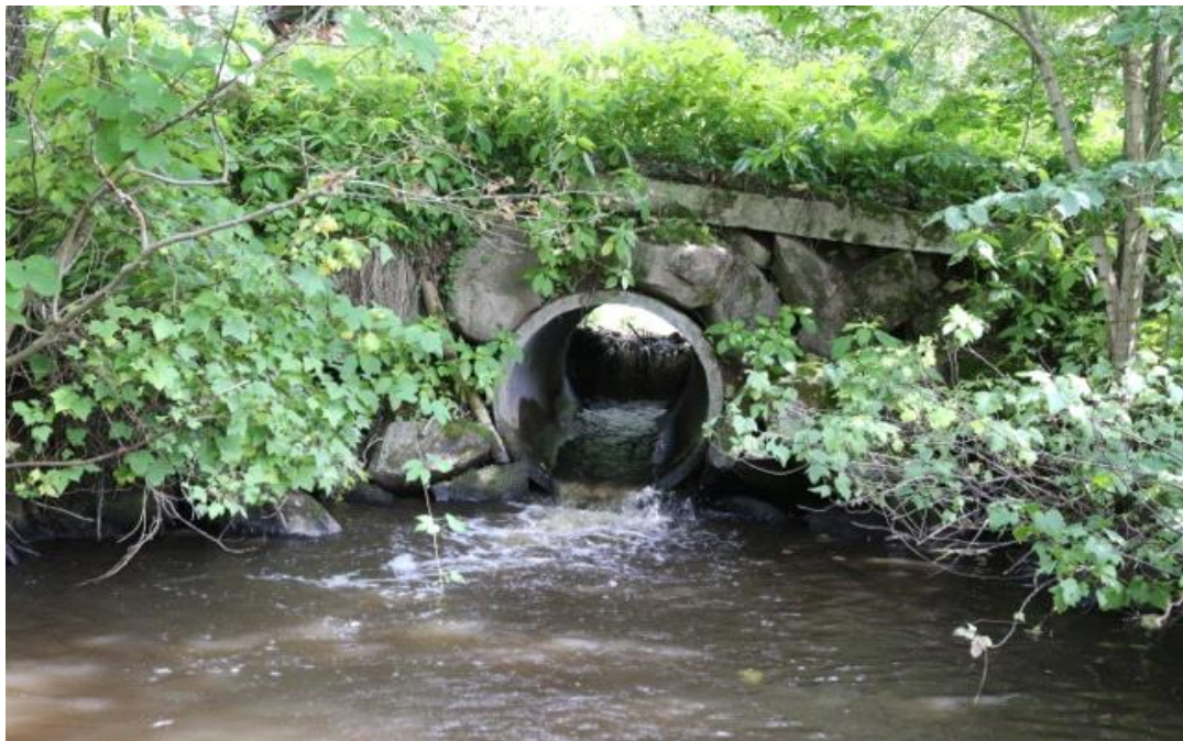
Foto 3.3.2. Teetruup Lipardi talu juures (6,92 km suudmest), paisutuse kõrgus oli 0,9 m ning mõju ulatus ülesvoolu 160 m. Paisutatud ojaosa on kasutusel veiste jootmiskohana.
