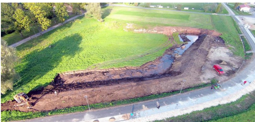
Joonis 22. Viljandi järvemuda tahendamiseks kasutatud settetiik [43]
