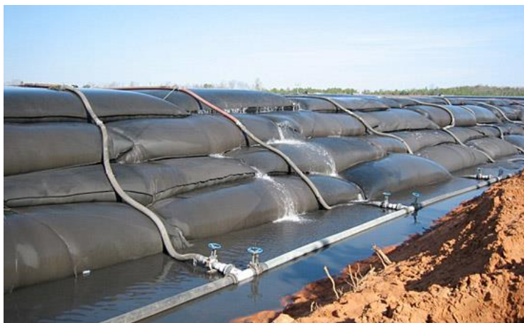
Joonis 18. Geokottide kasutamine kaitsevalli vahel [29]
