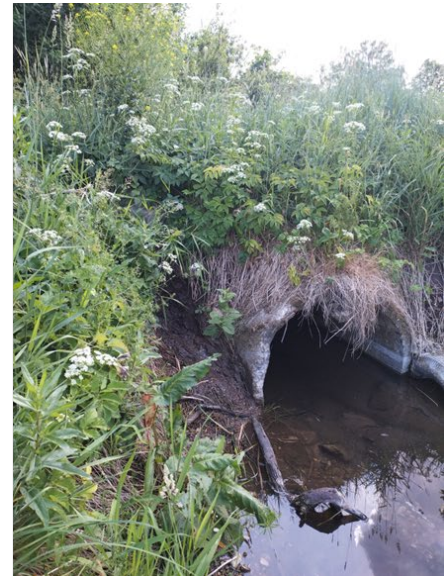
Joonis 9. Tõenäoliselt kobraсте tegevuse tagajärjel ummistunud truup (paremal vaade ülesvoolu, vasakul vaade allavoolu) Paekna paisust ca 330 m allavoolu (foto: Vallo Kõrgmaa)
