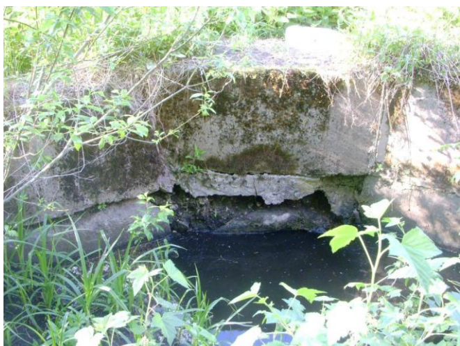
Foto 9. Järveotsa oja suubumisel Astangu tänava ummistunud truupi
