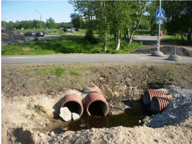
Foto 4. Järveotsa oja kergliiklustee aluse trubi väljavool
