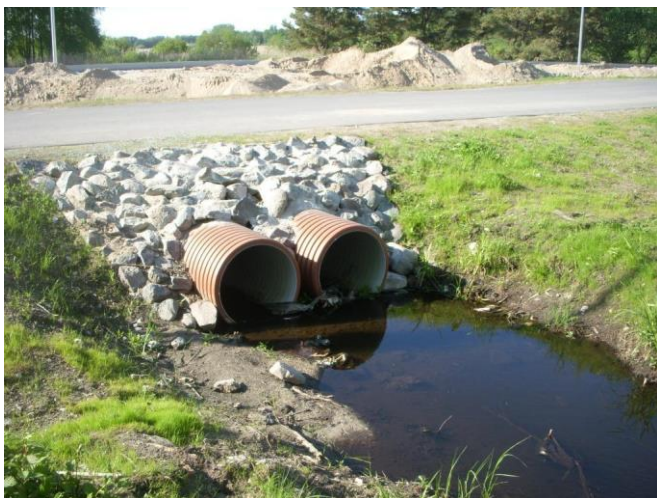
Foto 5. Järveotsa oja kergliiklustee aluse trubi sissevool
