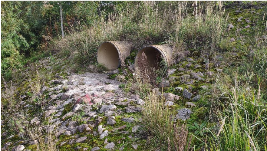
Foto 3 Järvest väljavoolu binokkeltruubi suue (24.09.2019)
