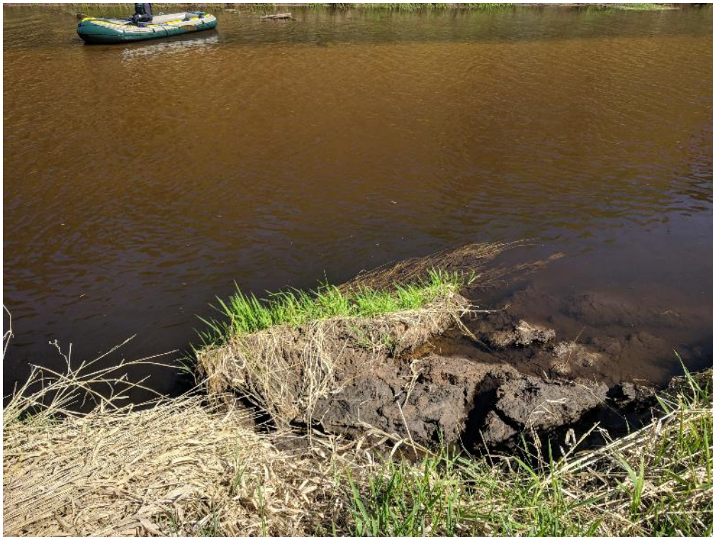
Foto 2 Jõe paremkalda deformatsioon profiili nr 14 juures
