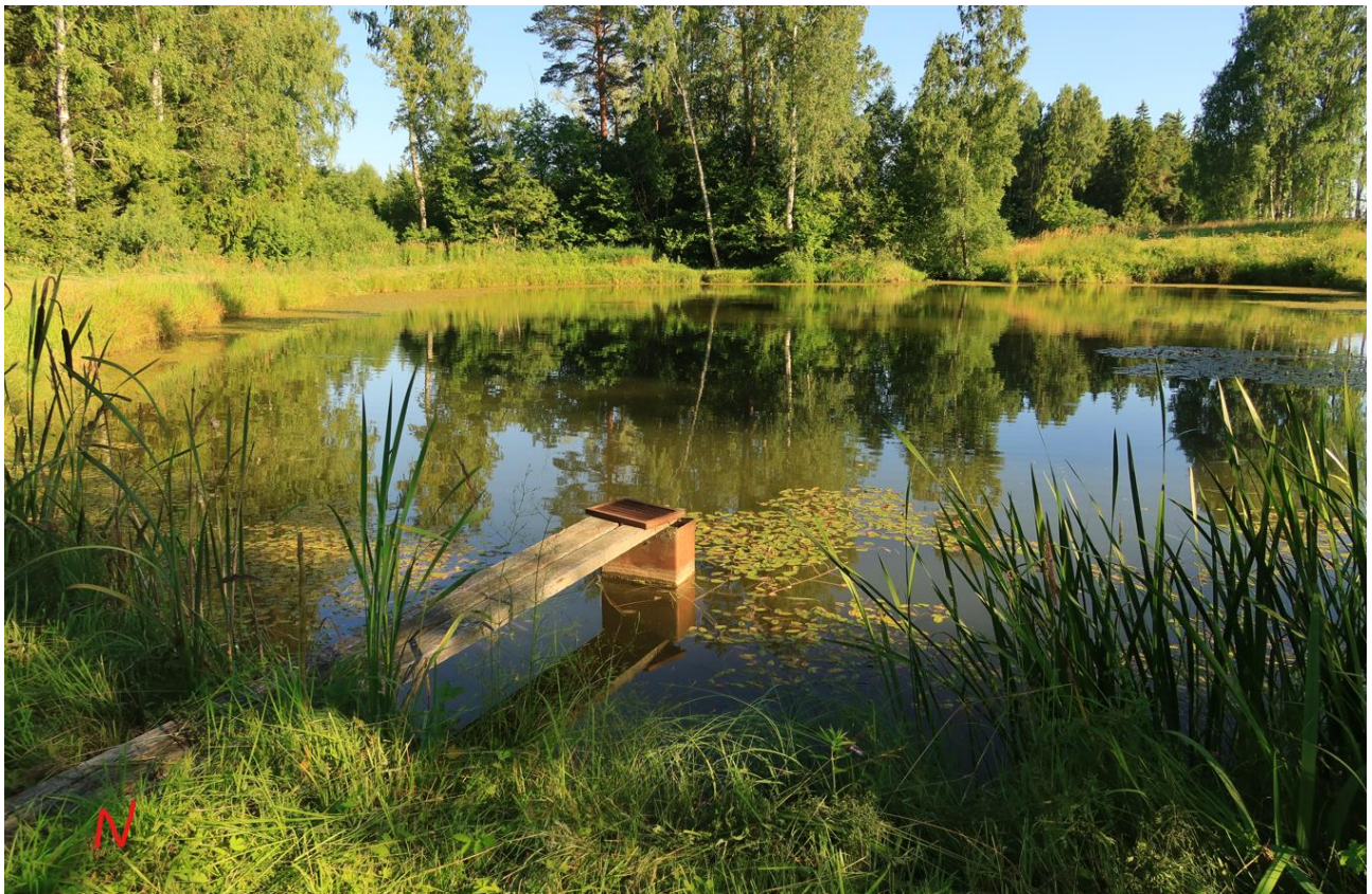
11. Samasugune pais, nagu punktis 10. Võre oli ees, vesi nirises sisse ja alavee poolel torust välja. Paisutuskõrgus oli kindlasti üle meetri:
