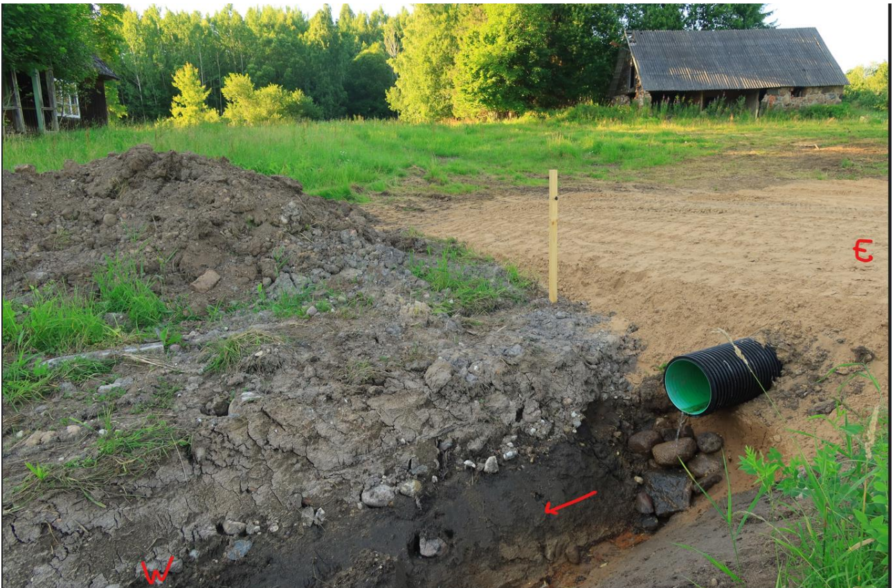
18. Värskest paigaldatud truup. Veidi vett nirises läbi:
