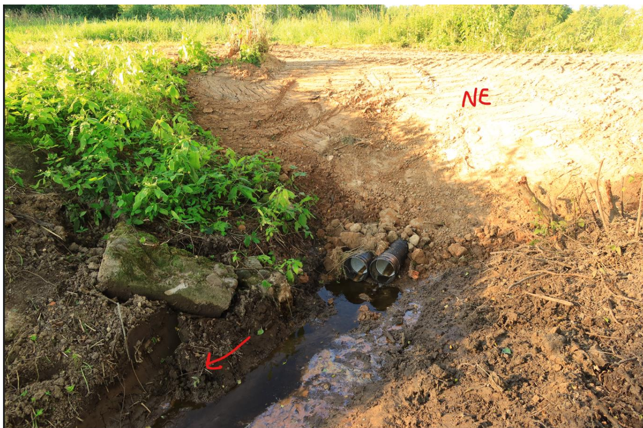
19. Värskelt paigaldatud kaks truubitoru. Ühest nirises vesi välja:
