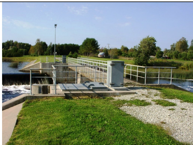
Pilt 2 Vaskjala paisu parempoolne regulaator
