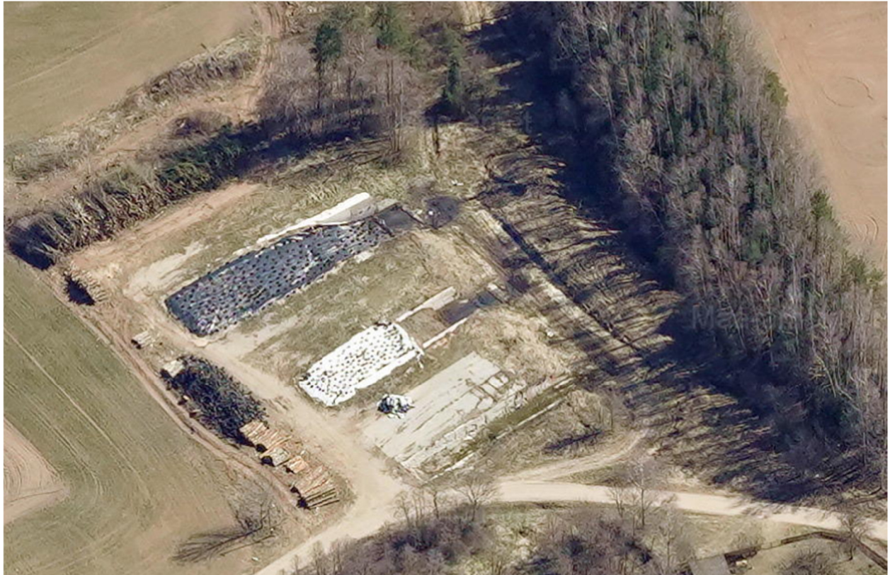
Foto 5. Peri POÜ veisefarmi silohoidlad Siloaugu katastriüksusel (kü tunnus 61903:001:0024) (Maa-ameti Fotoladu, pildistamise aeg 15.04.2019)
