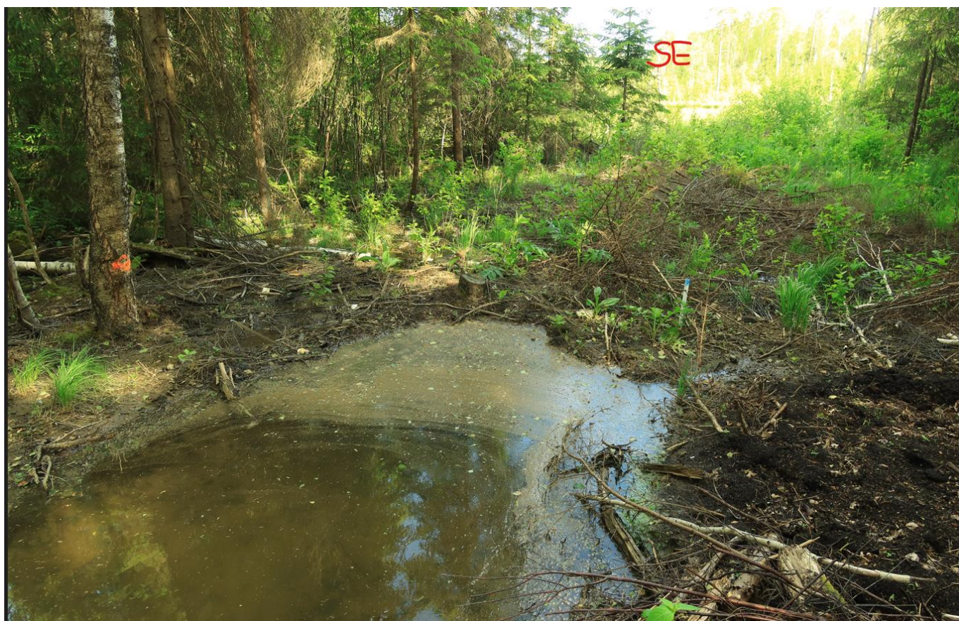
47. Uus kraav lõpeb täpselt Haukajärve kalda piiranguvööndi piiril. Vaatluse ajal olnud veetaseme juures vesi nähtavalt edasi ei voolanud, kuid maapind kuni järve õõtsikuni oli kohati märg ning oli märke, et umbkraavist on vesi üle voolanud:
