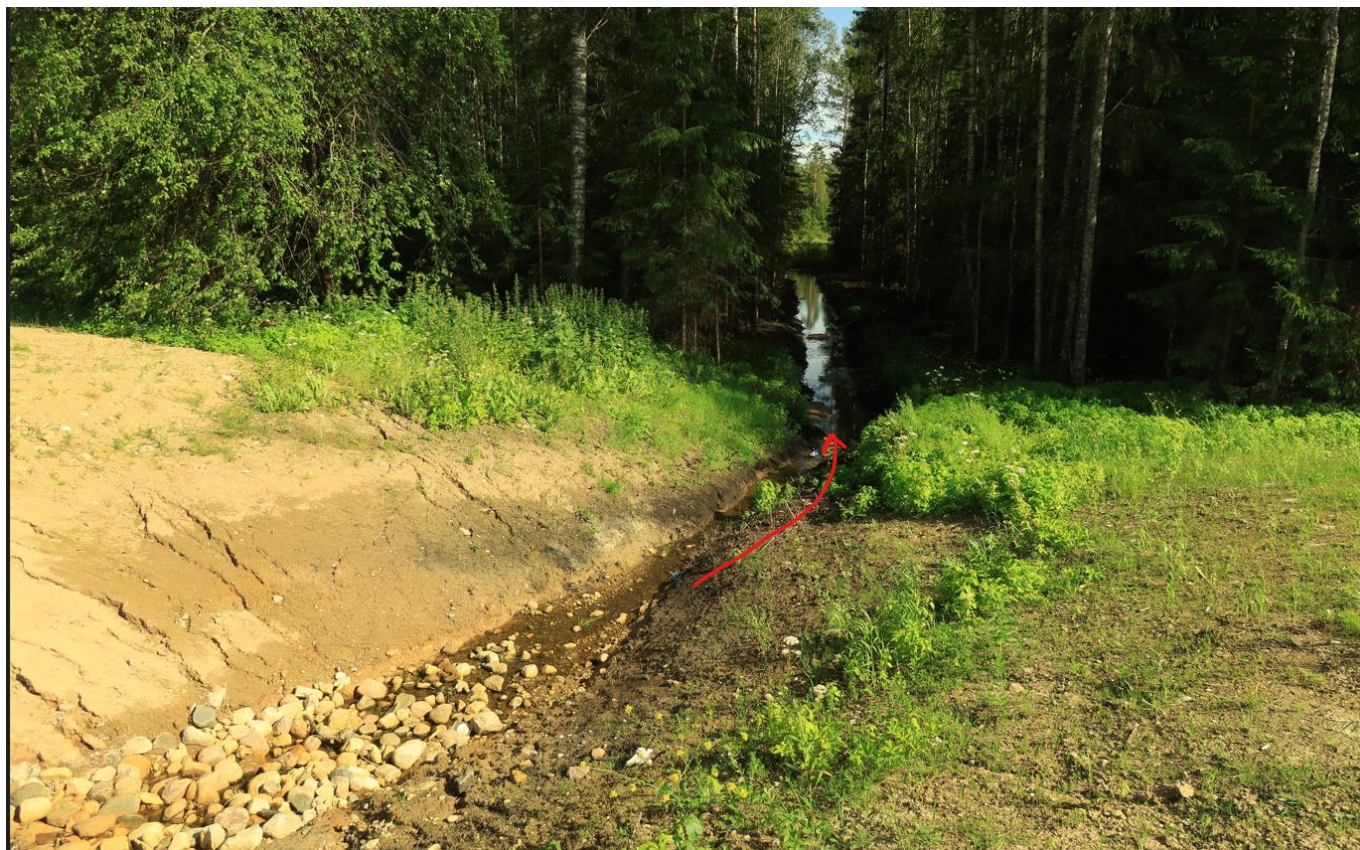
47. Uus kraav lõpeb täpselt Haukajärve kalda piiranguvööndi piiril. Vaatluse ajal olnud veetaseme juures vesi nähtavalt edasi ei voolanud, kuid maapind kuni järve õõtsikuni oli kohati märg ning oli märke, et umbkraavist on vesi üle voolanud:
