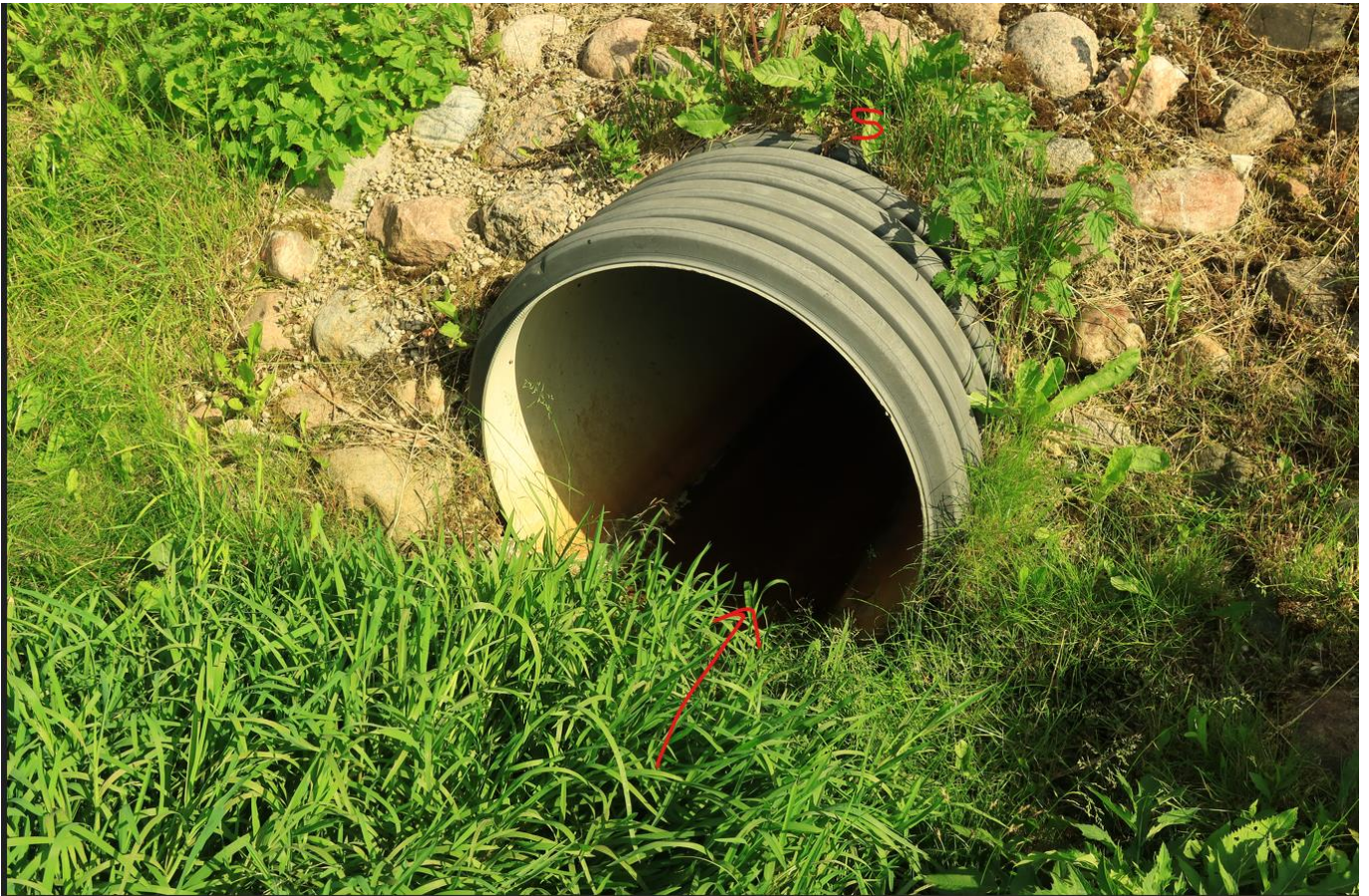
43. Värskelt kaevatud kraavil olev truup. Vesi nirises läbi:
