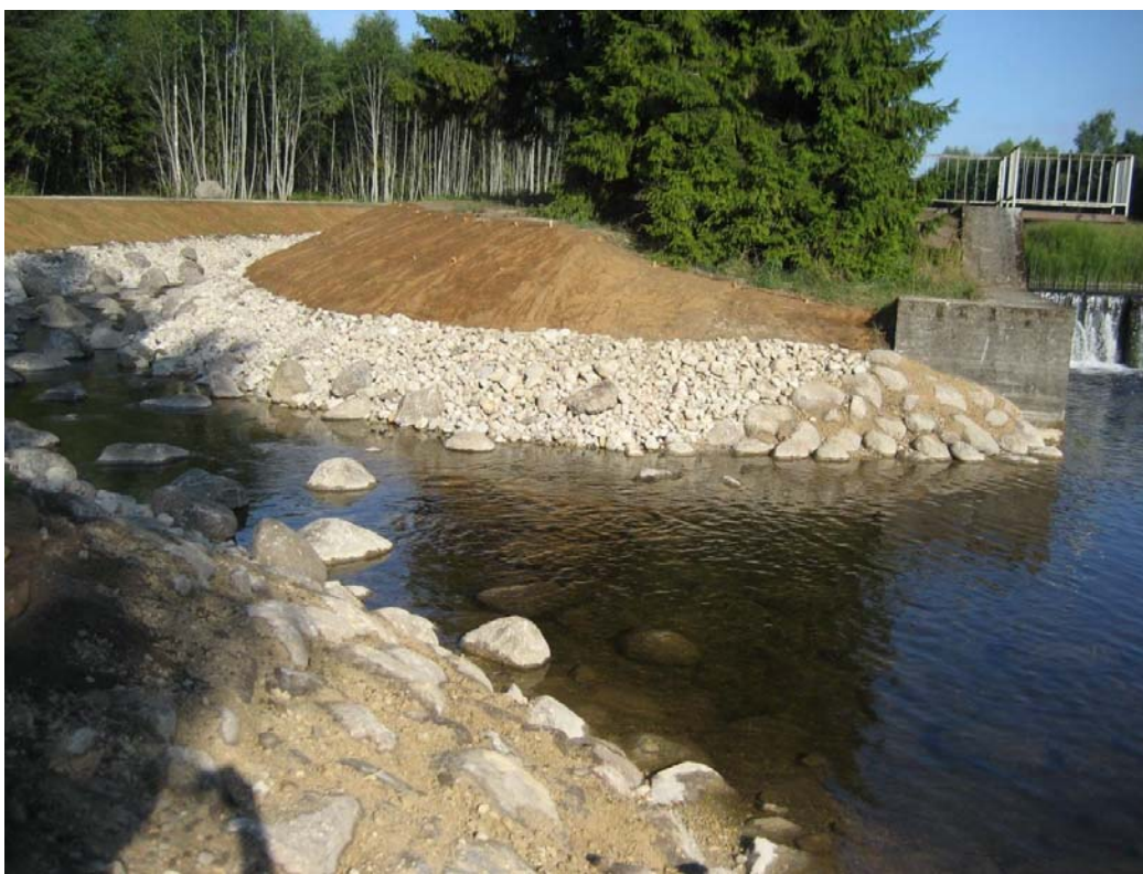
Foto 3. Kalapääsu väljavool (sissepääs)
