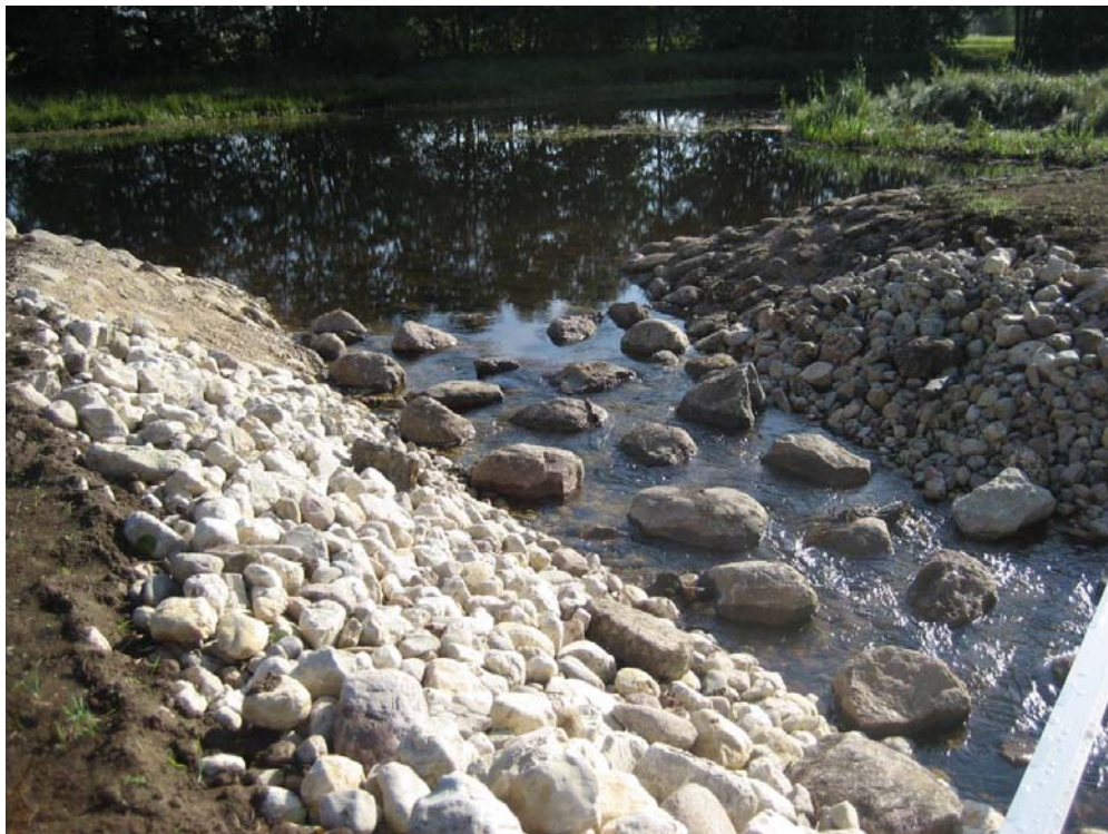
Foto 1. Kalapääsu sissevool (väljapääs)
