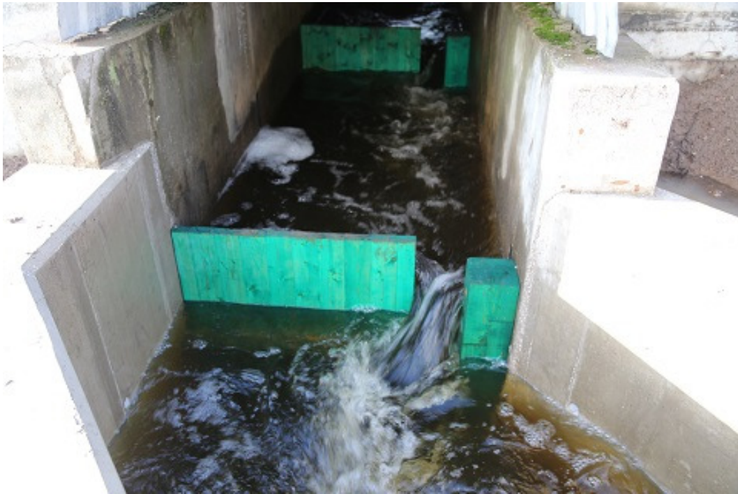
Foto 3. Pilukalapääs. Siin muutuvad piludes vee voolukiirused kriitiliseks, kui kalapääsu pääseb liiga palju vett (=paisjärve veepind on kõrgem projekteeritud NVT-st) (R.Järvekül, 08.11.2013).
