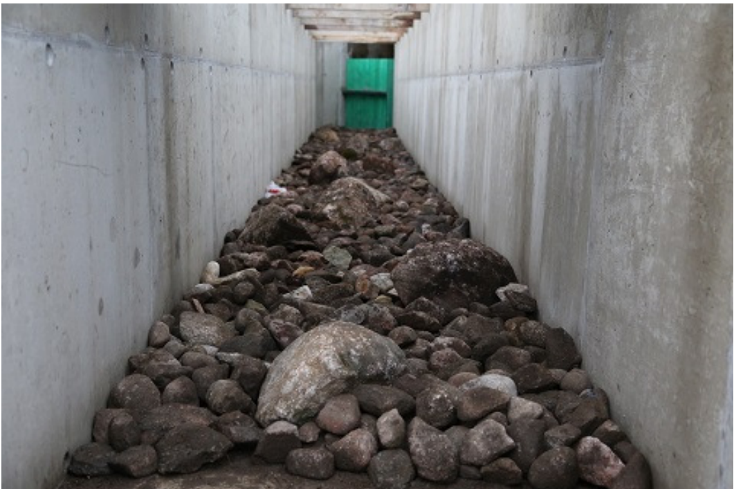
Foto 6. 0-languga betoonkanal enne vee sisselaskmist. Põhi on kividega tehtud kaladele võimalikult atraktiivseks ja varjet pakkuvaks. Tegelikult oleks võinud selle 0-languga kanali asemel pikendada nii pilukalapääsu kui ka basseinide kaskaadi osa ja vähendada sellega nende mõlema langu. Aga vahel lähevad asjad nagu nad lähevad (R.Järvekülg, 09.10.2013).
