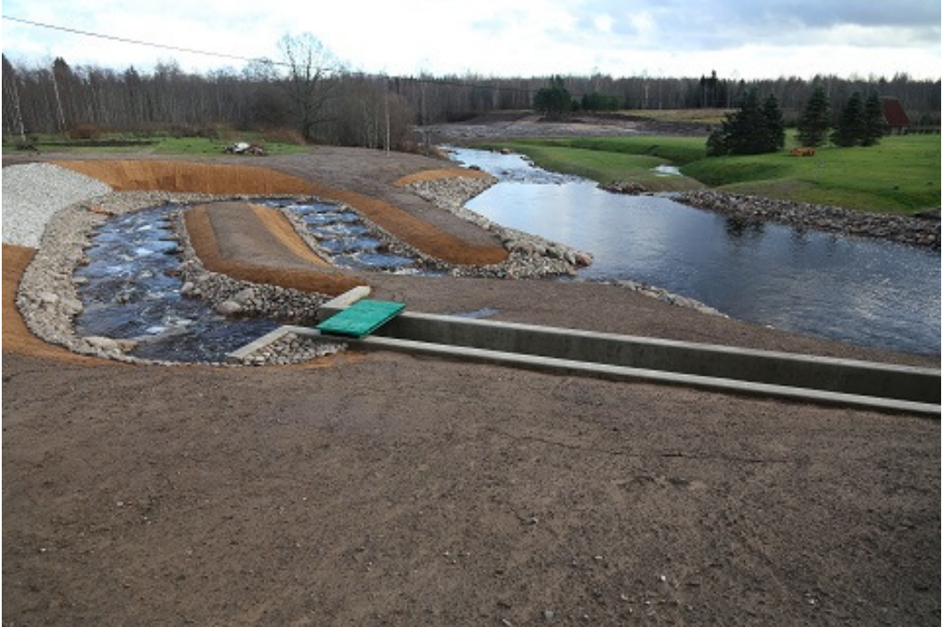
Foto 5. Paisust allavoolu jääv kalapääsu osa. 0-languga betoonkanal ja sellele järgnev loodusilmeline basseinide kaskaad (R.Järvekülg, 08.11.2013).
