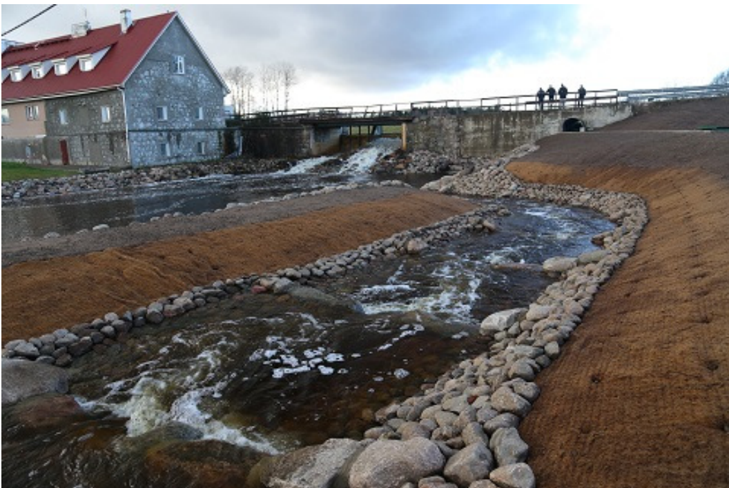
Foto 8. Vaade kalapääsu alaveepoolsele osale ja paisule. Kõik tööd olid ehitaja poolt tehtud korralikult. Seda nii kaugelt kui lähedalt vaadates ja uurides (R.Järvekül, 08.11.2013).
