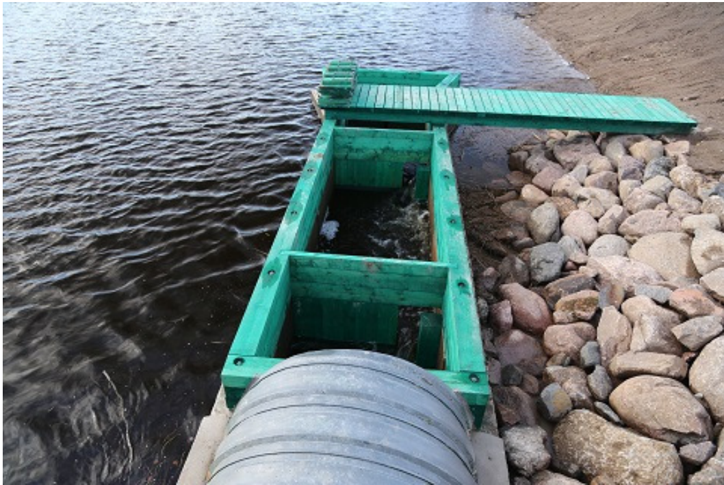
Foto 1. Kalapääsu sissevool. Betoonkambritele on kõrgenduseks pandud puitrakendus, mis aitab tõkestada liigse vee pääsuemist kalapääsu suurvee ajal, kui paisjärve veetasel ei pruugi olla võimalik hoida projekteeritud normaalveetaseme lähedal (R.Järvekül, 08.11.2013).
