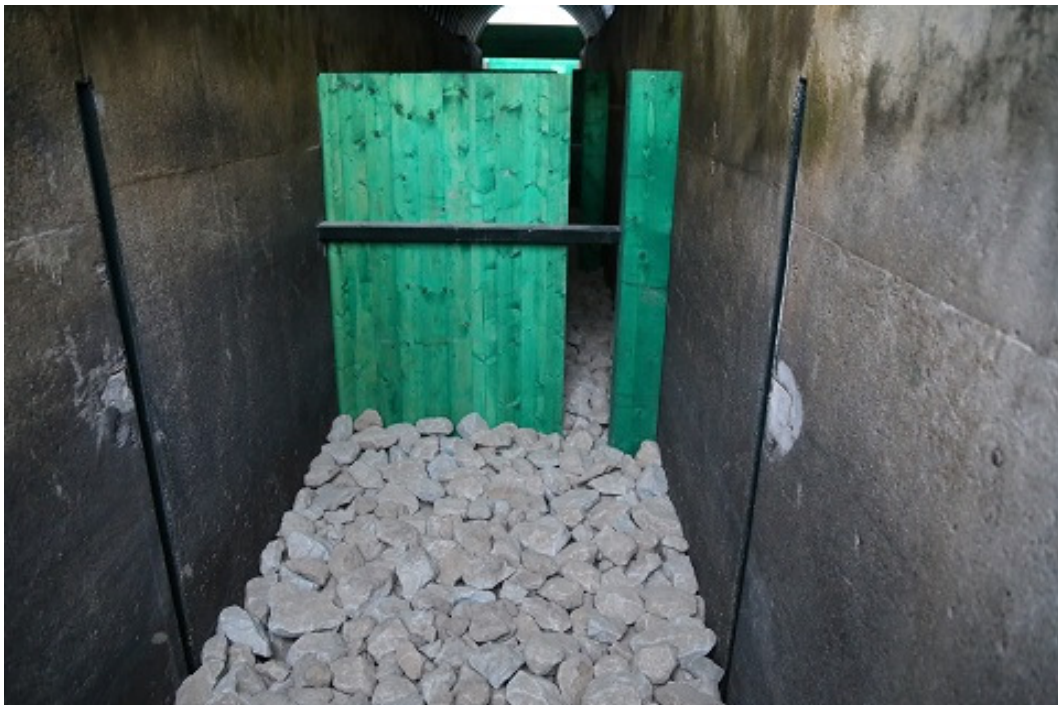
Foto 4. Pilukalapääsu osa enne vee sisselaskmist. Hiljem lisati igasse kambrisse ka kaks suuremat kivi. Kaladele meeldib ikka kuhugi varjuda, lisaks on kivide ümber sättimisega hiljem võimalik muuta hüdraulilisi tingimusi kambrites (R. Järvekül, 09.10.2013).
