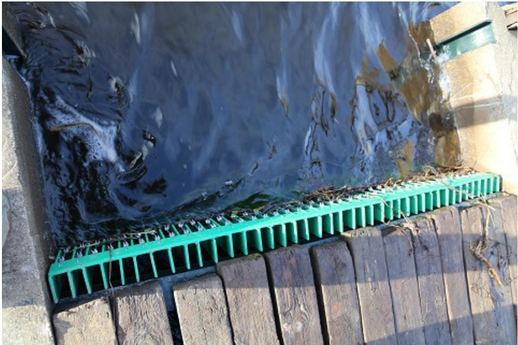
Foto 9. Turbiini sissevoolule on pandud võre, mille avad on algselt olnud 4–4,5 cm. Trosside vahele pingutamiseks on võre muudetud üle 2 korra tihedamaks, ... pole kindel, kas selline „rats“ ka tegelikult kaitseb kalu turbiini sattumast (R.Järvekülg, 08.11.2013).
