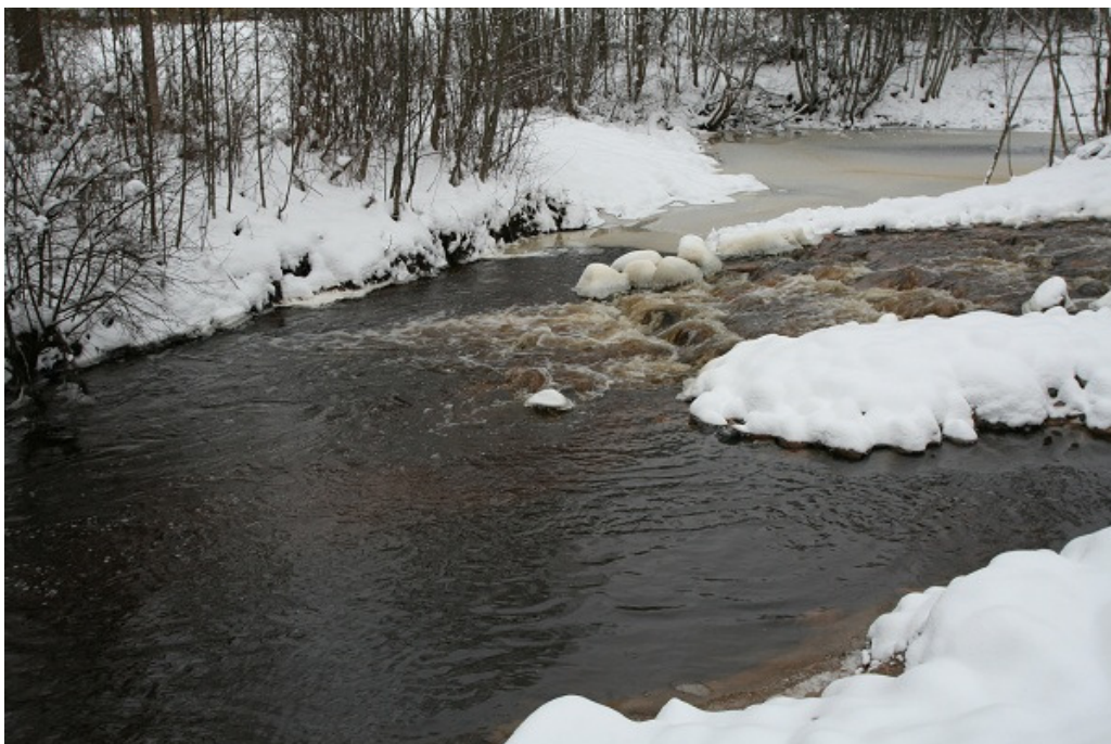
Foto 10. Kuna veetasemete vahe 8. kiviläbivoolu juures (viimane veeaste kivivallide vahel) tundus võrdlemisi järsk, siis tuleb ilmselt madalvee saabudes kohendada 9., 10. ja 11. kiviläbivoolu, mis asuvad jões allpool kalapääsu, liigveelasu ja veskikanali ühinemist ning olid vaatluspäeval kõrge alaveetaseme tõttu uputatud (R. Järvekülg, 05.12.2012).
