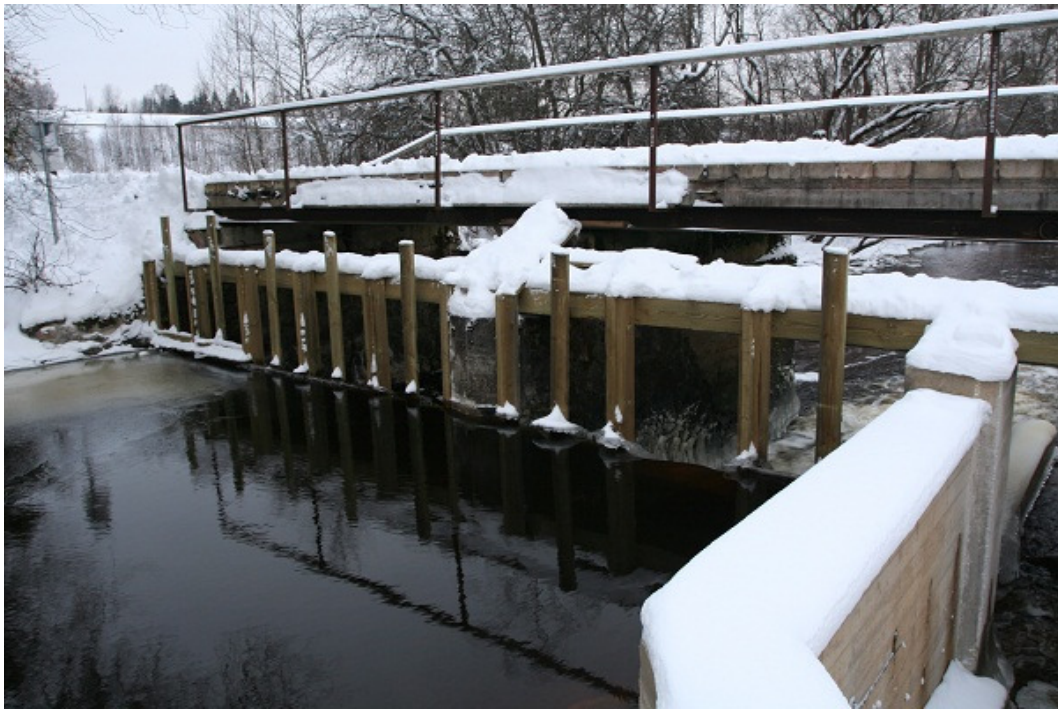
Foto 3. Sänna mäeveski pais 05.12.2012. Ülaveetase paisu juures oli madal ning kalapääsu pääses seetõttu liiga vähe vett. Kuna mõõdulatti paisul pole, siis saab ülaveetaseme reguleerimisel juhinduda vaid „kõhutundest“ ... (R. Järvekül).
