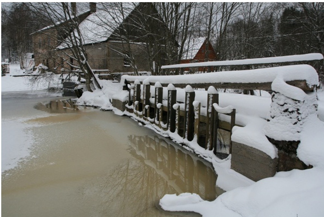
Foto 8. Paisu juures puudub mõõdulatt, millest ülavee taseme hoidmisel juhinduda (R. Järvekülg, 05.12.2012).
