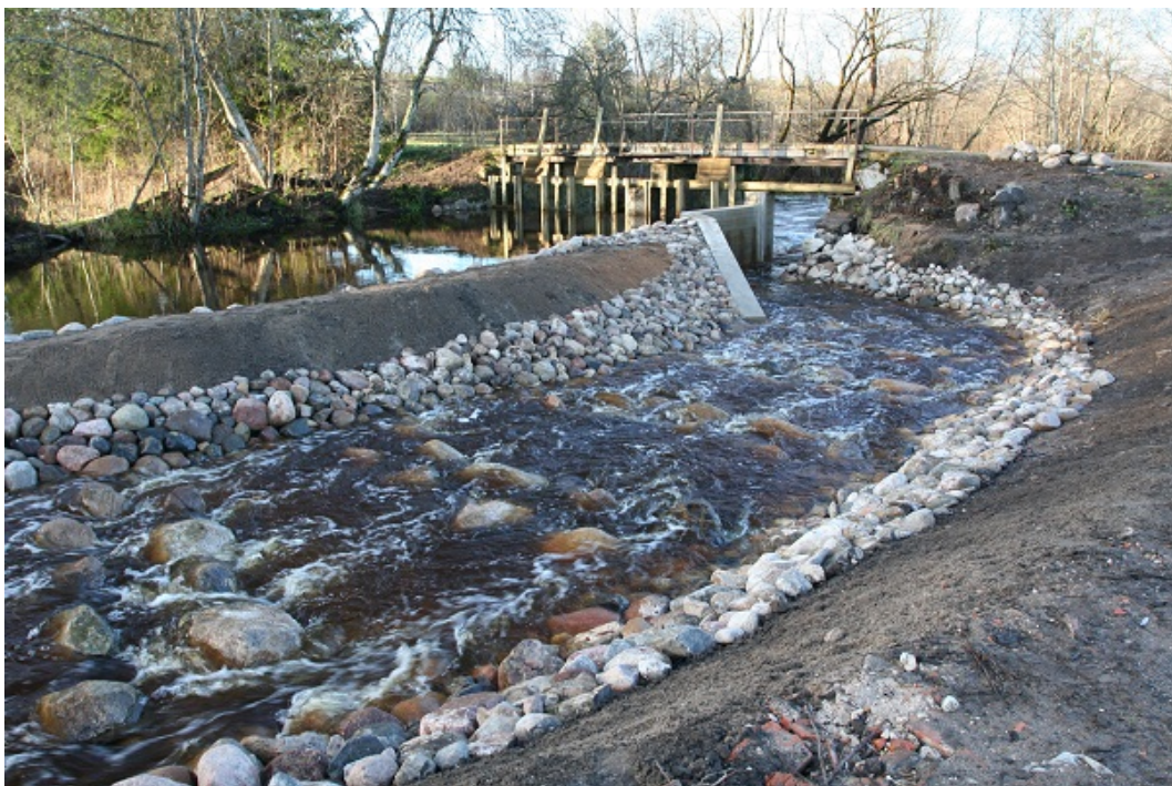
Foto 2. Sänna mäeveski kalapääs. Vaade ülavee poolelt paisu suunas (07.11.2012, R. Järvekülg).
