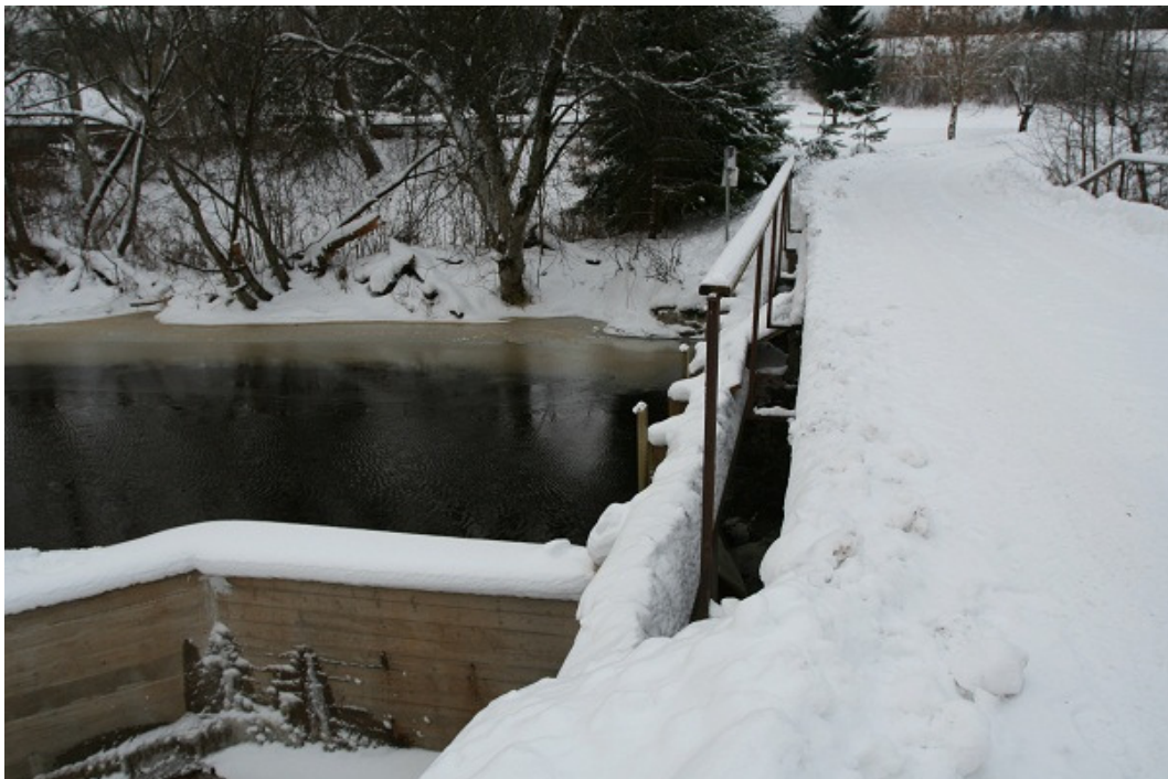
Foto 4. ... samas pole varjade lisamine/eemaldamine talvel paisu juures reaalselt teostatav. Turnimine mööda jää ja lumega kaetud prussi lõpeks üsna pea vette kukkumisega. Silla käsipuud tugevamat toetamist ei kannata (R. Järvekül).
