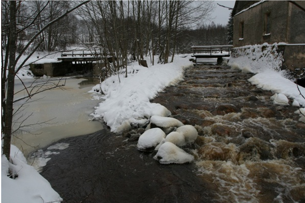
Foto 7. Kaugu pais 05.12.2012. Kuigi jõe vooluhulk oli suur, läbis praktiliselt kogu jõe vesi kalapääsu. Liigveelasust (fotol vasakul) läbivool praktiliselt puudus (R. Järvekülg).
