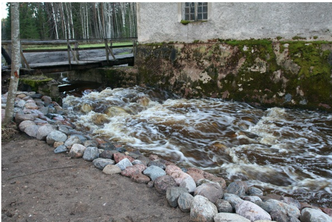
Foto 6. Kuna paisu ülaveetase oli kõrge, siis pääses kalapääsu liiga palju vett ja hüdraulilised tingimused kalapääsus olid kalade jaoks ebasobivad (R. Järvekülg, 07.11.2012).
