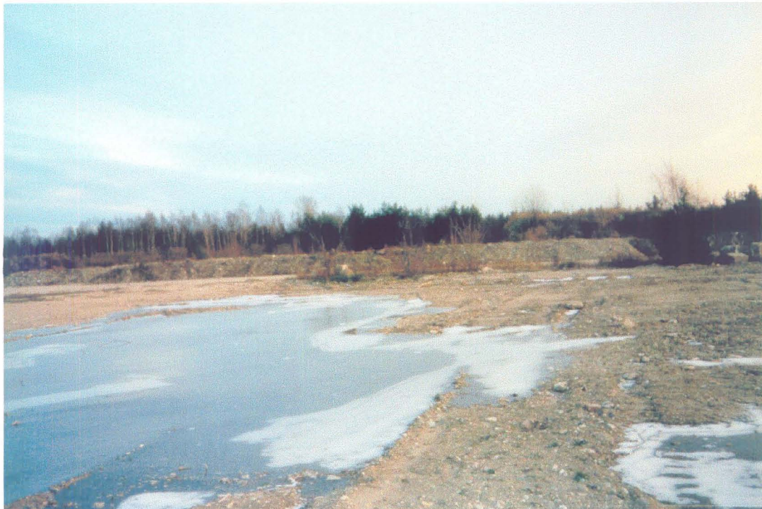
Foto 7. Suurte mahutite alt välja kaevatud tugevalt reostunud pinnas paigutati reostuskoha kõrvale betoonist alusega platsile aunadesse. Fotograaf T. Meriste. Foto kuupäev 10.11.98
