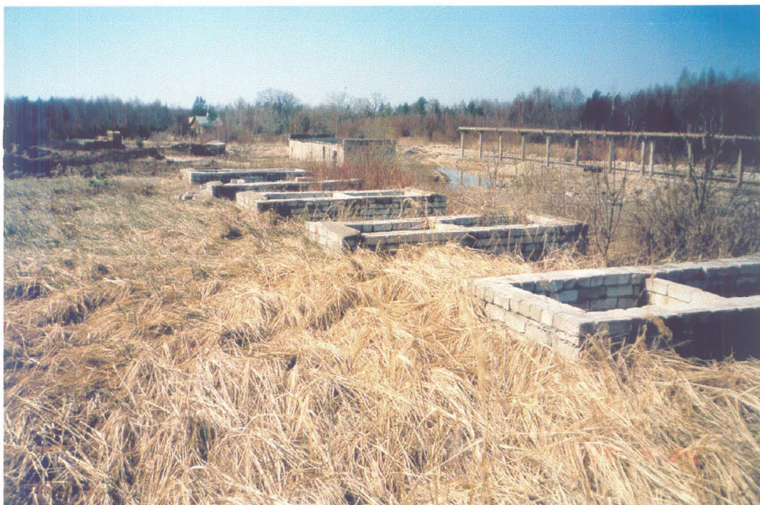
Foto 8. Vaade kuuest väiksemast mahutist koosneva mahutipargi tipust saneeritavale maa-alale, pumbamajale ja endisele kütuse laadimisplatsile. Fotograaf N. Reinap. Foto kuupäev 24.04.98
