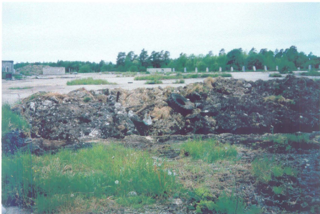
Foto 1. Haapsalu lennuvälja autopargi territooriumil oleva kraavi põhjast välja kaevatud reostunud pinnas enne aunadesse paigutamist. Fotograaf T. Meriste. Foto kuupäev 03.06.98
