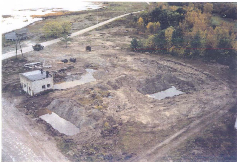
Foto 2. Vaade Kihnu endise demonteeritud ja puhastatud kütusehoidla territooriumile 22. oktoobril 1997. a. Endise diiseljõujaama kütusehoidla territooriumil asuvad kontrollaugud, millede kaudu eemaldati pinnasesse sorbeerunud ehe masuut.
