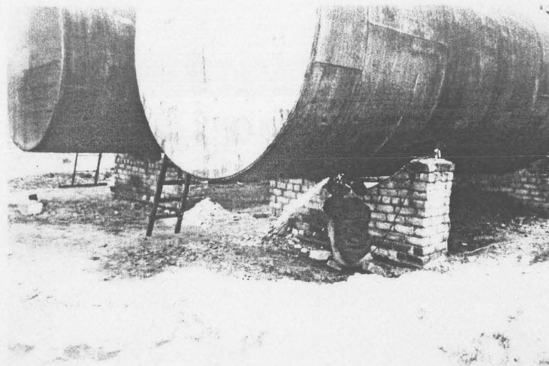
Foto 19. Degaseeritud õhema seintega mahutite tükeldamine lõikekäiaga septembris, 1997.
