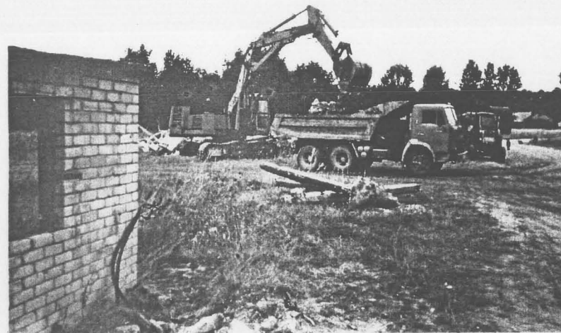
Foto 31. Masuudiga mitteraardunud chituskonstruktsioonide vedu rekonstrueeritava Kihnu sadama kai ehitusse. Kasutatud mehanismid: EO-4121, KAMAZ-5310, T-40AM. Sept. 1997.
