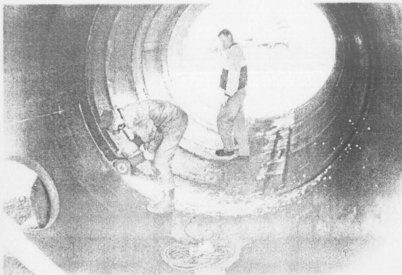
Foto 21. Mahutite sisemine tükeldamine lõikekäiaga septembris, 1997.
