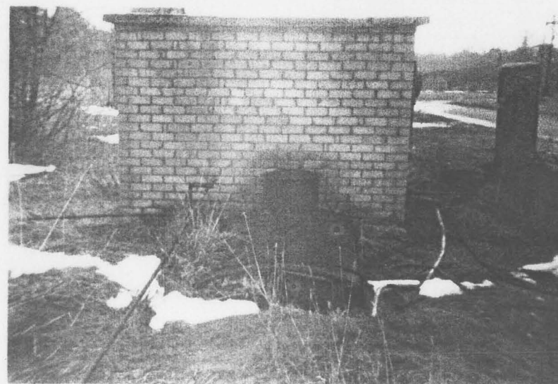
Foto 4. Endise diiseljõujaama maa-alune bensiinimahuti nr. 18 tööks vajalike kommunikatsioonidega 25.02.1997.
