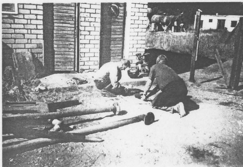
Foto 8. Kütusehoidla maa-pealse torustiku demonteerimine ja tükeldamine. August, 1997.
