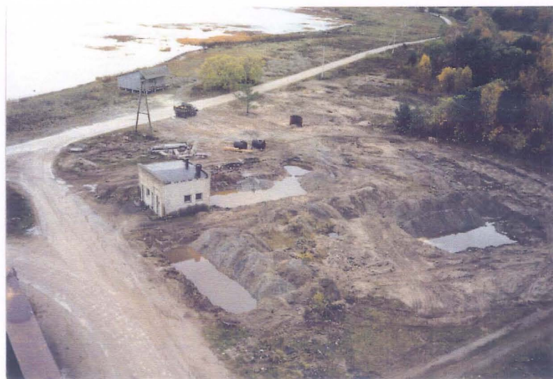
Foto 14. Seisuga oktoober, 1997 endise kütusehoidla territooriumile kaevatud tiigid. Antud tiikide eesmärgiks oli väljavalgunud masuudi eemaldamine reostunud pinnasest ning reostuskoormuse vähendamine reostuskoldes.
