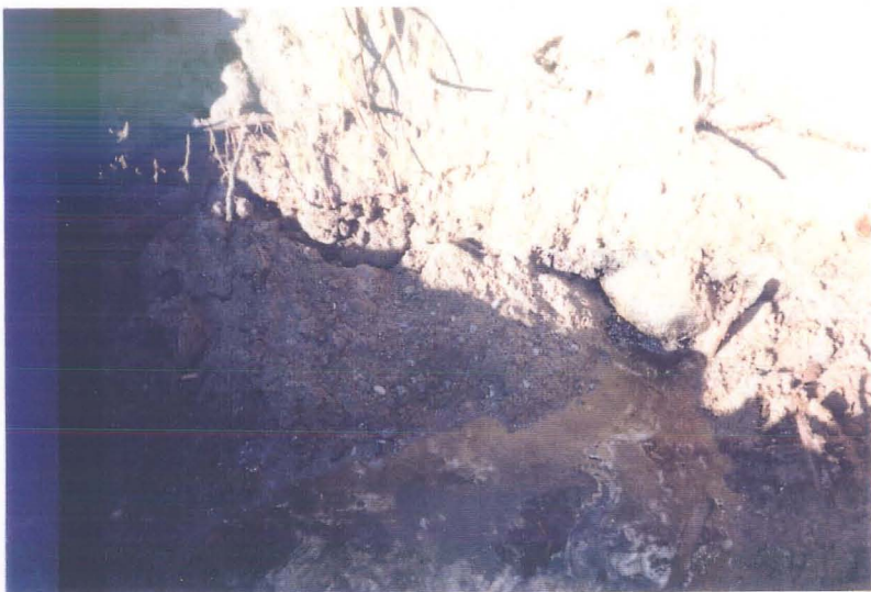
Foto 9. Puuraugu P - 2 juurde kaevatud süvendisse tungis vesi koos eheda masuudiga. Süvendi põhjas on näha masuudiga läbiimbunud kruusakihti.
