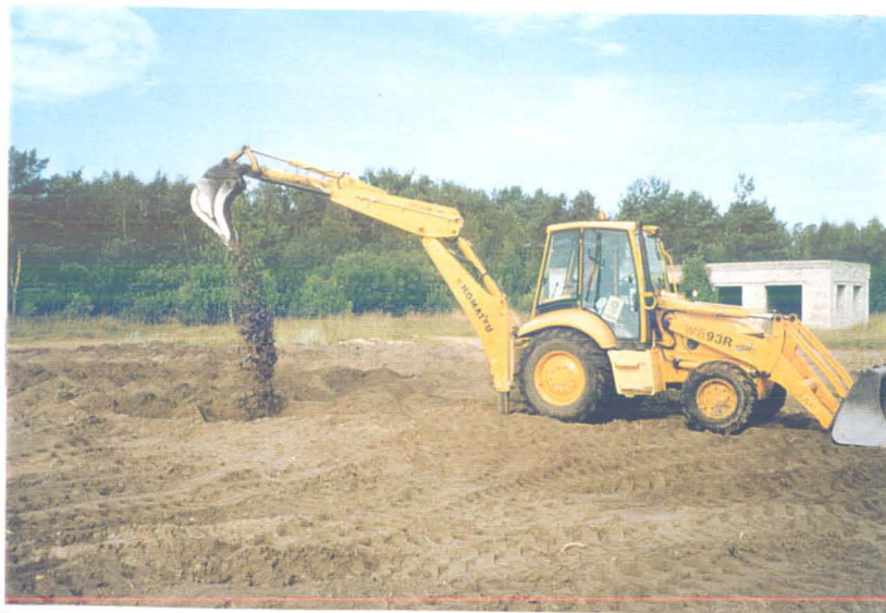
FOTO 5. Naftasaadustega reostunud pinnase kaevamine, sorteerimine ning ettevalmistus pesuks HydroBreak ®
