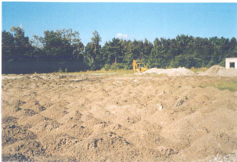
FOTO 6. Naftasaadustega reostunud pinnase õhutamine
