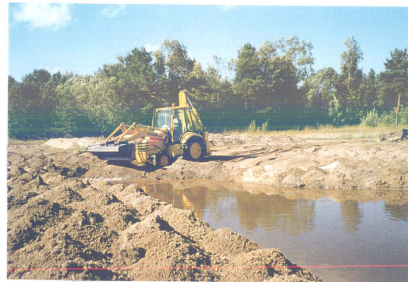
FOTO 3. Naftasaadustega reostunud pinnase sorteerimine ja ettevalmistamine pesuks HydroBreak ® (pinnase pesu pilootprojekt)
