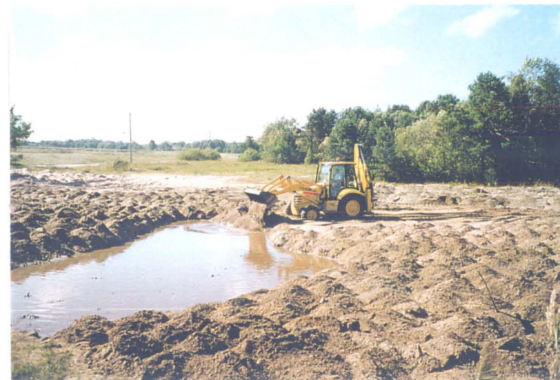
FOTO 3. Naftasaadustega reostunud pinnase sorteerimine ja ettevalmistamine pesuks HydroBreak ® (pinnase pesu pilootprojekt)
