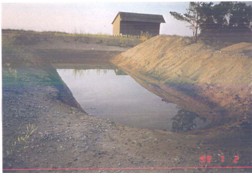
FOTO 1. Naftasaadustega reostunud maa-ala seisuga 02.07.1999
