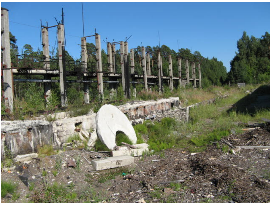
Foto 5202. Kütuse vastuvõtusõlm raudteel 2006.a ( vaade läänest)
