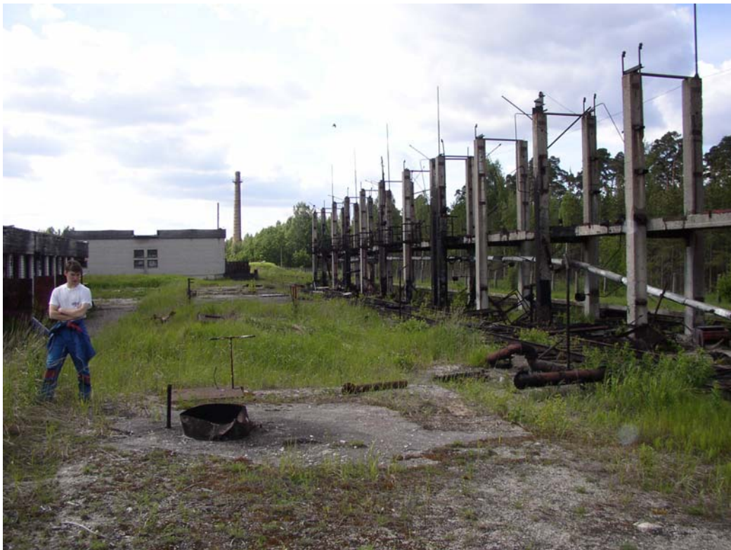
Foto 5201. Kütuse vastuvõtusõlm raudteel 2003.a ( vaade idast)
