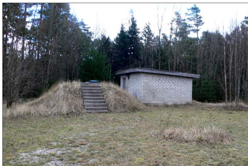
Foto 4.4.1 Puurkaevu 8780 asukoht ja pumplahoone (14.02.2008.)
